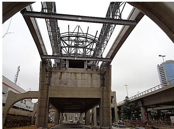
Corpo da estação
