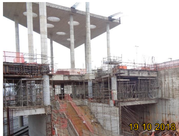
Acesso Heitor dos Prazeres: cobertura da estação e estruturas internas do acesso.
