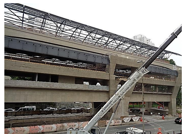
Corpo da estação.
