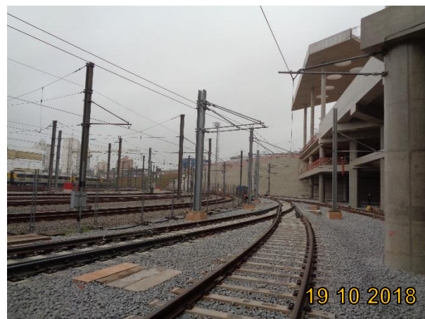
Nível Pátio (Terminal de Ônibus Vila Sônia): Vias Permanentes e AMVs (Feixe de entrada vias 6 a 10) instaladas, com rede aérea implantada.
