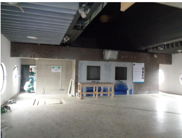
Em andamento a implantação dos Sistemas.
