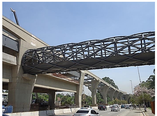
Passarela metálica entre estação e acesso.
