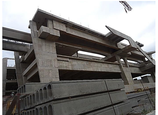
Corpo da estação – Obra bruta concluída
