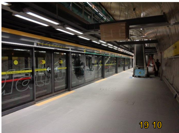
Corpo da Estação: vista da plataforma via 2 com acabamentos realizados e sistemas implantados.
