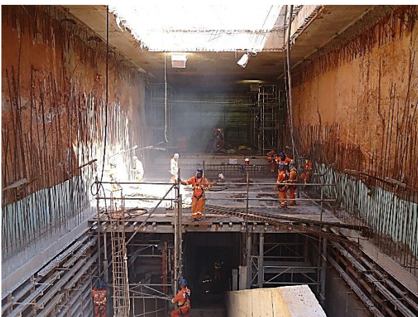
Acesso ao Aeroporto - Execução das paredes.
