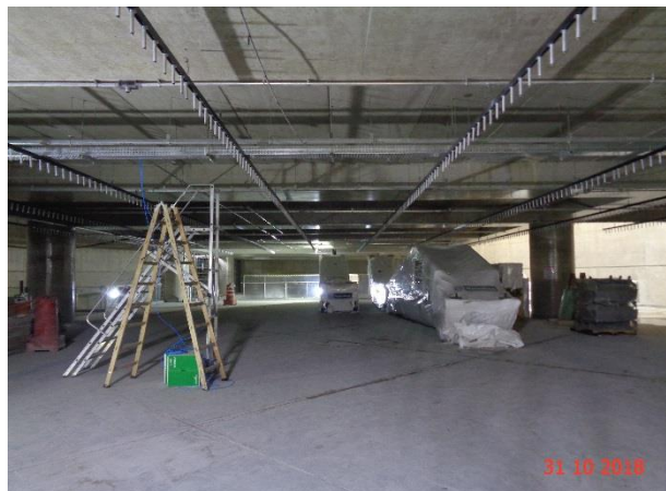
Mezanino Superior: Instalação do forro em execução
