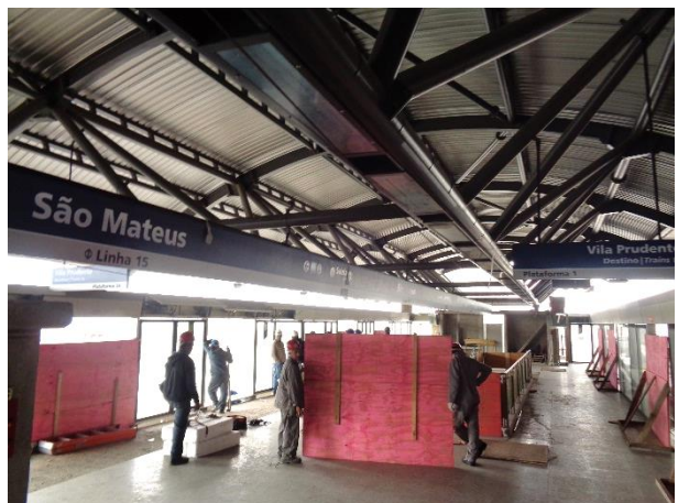
Em andamento a implantação dos Sistemas.
