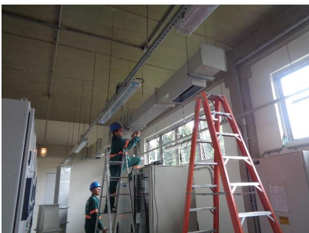
Dutos do sistema de ventilação em montagem.
