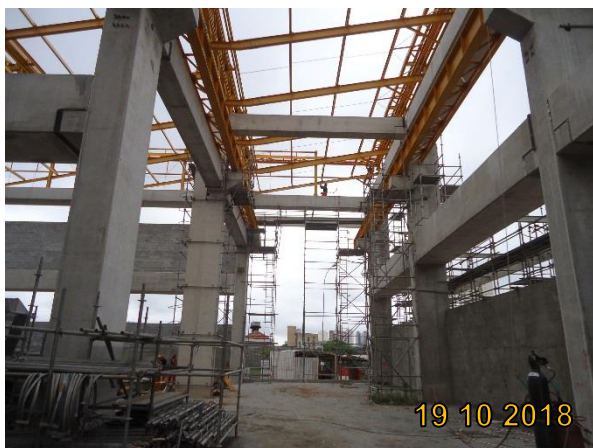
Bloco F: Acabamentos internos em execução.
