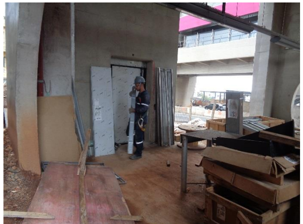
Em andamento a implantação dos Sistemas.
