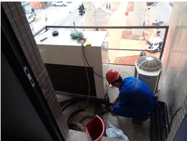
Em andamento a implantação dos Sistemas.
