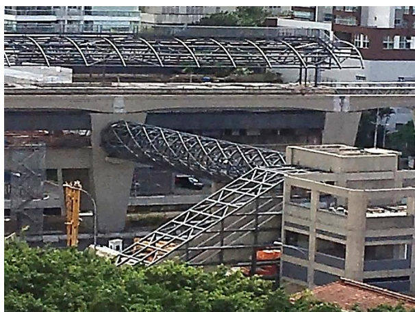
Montagem da cobertura metálica do acesso e instalação das passarelas metálicas.
