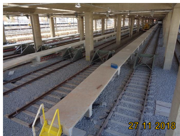
Nível Pátio (Terminal de Ônibus Vila Sônia): Vias Permanentes e AMVs (Feixe de entrada vias 1 a 10) instalados.
