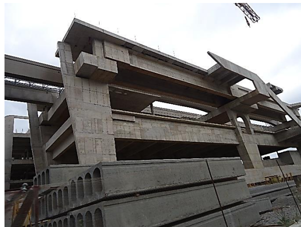
Corpo da estação – Obra bruta concluída
