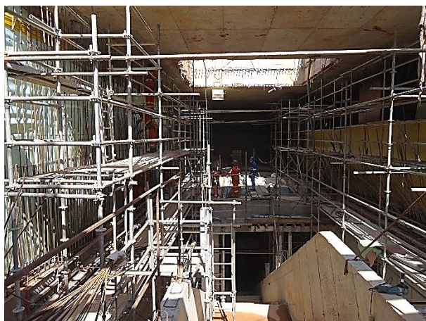
Acesso ao Aeroporto - Execução das paredes.
