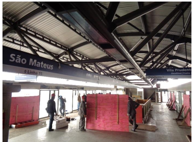
Em andamento a implantação dos Sistemas.
