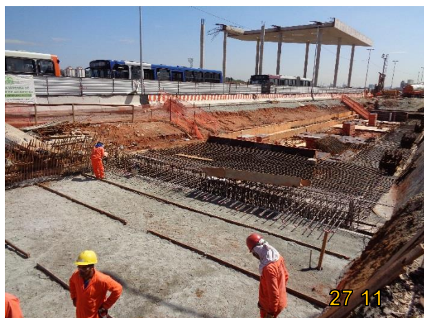
Corpo da Estação: concretagem, formas e armação da laje de cobertura em execução.
