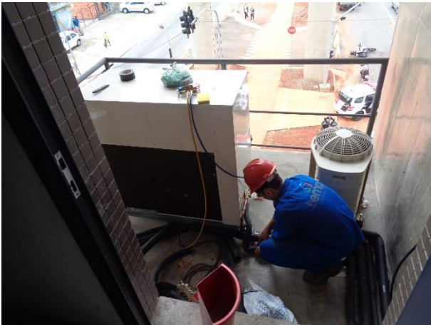
Em andamento a implantação dos Sistemas.
