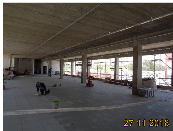
Bloco B/m: acabamentos (pisos e paredes) em execução; infraestrutura e lançamento de cabos de iluminação em execução.
