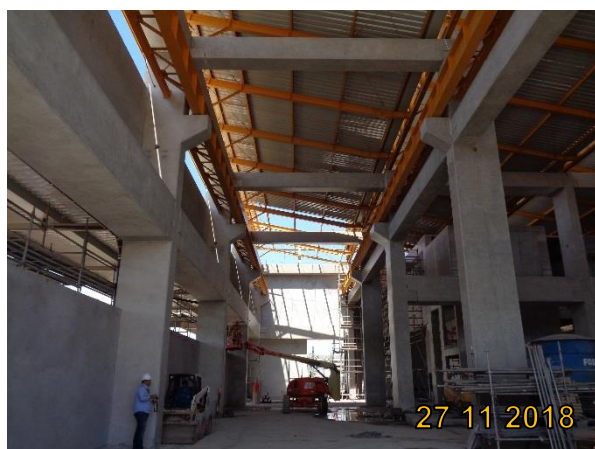
Bloco F: Acabamentos internos e externos em execução; Cobertura Metálica instalada.
