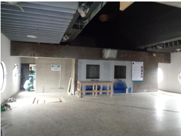
Em andamento a implantação dos Sistemas.
