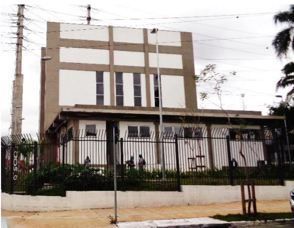
Visão geral da Subestação
