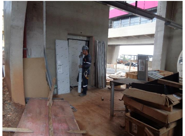
Em andamento a implantação dos Sistemas.
