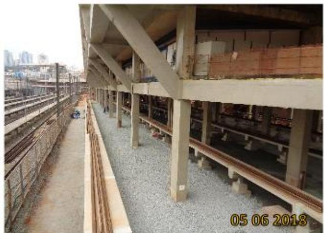
**Nível Pátio (Terminal de Ônibus Vila Sônia):** Plataformas de acesso aos trens e reaterro em execução. Infraestrutura para rede aérea em instalação.
