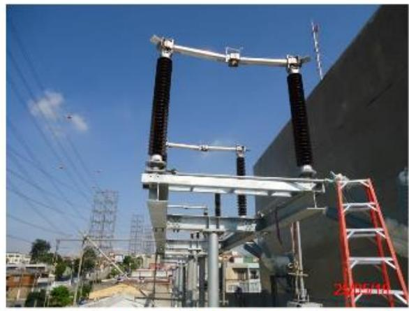
Montagem das seccionadoras e para-raios de entrada.
