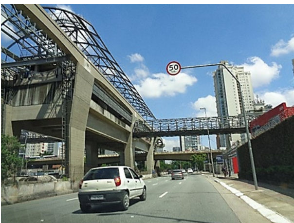
Passarela de Acesso.
