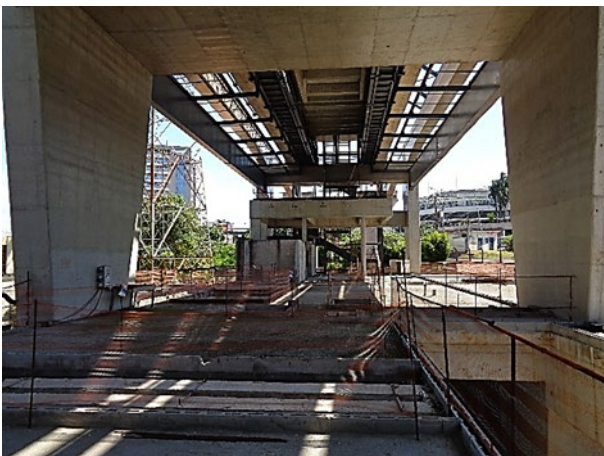
Corpo da Estação: obra bruta.
