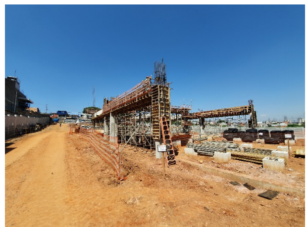
Obra Civil – execução dos blocos de fundações, pilares e paredes do porão de cabos.
