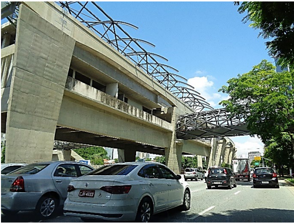
Corpo da estação: obra bruta.
