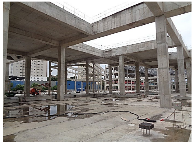
Setor 5 - Estrutura de concreto: obra bruta.
