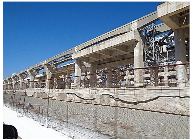
Setor 5 - Estrutura de concreto: obra bruta.
