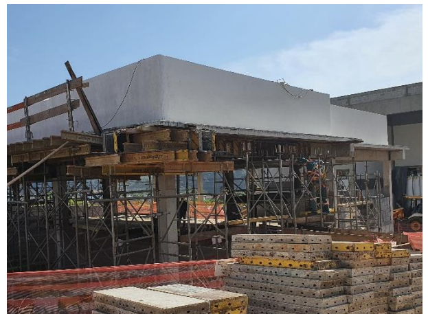
Obra Civil – retirada do cimbramento da laje da sala de Controle.
