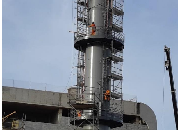
Nível Terminal - execução do reservatório superior do Terminal.
