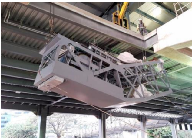
Montagem das Escadas Rolantes.
