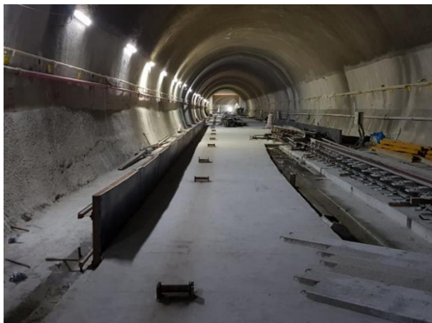
Túnel de Via 02 – em execução laje flutuante.
