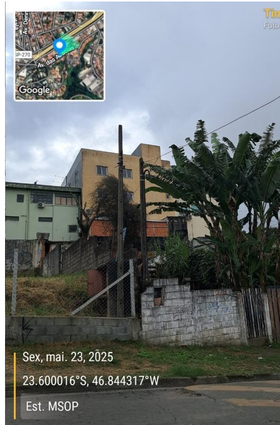
Foto 498 - Estação São George
