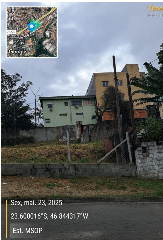
Foto 499 - Estação São George
