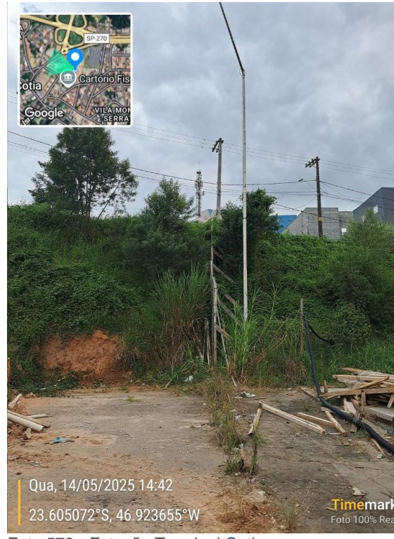
Foto 578 - Estação Terminal Cotia
