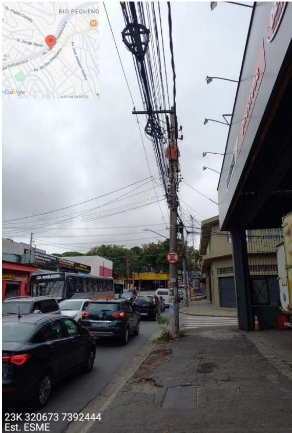
Foto 429 - Estação Rio Pequeno
