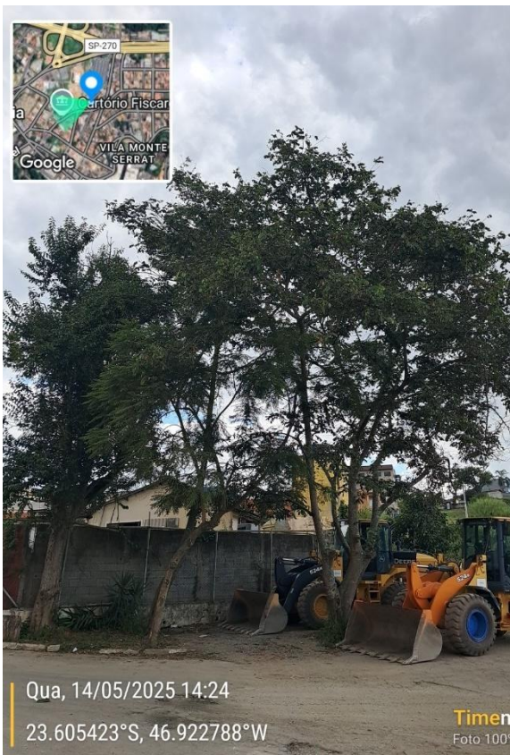
Foto 567 - Estação Terminal Cotia
