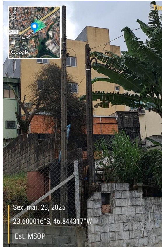
Foto 502 - Estação São George
