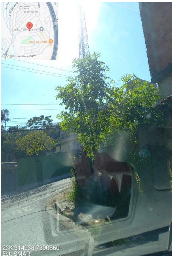
Foto 483 - Estação Santa Maria
