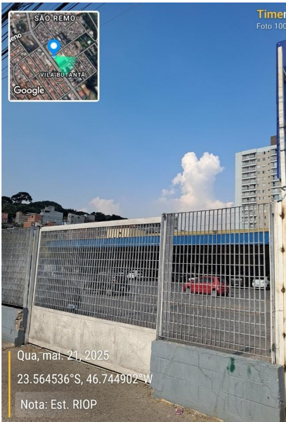
Foto 407 - Estação Hospital Universitário
