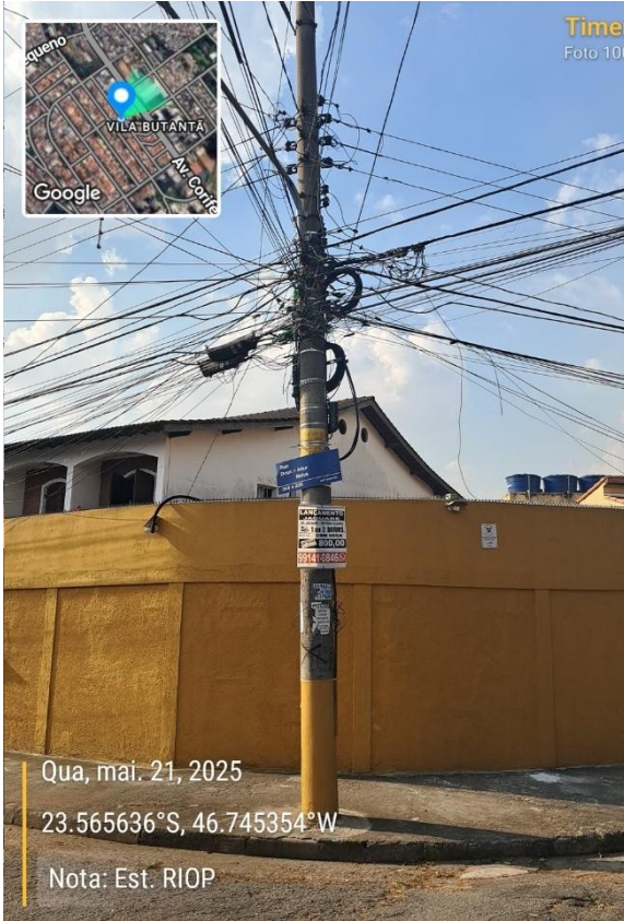
Foto 409 - Estação Hospital Universitário
