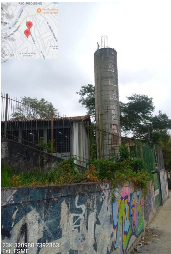
Foto 423 - Estação Rio Pequeno
