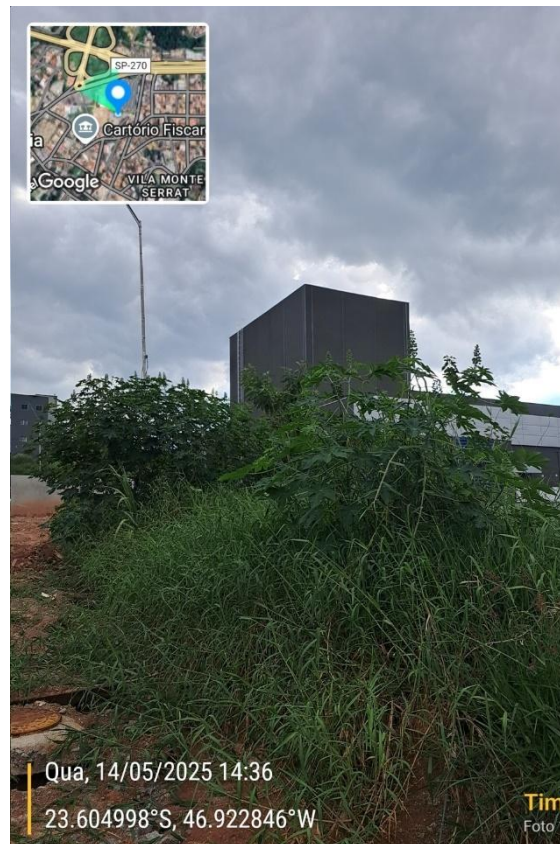
Foto 576 - Estação Terminal Cotia
