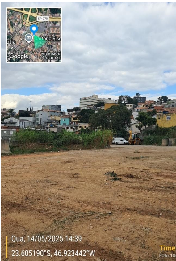
Foto 575 - Estação Terminal Cotia
