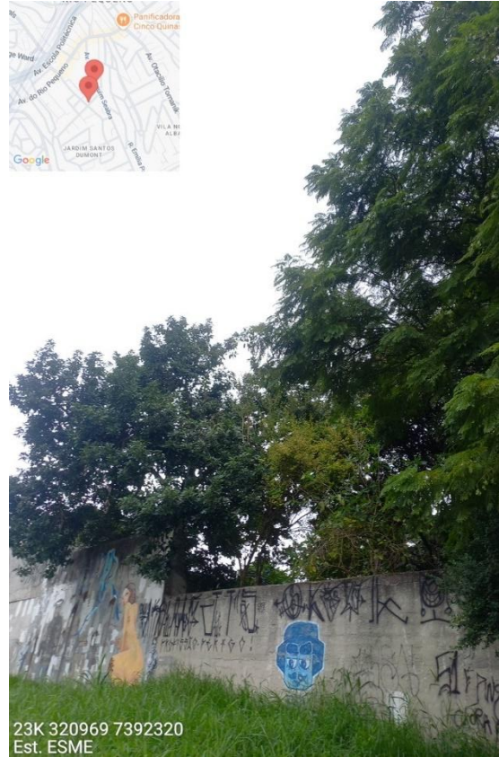
Foto 422 - Estação Rio Pequeno
