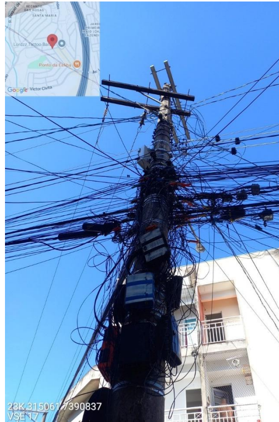
Foto 474 - Estação Santa Maria
