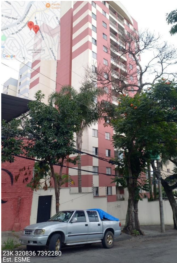
Foto 425 - Estação Rio Pequeno
