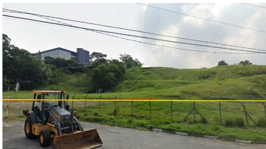
Barranco que separa o local da estação dos bairros ao sul, na rua Com. Gumercindo C. L. del Gaizo
