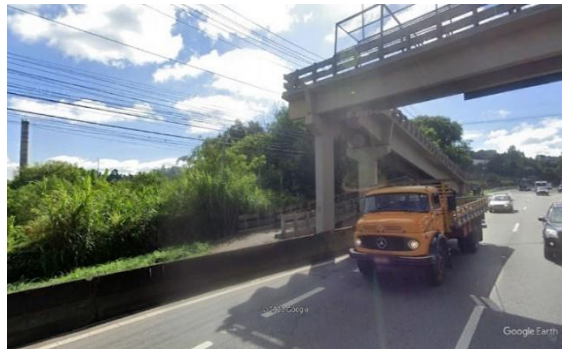
Passarela a 350m da estação - local ermo e sem iluminação
