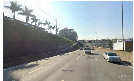
Acesso à passarela, setor norte
