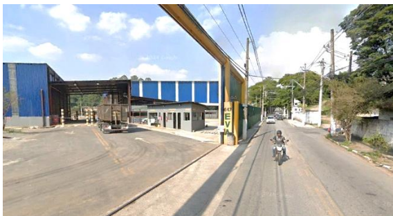
Área da estação desde a rua Dr. Ladislau Retti
