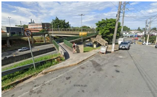
Acesso à passarela, setor norte, na marginal da rodovia Raposo Tavares, com escada de madeira e calçadas estreitas ou inexistentes
