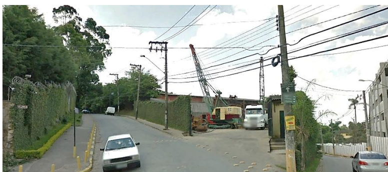
Vista da área desde a estrada da Aldeia
