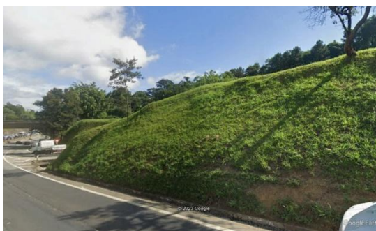
Áreas vazias ao norte da rodovia Raposo Tavares e a leste da estação Cotia-km 26
