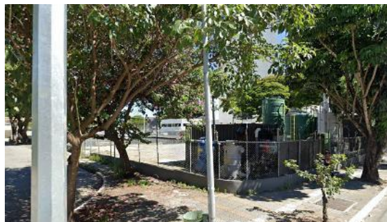
Av. Eusébio Matoso – vista da área
