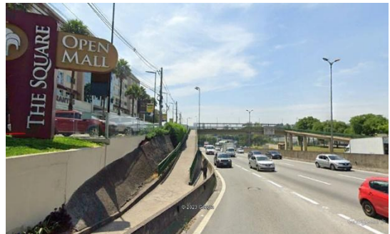
Acesso à passarela a cerca de 600 m da estação – setor norte, Estrada da Aldeia, em frente ao Shopping Open Mall The Square
