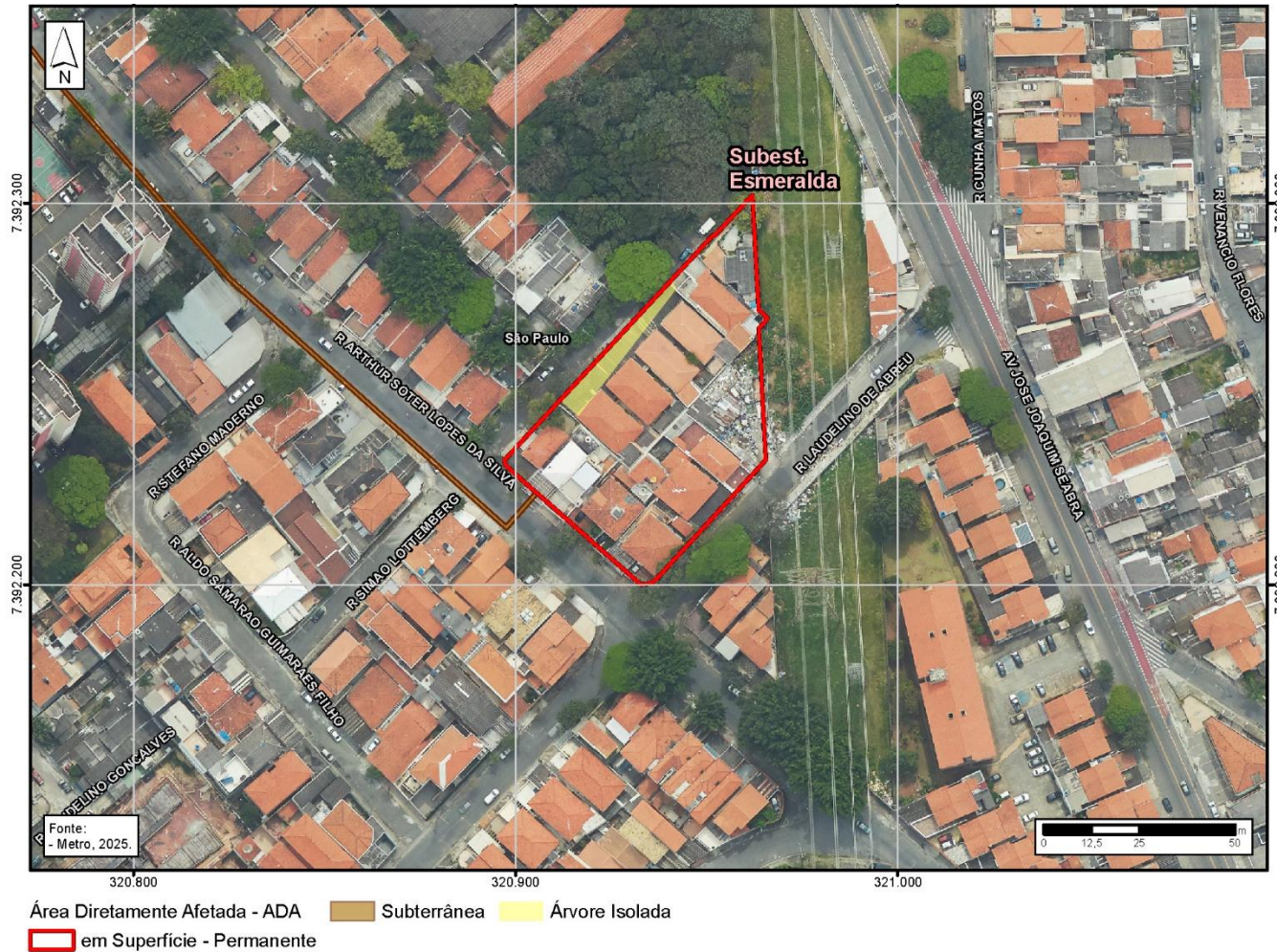
Figura 10.1-70 – Áreas de supressão mais expressivas na Subestação Esmeralda.
