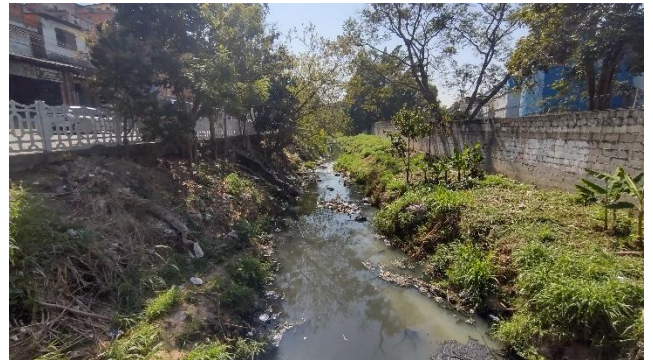
Foto 9.9-14 – Travessia 39 – Ribeirão dos Pedros próximo à estação Portão.
