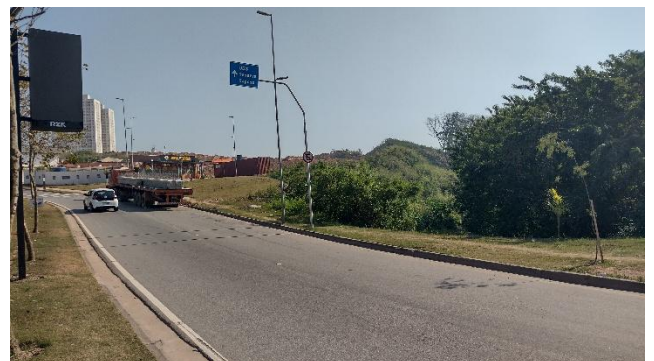
Foto 9.9-10 – Travessia 28 – Córrego Itaim tamponado nas proximidades da estação Reserva Raposo.
