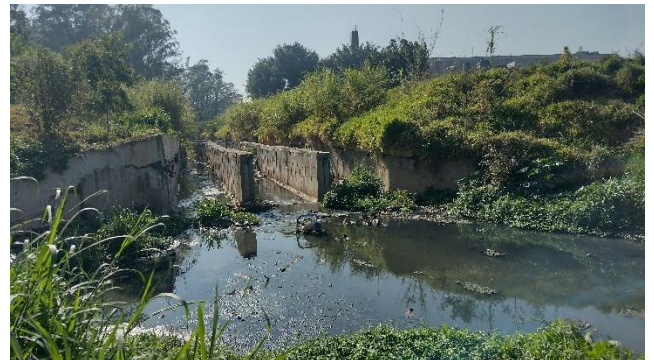
Foto 9.9-8 – Travessia 25 – Córrego Itaim na jusante da região do Pátio.
