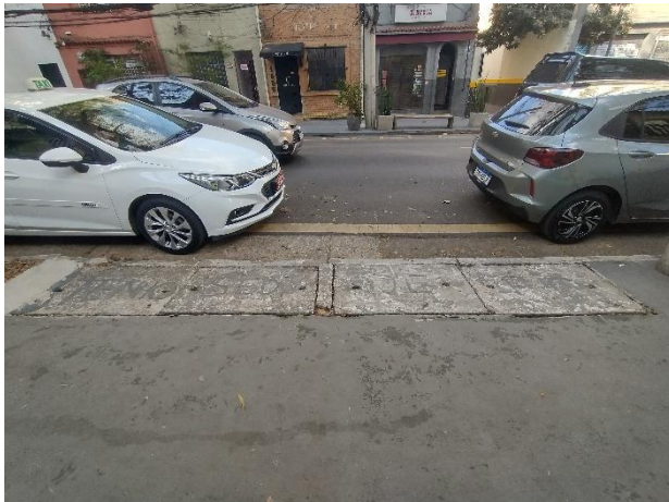
Foto 9.9-1 – Travessia 3 - Interferência no córrego Verde rua João Moura, próximo ao VSE 2.
