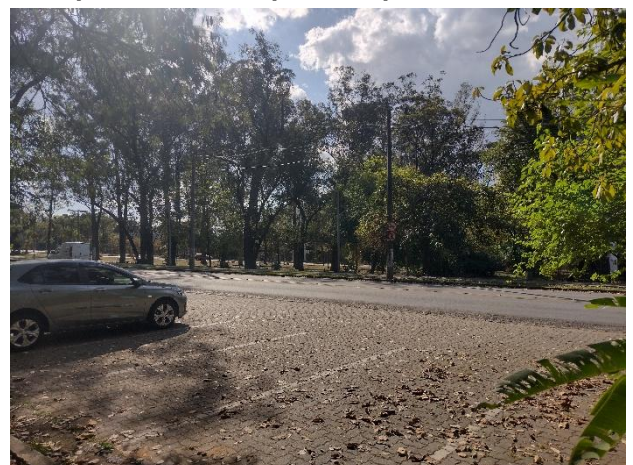
Foto 9.9-4 – Travessia 11 - Vista para a jusante do Parque Esporte Para Todos, do mesmo córrego, agora tamponado, próximo ao VSE 9.
