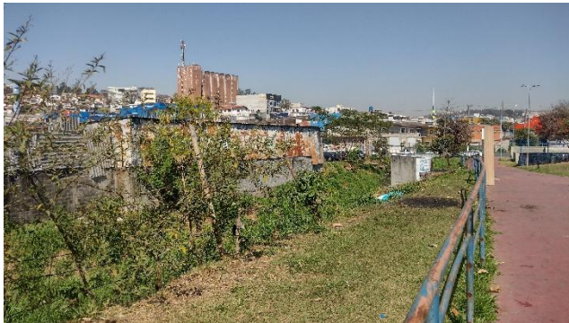
Foto 9.9-13 – Travessia 39 – Ribeirão dos Pedros próximo à estação Portão.
