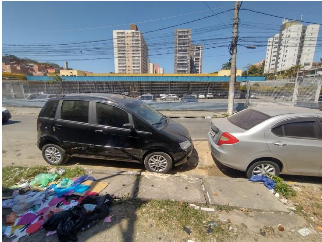
Foto 9.9-5 – Travessia 13 – Riacho Doce tamponado no trecho sob o mercado Roldão, com os bueiros na calçada, próximo à estação Hospital Universitário.
