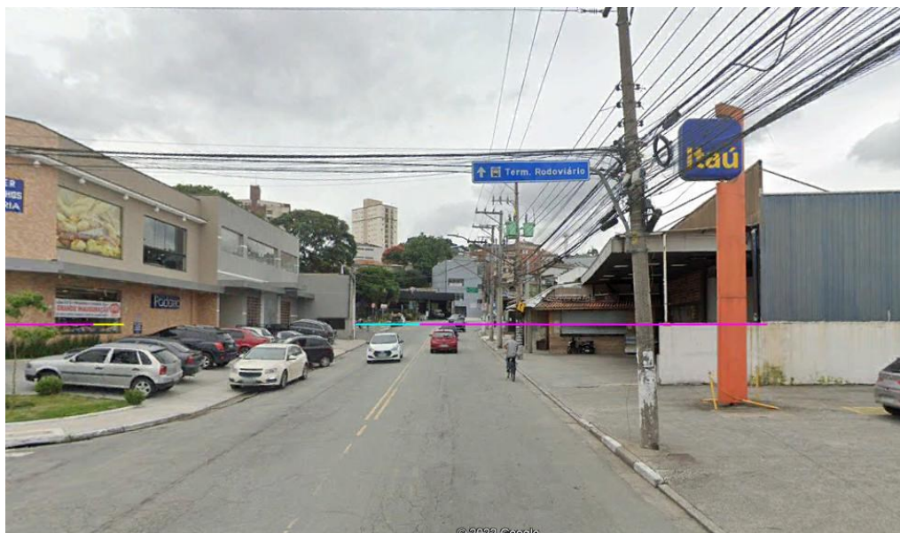
Foto 9.3.2.1.4-10 – Vista da av. Guarulhos, em área prevista para implantação da estação Ponte Grande à direita
