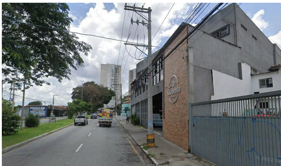
Foto 9.3.2.1.4-19 – Vista da av. Pres. Humberto de Alencar Castelo Branco no local à direita onde está prevista a implantação do VSE Castelo Branco Fonte: Google Street View, 2021
