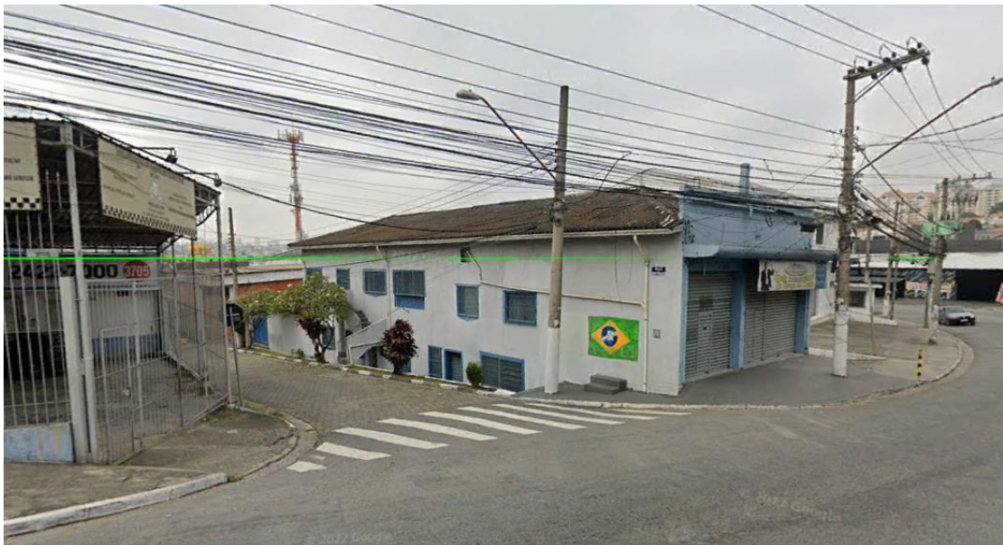
Foto 9.3.3.2.3-2 – Usos Afetados no Bloco 3 Usos na av. Guarulhos, esquina com a rua Joaquim Isidoro da Silva, para a estação Ponte Grande Fonte: Google Street View
