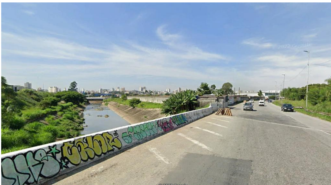
Foto 9.3.2.1.4-3 – Vista do local da estação Fernão Dias à direita do rio Cabuçu de Cima, desde o viaduto da av. homônima que faz a travessia
