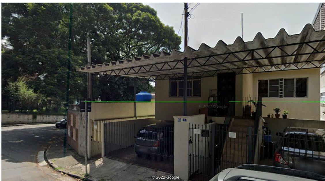
Foto 9.3.3.2.4-3 – Usos Afetados no Bloco 4 Moradias na rua 1º Ten. Aviador Aurélio Vieira Sampaio
