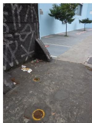
**Foto 9.1.12.3-35 – Poços de monitoramento de água subterrânea instalados na área do VSE Castelo Branco, aos fundos.**
