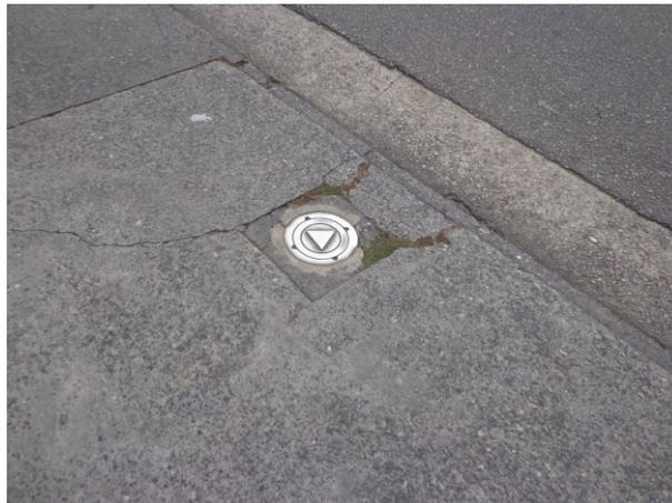
**Foto 9.1.12.3-16 – Poço de monitoramento de água subterrânea instalado na calçada do posto de combustível.**
