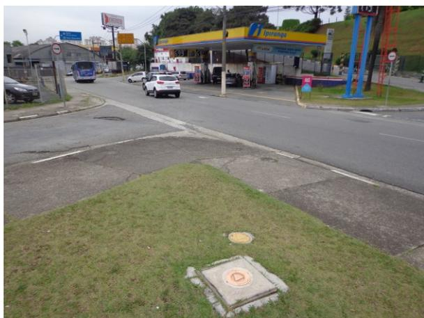
**Foto 9.1.12.3-12 – Poços de monitoramento de água subterrânea, instalados próximo à ADA da Estação Dutra.**
