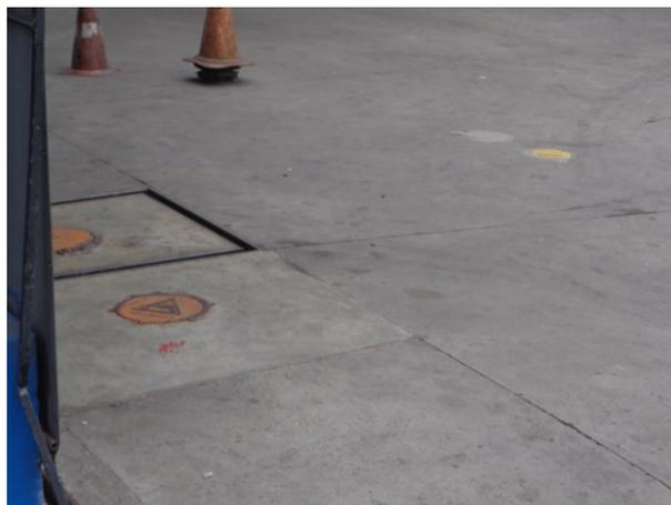
**Foto 9.1.12.3-19 – Poço de monitoramento de água subterrânea (tampa amarela) instalado na área do posto de combustível.**
