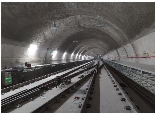
Túnel de Via 02 – Suporte da rede aérea e laje entre as vias em execução.
