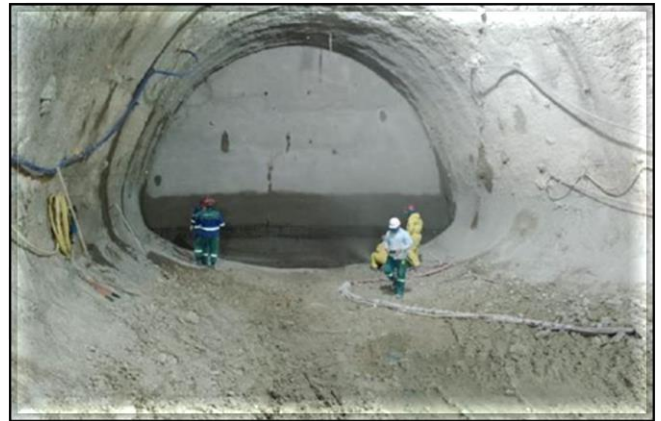
Escavação do túnel de ligação.
