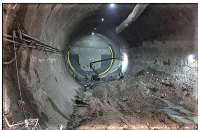
Escavação e impermeabilização dos túneis do corpo da estação.
