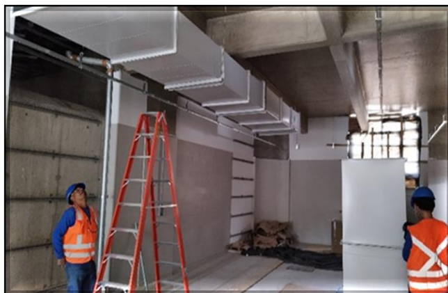
Sistemas – instalação dos dutos de ventilação nas Salas Técnicas.
