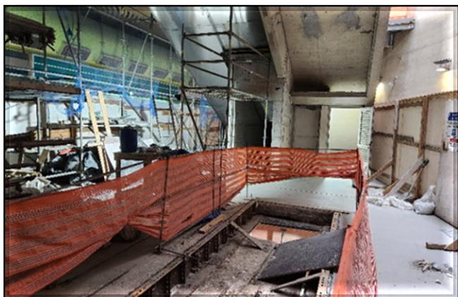
Linha 2-Verde - Plataforma 2 – lado leste – nova escada de acesso ao porão da plataforma e caixa de apoio da nova escada rolante.
