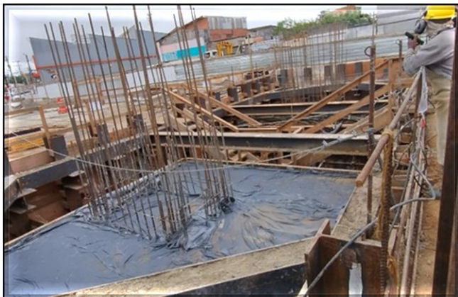
Obra Civil – bloco de fundação do corpo da estação concretado.
