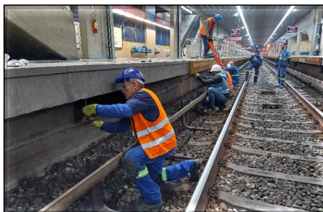
Adequação das estruturas das plataformas para receber a estrutura metálica das PSDs
