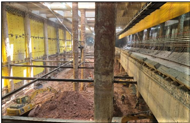
Escavação e estruturas de concreto do corpo da estação.
