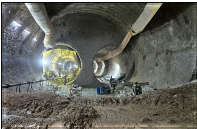
Escavação e revestimento secundário do túnel de via.
