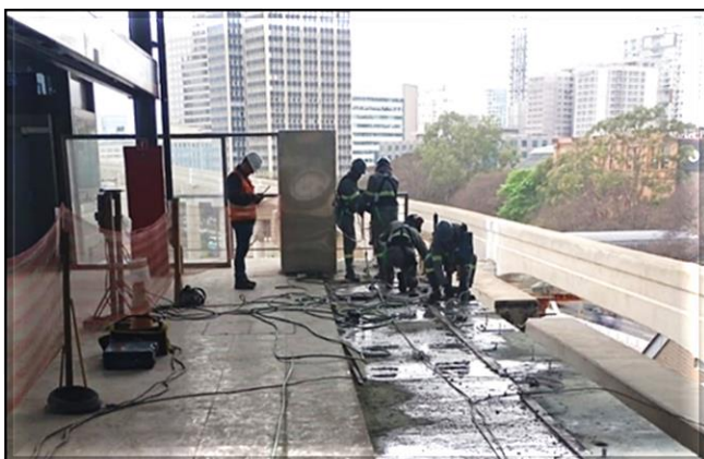
Sistemas – montagem mecânica das portas de plataforma em execução.
