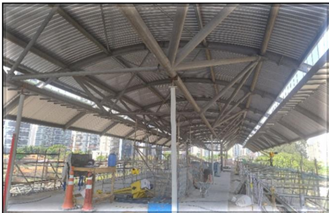
Obra Civil – em andamento a instalação das telhas da cobertura da plataforma.
