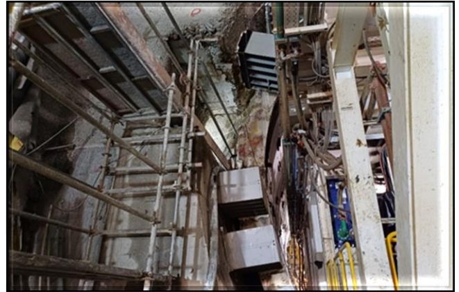
Estrutura de reação para a tuneladora no Poço Capitão.
