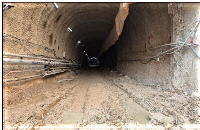
Escavação do túnel singelo.
