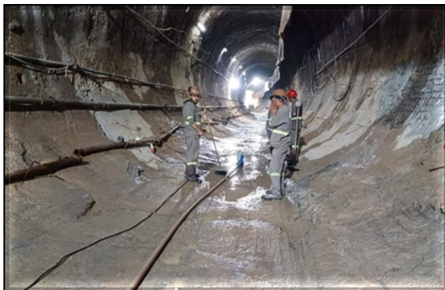
Vista do túnel singelo de terceira via.
