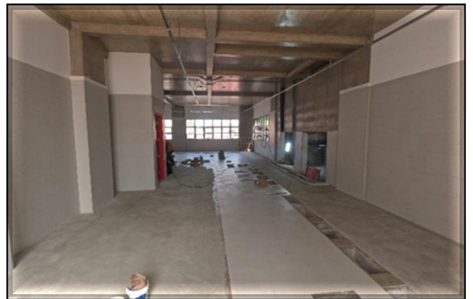
Obra Civil – em andamento a instalação do piso nas Salas Técnicas. Sistemas – instalação da infraestrutura de iluminação.
