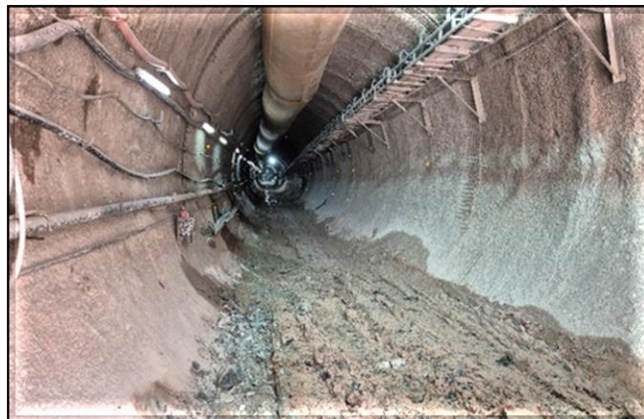
Escavação do túnel singelo.
