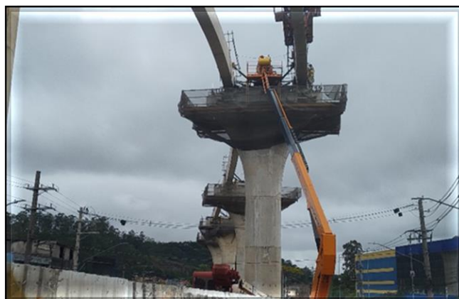
Obra Civil – execução da monolitização das vigas-guia lançadas.
