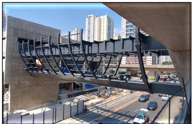
Obra Civil – instalação da passarela do Acesso 1.
