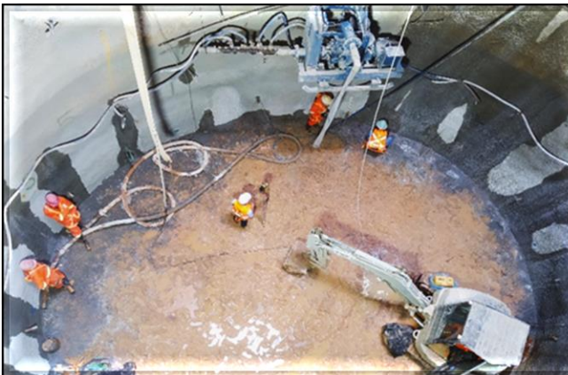
Topografia para execução do poço de drenagem, em execução.
