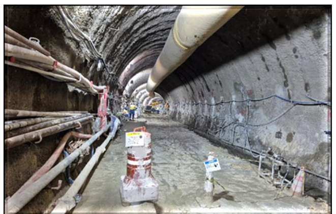
Escavação do túnel.
