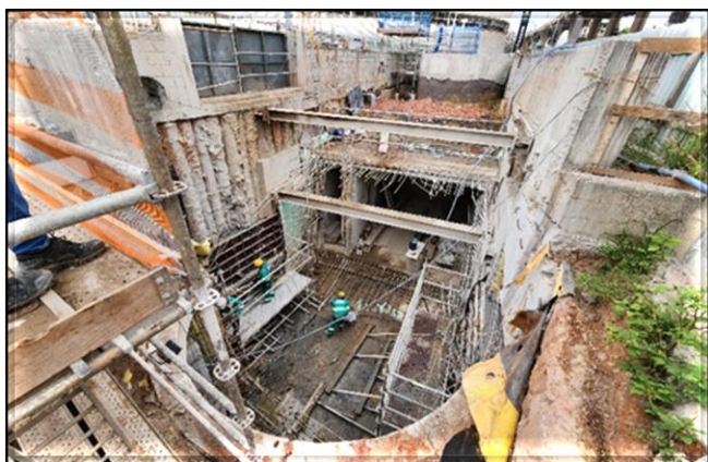
Exaustão 1 - Novo canal de ventilação da Plataforma 2 da estação Vila Prudente da Linha 2-Verde – execução das estruturas do novo canal.
