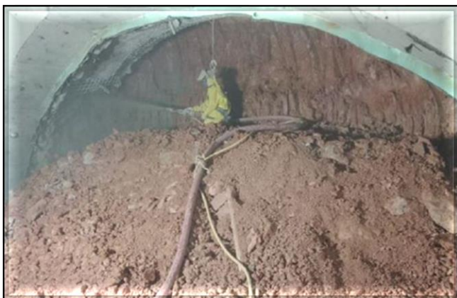
Escavação dos túneis direcionais para a tuneladora.
