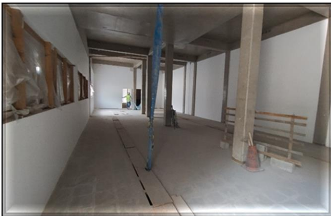
Obra Civil – pintura das Salas Técnicas.
