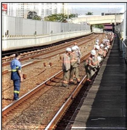
Lançamento de cabos do CBTC
