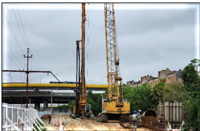
Obra Civil – execução das fundações dos pilares da via elevada.
