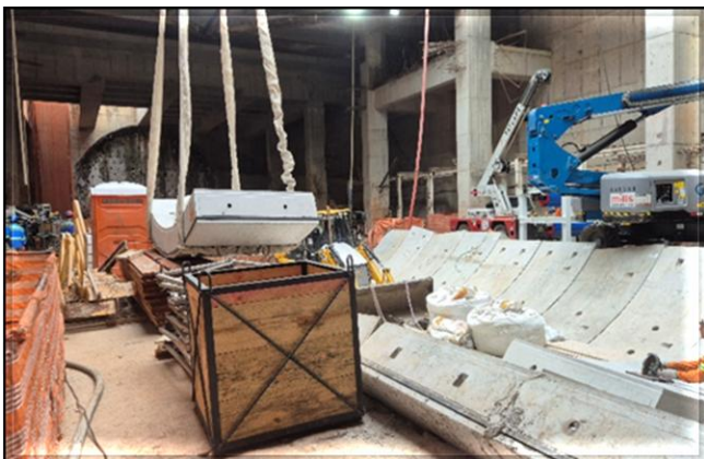
Montagem da Tunneladora na estação Penha.
