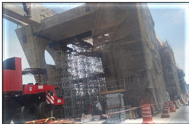
Obra Civil – em montagem o cimbramento para execução da plataforma, lançadas 8 de 10 vigas-guia do corpo da estação.
