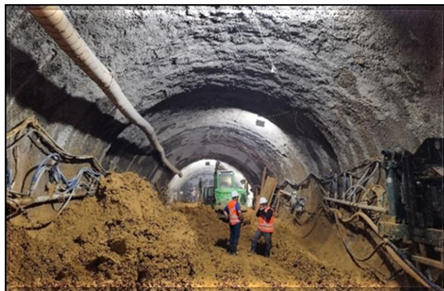
Túnel norte: Escavação da 45ª cambota concluída.
