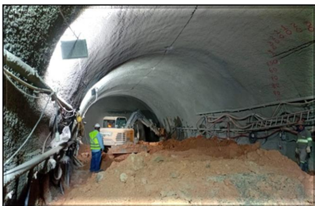
Escavação do túnel de estacionamento.
