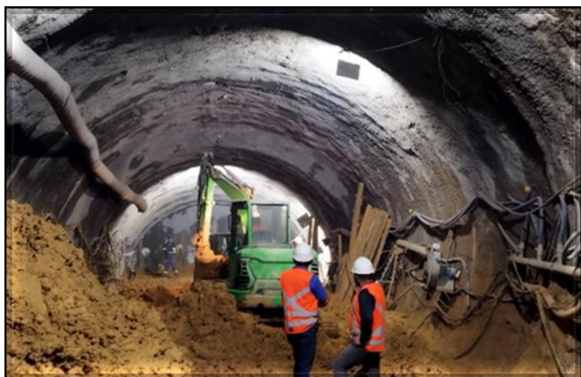
Túnel norte: Concluído o quinto lance de tratamento.
