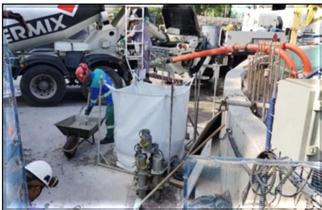
Vista do canteiro, frente utilizada para enchimento da via.
