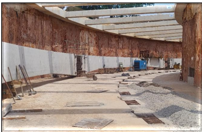
Obra Civil – lançadas as vigas-guia da região da vala.
