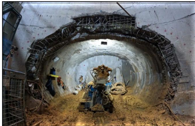
Túnel sul: Escavação da 14ª cambota concluída.
