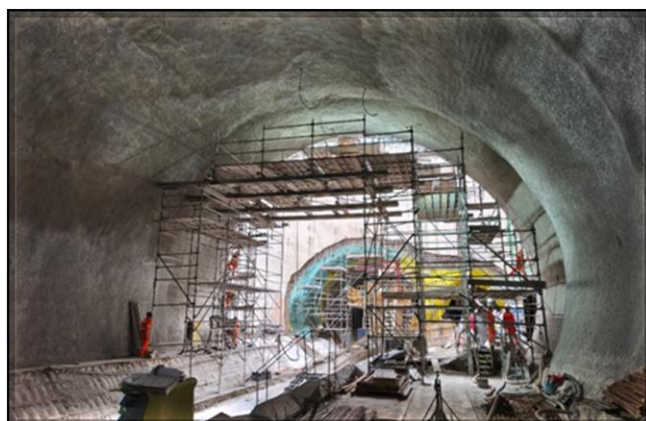
Revestimento secundário do túnel.
