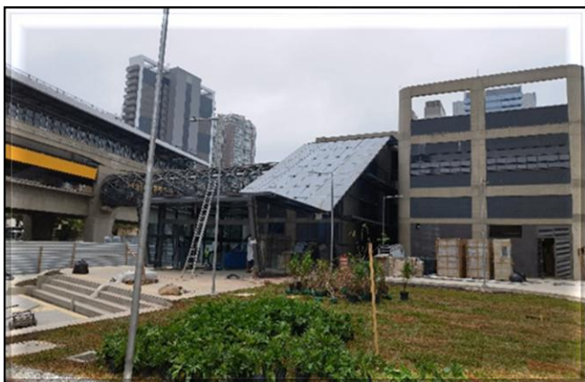
Obra Civil – execução do paisagismo dos acessos.
