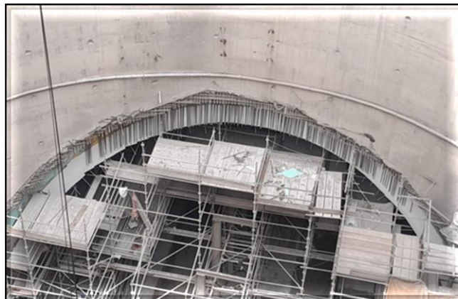
Revestimento secundário do túnel.
