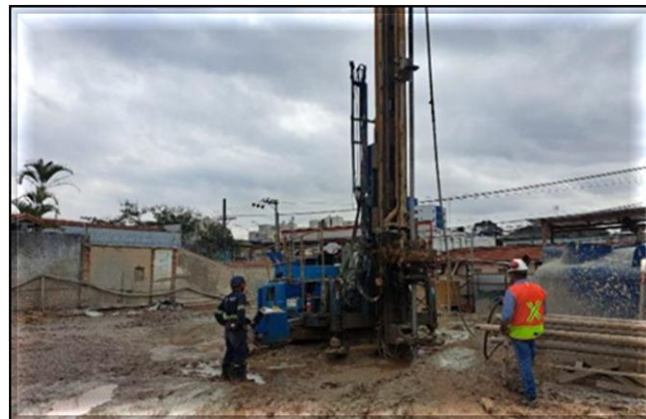
Execução do jet grouting para escavação do poço.
