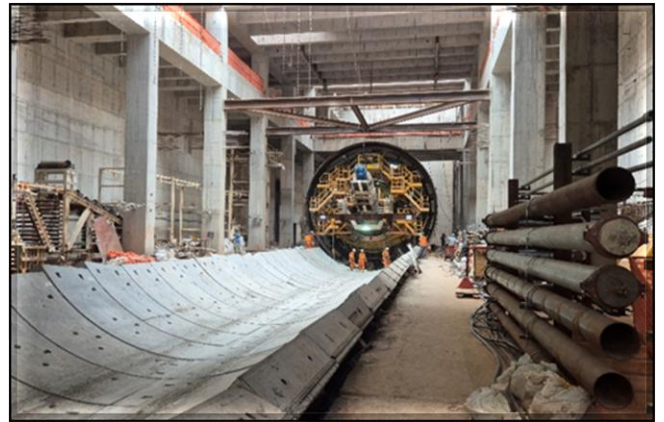
Montagem da Tunneladora na estação Penha.
