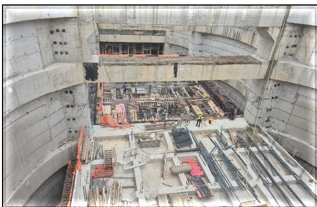
Estruturas de concreto do corpo da estação.
