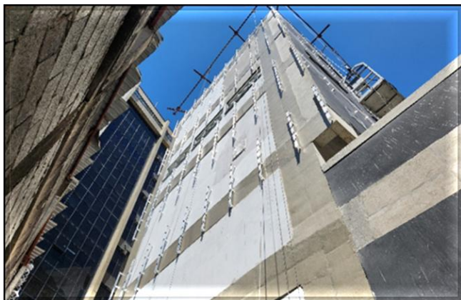
Novo Edifício Técnico Operacional (ETO): Montagem do brise da fachada.
