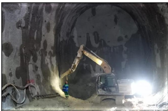
Tratamento para emboque da tuneladora.
