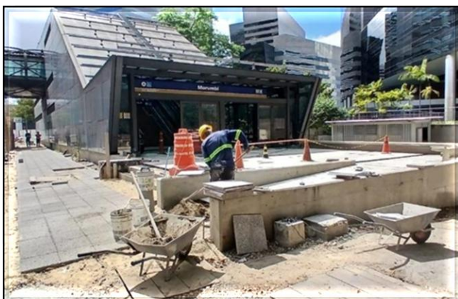
Obra Civil – execução da urbanização do acesso.
