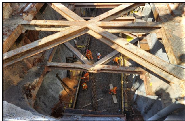
Galeria de Cabos: Armação da laje de fundo.
