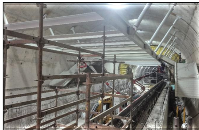
Instalação do mezanino metálico no túnel de corpo da estação.
