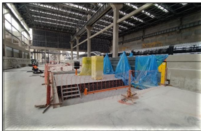
Sistemas – Drop Table em instalação no Bloco A.
