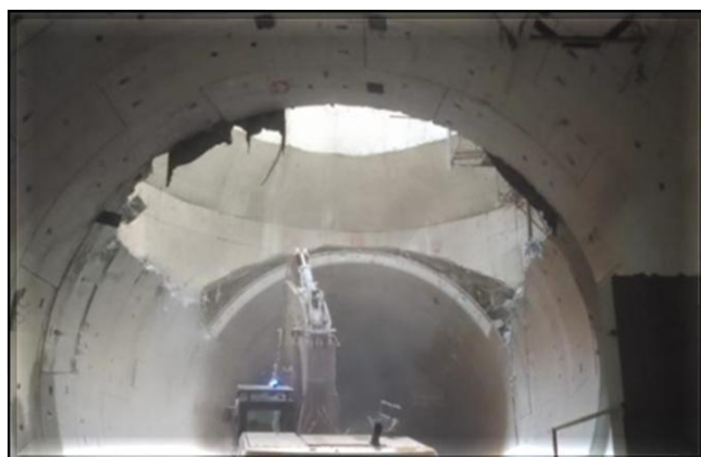
Demolição do túnel falso.
