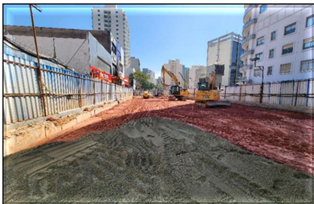
Rua Vergueiro (sentido bairro): Reaterro da laje da ampliação do mezanino.
