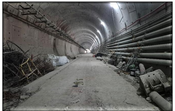
Desmobilização das utilidades da tunneladora e enchimento do túnel para execução da via permanente.
