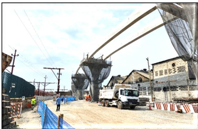
Obra Civil – lançamento das vigas-guia da via elevada.
