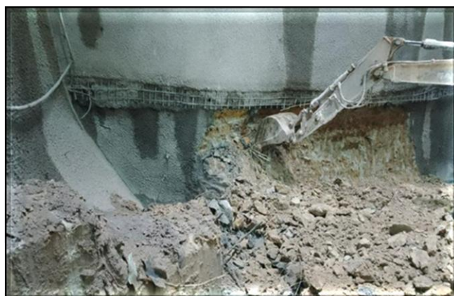
Escavação dos túneis direcionais.
