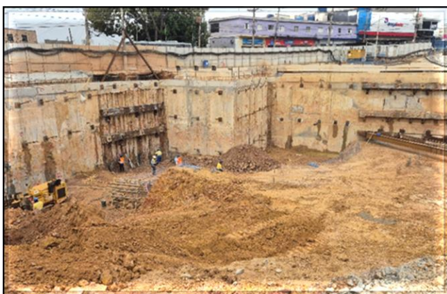
Escavação da vala do acesso principal.
