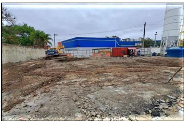
Execução da viga de borda para escavação do poço.
