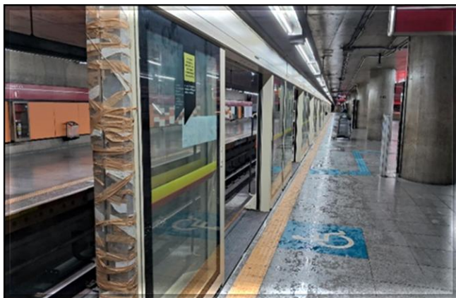
Fachadas das portas de plataforma em instalação.
