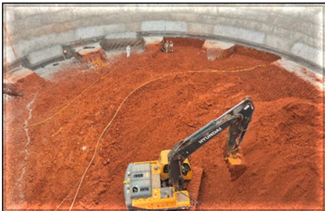
Escavação do poço do corpo da estação.
