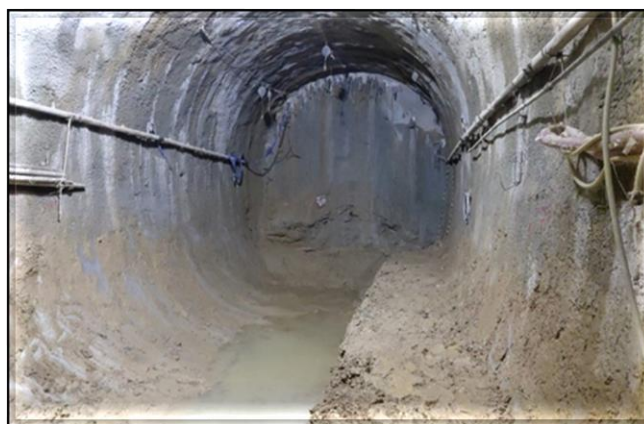
Escavação do túnel singelo de estacionamento.
