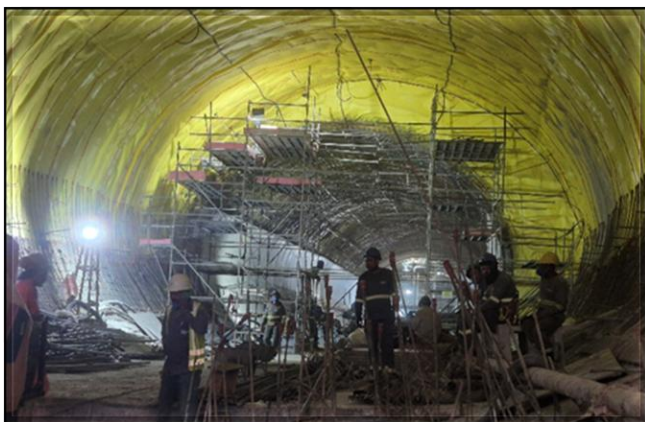
Laje de fundo, impermeabilização e revestimento secundário do túnel de via.
