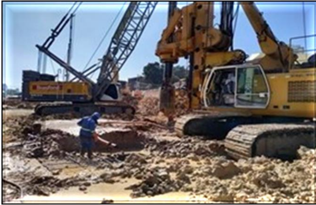
Escavação do corpo da estação..
