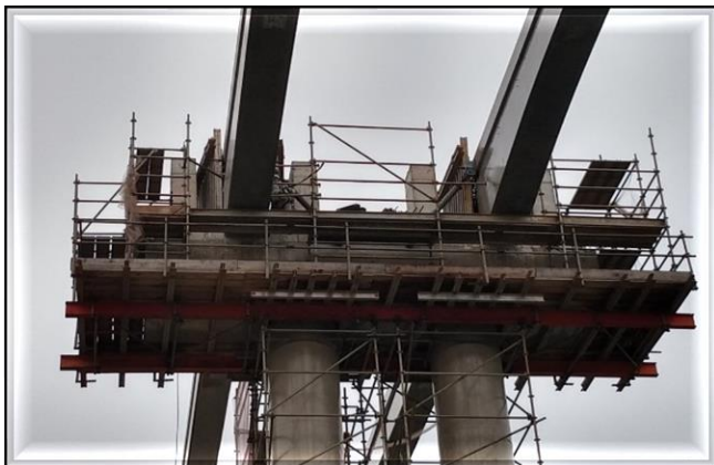
Vias do monotrilho/Obra Civil – Execução da monolitização.
