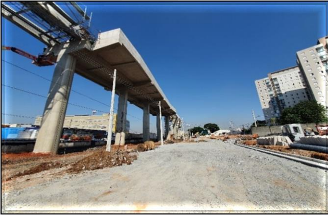
Obra Civil – Execução do novo viário.
