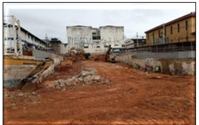
Escavação da vala do corpo da estação.
