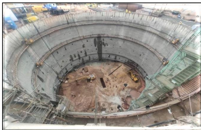
Escavação do poço do corpo da estação.
