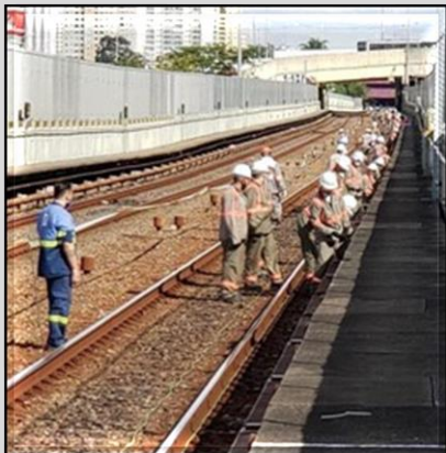
Lançamento de cabos do CBTC
