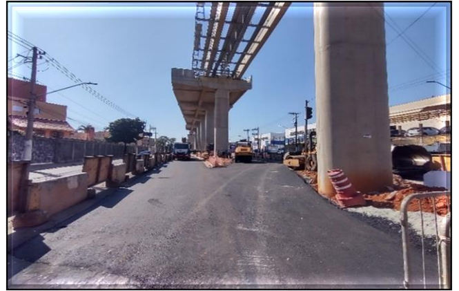
Obra Civil – Recomposição do viário.
