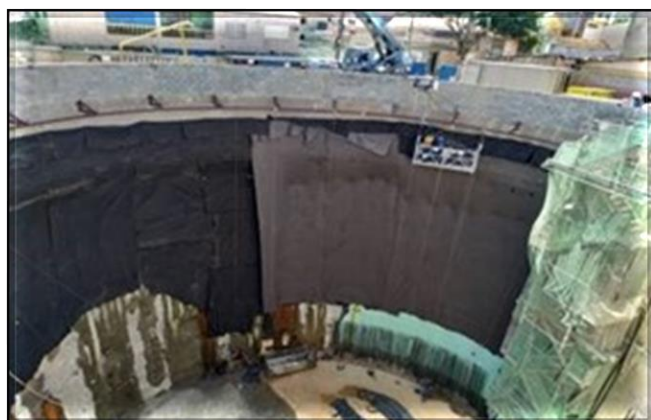
Impermeabilização do poço.
