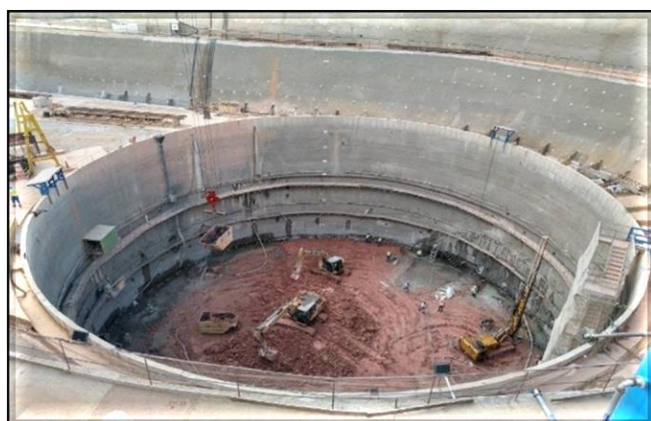
Escavação do poço do corpo da estação.
