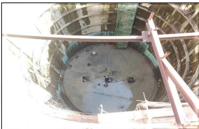
Laje de fundo do poço concretada
