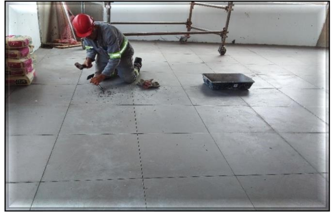
ETO/Obra civil – Execução do piso porcelanato no pavimento de escritórios.
