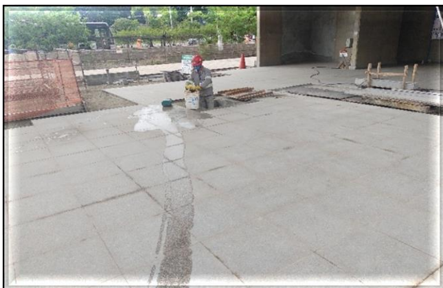
Corpo/Obra Civil – Execução da limpeza das caixas de passagem.
