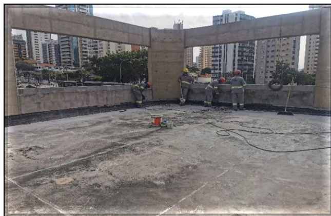
Edifício Técnico e Operacional-ETO/Obra Civil – Execução da demolição do piso para ajuste da impermeabilização.
