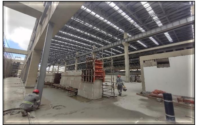
Bloco A – Execução da cobertura e do piso.
