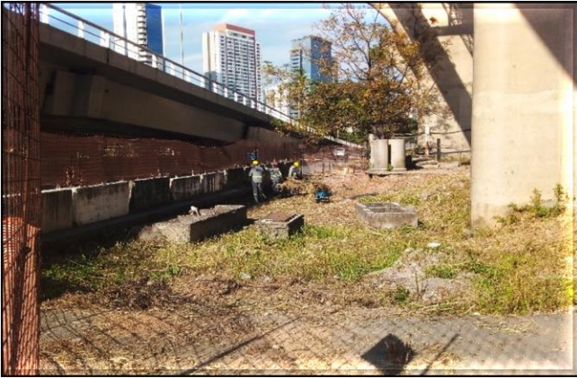
Canteiro/ Obra Civil – Limpeza e manutenção.
