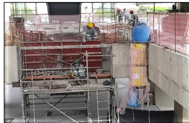
Corpo da estação/Obra Civil – Montagem de forma.
