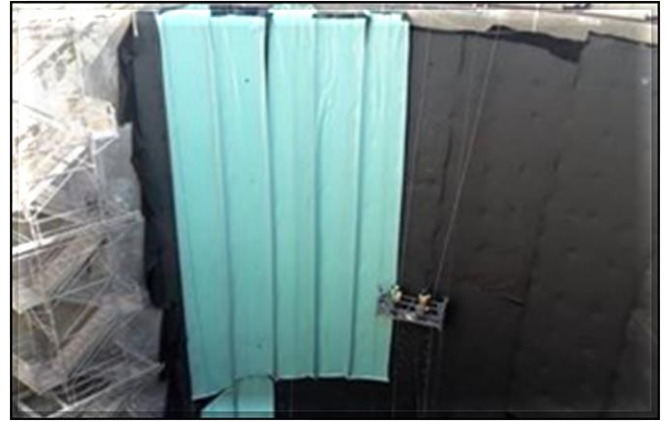
Impermeabilização do poço.
