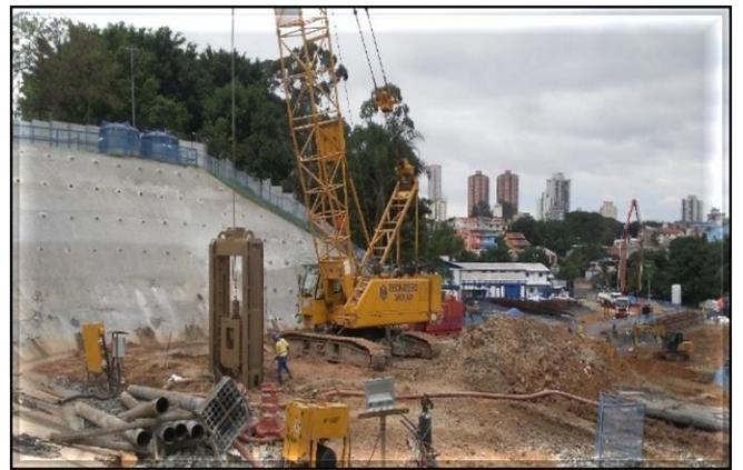
Parede diafragma da vala.
