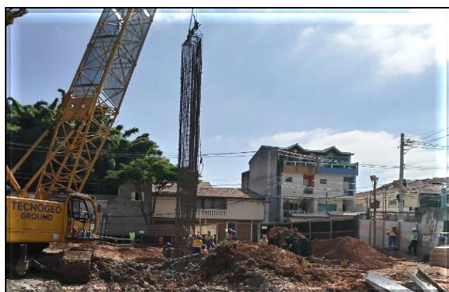
Parede diafragma da vala
