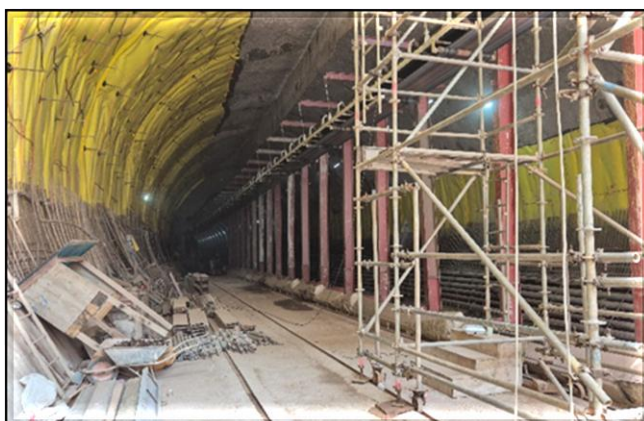
Impermeabilização do Túnel.
