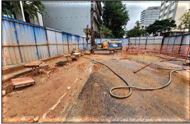
Avenida Liberdade (sentido bairro): execução das estacas raízes.
