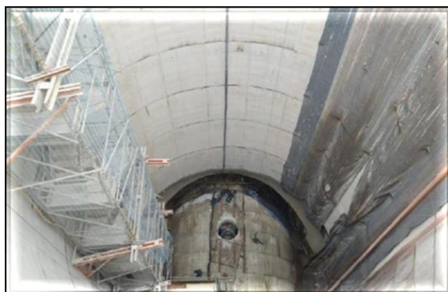
Vista do Poço.
