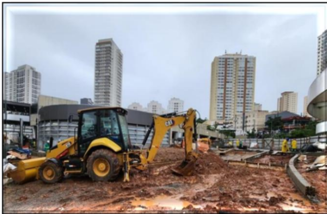
Exaustão 1 - Novo canal de ventilação da Plataforma 2 da estação Vila Prudente da Linha 2-Verde: recomposição do viário e paisagismo.
