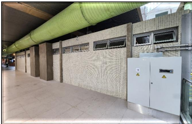
Linha 2-Verde - Novas Salas Operacionais: em andamento atividades de acabamento.
