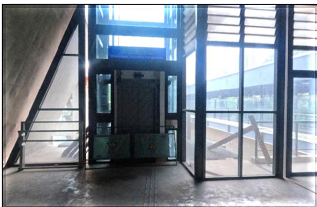
Sistemas – elevadores em instalação.
