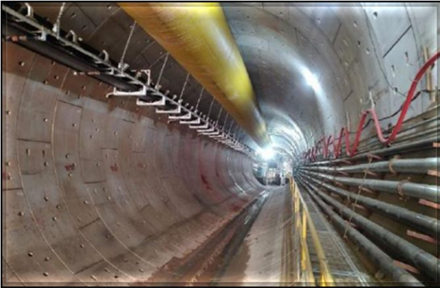
Vista da esteira transportadora de solo e túnel de via.
