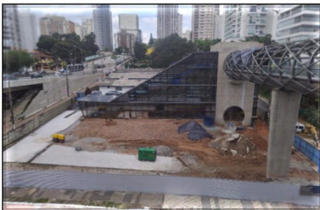
Obra Civil – execução da urbanização do Acesso.
