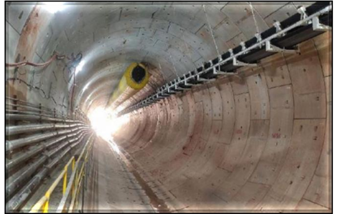
Vista da esteira transportadora de solo e túnel de via.
