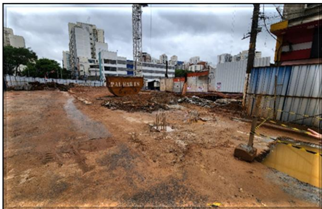
Rua Vergueiro (sentido bairro): estacas barrete concluídas. Execução das estacas raízes.
