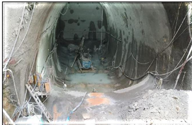
Escavação do túnel de ligação.
