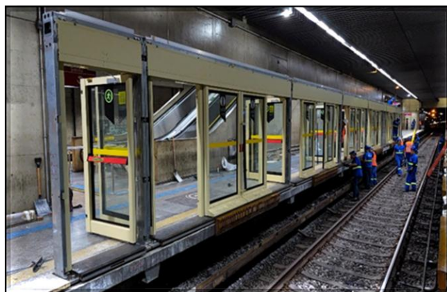
Fachadas e módulos das PSD's em instalação
