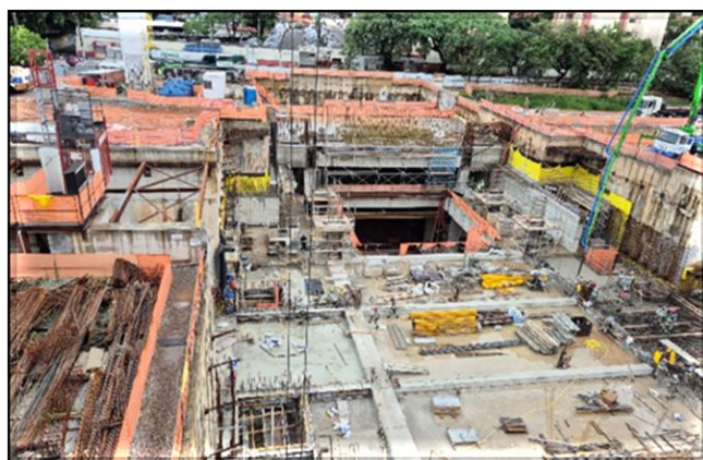
Estruturas de concreto do corpo da estação do Metrô Linha 2.
