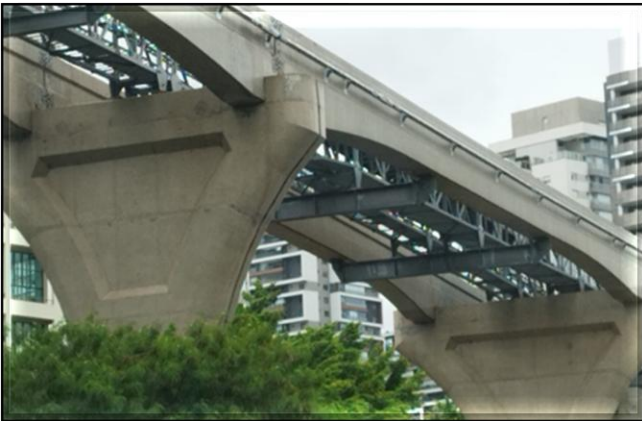
Sistemas – instalação do 3º e 4º trilhos para captação de energia entre as Estações Vila Cordeiro e Chucri Zaidan.
