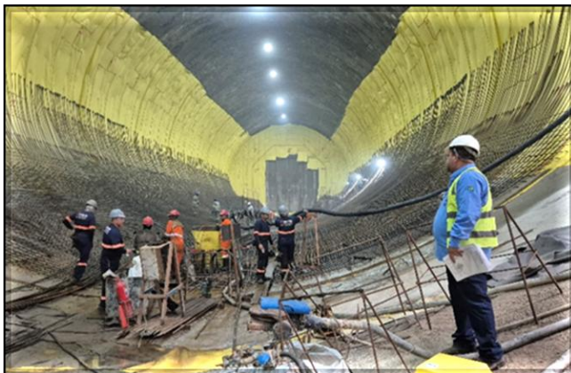
Armação do berço de arraste no túnel do corpo da estação.
