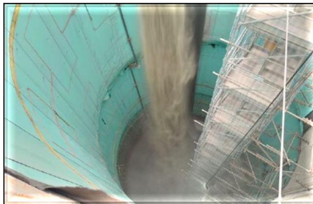
Aterro do Poço para escavação dos túneis direcionais.
