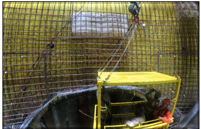
Poço principal: armação concluída e vista do emboque do túnel norte (sentido estação Paulista)
