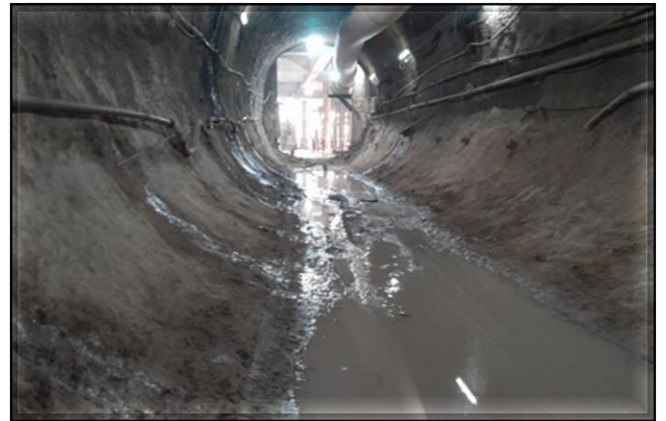
Escavação finalizada do túnel singelo.
