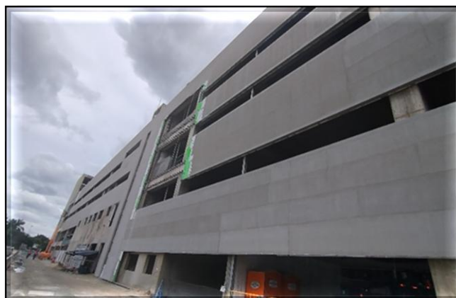
Civil – execução do acabamento dos Blocos.
