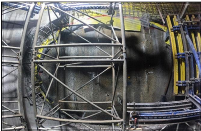
Poço principal: revestimento secundário parcialmente concluído e vista do emboque do túnel sul (sentido Estação Paulista)
