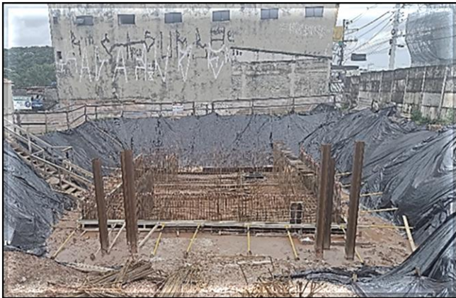
Obra Civil – execução das fundações do Acesso Norte.
