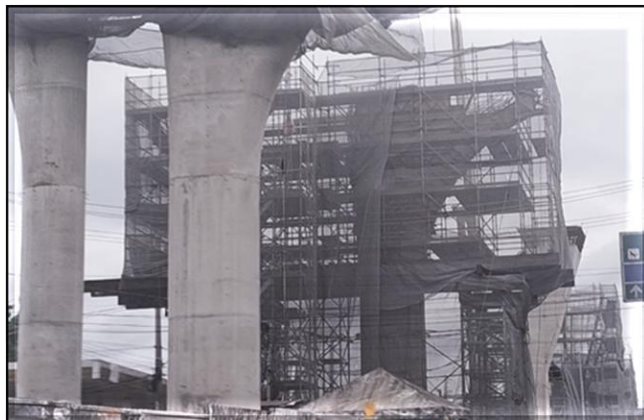
Obra Civil – execução dos pilares e capitéis da via elevada.
