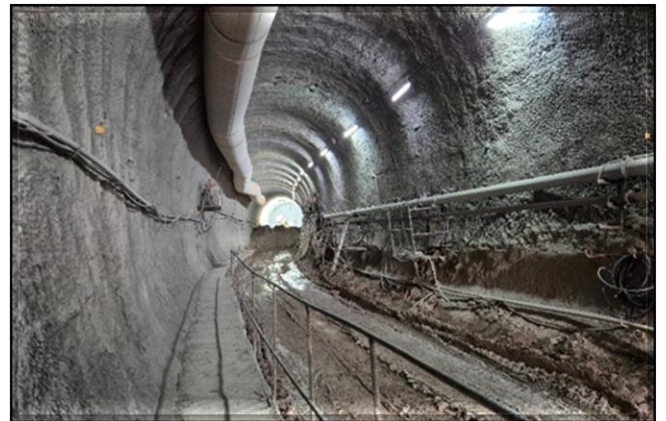
Escavação do túnel singelo.
