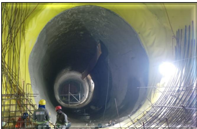
Proteção mecânica e armação do invert do túnel de via.
