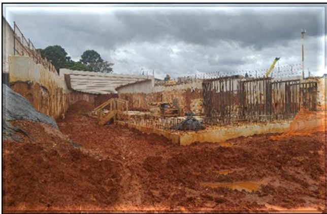
Obra Civil – execução das vias do pátio.
