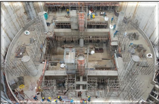
Estruturas de concreto do corpo da estação.
