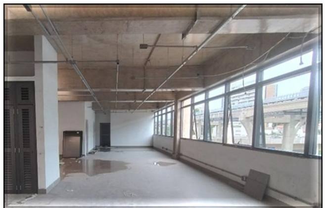
Obra Civil – instalação dos vidros. Sistemas – instalação do sistema de iluminação e tomadas.
