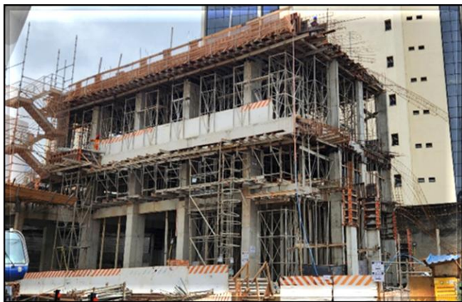
Novo Edifício Técnico Operacional (ETO): laje das salas técnicas "2" concretada. Montagem de armação e formas das estruturas das salas Operacionais.
