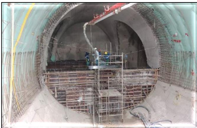
Laje de fundo para arraste da tuneladora.
