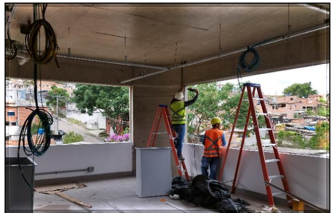
Obra Civil – execução do acabamento no ETO. Sistemas – instalação de iluminação e tomadas .
