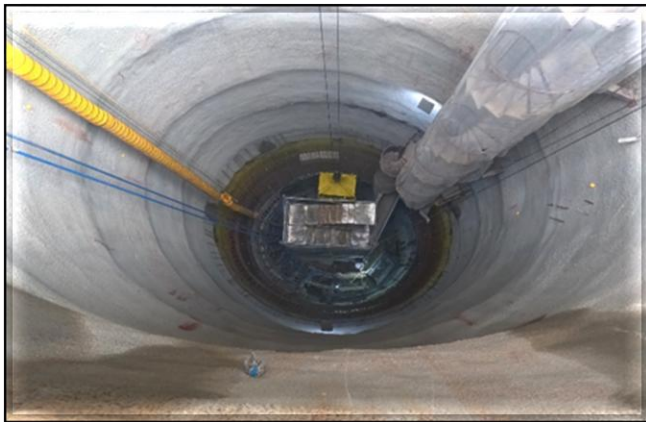
Vista do poço principal escavado.
