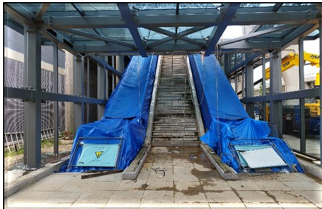
Obra Civil – instalação dos vidros da cobertura do Acesso C.
