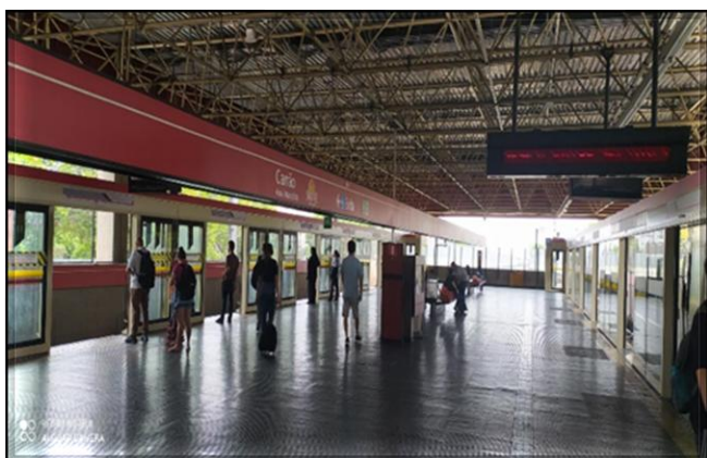
Fachadas das portas de plataforma | Em operação
