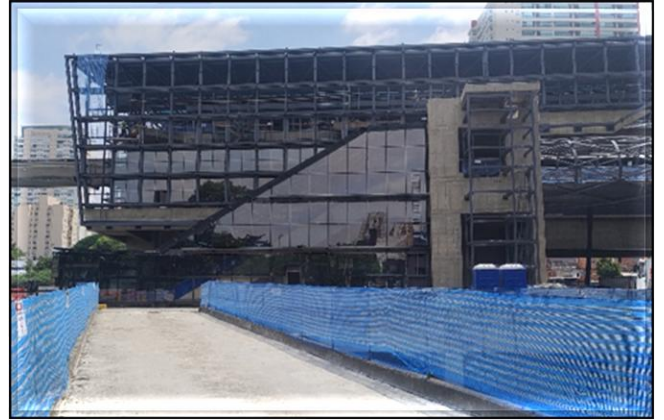
Obra Civil – instalação dos vidros no corpo da estação.
