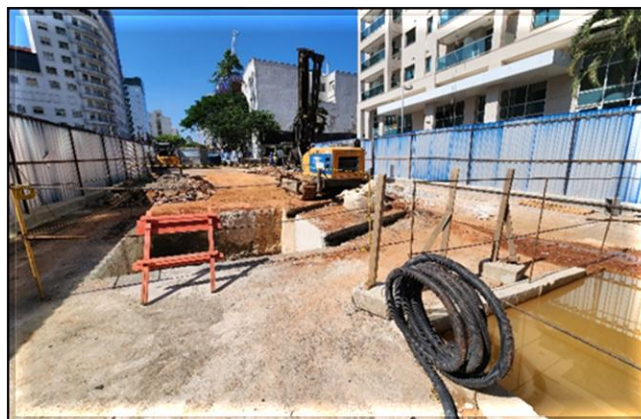
Avenida Liberdade (sentido bairro): preparação para execução das estacas raízes.
