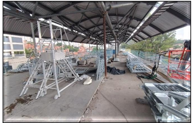
Obra Civil – instaladas as telhas da cobertura da plataforma.
