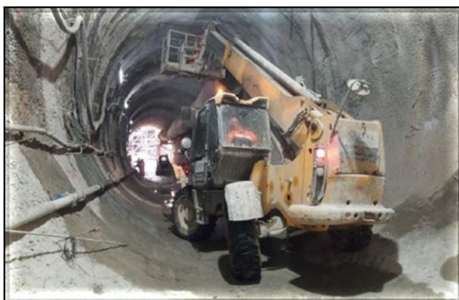
Impermeabilização do túnel de transição.
