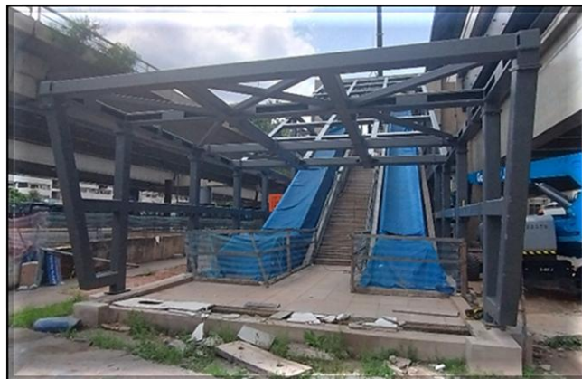
Obra Civil – instalação da estrutura metálica do Acesso B.
