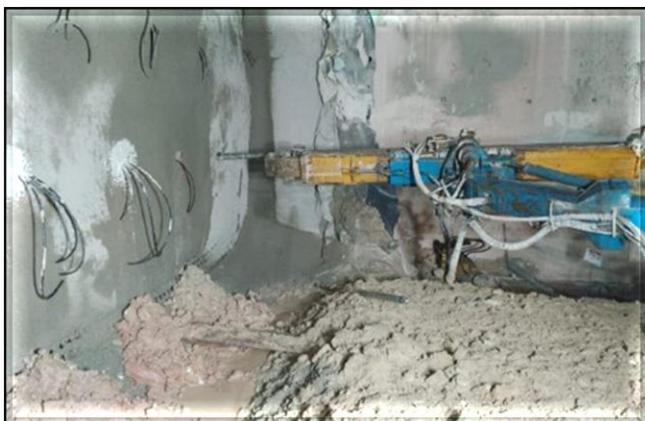
Tratamento para a tuneladora.
