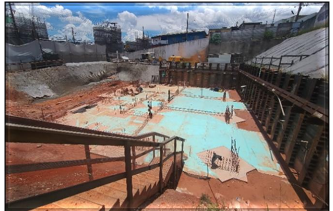
Obra Civil – impermeabilização dos blocos do edifício técnico.
