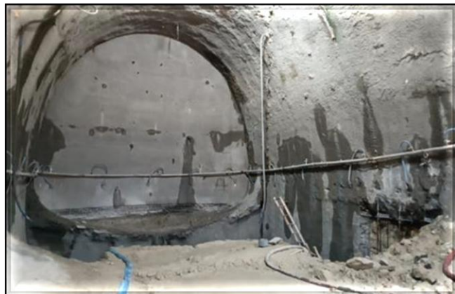
Escavação do túnel de ligação.
