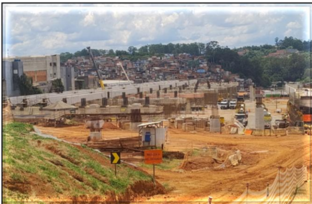
Obra Civil – vias de estacionamento.
