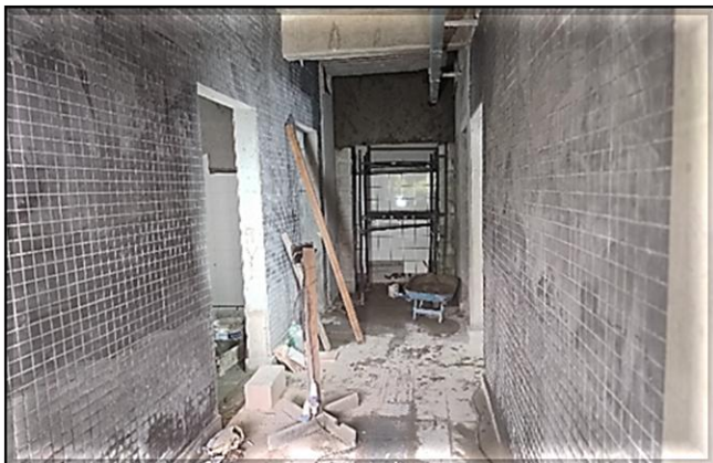
Obra Civil – execução do acabamento nas salas operacionais.
