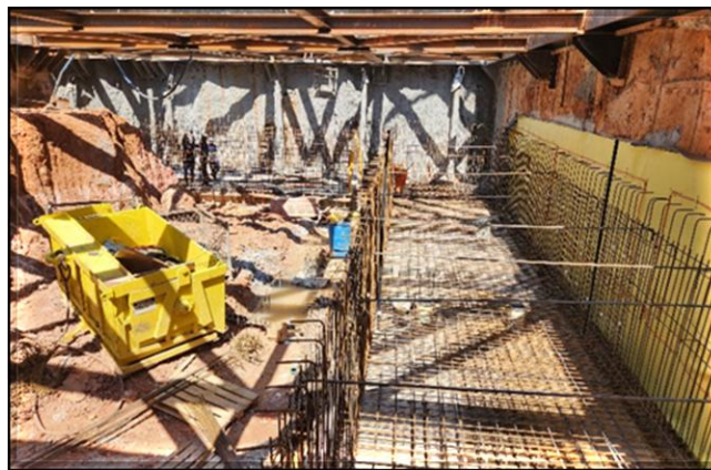
Galeria de Cabos: armação da laje de fundo e paredes laterais.
