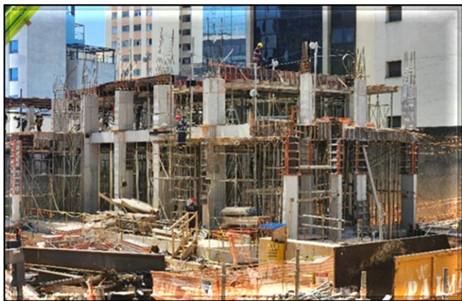
Novo Edifício Técnico Operacional (ETO): laje e estruturas das salas de trafos e GGD concretadas. Montagem de armação e forma das salas técnicas 2
