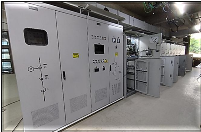
Sistemas – cubículos de tração em fase de testes.
