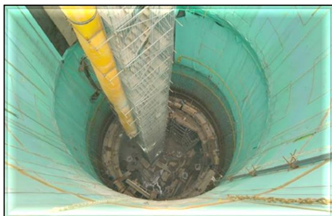
Revestimento secundário do Poço.
