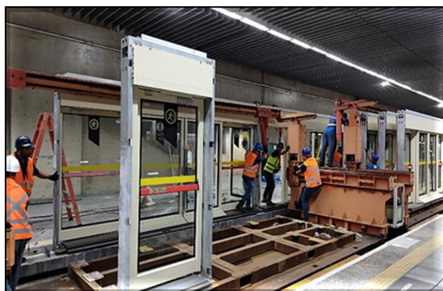
Fachadas e módulos das PSD's em instalação
