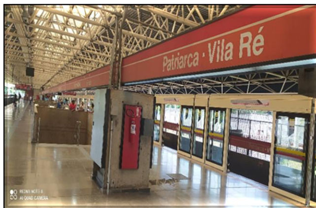
Fachadas das portas de plataforma | Em operação
