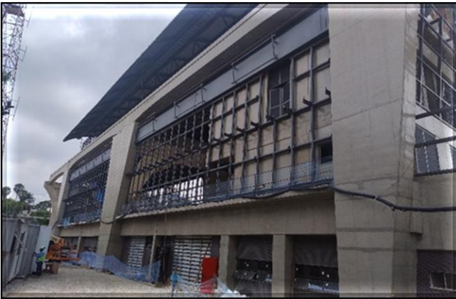
Obra Civil – instalação da estrutura metálica do corpo da estação.
