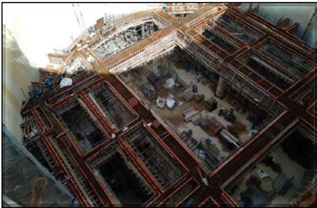
Estruturas de concreto do corpo da estação.
