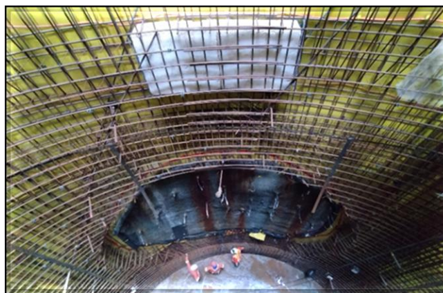
Poço principal: armação concluída e vista do emboque do túnel norte (sentido Estação Paulista)
