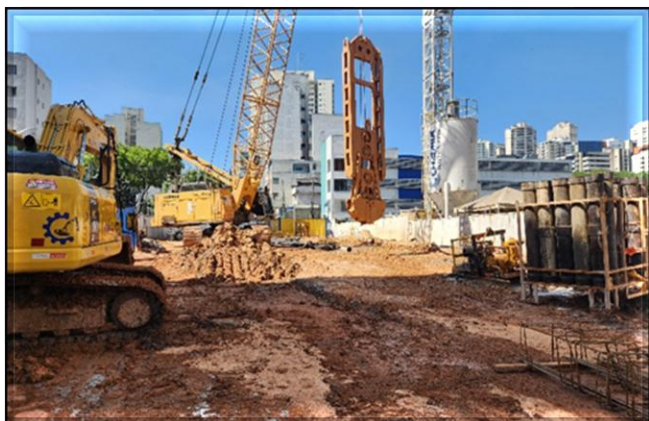
Rua Vergueiro (sentido bairro): parede diafragma concluída. Execução das estacas barrete.
