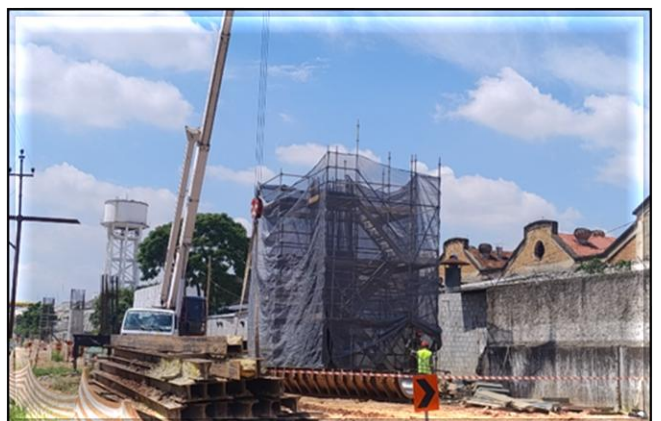
Obra Civil – armação, forma e concretagem dos pilares da via elevada.
