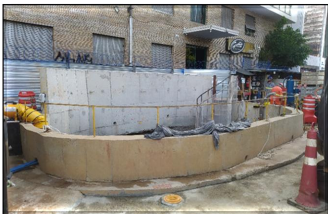
Vista da viga de borda do poço principal.
