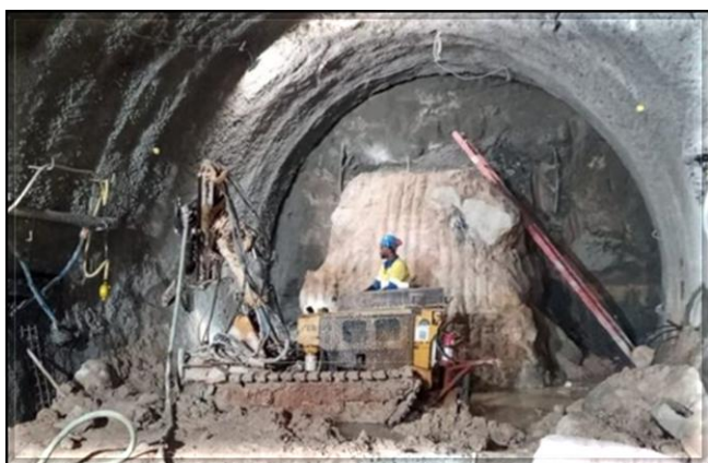
Escavação do túnel.
