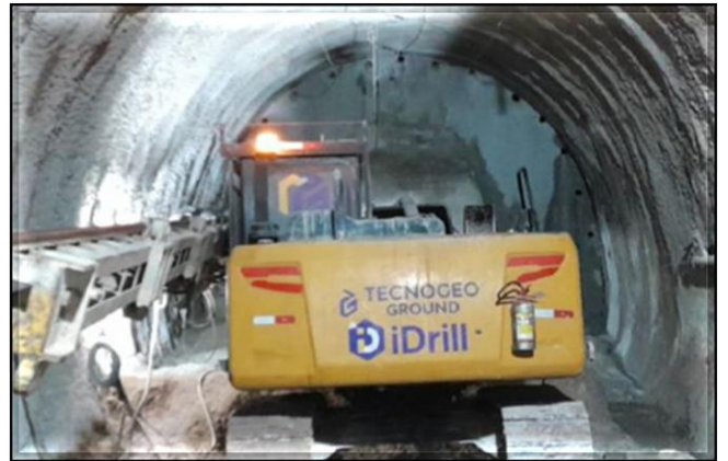
Escavação do túnel singled.
