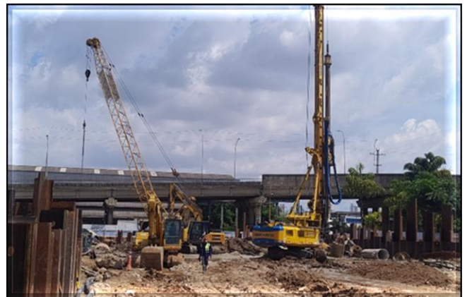
Obra Civil – execução das estacas de fundação do corpo da estação.
