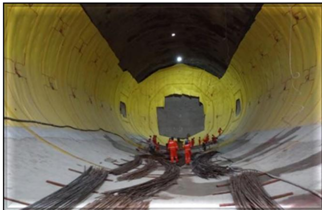
Armação do berço de arraste no túnel do corpo da estação.
