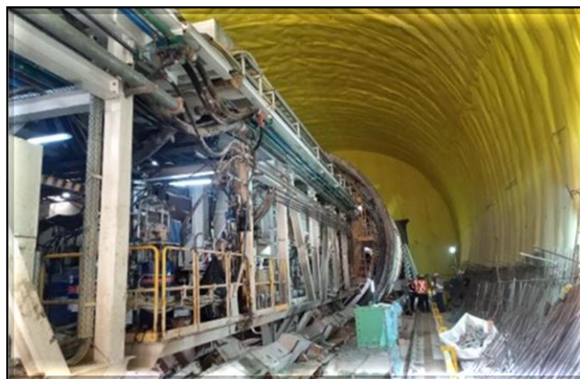
Impermeabilização do túnel do corpo da estação.
