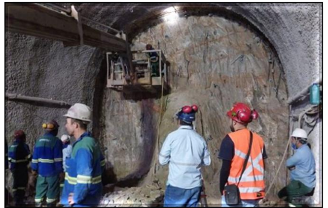
Escavação do túnel singled.
