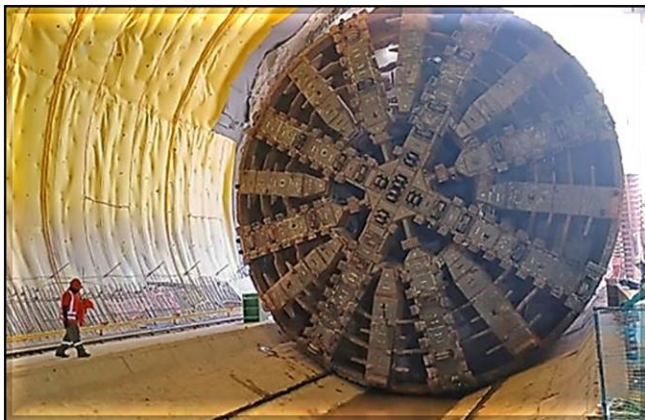
Vista da roda de corte no arraste na estação Santa Clara.
