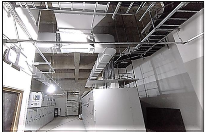
Sistemas – lançamento de cabos nos cubículos de média tensão e de tração nas salas técnicas.
