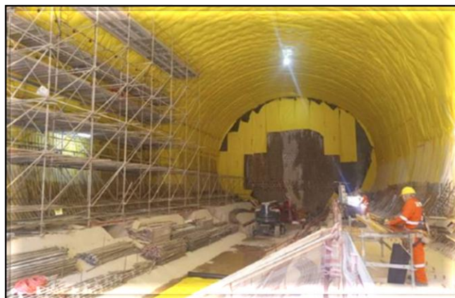
Impermeabilização do túnel do corpo da estação.
