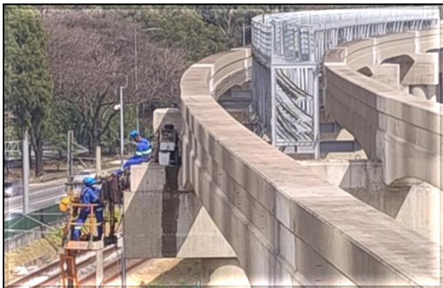
Obra Civil – Lote 07, consolidação da via, montagem da passarela de emergência.
