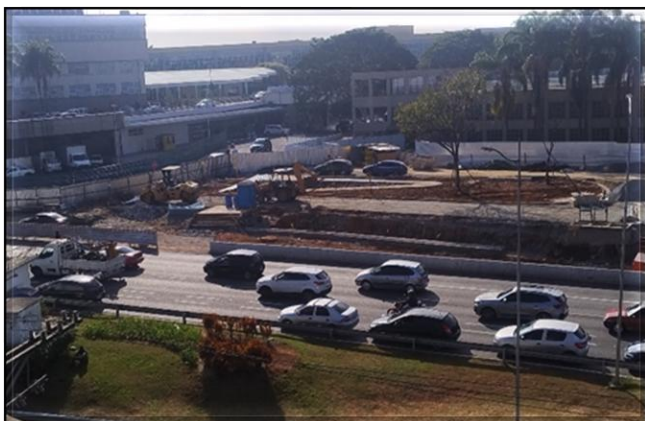
Obra Civil – urbanização e viário do Acesso 2.
