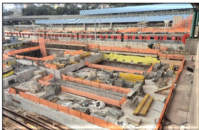
Estruturas de concreto do corpo da estação da Linha 2 do Metrô.
