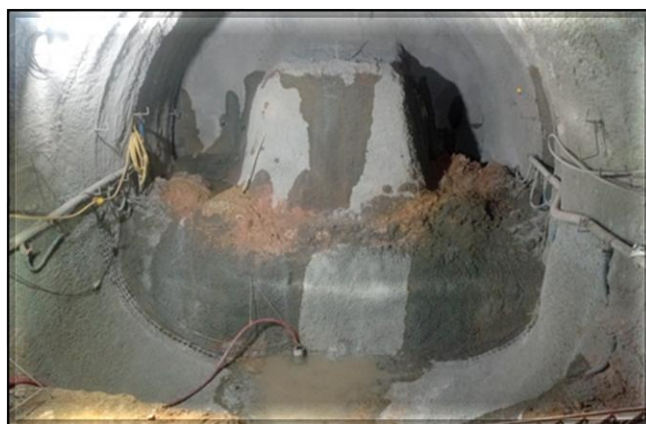
Escavação do túnel.
