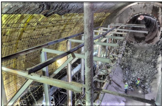
Impermeabilização e revestimento secundário do túnel do corpo da estação.
