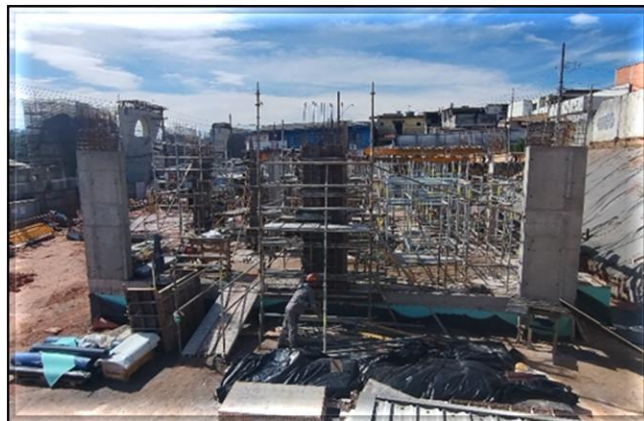
Obra Civil – realizado aterro da vala, em andamento os pilares das Salas Técnicas de nível 1 do Edifício Técnico Operacional.
