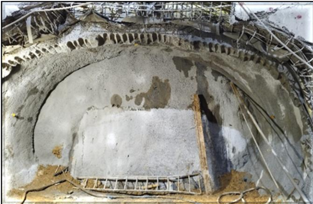
Túnel sul: Escavação da sexta cambota concluída.
