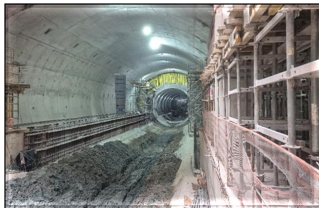
Estruturas de concreto do túnel de corpo da estação
