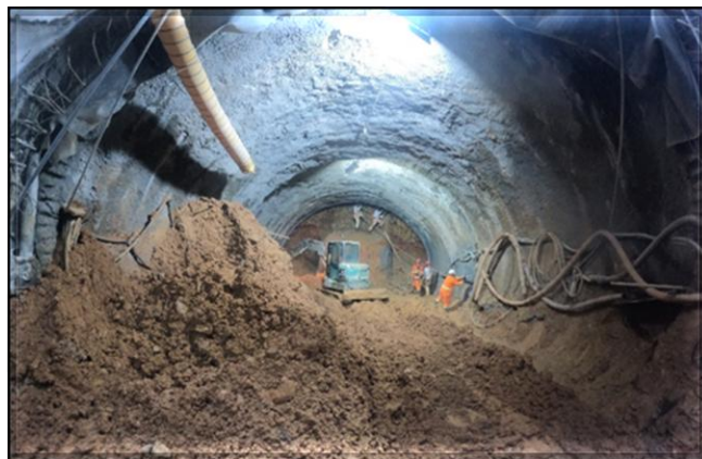
Túnel norte: Escavação da 24ª cambota concluída.
