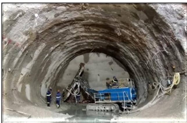
Escavação dos túneis direcionais para a tuneladora.
