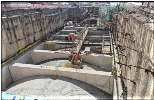
Impermeabilização da laje de cobertura e estruturas de concreto do corpo da estação.
