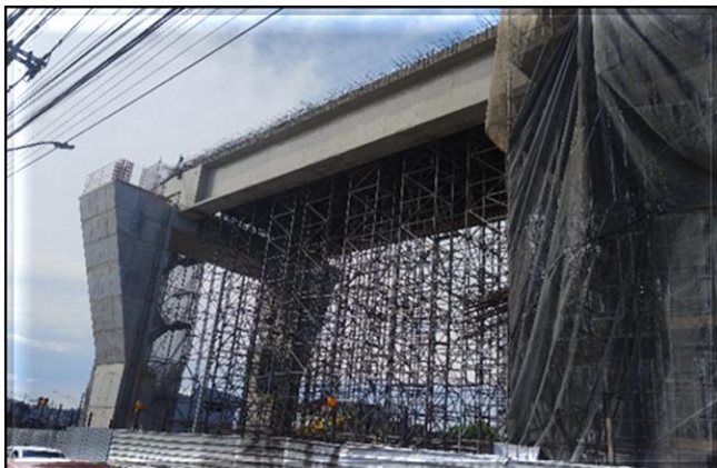
Obra Civil – execução da laje da plataforma.
