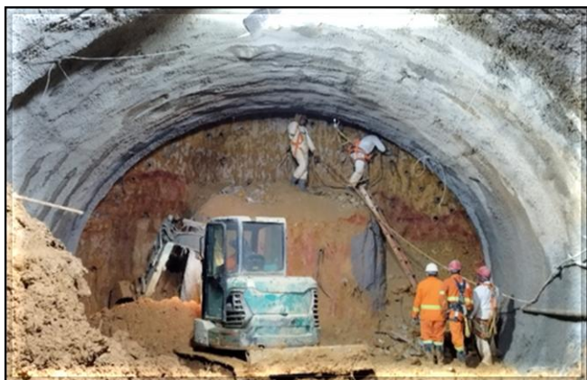
Túnel norte: Escavação da 24ª cambota concluída.
