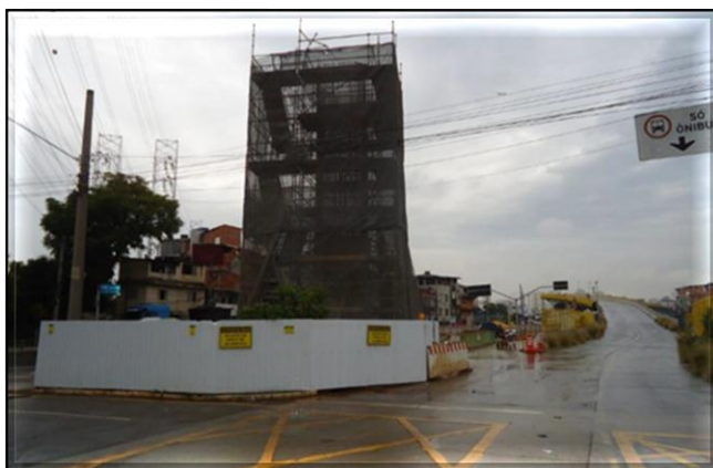
Obra Civil – execução de pilar da via elevada em frente à Comunidade da Vila Prudente.
