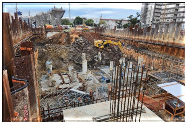
Obra Civil – execução dos blocos de fundação e escavação da vala do corpo da estação.
