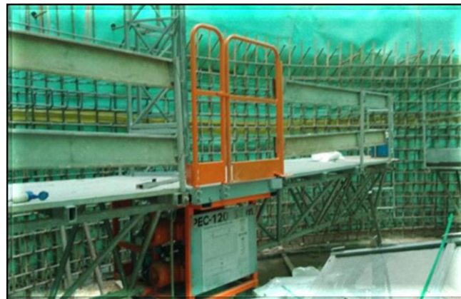
Revestimento secundário do Poço.
