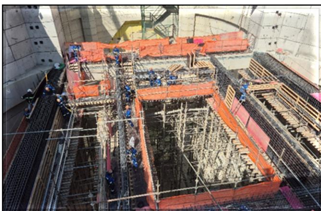
Estruturas de concreto do corpo da estação.
