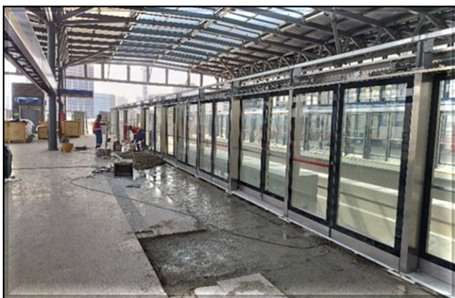
Obra Civil e Sistemas – instalação do piso de granito e montagem das Portas de Plataforma.
