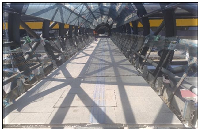
Civil – instalação dos suportes dos corrimãos das passarelas.
