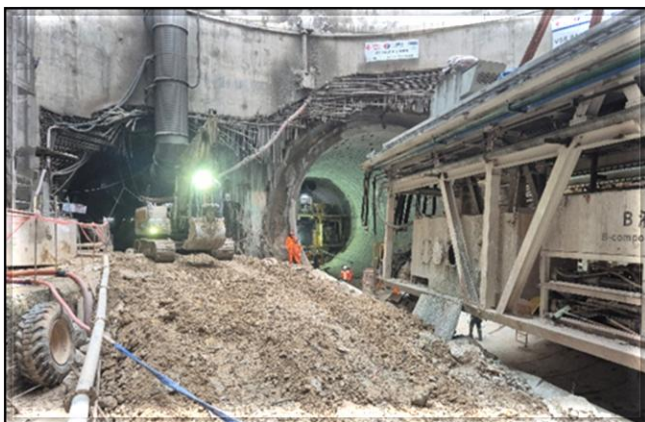
Desmontagem da tunneladora na VSE Falchi Gianini.
