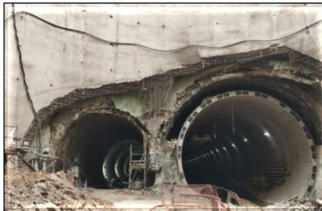
Demolição do túnel falso do túnel de via.
