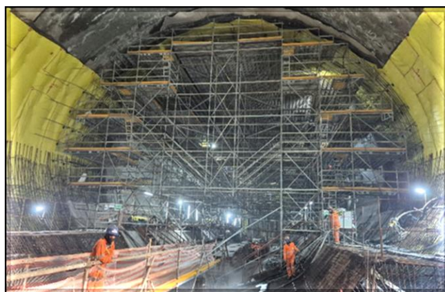
Impermeabilização, laje de fundo e revestimento secundário do túnel do corpo da estação.
