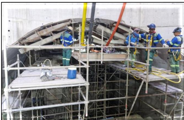
Revestimento secundário do túnel de ligação.
