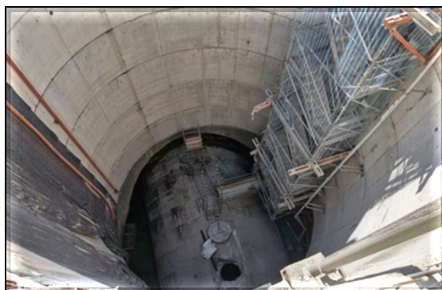
Vista superior do poço.
