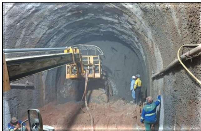
Escavação do túnel singelo de estacionamento.
