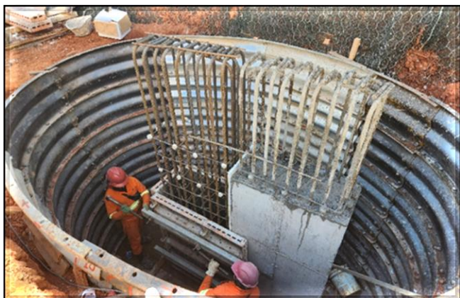
Rua Vergueiro (sentido bairro): Armação e concretagem dos pilares de sustentação da laje da ampliação do mezanino.
