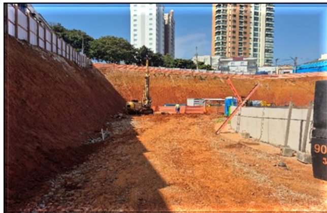
Execução dos poços profundos para rebaixamento de lençol freático.
