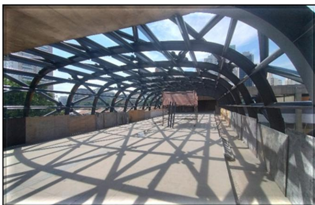
Obra Civil – instalação dos suportes dos vidros da passarela do Acesso 1.
