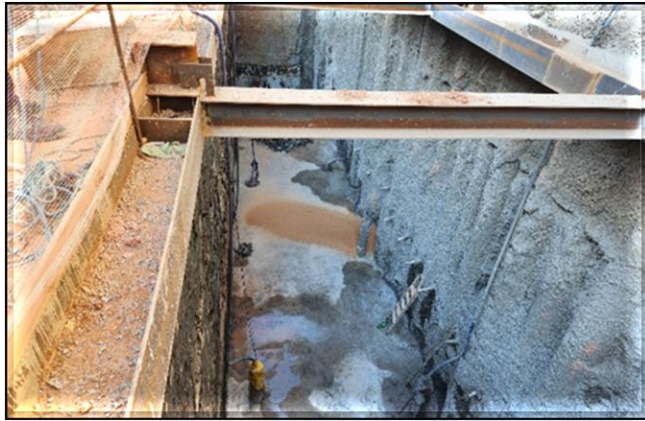
Avenida Liberdade (sentido bairro): Escavação da vala concluída.
