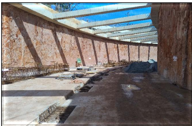
Obra Civil – execução da laje de fundo e infraestrutura da vala.
