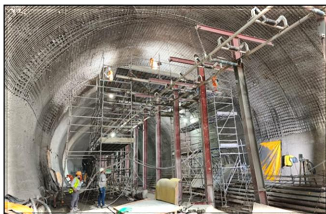
Revestimento secundário do túnel.
