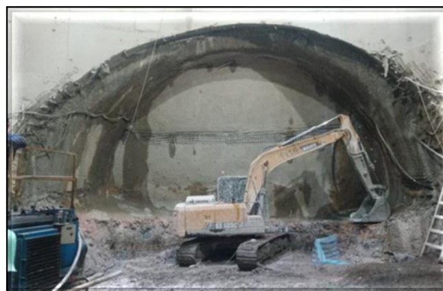
Escavação dos túneis direcionais.
