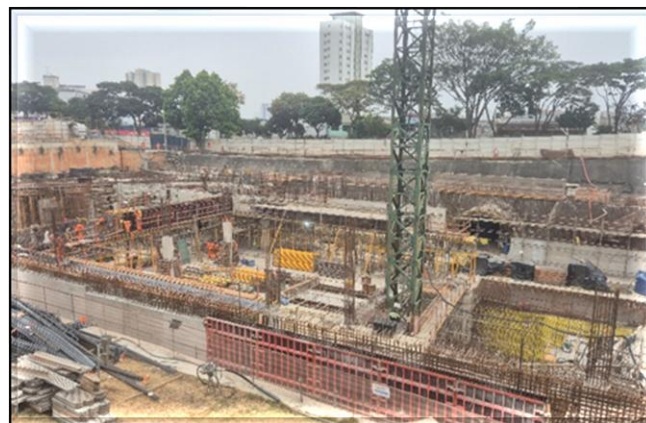
Estruturas de concreto do corpo da estação.
