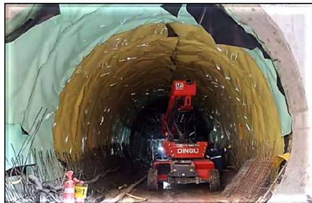
Armação do revestimento secundário em execução (aplicação de tela metálica).
