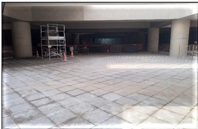
Execução dos pisos no corpo da estação.
