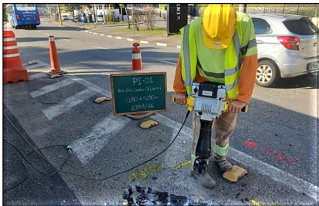
Sondagens complementares para implantação do novo viário e acessos.
