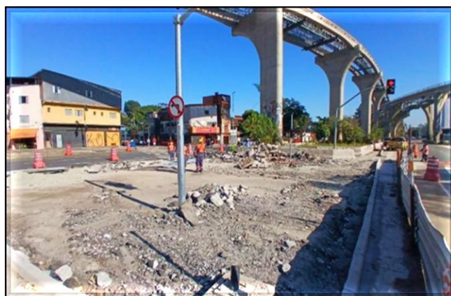
Lote 15 (próximo à estação Washington Luís): assentamento de guias e adequação do viário na Av. Jornalista Roberto Marinho.
