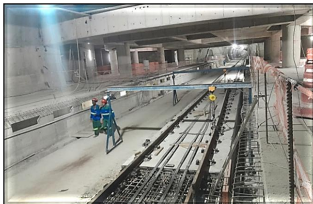
Estação Orfanato: estrutura da laje flutuante e fixação dos trilhos em execução.
