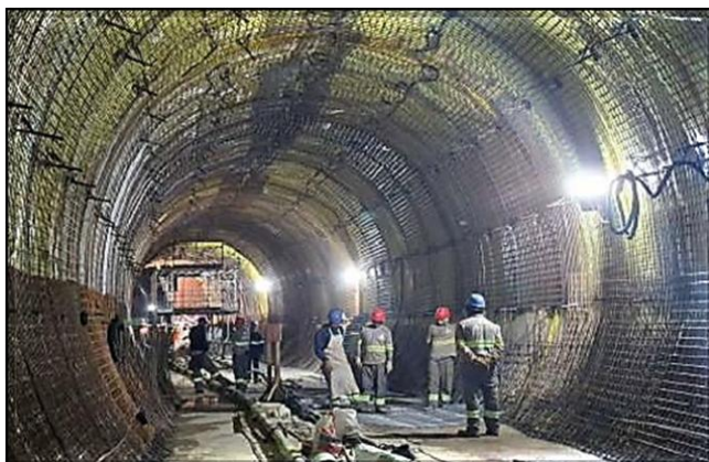
Armação das paredes para execução do revestimento secundário.
