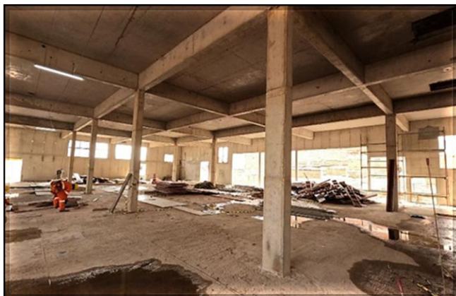
Estrutura de concreto das salas técnicas concluída.
