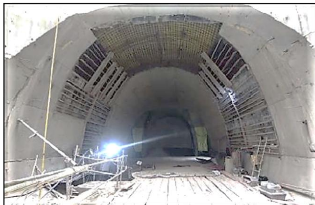
Vista geral do túnel de ligação.
