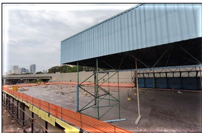
Vista da laje de trabalho para execução de nova cobertura metálica.
