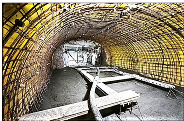
Túnel sul: concretagem da base estrutural ( invert ).
