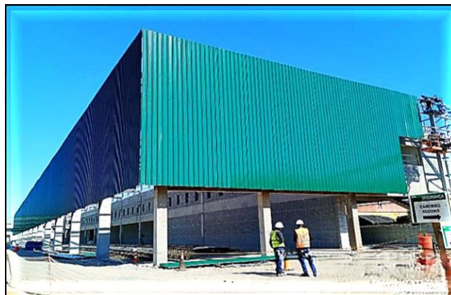
Fechamento lateral da cobertura metálica do Bloco A1.
