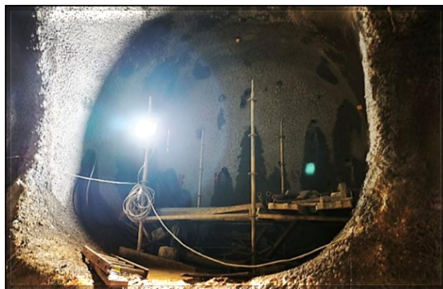
Túnel norte: revestimento primário do patamar de descanso 2 concluído.
