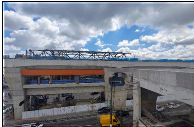
Obra Civil – montagem da cobertura da plataforma.
