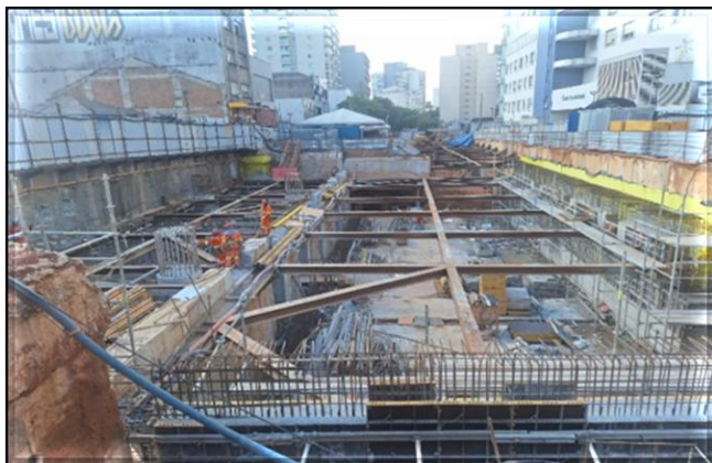
Execução das estruturas de concreto na área de integração lado leste.
