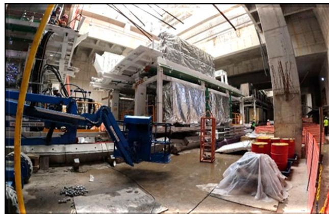
Montagem da estrutura de reação da tuneladora.
