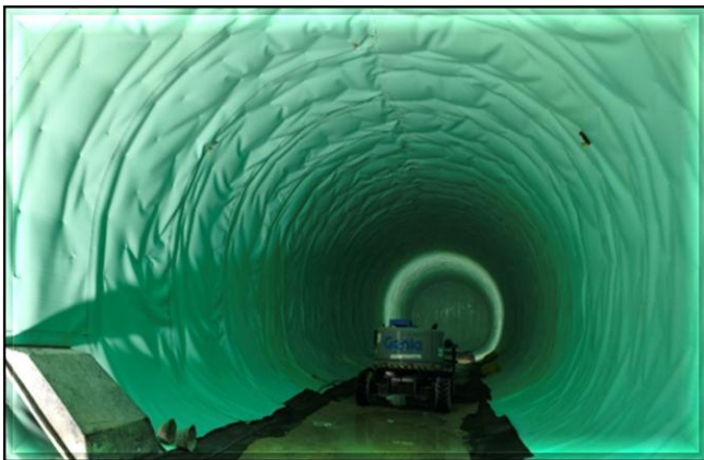
Impermeabilização do túnel em execução.
