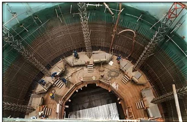
Armação do revestimento secundário em execução.
