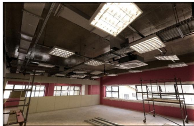
Bloco LMN – divisórias e portas em instalação.
