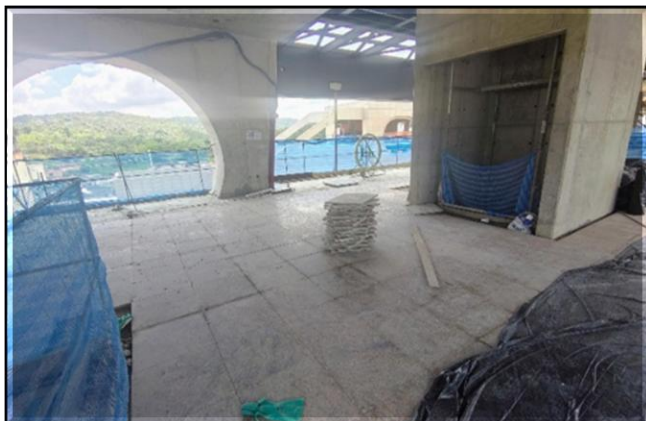
Obra Civil – execução do piso de granito do mezanino.
