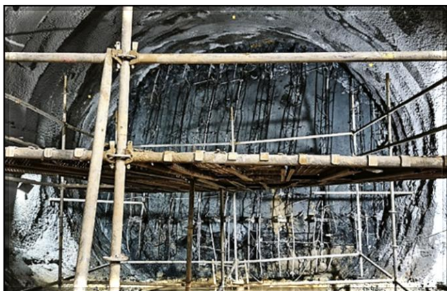
Túnel norte: preparação para retirada do revestimento secundário da estação Paulista.
