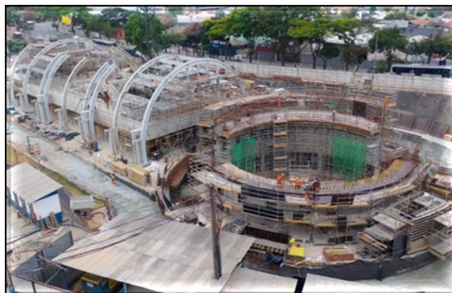
Montagem da estrutura metálica da cobertura do Acesso B em execução.
