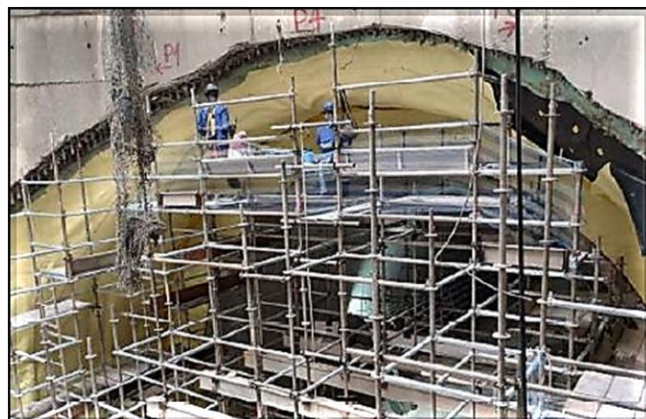
Impermeabilização do túnel direcional sentido Poço Capitão em execução.
