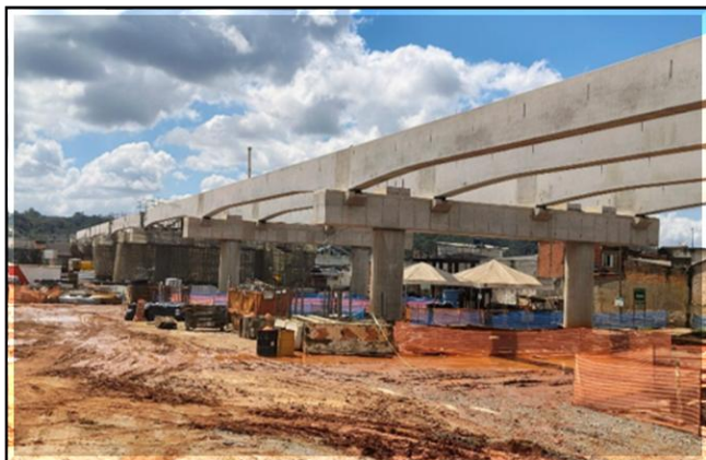
Obra Civil – concluído o lançamento das vigas-guia do estacionamento leste
