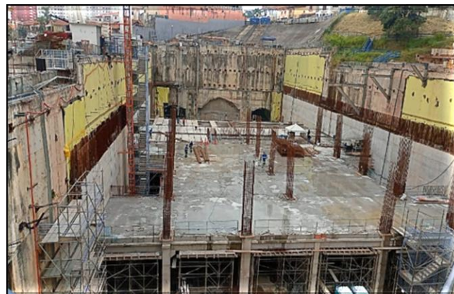
Vala principal: instalação das lajes pré-fabricadas.
