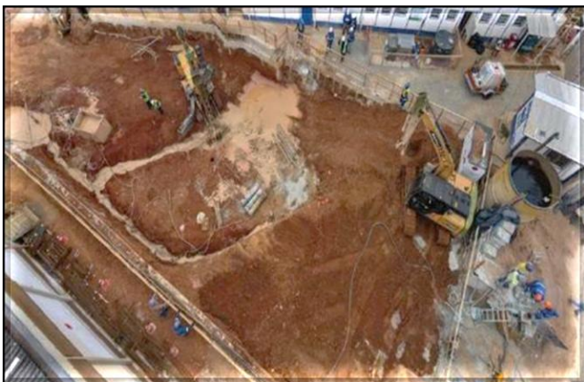
Execução de estacas de fundação na área da sala de média tensão e do porão de cabos.
