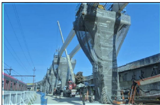
Obra Civil – execução da monolitização do trecho entre a estação Ipiranga e Vila Prudente.
