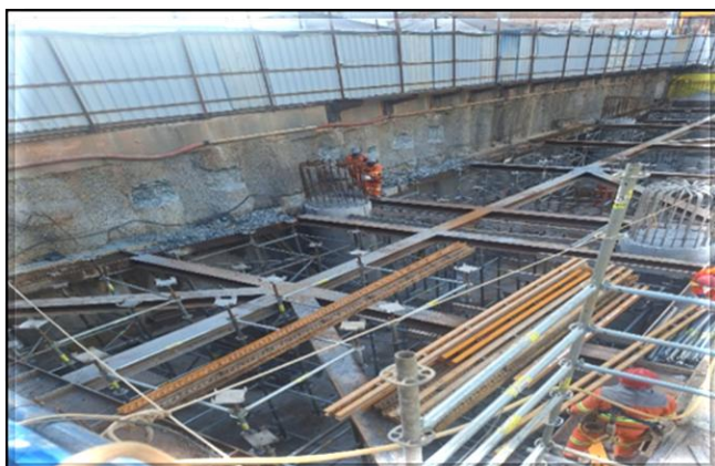
Execução dos pilares e escoramento das vigas na área de integração lado oeste.
