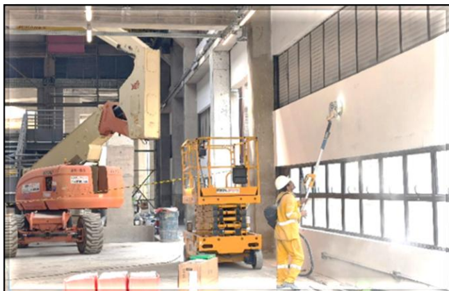
Bloco C – tratamento das paredes do lado interno.
