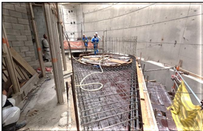
Formas e armação na região dos canais de ventilação.
