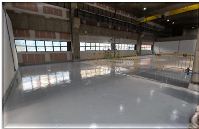
Bloco A – execução do piso.
