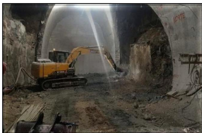
Túnel direcional de chegada: início da segunda etapa de escavação.
