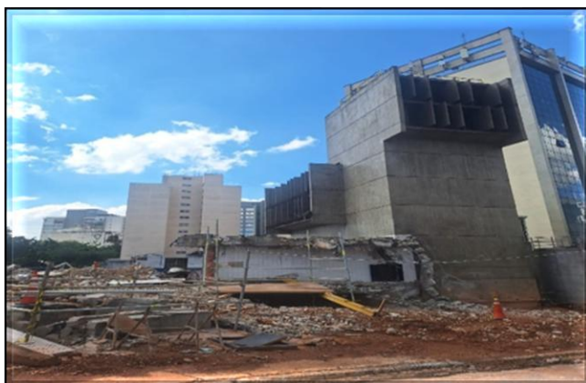
Limpeza de área para as obras de ampliação do Acesso Leste.
