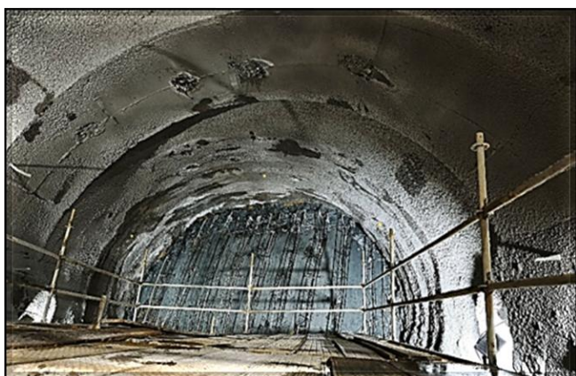
Túnel norte: pórtico para transferência de carga da fundação do edifício técnico da estação Paulista concretado.
