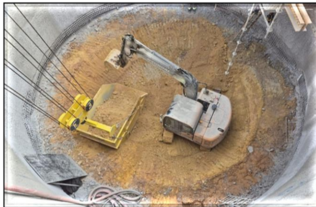
Revestimento primário e escavação em execução.
