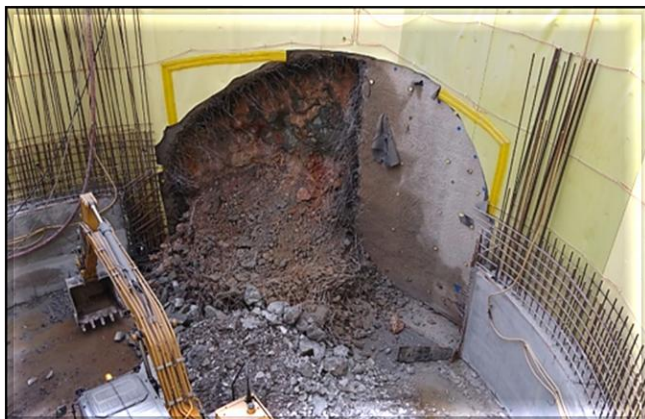
Escavação do túnel de ligação entre o Acesso A e o corpo da estação.
