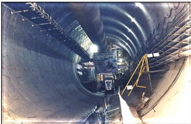
Tuneladora em atividade após a estação Aricanduva.
