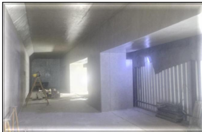
Tratamento das estruturas de concreto concluído.
