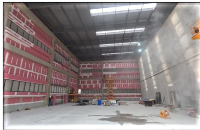
Bloco E – lixamento das paredes em execução.
