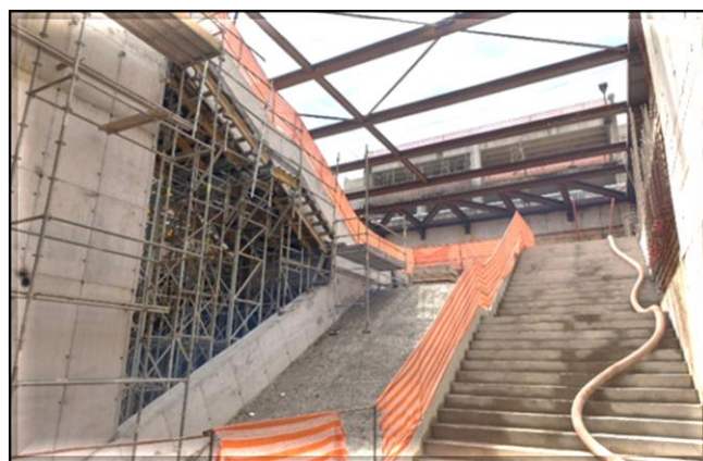
Escadas fixas do acesso em execução.
