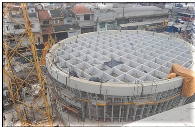
Cobertura metálica do Acesso B em execução.
