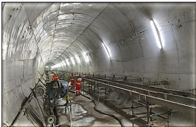
Túnel Via E3: armação para as vigas das passarelas de emergência em execução.
