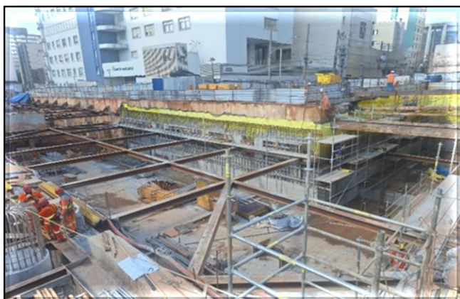
Execução das estruturas de concreto na área de integração com o acesso Pirapitingui (parte nova)
