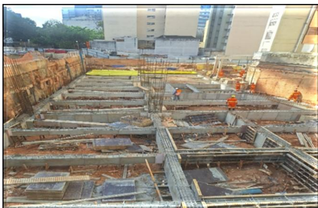
Execução das fundações.
