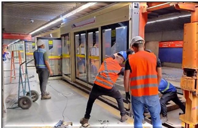
Montagem dos módulos em andamento.
