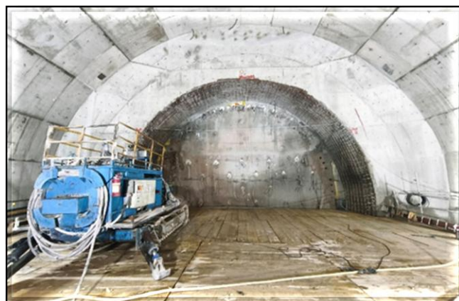
Tratamento de partida da Tunnel Boring Machine - TBM no corpo da estação.
