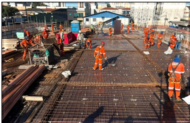
Armação da laje de cobertura das Salas Técnicas em execução.
