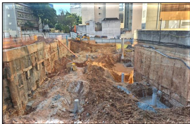
Arrasamento de estacas.
