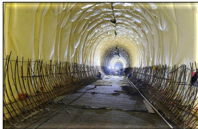
Concretagem do invert e execução da armação do revestimento secundário no Túnel 4 Norte (sentido estação Santa Isabel).
