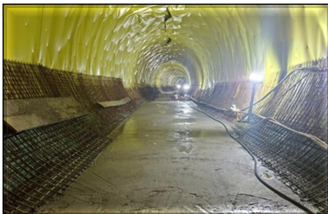
Armação do revestimento secundário em execução.
