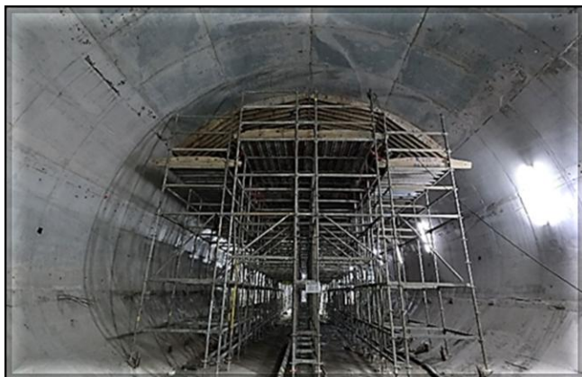
Revestimento secundário do túnel: formas, armação e concretagem da abóbada em execução no túnel duplo.
