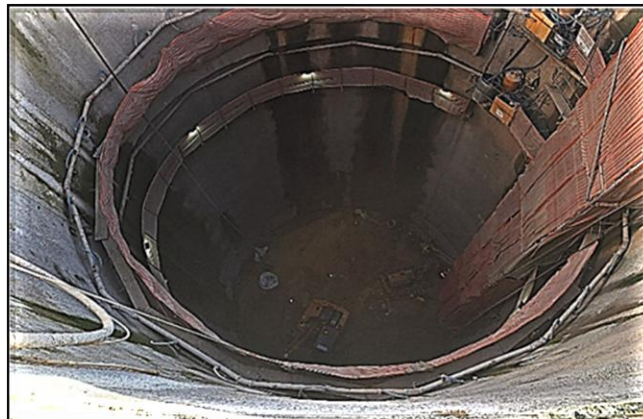
Execução de ponteiros filtrantes para rebaixamento de lençol freático durante escavação do poço principal.
