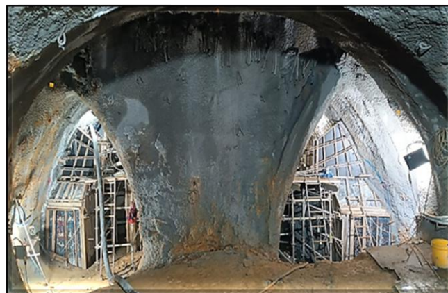
Túnel norte: side-drifts direito e esquerdo na cambota 91.
