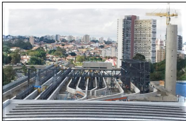
Vista das vias superiores, passarelas e estrutura metálica da máquina de lavar trens.
