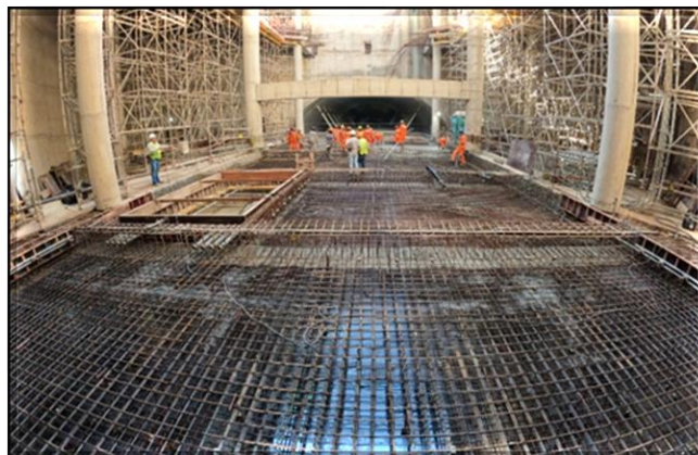
Armação e concretagem da laje do nível mezanino, acima das plataformas.
