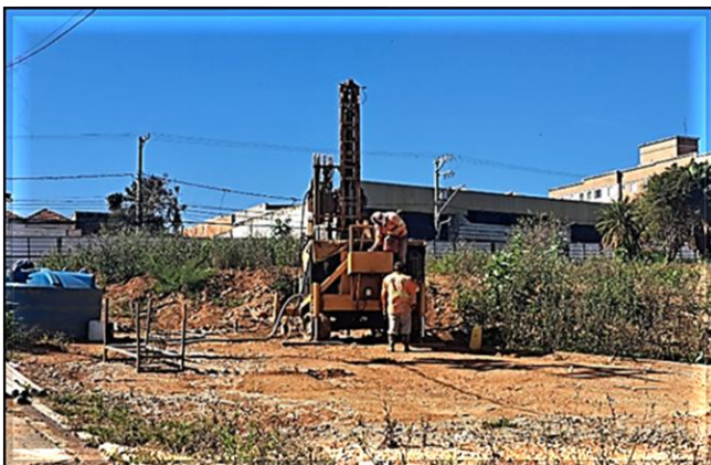
Sondagens em execução.
