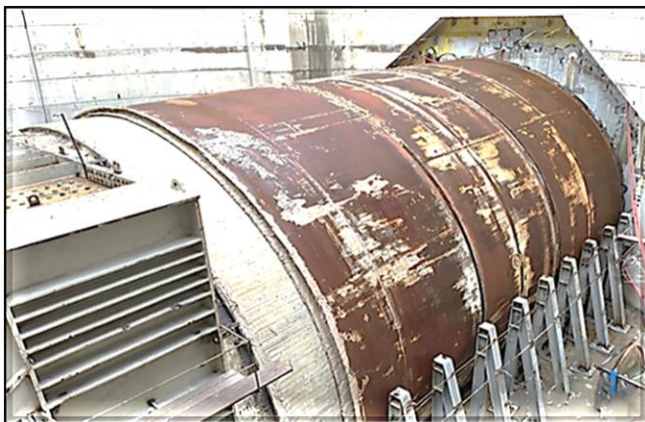
Tuneladora posicionada na estação Aricanduva.
