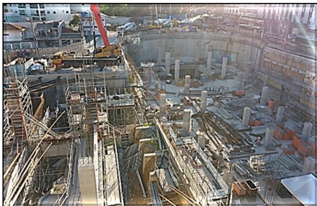
Vista superior do Acesso B (nível bilheterias) e do Acesso C (vigas e pilares em execução).
