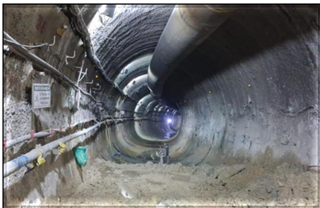
Retirada de material do túnel de estacionamento.
