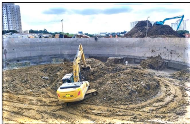
Escavação e revestimento primário em execução.
