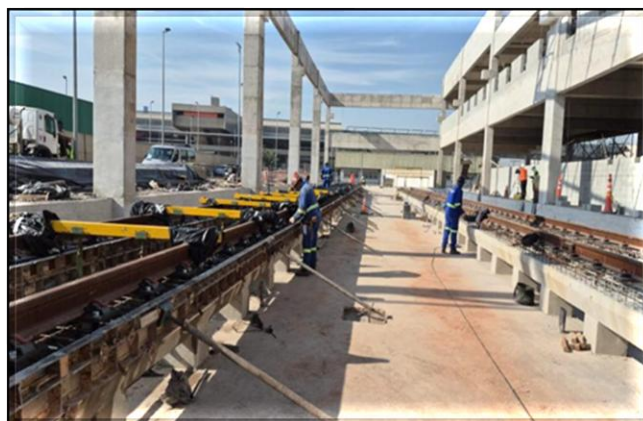
Concretagem da via 14 do Bloco A1.
