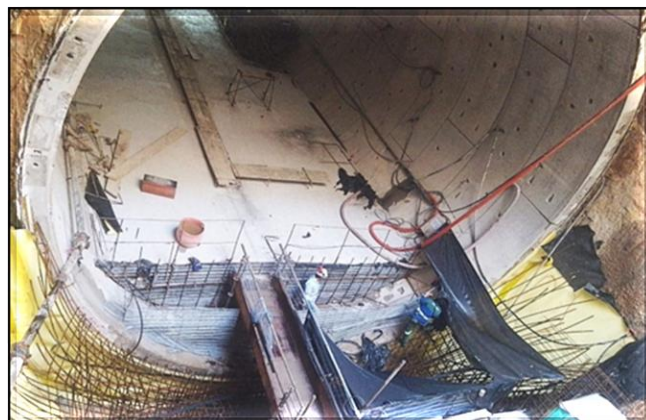
Montagem da armação no túnel direcional, sentido estação Santa Clara.
