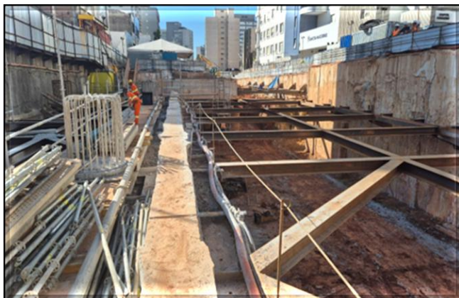
Escavação para execução da Área de Integração lado leste.
