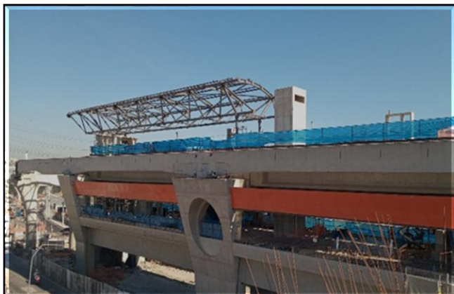
Obra Civil – lançado o primeiro módulo da estrutura da cobertura da Plataforma.
