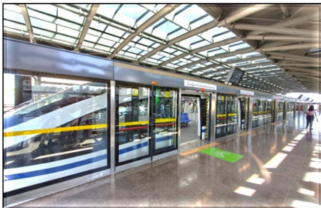
Corpo da Estação – Plataforma durante operação assistida.
