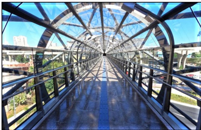
Passarela entre o Acesso 2 e o corpo da estação.
