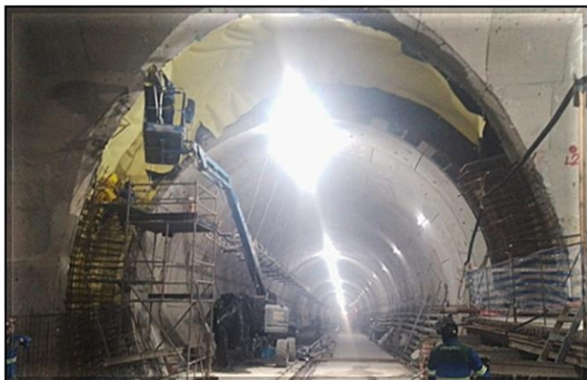
Montagem da impermeabilização e da armação do revestimento secundário no túnel de ligação à via.
