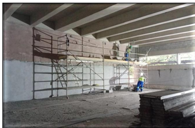
Acabamento em alvenaria de vedação no edifício das Salas Técnicas.
