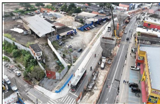
Obra Civil – execução das fundações, pilares e dos capitéis entre as estações Boa Esperança e Jacu-Pêssego.
