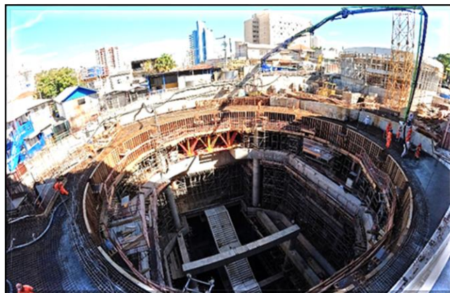
Concretagem da laje do nível térreo do Poço Principal.
