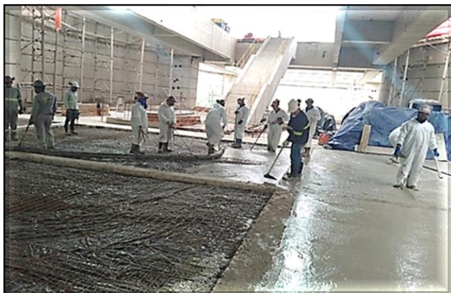
Concretagem das capas das lajes rebaixadas do mezanino superior.
