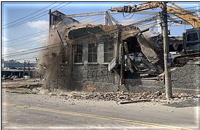
Demolição dos imóveis desapropriados em execução.
