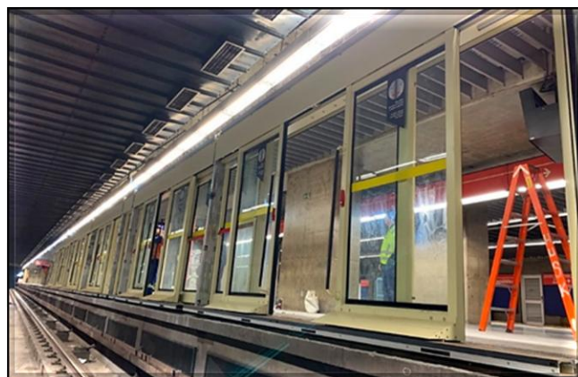
Montagem dos módulos em andamento
