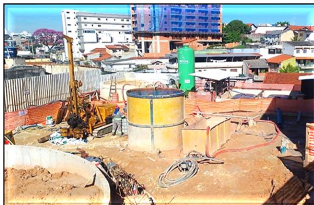
Instalação do rebaixamento do lençol freático em execução.
