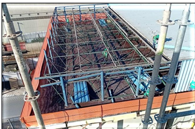
Retirada da cobertura metálica do corpo da estação.
