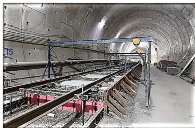
Trecho Vila Formosa – Complexo Rapadura: estrutura da laje flutuante das vias permanentes em execução.
