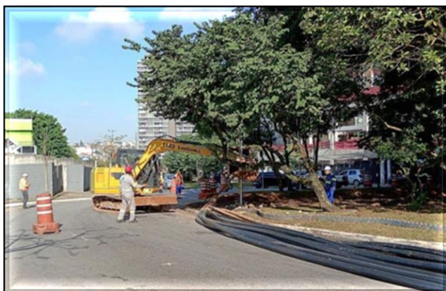
Lançamento dos eletrodutos em execução.
