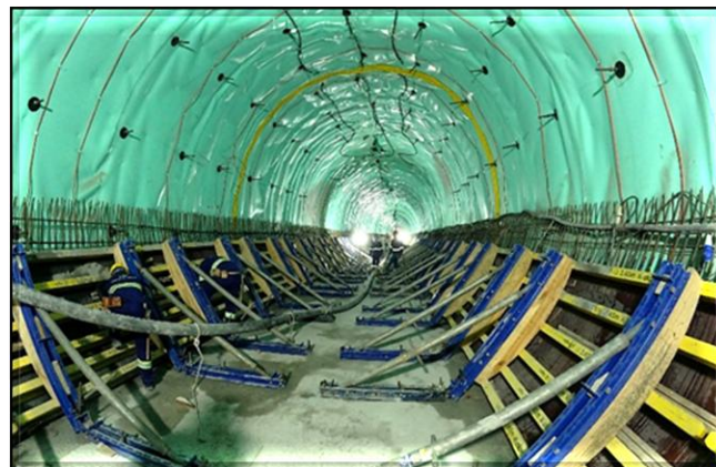
Formas do revestimento secundário em execução.
