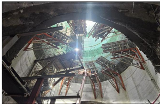
Vista interna do VSE 1 Soares Neiva.
