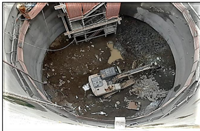
Escavação e revestimento primário do poço.
