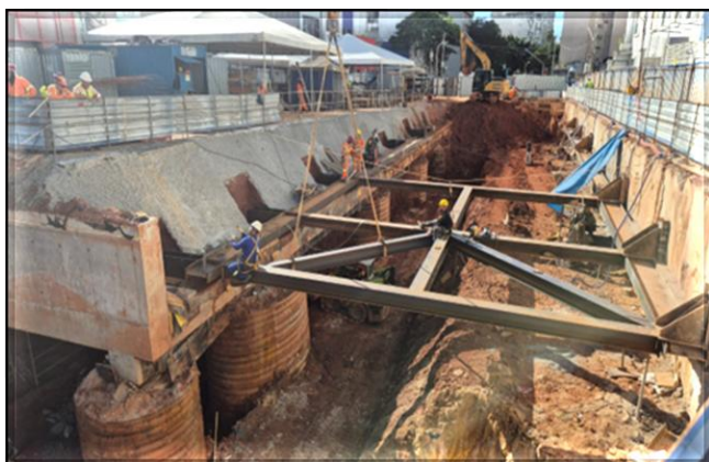
Início dos serviços de estroncamento metálico.
