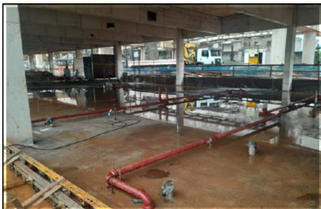
Obra Civil – execução da instalação hidráulica do bloco B.
