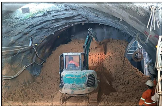
Túnel norte: escavação da calota da cambota 84 em execução.
