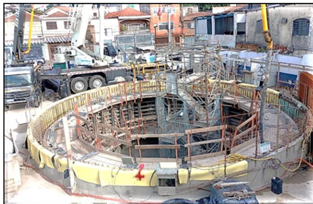
Montagem de formas do revestimento secundário.
