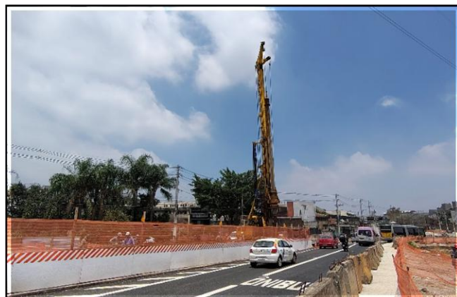
Obra Civil – executado o desvio, em execução a adequação viária e as fundações da via elevada no trecho entre as estações Jd. Colonial e Boa Esperança.
