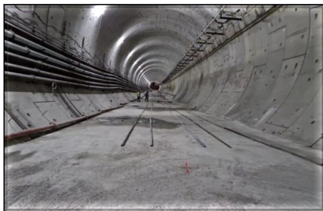
Desmobilização das utilidades da tunneladora e enchimento do túnel para execução da via permanente.
