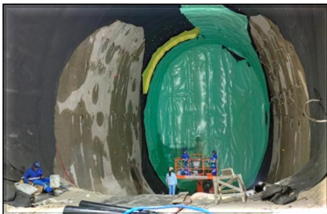
Impermeabilização do túnel.
