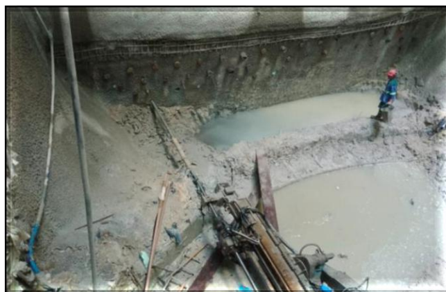
Escavação dos túneis direcionais.
