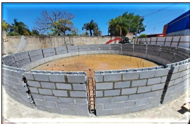
Guarda corpo para escavação do poço.
