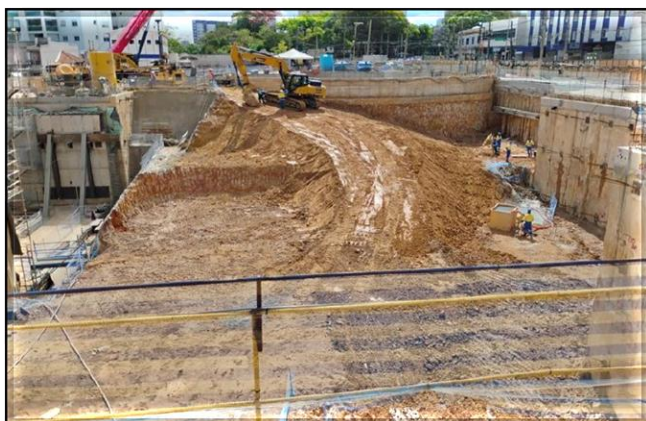
Escavação da vala do acesso principal.
