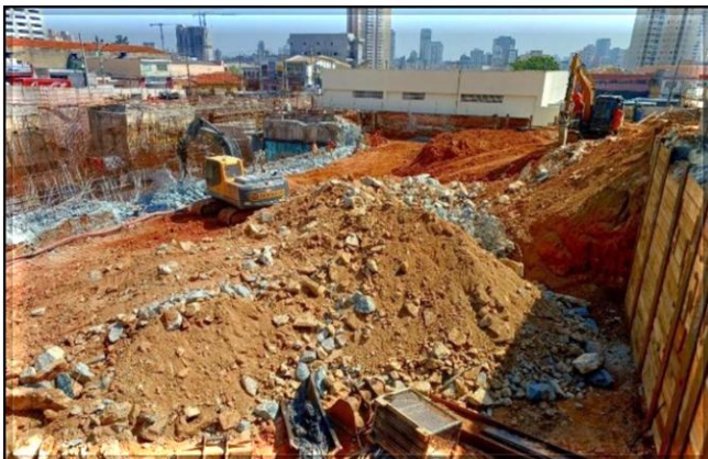
Escavação e arrasamento da parede de diafragma para execução das salas técnicas.
