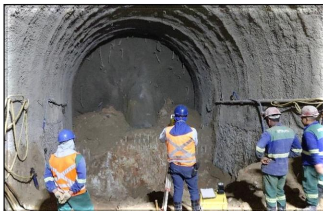
Escavação do túnel singelo de estacionamento.
