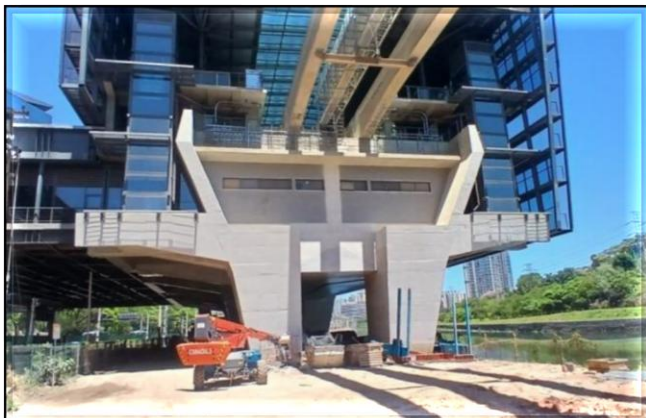
Obra Civil – execução do tratamento do concreto do corpo da estação.
