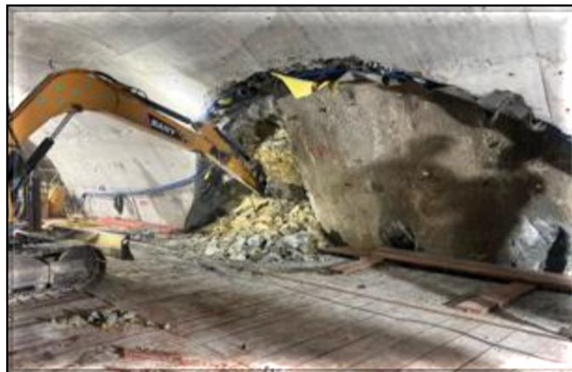
Escavação dos túneis direcionais para Tuneladora.
