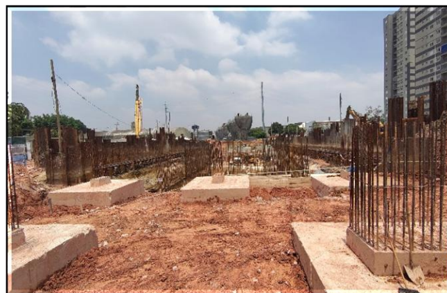
Obra Civil – execução do aterro e compactação junto aos blocos de fundação do corpo da estação.
