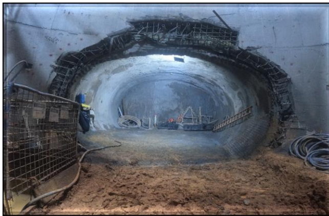
Túnel sul: escavação concluída (17 cambotas executadas).
