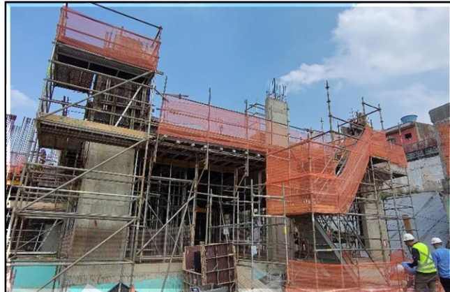
Obra Civil – execução da estrutura de concreto do Edifício Técnico.
