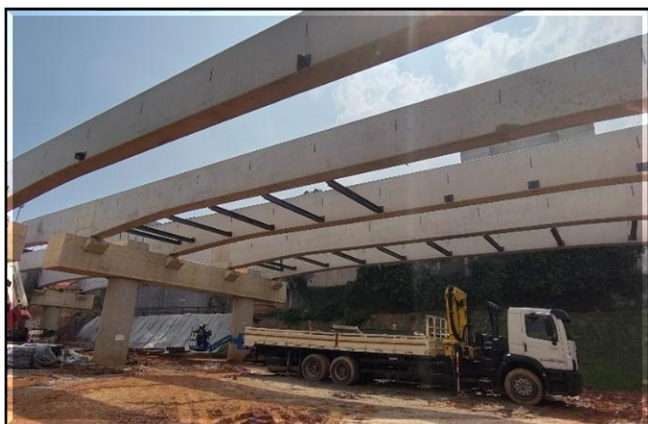
Obra Civil – instalação das passarelas nas vias de estacionamento.
