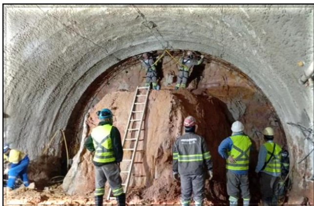
Escavação do túnel de estacionamento.
