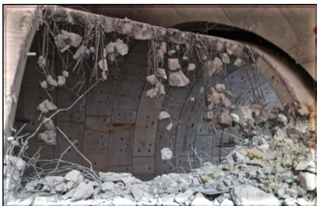
Demolição do túnel falso.
