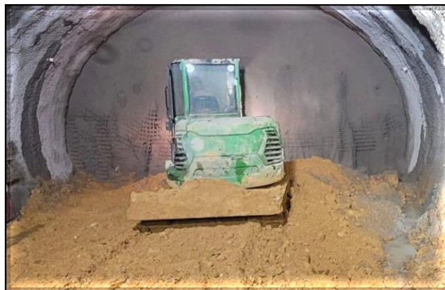
Túnel norte: escavação da 54ª cambota concluída.
