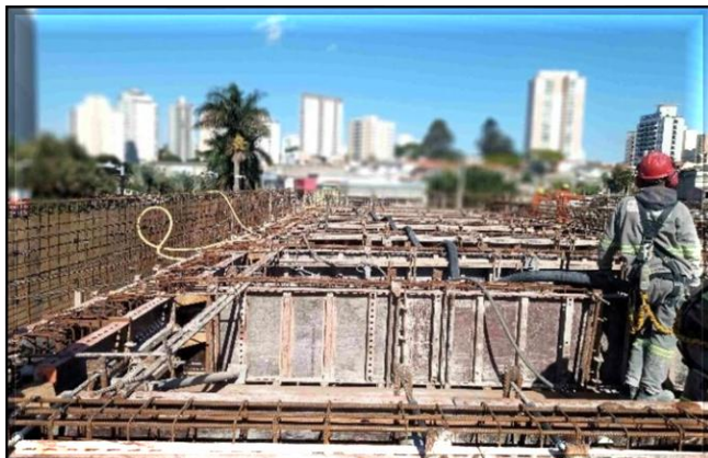
Estruturas de concreto do acesso secundário.
