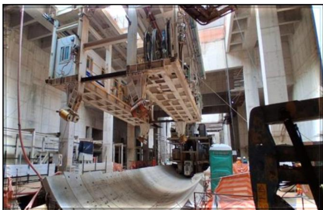
Montagem da Tunneladora na estação Penha.
