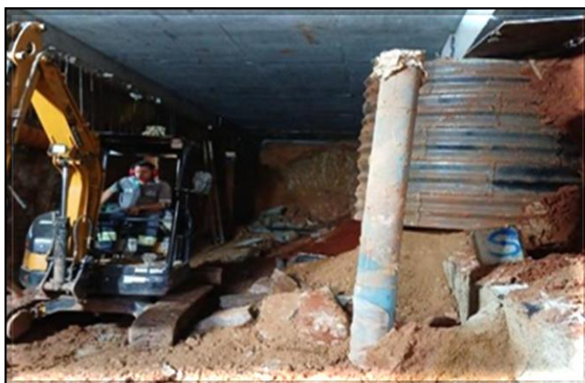
Acesso à Rua Pedroso: Execução da escavação sob a laje de cobertura.
