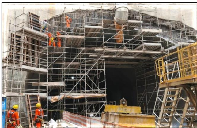
Revestimento secundário do túnel.
