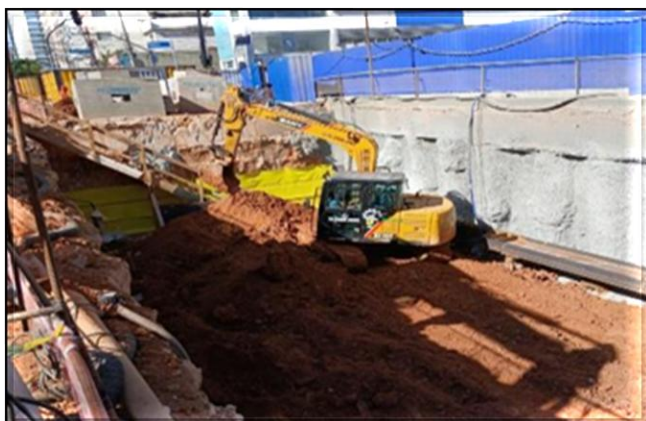
Rua São Joaquim: Remoção de terra.
