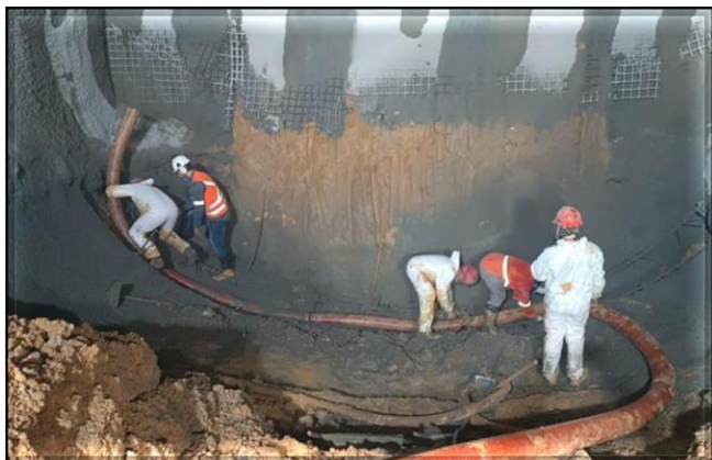
Túnel norte: execução do arco invertido (AID) das cambotas 51 a 53.
