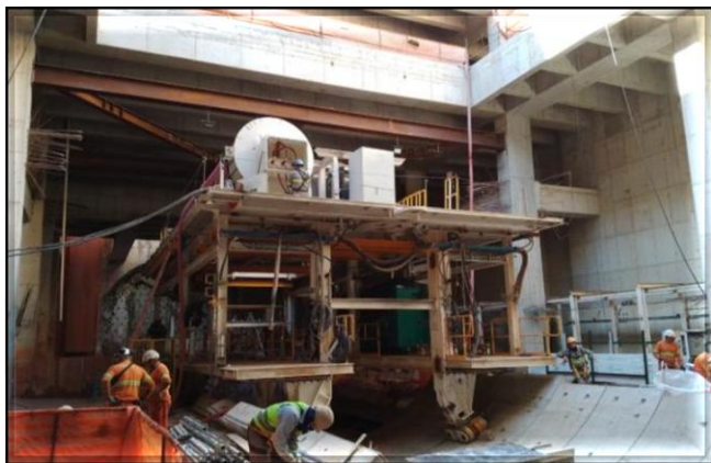
Montagem da Tunneladora na estação Penha.
