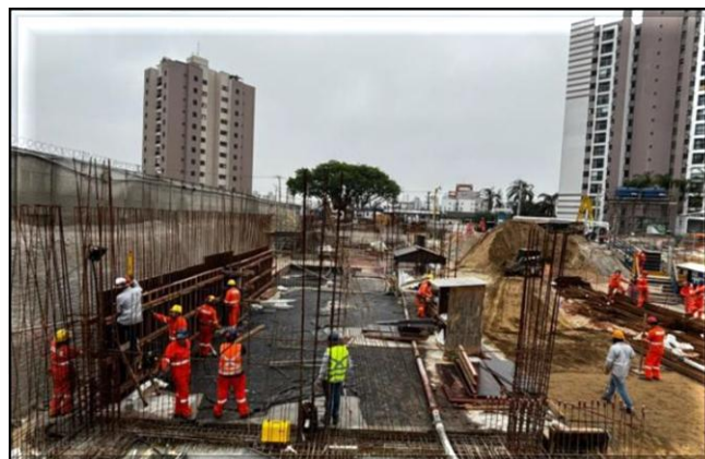
Estruturas de concreto das salas técnicas.
