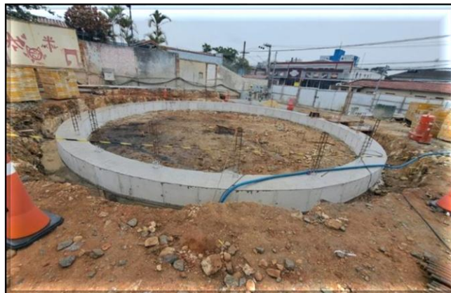
Viga de borda para escavação do poço.
