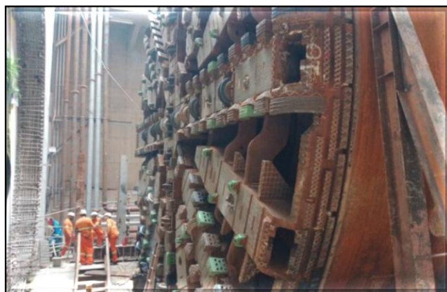
Montagem da Tunneladora na estação Penha.
