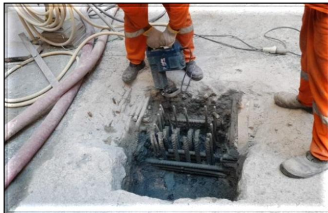
Arranque dos pilares no Poço.
