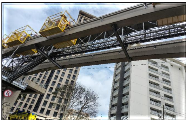
Obra Civil – instalação do guarda-corpo na passarela de emergência e retificação da via próximo à estação Aeroporto de Congonhas.
