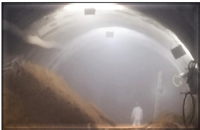
Túnel Norte: execução de concreto projetado para tratamento da cambota 54.
