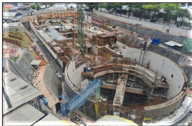
Estrutura de concreto do corpo da estação.
