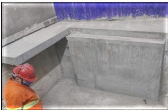
Mezanino sentido Jabaquara lado norte: Adequação para colocação de nova escada rolante.
