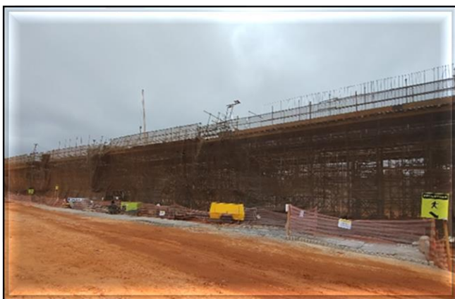
Obra Civil – execução de track switch do Pátio.
