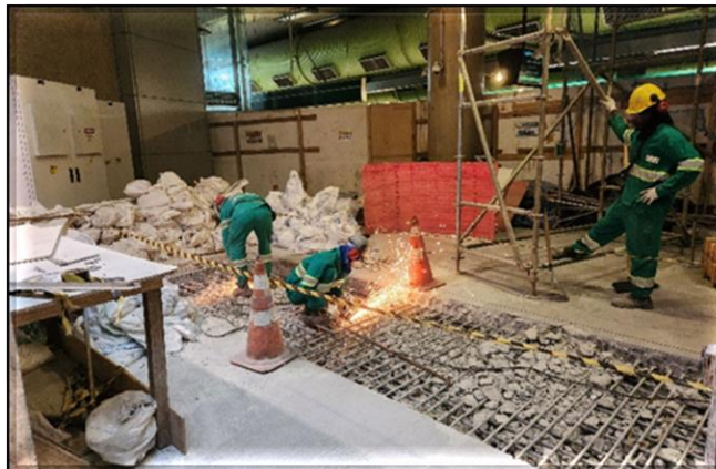
Linha 2-Verde - Plataforma 2 – lado leste – recorte da laje para instalação da nova escada rolante.
