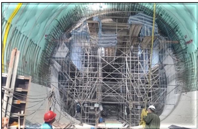
Revestimento secundário do túnel de ligação.
