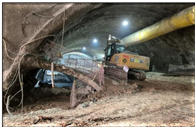
Escavação dos túneis do corpo da estação.
