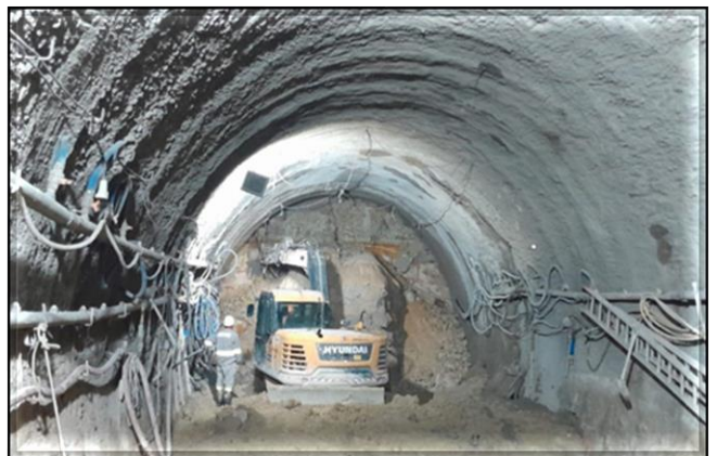
Escavação do túnel.
