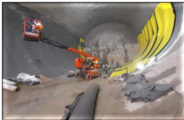
Impermeabilização do túnel de corpo da estação
