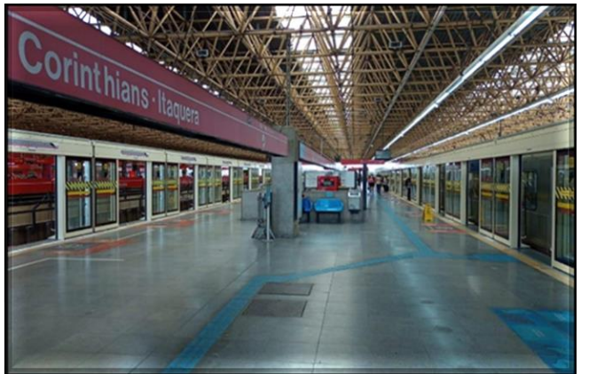
Fachadas das portas de plataforma | Instaladas 4/4 fachadas. (em testes)
