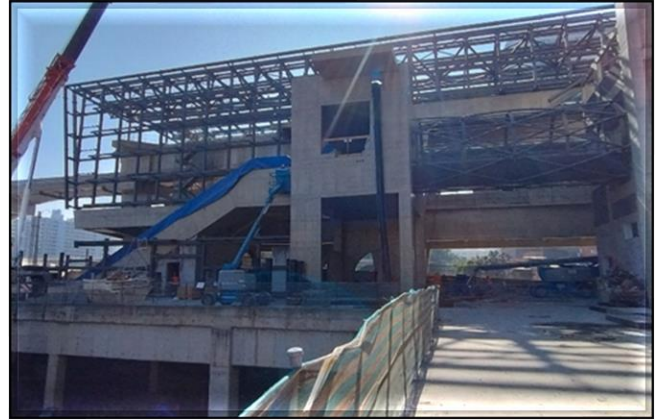
Obra Civil – em andamento a instalação da estrutura metálica da cobertura da plataforma, estrutura de fechamento do corpo e do acesso.
