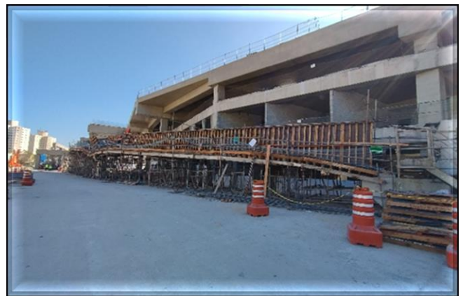
Obra Civil – execução das vias do Pátio
