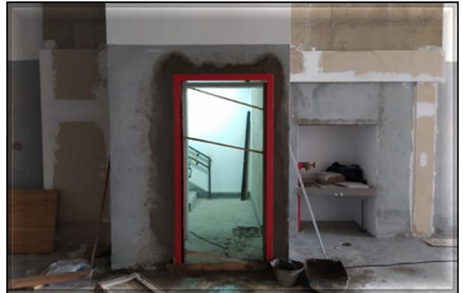
Obra Civil – execução do acabamento e instalação dos batentes no ETO.
