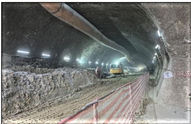
Escavação do túnel de via.
