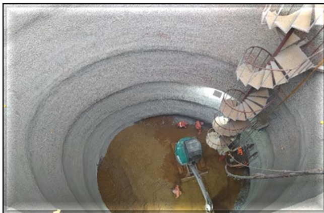
Local do poço de escavação do túnel: escavação e revestimento primário em execução.
