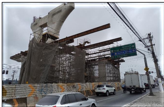
Obra Civil – execução dos capitéis da via elevada.
