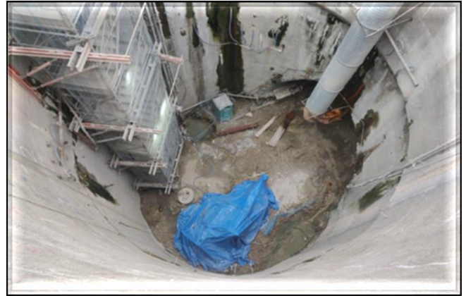
Vista geral do Poço.
