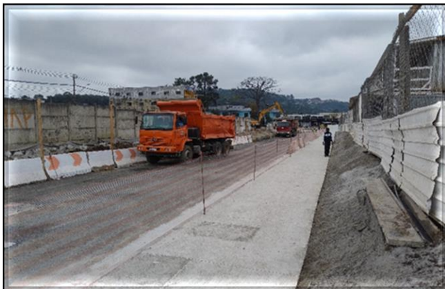
Obra Civil – Execução do viário para o desvio de tráfego.
