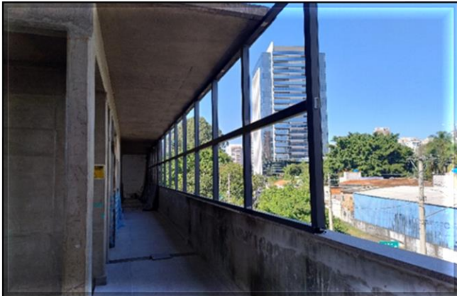
Obra Civil – em andamento a instalação dos caixilhos na SEE.
