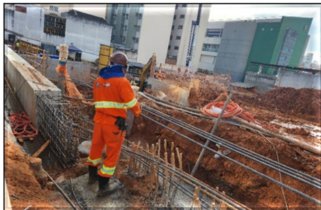
Arrasamento das estacas raízes e execução da viga de coroamento da contenção.
