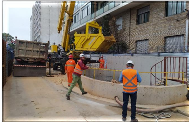
Local do poço de escavação do túnel: viga de borda.
