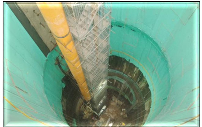
Revestimento secundário do Poço.
