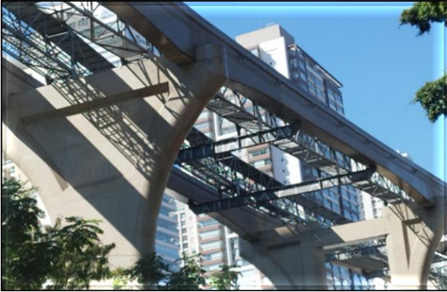
Vias do Monotrilho/Sistemas – instalação dos trilhos de captação de energia.
