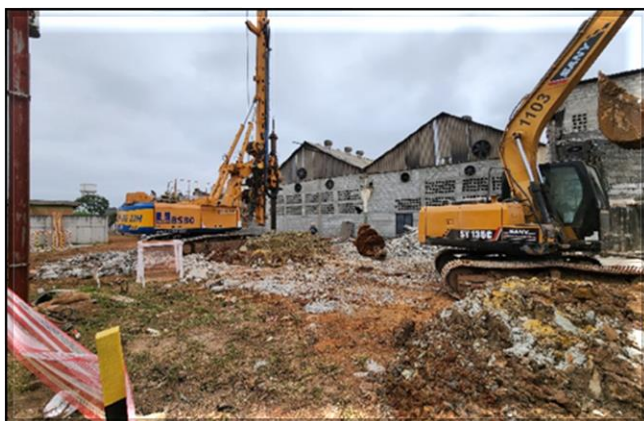
Obra Civil – execução dos estações da via elevada.
