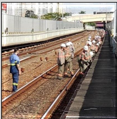
Lançamento de cabos do CBTC
