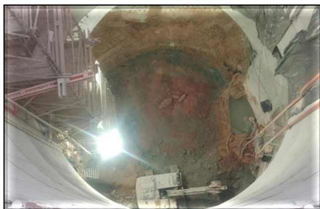
Tratamento para emboque e desemboque da tuneladora.
