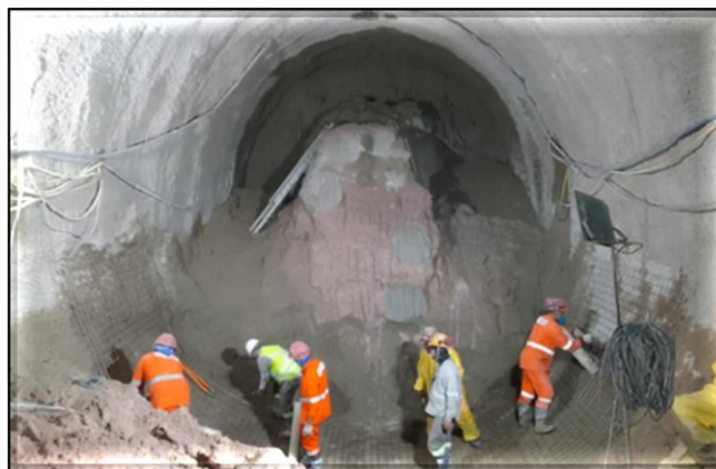
Escavação do túnel singelo.
