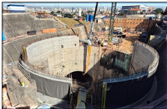
Estruturas de concreto do corpo da estação.
