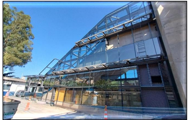
Obra Civil – em andamento a instalação dos vidros dos acessos
