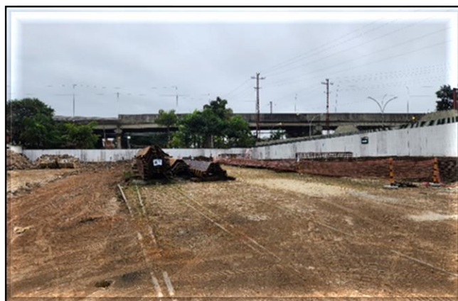
Obra Civil – mobilização dos equipamentos para execução das estacas prancha.
