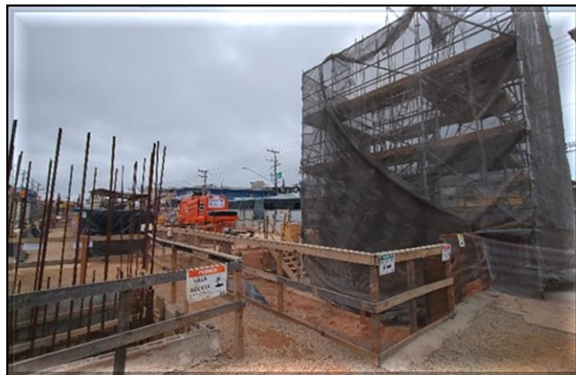
Obra Civil – Em execução os pilares do corpo da estação.
