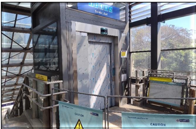
Sistemas – elevadores em instalação.
