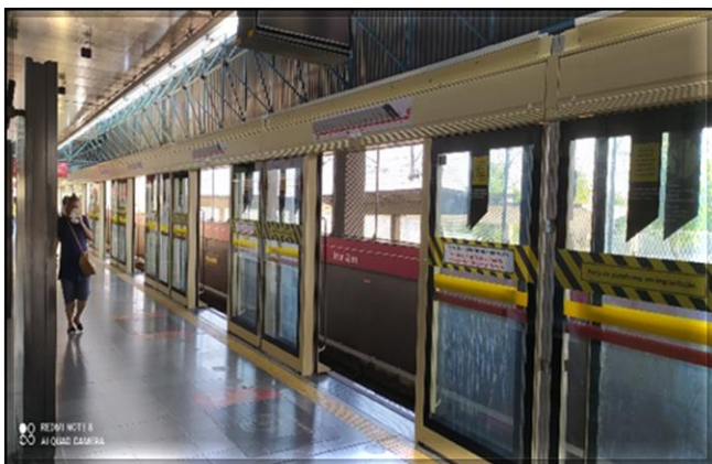
Fachada das portas de plataforma | Em instalação e testes
