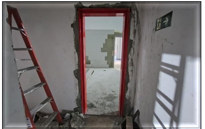
Obra Civil – em andamento a instalação dos batentes nas salas técnicas.
