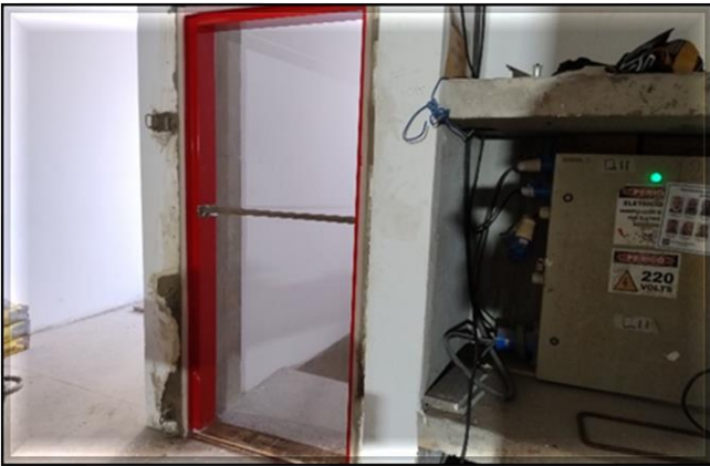
Obra Civil – instalação dos batentes nas Salas Técnicas.
