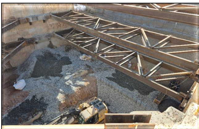
Escavação e lastro da vala do corpo da estação.
