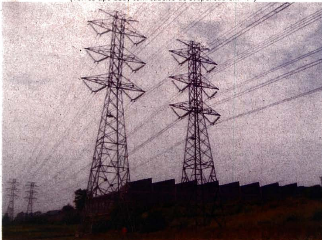
Figura 2: Linhas LTA Leste – Capuava 1-2 (à direita) e Leste – Capuava 3-4 (à esquerda). (Torres tipo 1SB, com cadeias de suspensão em “V”)
