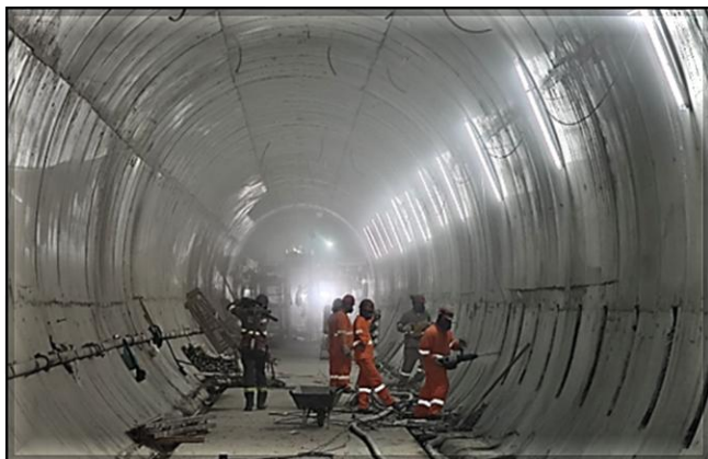
Túnel Via E3: reposicionamento de armação para as vigas das passarelas de emergência.
