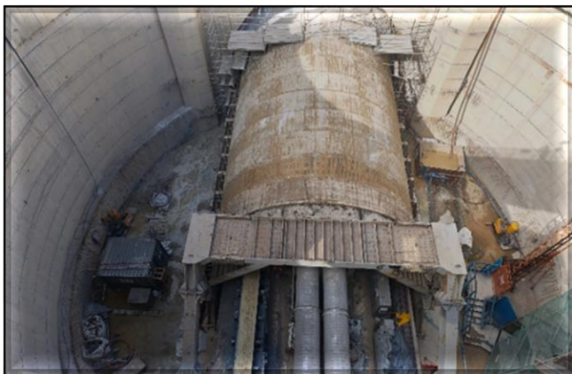
Tuneladora em atividade a partir da Estação Aricanduva.
