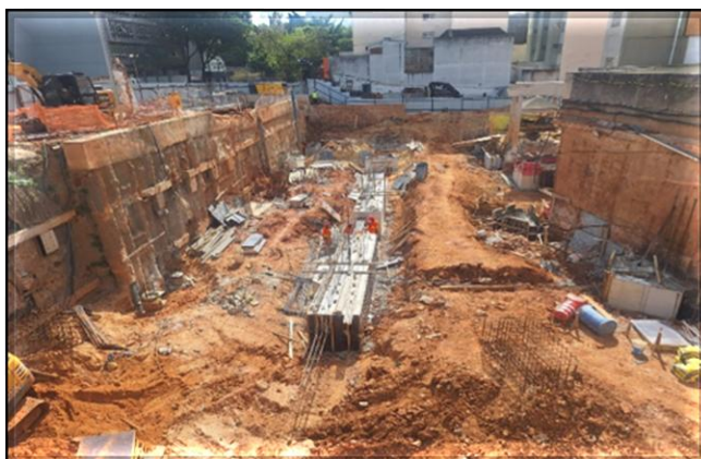
Arrasamento de estacas.
