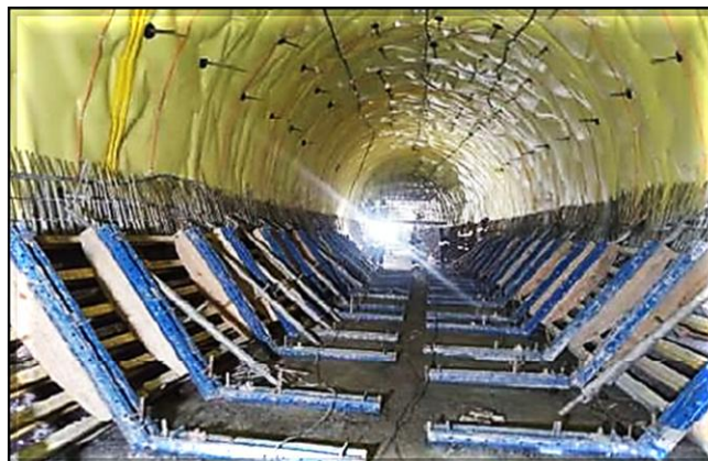
Concretagem do revestimento secundário em execução.
