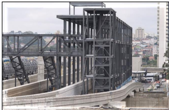
Bloco F – estrutura metálica para instalação da máquina de lavar trens.
