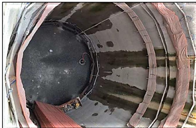
Escavação do poço principal concluída.
