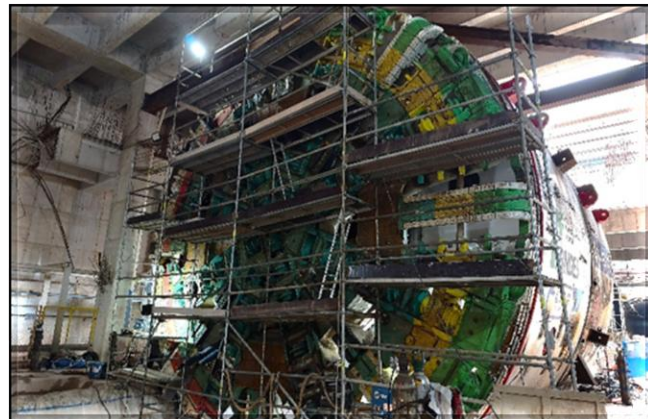
Montagem das estruturas e da roda de corte da tunneladora.
