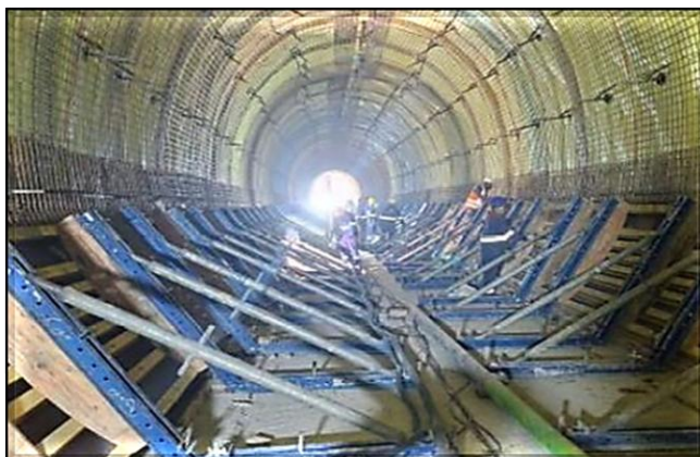
Fechamento das formas para execução do revestimento secundário.
