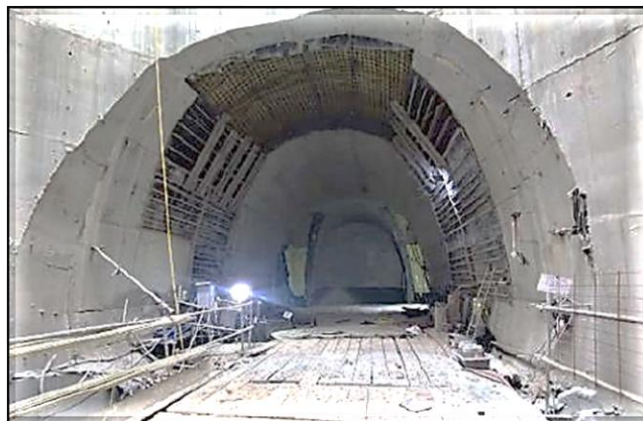
Vista geral do Túnel de Ligação.
