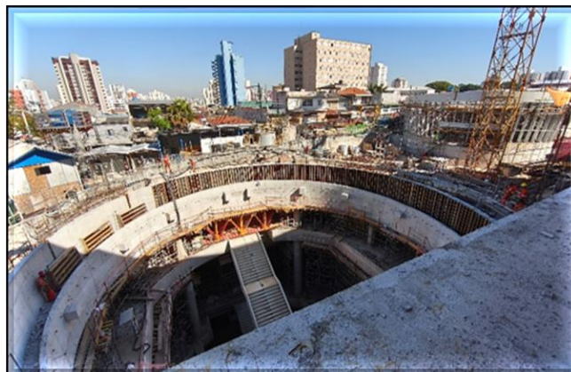
Estruturas internas do poço e cobertura do Acesso B em execução.
