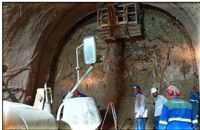
Túnel E05 Sul: montagem da armação da cambota 409.
