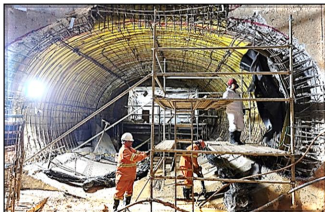
Túnel sul: ajustes do revestimento primário para o revestimento secundário.
