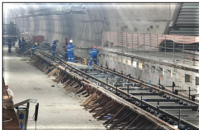
Estação Orfanato: estrutura da laje flutuante das vias permanentes em execução.
