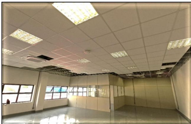
Bloco A – forro mineral em instalação nas salas e corredores.
