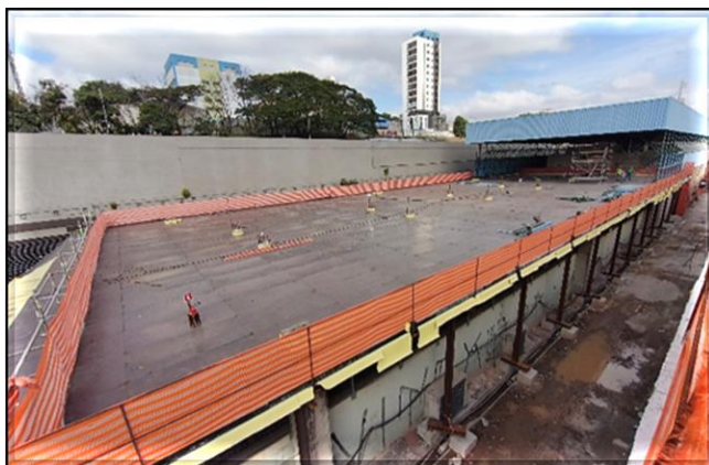
Laje de trabalho para execução de nova cobertura metálica.
