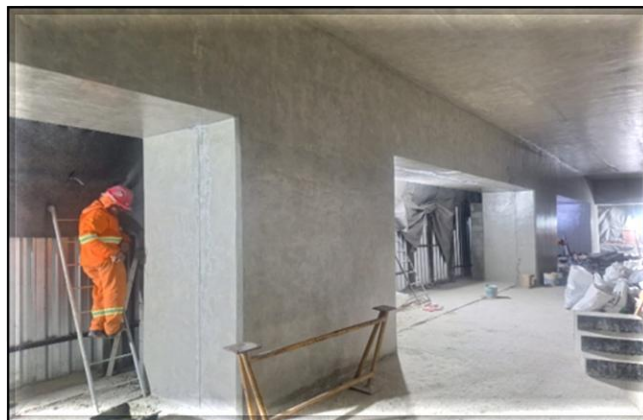
Tratamento das estruturas de concreto.
