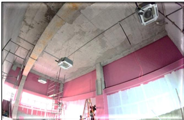
Bloco E – acabamentos interno e instalação do ar condicionado.
