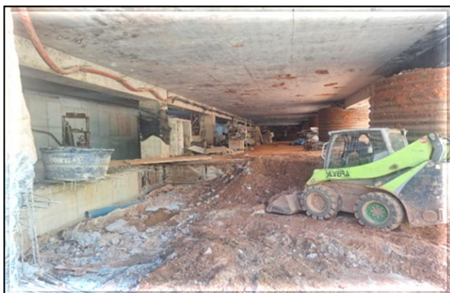
Escavação do solo.
