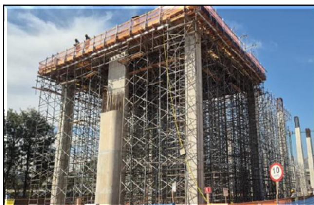
Obra Civil – montagem do cimbramento para execução das lajes do deck switch da área de manobra.
