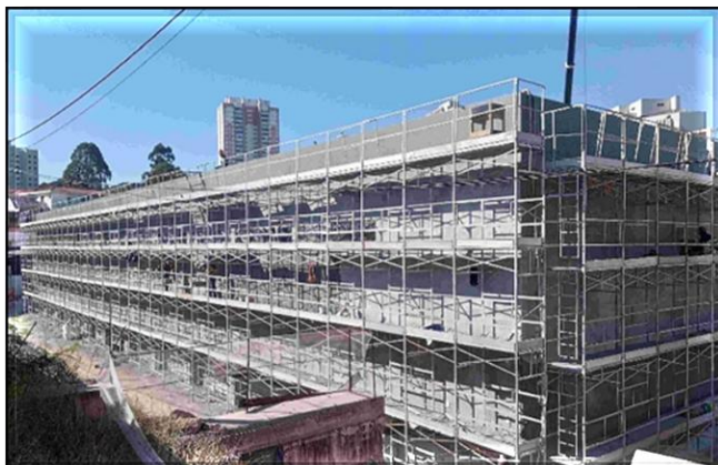
Acabamentos externos em execução (instalação de pastilhas).
