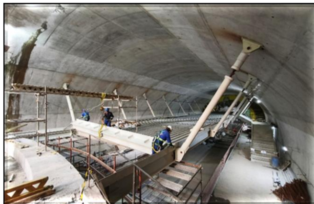
Montagem da estrutura metálica do mezanino em execução.
