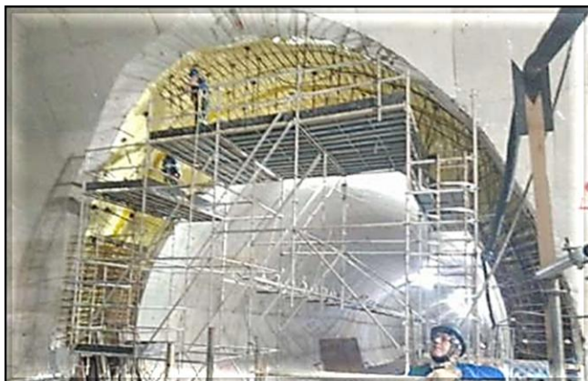
Instalação da manta de impermeabilização e montagem da armação no túnel direcional sentido Orfanato.
