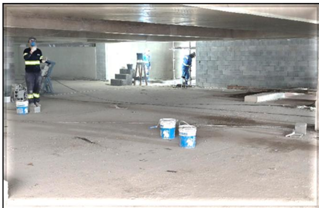
Acabamentos (alvenaria e tratamento do concreto aparente) da região do porão de cabos em execução.
