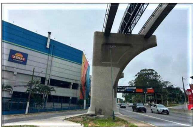
Tratamento de concreto aparente dos capitéis, próximo ao Supermercado Assaí.
