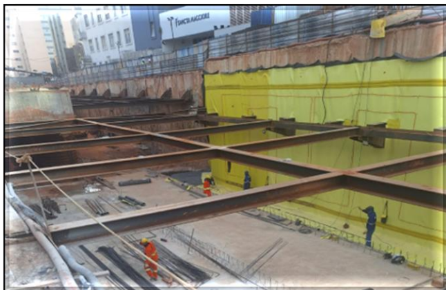
Enchimento entre vigas da área de integração com o acesso Pirapitingui (parte nova).
