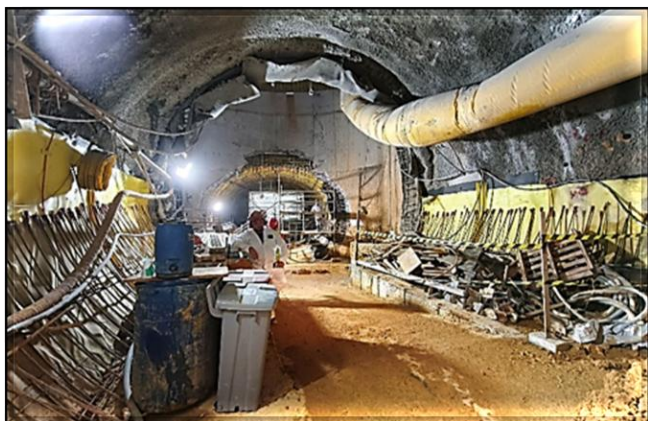
Túnel norte: revestimento secundário em execução.
