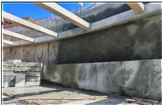
Obra Civil – execução do acabamento das paredes da vala.
