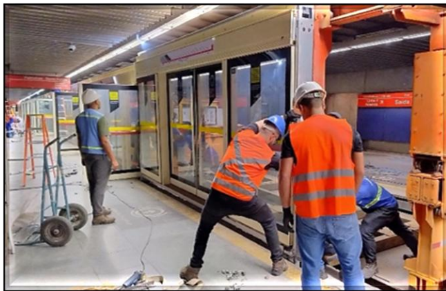
Montagem dos módulos em andamento.
