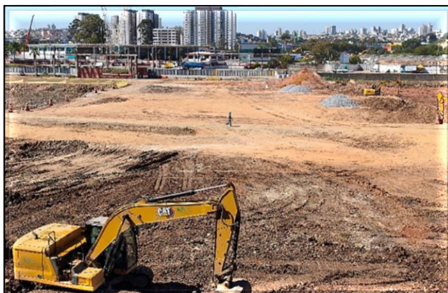
Movimentação de terra e limpeza do terreno.
