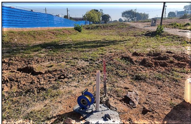
Piezômetros em instalação na área da estação.
