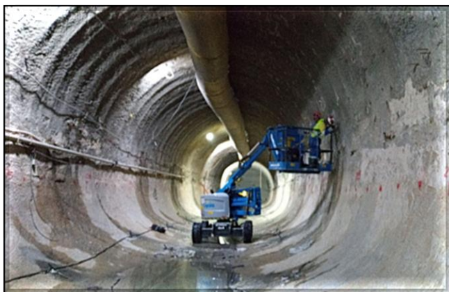
Regularização da superfície para preparação da impermeabilização do túnel.
