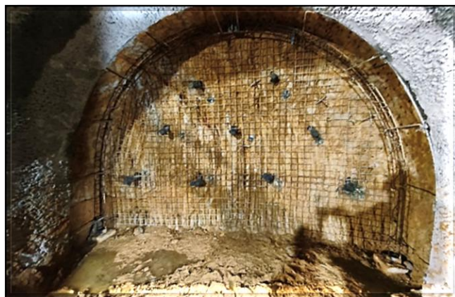
Túnel norte: armação do patamar de descanso 2 em execução.
