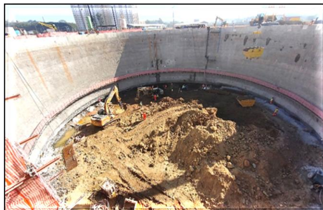
Escavação e revestimento primário em execução.
