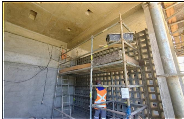
Obra Civil – execução do acabamento do Edifício Técnico.
