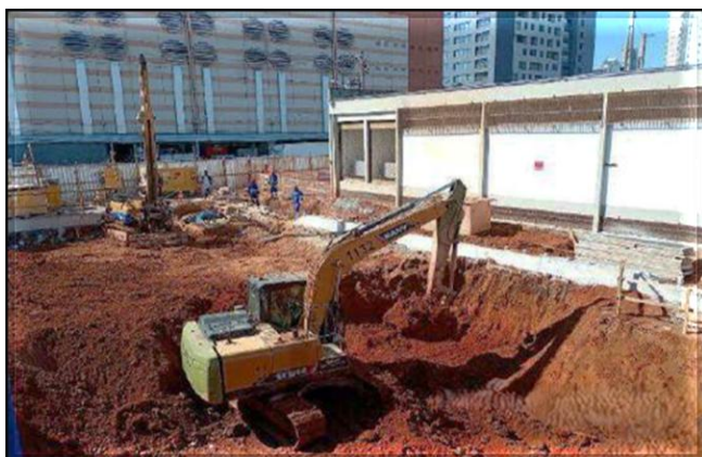
Escavação do local do porão de cabos.
