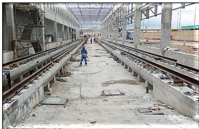
Tratamento de concreto da via 14 e concretagem da via 15 do Bloco A1.
