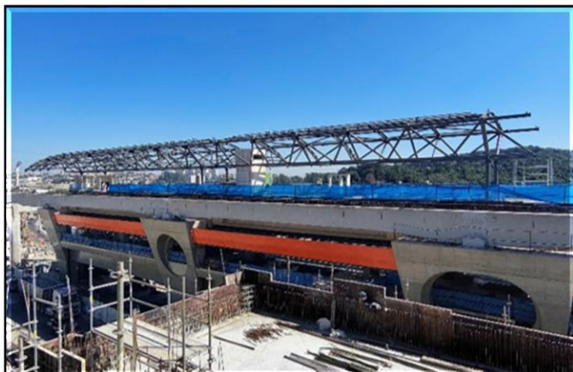
Obra Civil – lançado o segundo módulo da estrutura da cobertura da plataforma.
