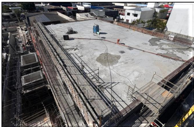
Cobertura em concreto das Salas Técnicas finalizada.
