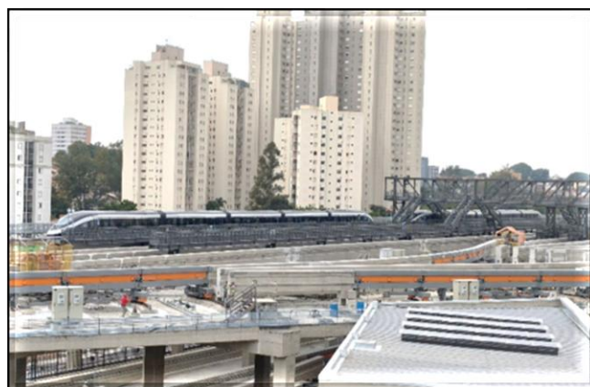
Vista das vias superiores do Pátio Água Espraiada.
