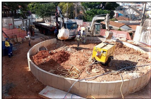
Conclusão do rebaixamento do lençol freático e viga de coroamento do poço em execução.
