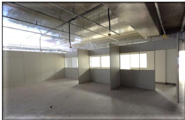
Bloco LMN – divisórias e portas em instalação.
