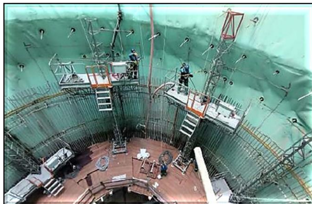
Armação do revestimento secundário em execução.
