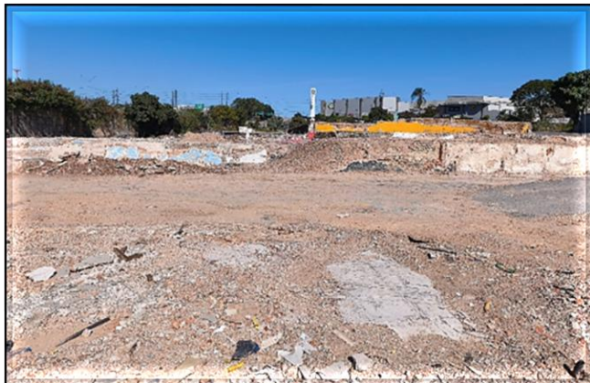
Demolição dos imóveis desapropriados.
