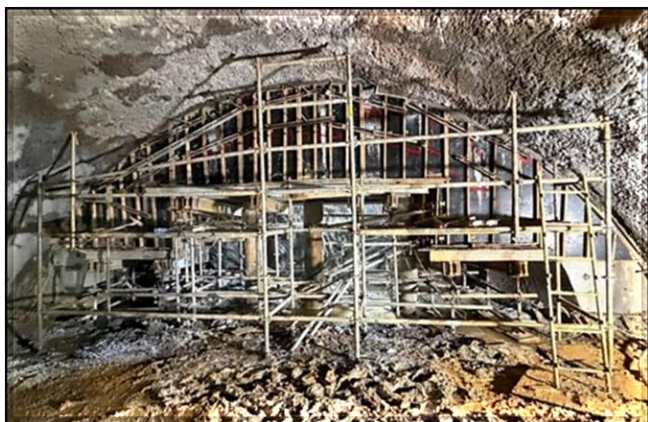
Túnel norte: concretagem parcial do pórtico.
