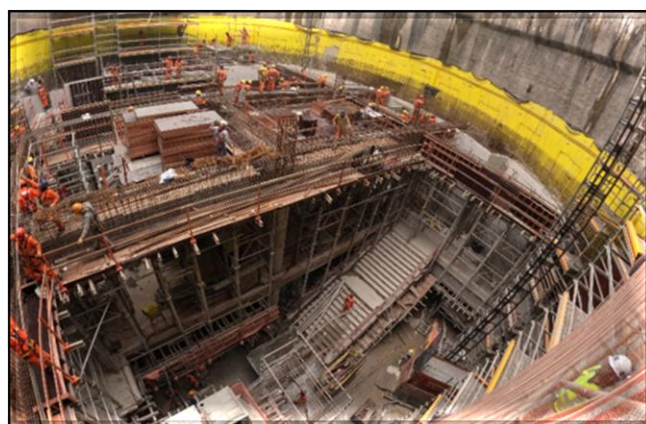
Estruturas internas do poço em execução (lajes, pilares e vigas).
