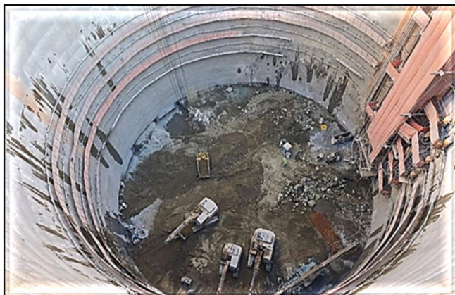
Escavação e tratamentos para o túnel do corpo da estação em execução.
