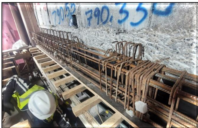
Túnel sul: estruturas internas dos shafts de cabos em execução.
