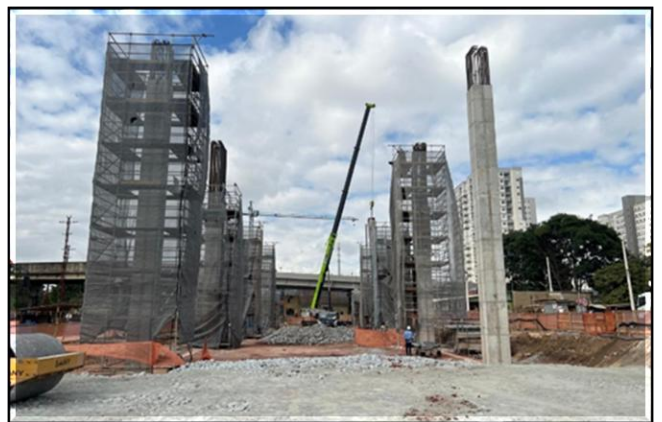
Obra Civil – execução dos pilares da área de manobra.
