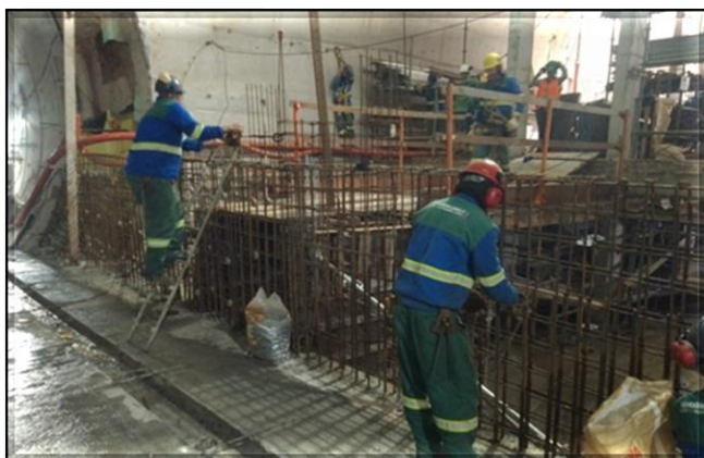
Estruturas internas em execução.
