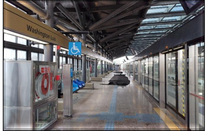
Corpo da Estação – Sistemas em fase de testes e comissionamento.
