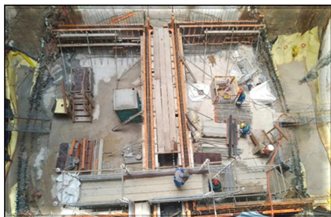
Estruturas internas em execução.
