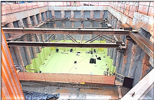
Acesso B – impermeabilização em execução.
