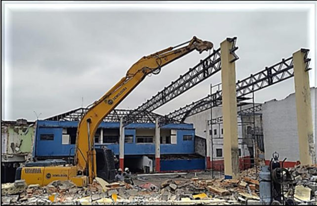
Demolição dos imóveis desapropriados em execução.
