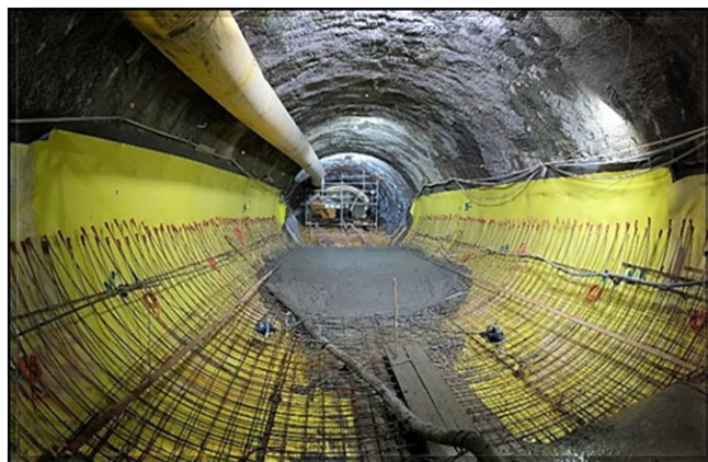
Túnel norte: revestimento secundário e concretagem do arco invertido em execução.
