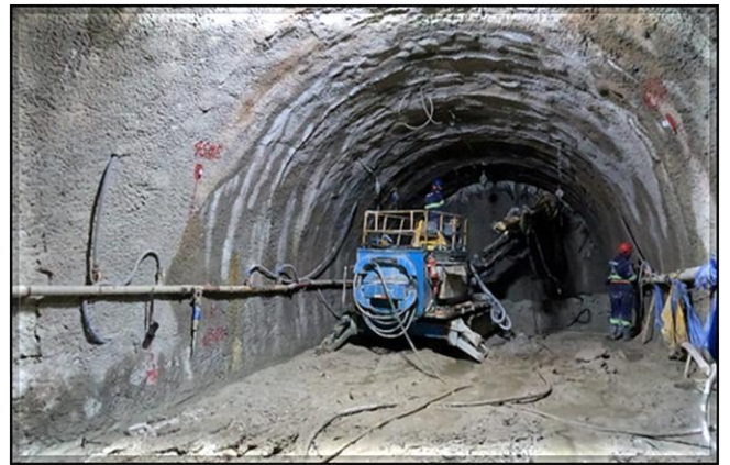
Escavação e tratamento da cambota no túnel sul 5 (sentido estação Vila Formosa).
