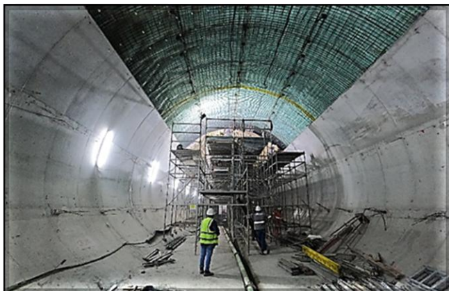
Revestimento secundário do túnel: formas, armadura e concretagem em execução.
