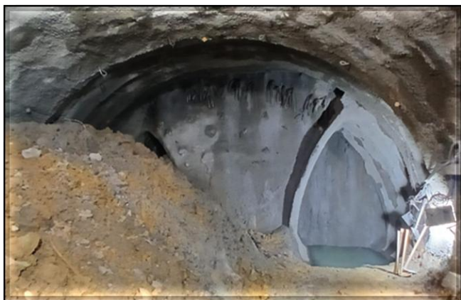
Túnel norte: escavação da cambota 87 e do side-drift esquerdo da cambota 91.
