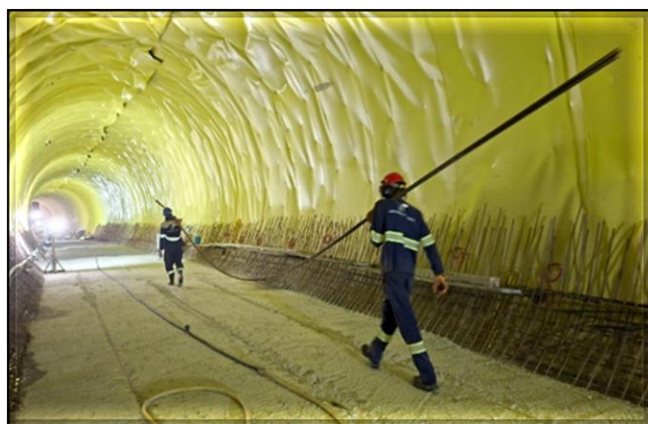
Concretagem do invert em execução.
