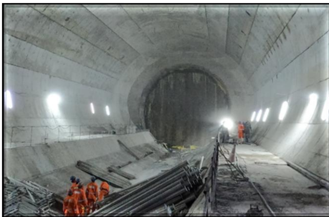
Revestimento secundário do corpo da estação concluída.
