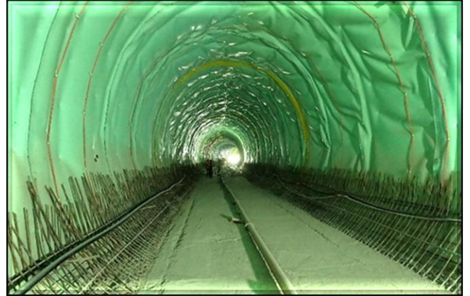
Concretagem do invert em execução.
