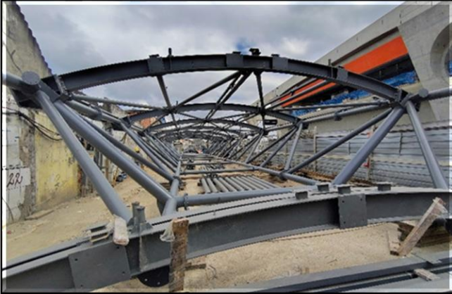
Obra Civil – execução da pré-montagem da estrutura da cobertura da plataforma.
