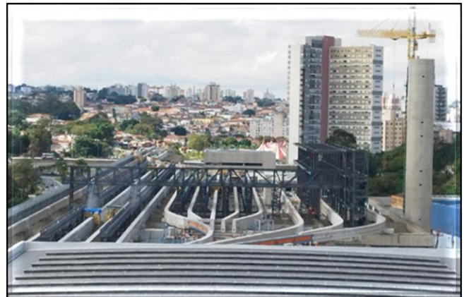
Vista das vias superiores, passarelas metálicas e caixa d'água.
