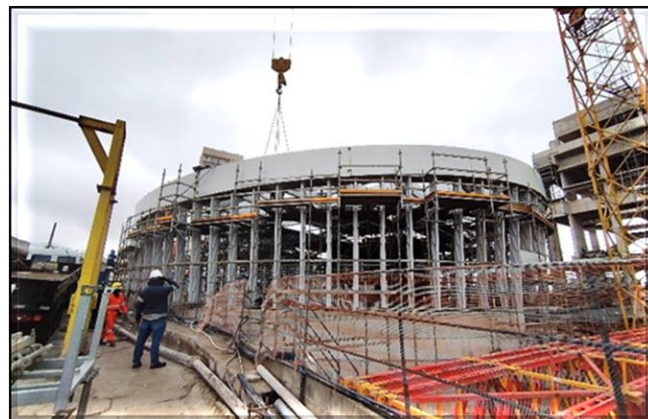
Estrutura e cobertura metálica do Acesso B em execução.
