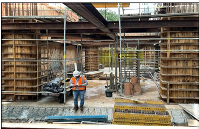
Execução dos pilares.
