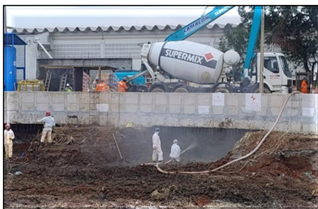
Escavação e revestimento primário em execução.
