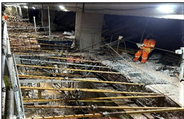
Ampliação das estruturas existentes.
