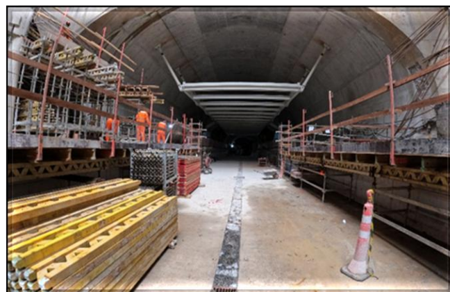
Laje para a superestrutura da via permanente concluída no corpo da estação.
