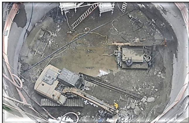
Escavação e revestimento primário do poço.
