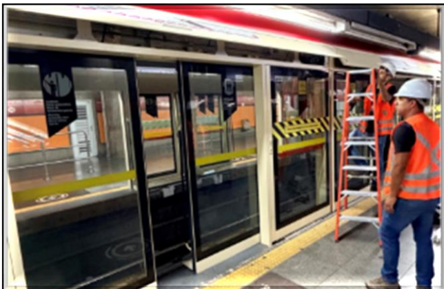
Fachadas das portas de plataforma em instalação.
