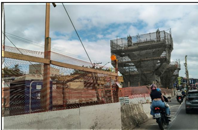
Obra Civil – execução das fundações, pilares e dos capitéis entre as estações Boa Esperança e Jacu-Pêssego.
