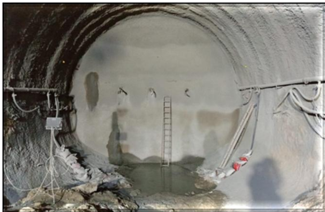
Escavação do túnel concluída – parede de paralisação.
