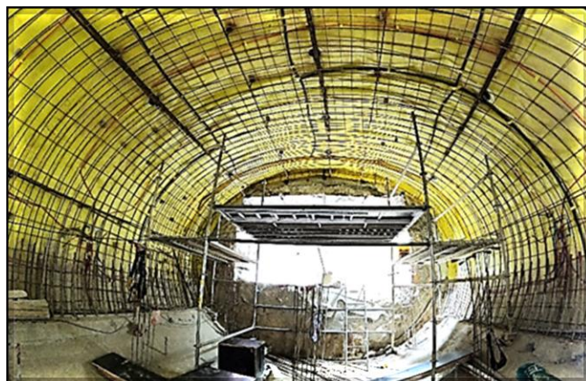
Túnel sul: armação do revestimento secundário superior em execução.
