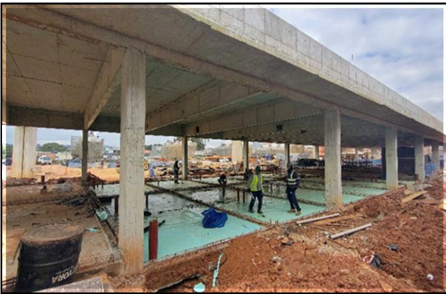
Obra Civil – execução da impermeabilização do bloco B.
