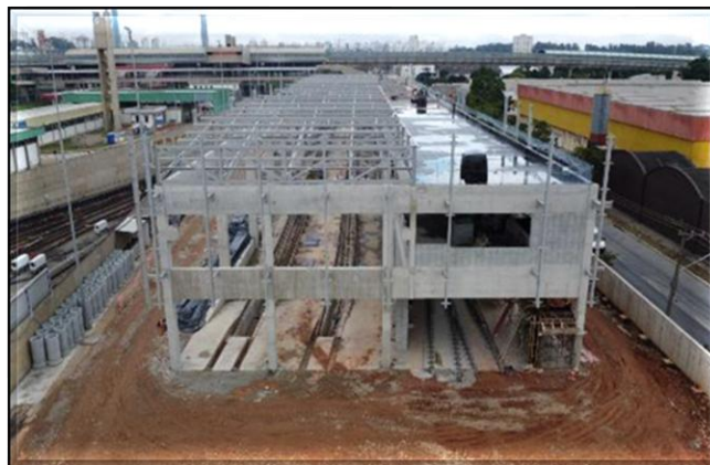
Obras civis e vias permanentes do Bloco A
