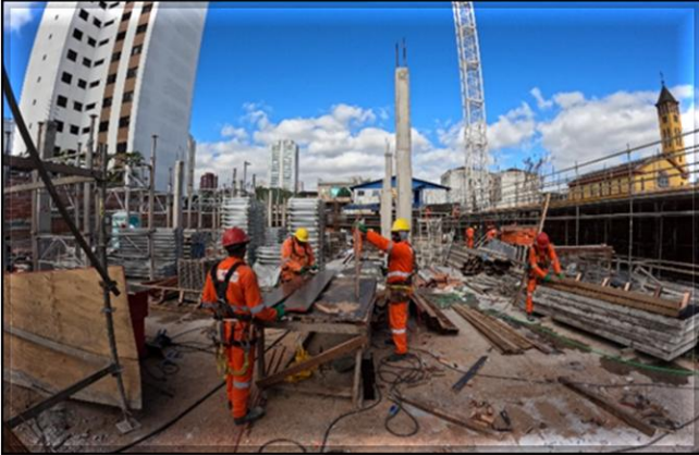
Armação e formas dos pilares das salas técnicas em execução.
