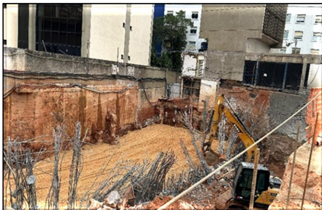
Acesso leste atual fechado e escavação para construção do novo acesso.
