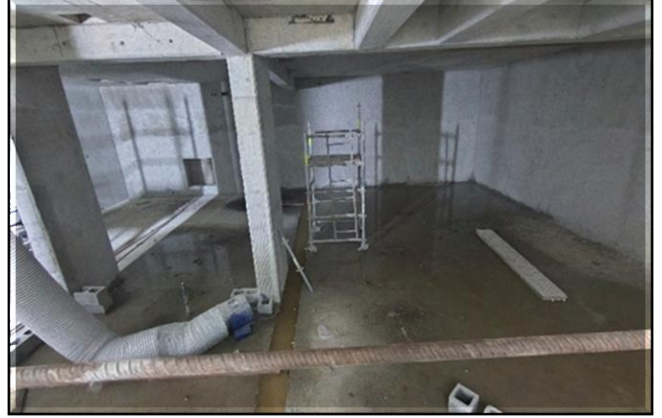
Obra Civil – execução do acabamento do porão do Edifício Técnico.
