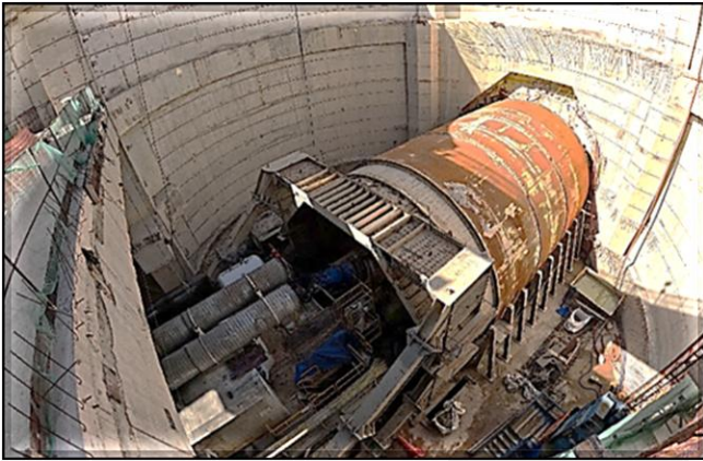
Tuneladora posicionada na estação Aricanduva.
