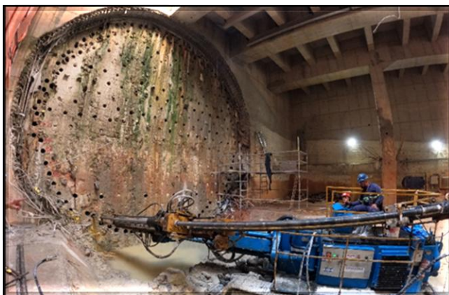
Tratamento do emboque para passagem da tuneladora, do Lote 2, no sentido Dutra.
