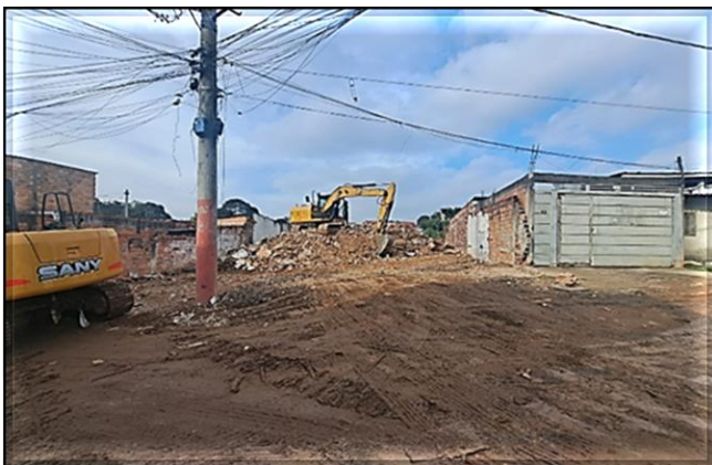
Demolições e sondagens em execução.
