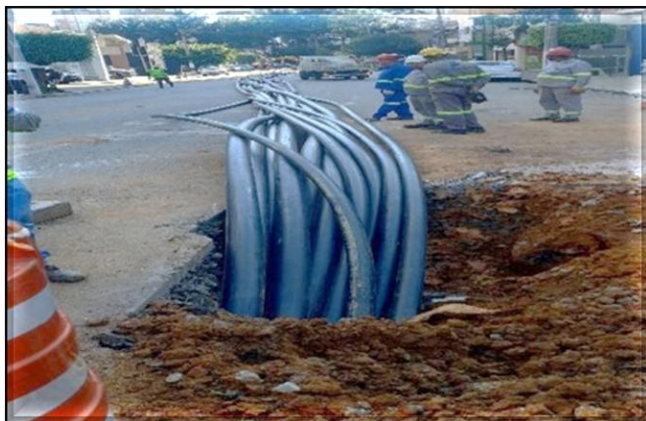
Implantação dos eletrodutos em execução.
