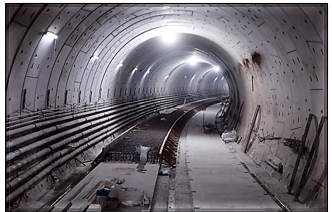
Trecho Anália Franco – VSE Coxim: estrutura da laje das vias permanentes em execução.
