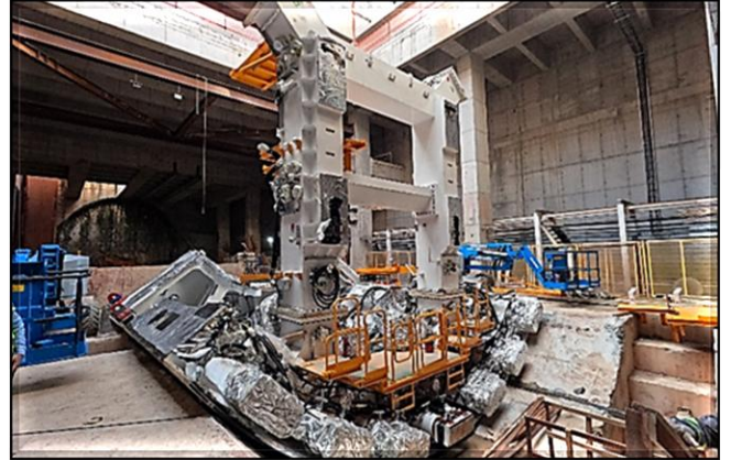
Montagem da tuneladora na estação Penha.
