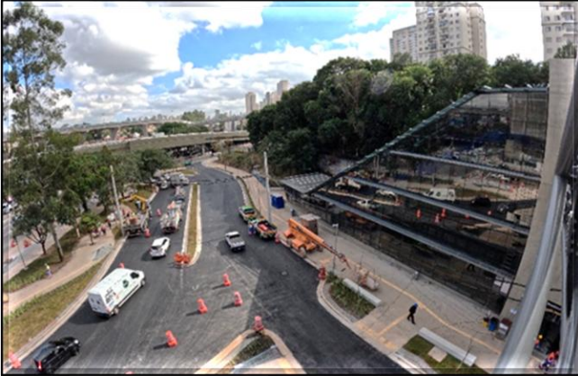
Acesso 2 – acabamentos externos, paisagismo e reurbanização.
