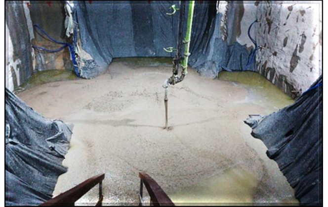
Enchimento do berço para a passagem da tuneladora.
