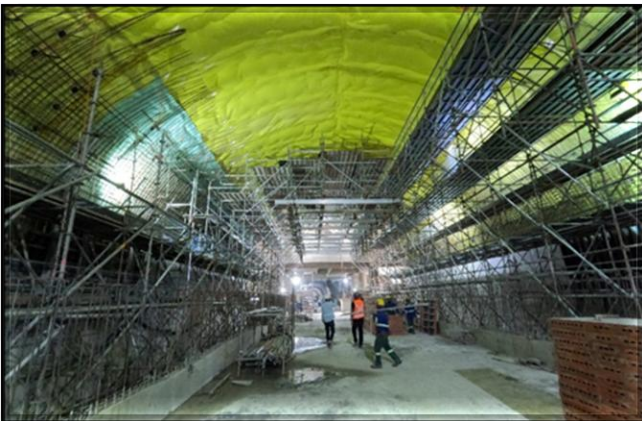
Formas, armações e concretagem do revestimento secundário e das paredes da plataforma.
