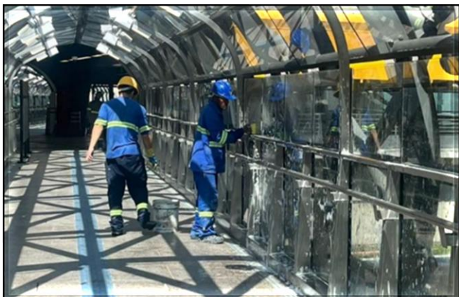
Acesso 2 – estação em operação.
