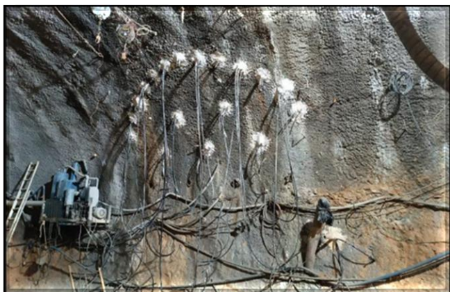
Túnel norte: tratamento do patamar de descanso 2.
