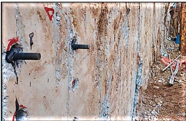
Execução do estroncamento na área de interligação com a estação
