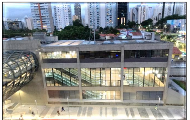
Acesso 1 – Estação em operação.
