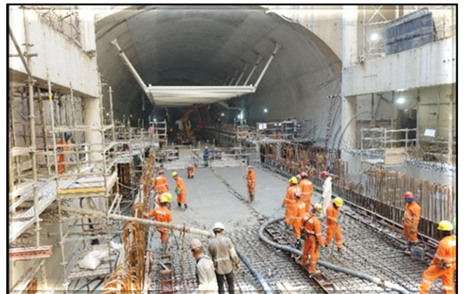
Laje para a superestrutura da via permanente em execução no Corpo da Estação.
