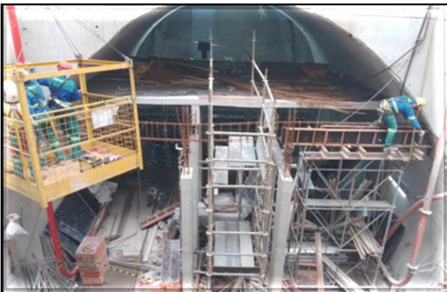
Montagem de formas na viga de transição.
