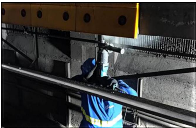
Obras de adequações civis nas plataformas em andamento.
