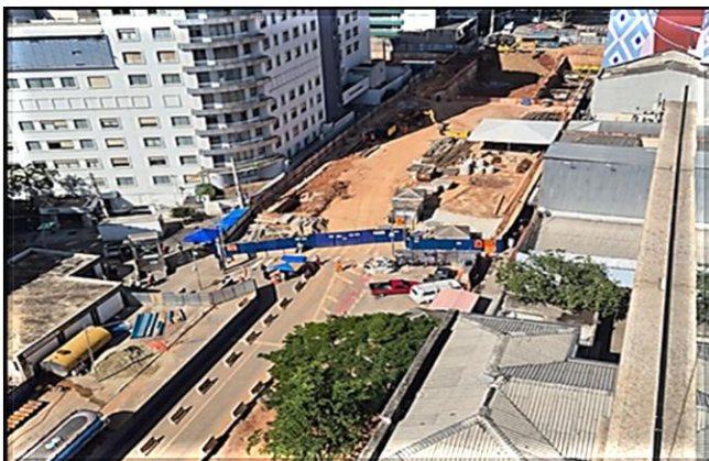
Início da escavação da área de integração entre o novo Acesso Leste e a estação
