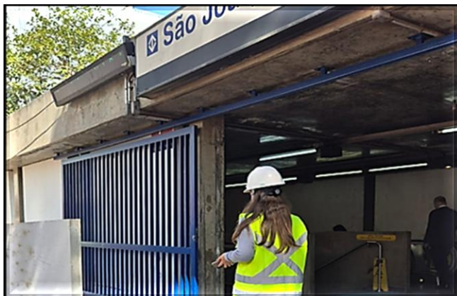
Novo Portão Instalado
