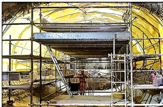
Túnel sul: impermeabilização e revestimento secundário do arco invertido concluídos.
