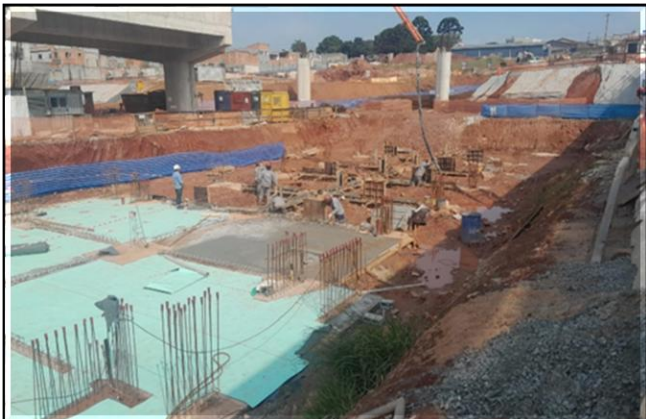
Obra Civil – execução da fundação e impermeabilização dos Blocos D1 e D2.
