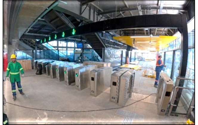
Sistemas – instalação dos bloqueios em execução.
