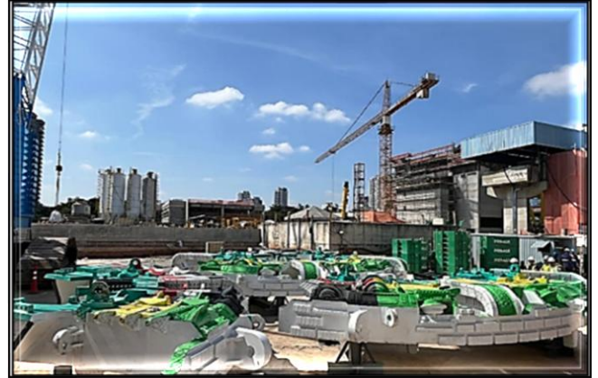
Entrega dos componentes da tuneladora na estação Penha.
