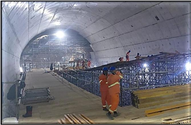
Plataforma de trabalho para estrutura da tuneladora na estação Santa Isabel.
