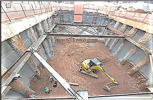
Acesso B – Escavação da vala e fixação de estroncas metálicas.
