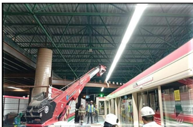
Montagem de estrutura metálica para proteção ao usuário e via na plataforma da Linha 3.
