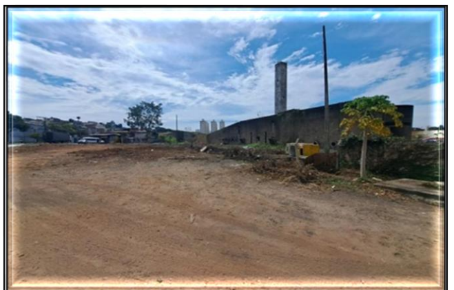
Limpeza de terreno em execução.
