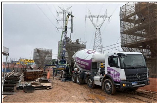
Obra Civil – execução dos capitéis entre as estações Jardim Colonial e Boa Esperança.
