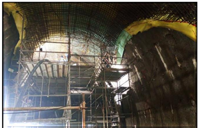
Túnel de ligação: armação e formas do revestimento secundário.
