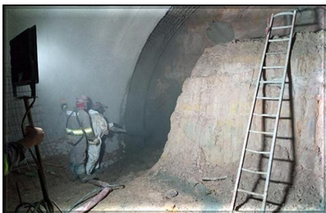
Concretagem da cambota 353 do túnel de estacionamento.
