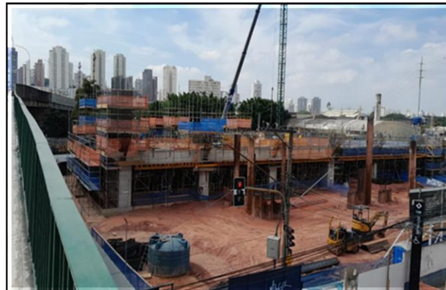
Obra Civil – execução da estrutura do corpo da estação.
