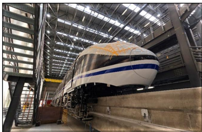
Montagem do trem N11 em execução.
