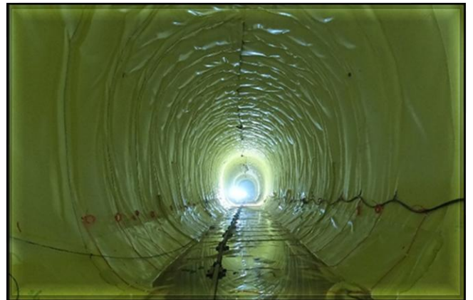
Laje de trabalho e laje de invert iniciados no túnel norte 5 (sentido estação Santa Isabel).
