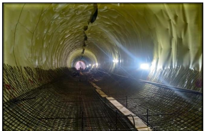
Armação do invert em execução.
