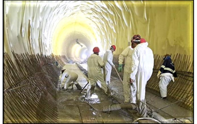
Enchimento da via em execução
