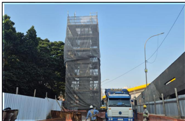
Obra Civil – execução dos pilares próximos a Avenida Luiz Inácio de Anhaia Melo.
