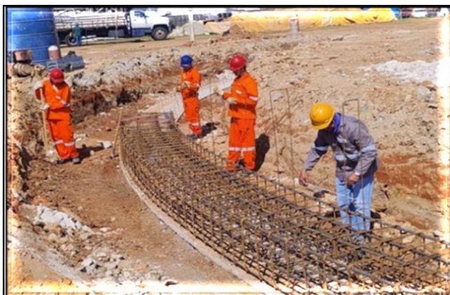
Armações da viga de borda.
