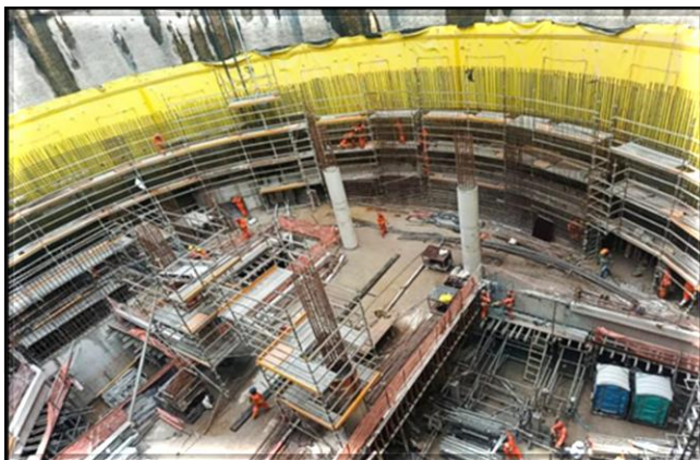
Armação das paredes e pilares do mezanino inferior, no poço principal.
