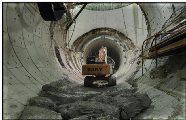
Túnel falso suprimido no poço do VSE.
