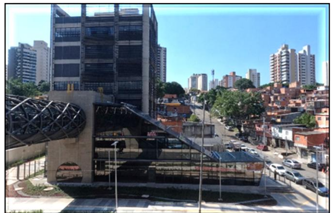
Acesso 1 – estação em operação.
