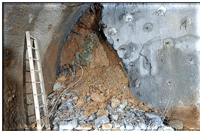
Túnel norte: escavação do side-drift esquerdo da cambota 84
