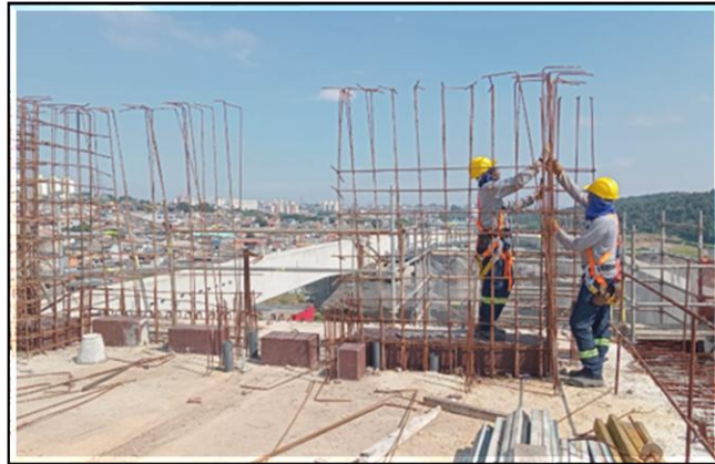
Obra Civil – execução dos módulos da plataforma.
