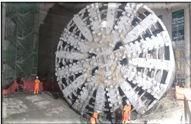
Chegada da tuneladora no corpo da estação.
