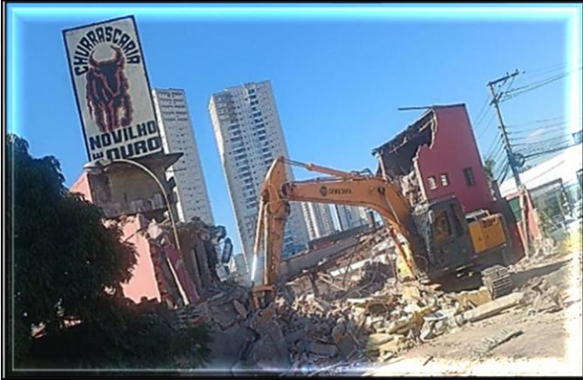
Demolição dos imóveis desapropriados em execução.
