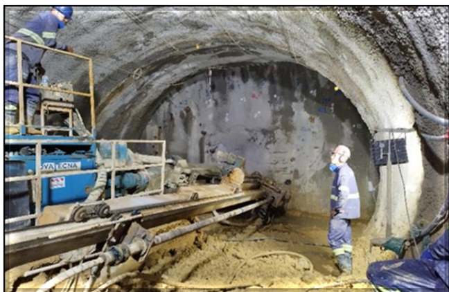
Túnel norte: tratamento do maciço da cambota 83.
