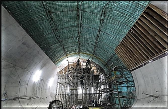
Revestimento secundário do túnel: formas, armação e concretagem em execução.
