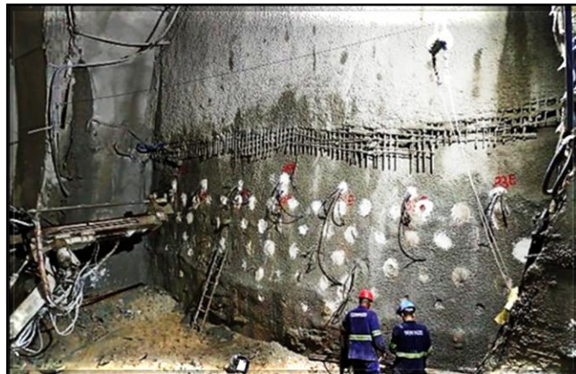
Tratamento de partida para a tuneladora, no túnel direcional norte.
