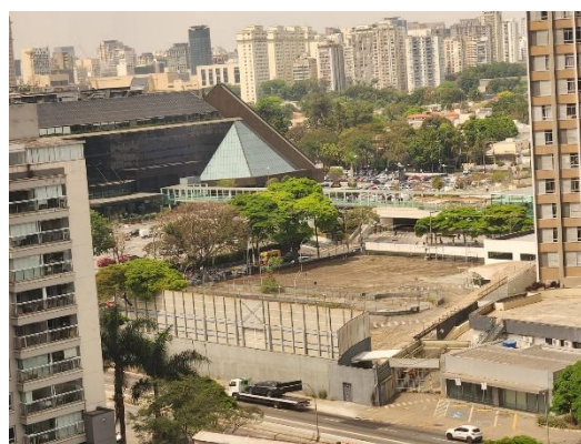
Foto 9.7-2 – Região da estação Hebraica-Rebouças, na planície aluvial do rio Pinheiros, onde a escavação em solos aluviais pode gerar dificuldades na estabilização das paredes de escavação, podendo gerar risco à ocupação de edifícios próximos.
