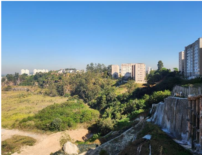
Foto 9.6-9 – Relevo amorreado baixo na região do Pátio, mostrando o talude formado pela antiga pedreira.
