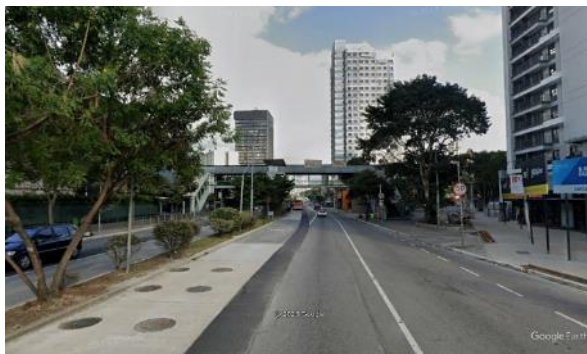
Av. Eusébio Matoso com passarela para o Shopping Eldorado, associada à parada do corredor de ônibus
