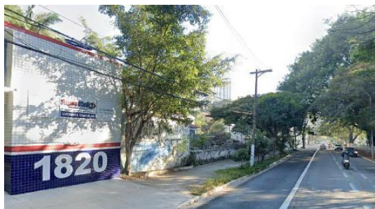
Ocupação da área da VSE1 na av. Sumaré
