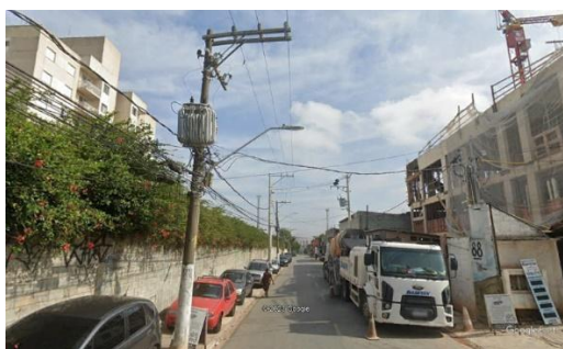
Estrada das Margaridas com condomínios em construção
