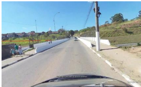
Travessia sobre o Rodoanel – viaduto/ av. Vitor Civita
