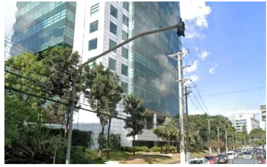
Edifícios comerciais na Marginal Pinheiros
