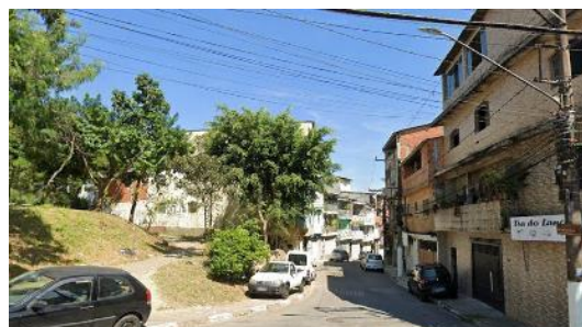
Ocupações em ambas as margens da rua Sacerdote Izaque, a ser desafetada
