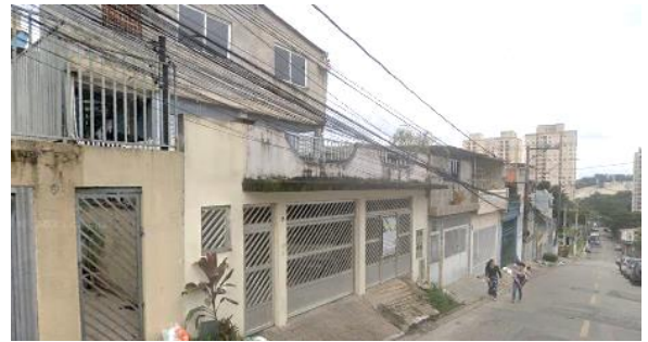
Ocupações na estrada da Divisa, esquina com av. Ayrton Senna
