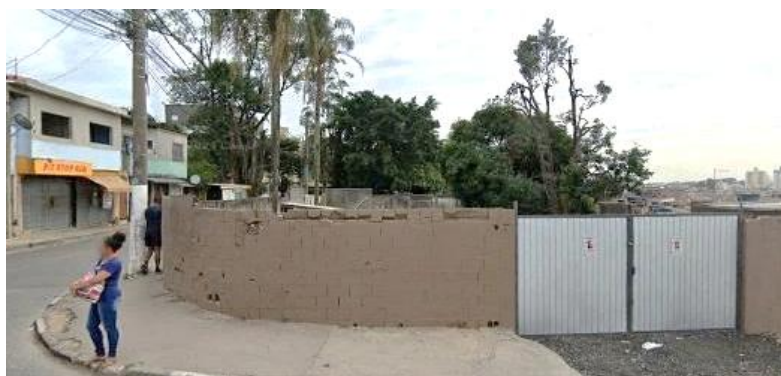
Área murada do acesso norte à estação Santa Maria, na esquina entre a av. Ayrton Senna e a estrada da Divisa
