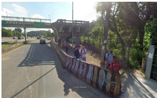
Passarela a 650 m – setor norte
