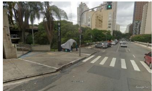
R. Oscar Freire, entrada da estação Sumaré da Linha 2-Verde de Metrô
