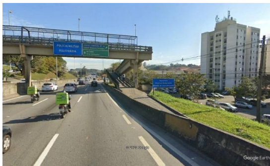
Passarela a 400 m da estação – setor norte
