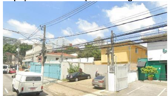
Área da subestação desde a rua Alvarenga com comércio e serviços
