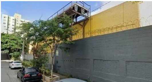
Rua Pangaré, setor norte
