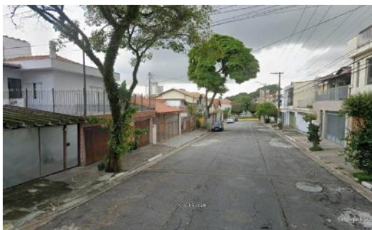
R. Dr. Ernâni da Gama Correa no conjunto Residencial Butantã, com moradias geminadas
