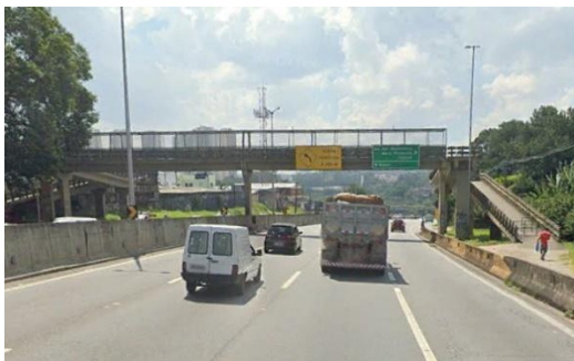
Passarela sobre a rodovia Raposo Tavares
