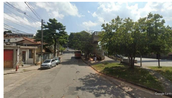
Passarela a 400 m da estação – setor sul
