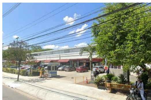
Av. Corifeu de Azevedo Marques – setor sul Fonte: Street View – Pesquisa de campo
