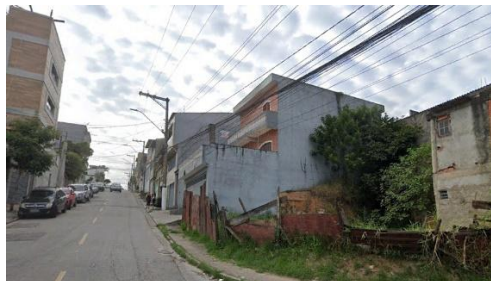
Estrada da Divisa - moradias
