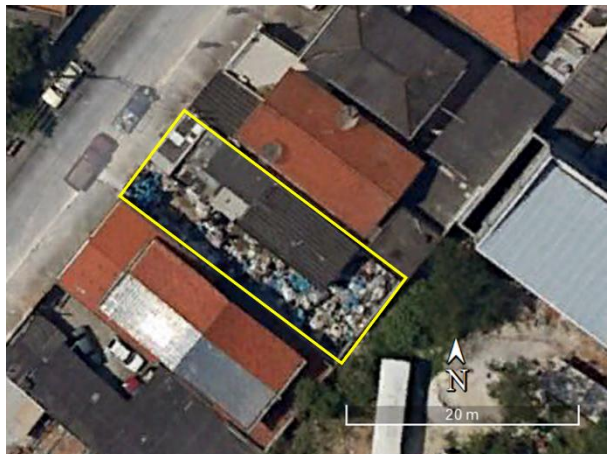
Foto 30 – Imagem de satélite da área em outubro/2020, que sugere gerenciamento inadequado de resíduos sólidos.
