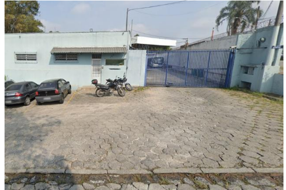
Foto 46 – Vista atual da Viação Raposo Tavares Ltda., em abril/2024, ativa.
