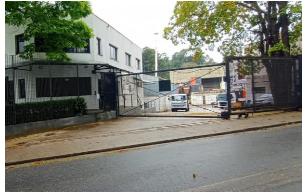
Foto 64 – Vista atual da Drill Co Fundações, em setembro/2025, ativa.
