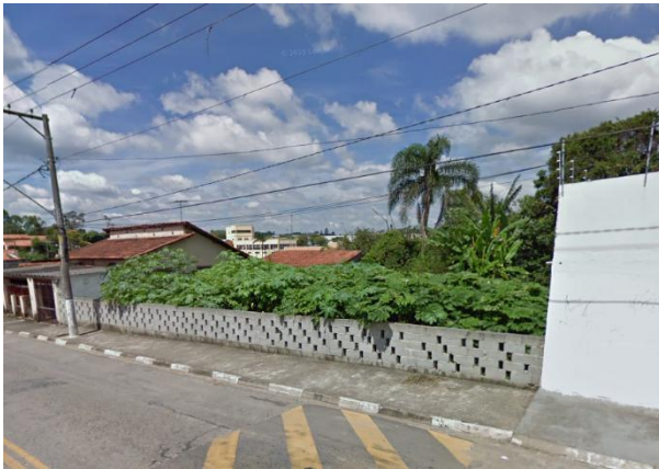
Foto 71 – Vista geral do imóvel em janeiro/2010, desocupado.
