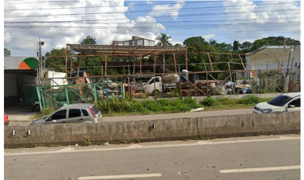
Foto 70 – Vista atual da MHC - Mecânica Hidráulica Cotia Ltda., em outubro/2024, ativa.
