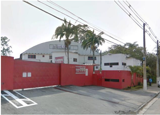
Foto 59 – Vista geral do imóvel ocupado pela Cervejaria Petrópolis, em agosto/2016, ativo.
