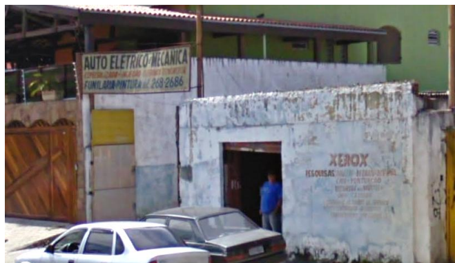
Foto 33 – Vista geral do Autoelétrico e Mecânica, em março/2010, ativo.
