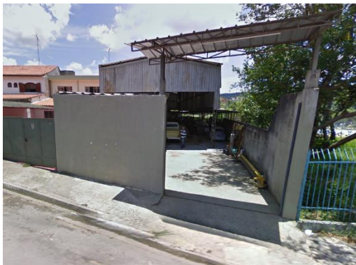
Foto 75 – Vista geral da área da Miyake Mecânica, em fevereiro/2010, ativa.
