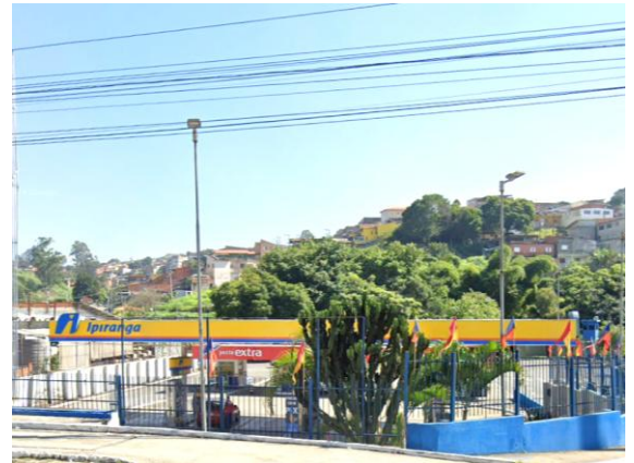
Foto 74 – Vista atual do posto de combustível, sob a bandeira Ipiranga, em abril/2024, ativo.
