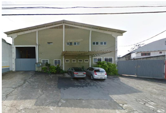
Foto 57 – Vista geral da antiga Support-Drill Indústria Metalúrgica, em agosto/2016, ativa.
