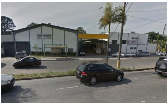
Foto 53 – Vista geral da antiga Auto Q3 Mecânica, Funilaria e Pintura, em julho/2016, ativa.
