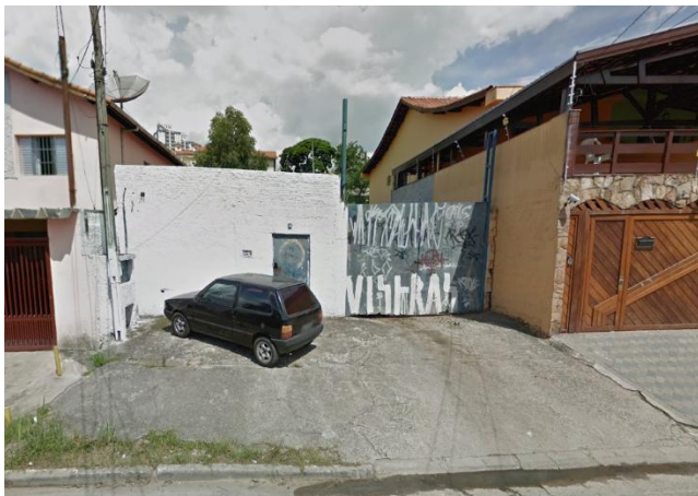
Foto 29 – Vista geral da área do antigo depósito de resíduos, em fevereiro/2011.
