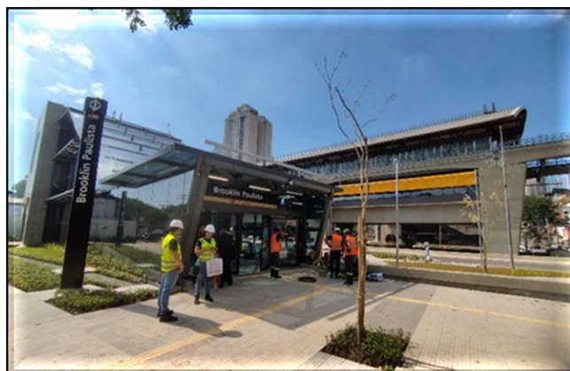
Obras Civas – Reurbanização do Acesso 2.
