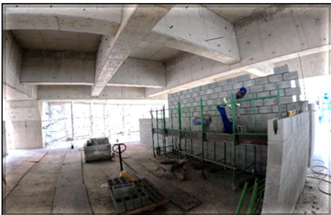
Fechamento das paredes em alvenaria.
