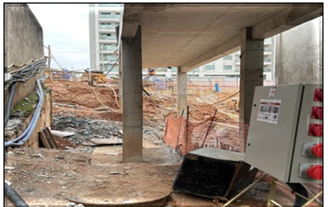
Passarela do ETO para o Acesso Leste.
