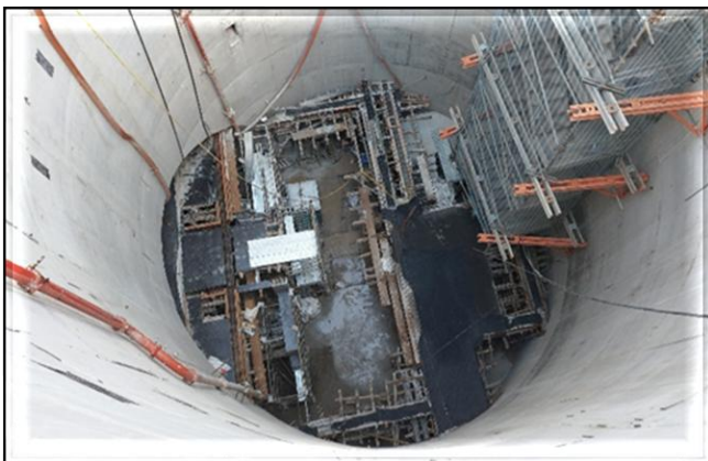
Estruturas de concreto do poço em execução.
