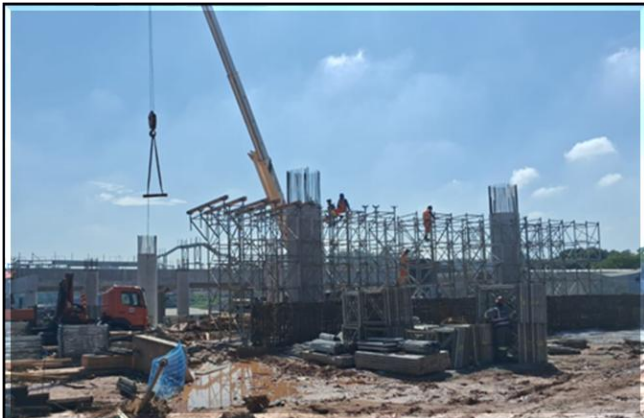
Obra Civil – montagem do cimbramento para execução das vigas travessas das vias de estacionamento (área 4).
