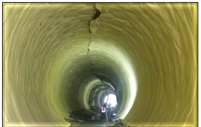
Impermeabilização do Túnel em execução.
