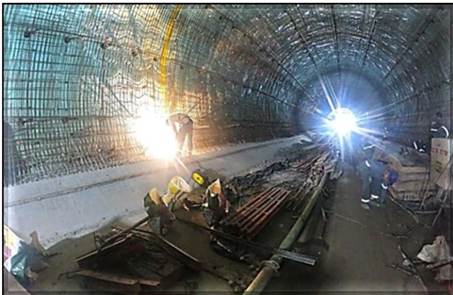
Revestimento secundário do túnel: armação da parte superior em execução.
