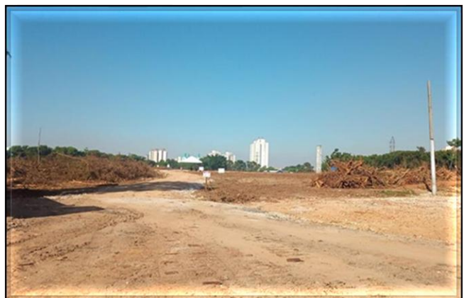
Remanejamento arbóreo em execução.
