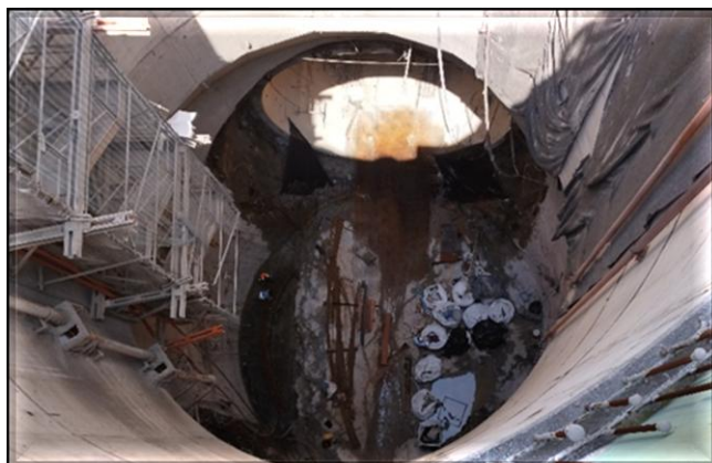
Revestimento secundário do túnel.
