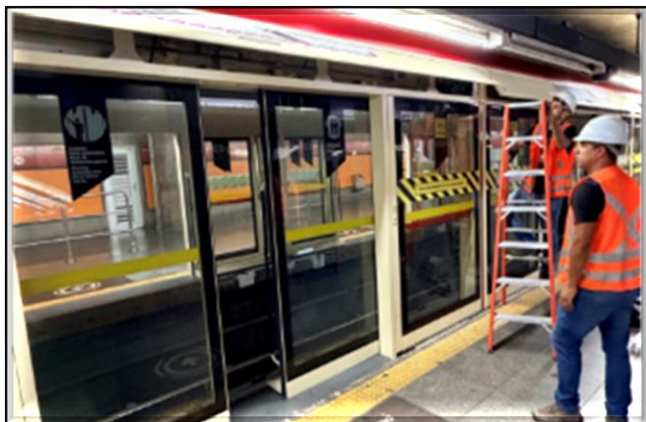
Fachadas das portas de plataforma em instalação.
