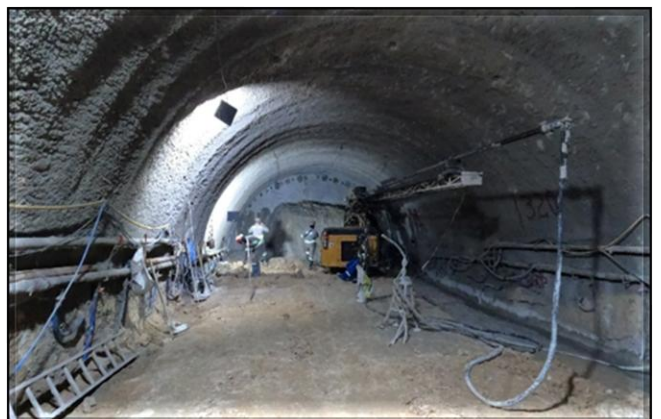
Tratamento do maciço no avanço da cambota em execução
