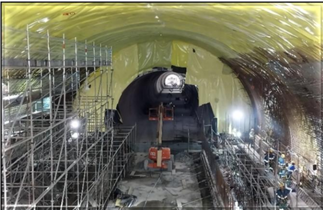
Armações do revestimento secundário e das paredes da plataforma em execução.
