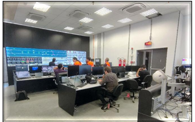
Bloco B – CCO – em atividades na operação transitória.
