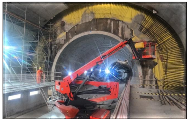
Corte parcial do anel feito pela tuneladora em preparação.
