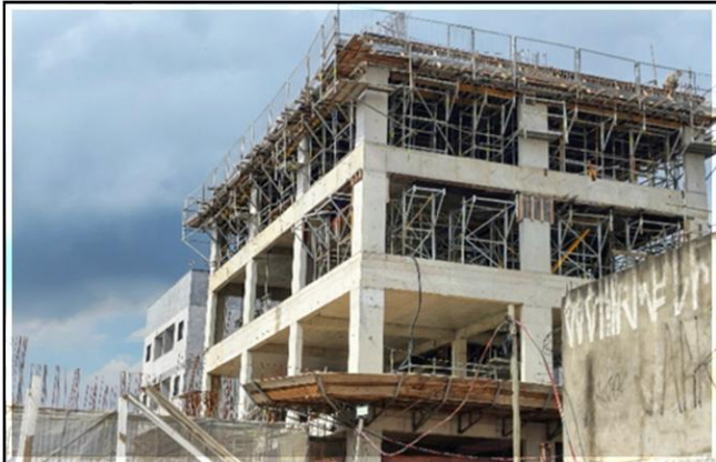
Obra Civil – execução das estruturas de concreto do Edifício Técnico.
