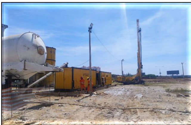
Aplicação de colunas de jet grouting em execução.
