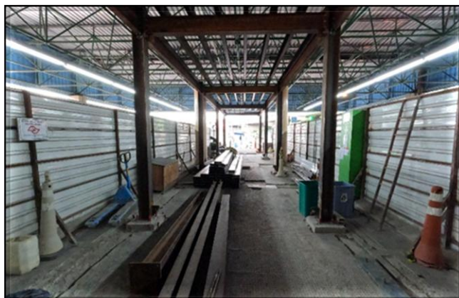
Estrutura metálica para retirada dos sistemas e execução de nova cobertura metálica, na Linha 3 - Vermelha
