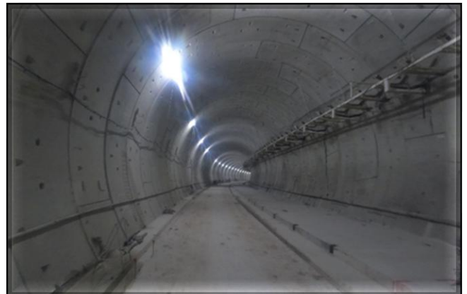
Trecho VSE Falchi Gianini – Orfanato: enchimento de via executado.
