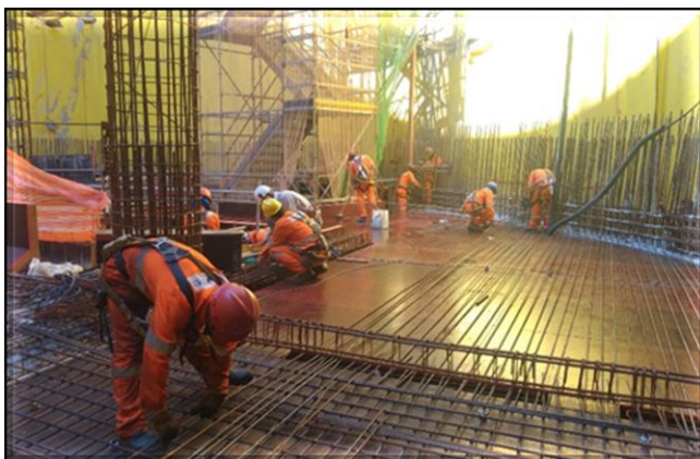
Estruturas de concreto do poço do corpo da estação.
