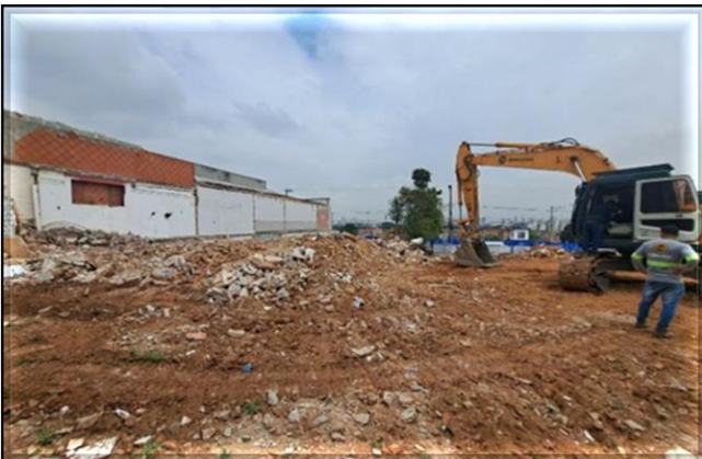
Limpeza da área desapropriada para implantação das obras civis.
