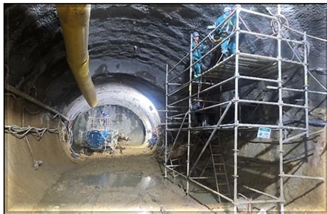
Túnel norte: escavação do túnel e execução dos pré-furos para o patamar de descanso 2.
