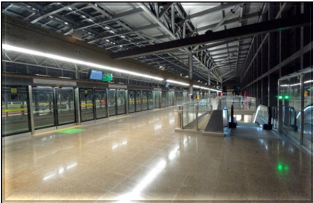
Plataforma (corpo da estação) durante o início da operação transitória em 31/03/2026.
