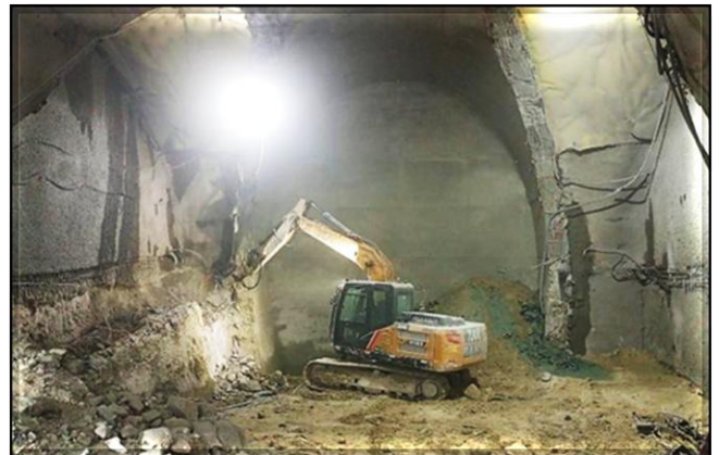
Escavação do rebaixo do túnel direcional norte.
