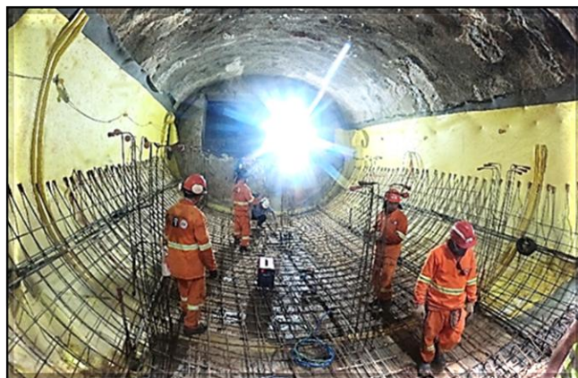
Túnel sul: armação do revestimento secundário do arco invertido.
