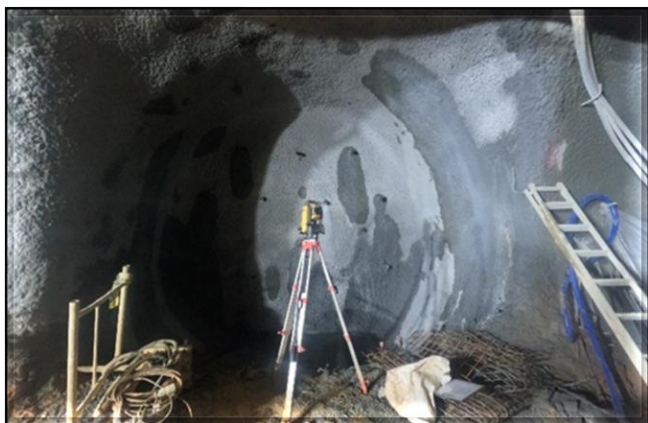
Túnel norte: patamar de descanso 1 escavado.
