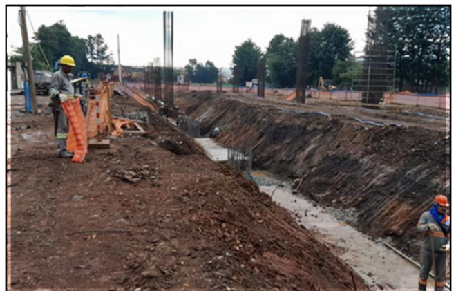
Obra Civil – execução dos blocos de fundação do track switch.
