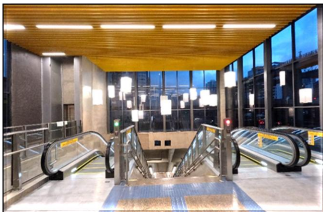
Acesso à interligação com a Linha 5 – Lilás, durante o início da operação transitória em 31/03/2026.
