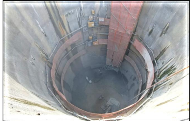
Escavação e revestimento primário do poço do corpo da estação.
