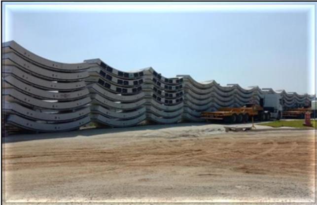
Segmentos de anéis para escavação do túnel.
