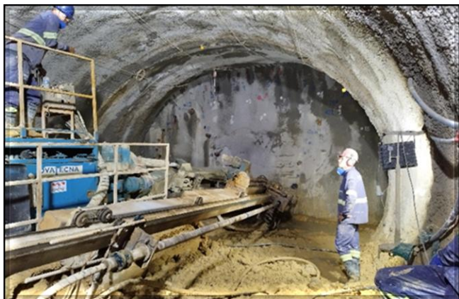
Túnel norte: tratamento do maciço da cambota 83.
