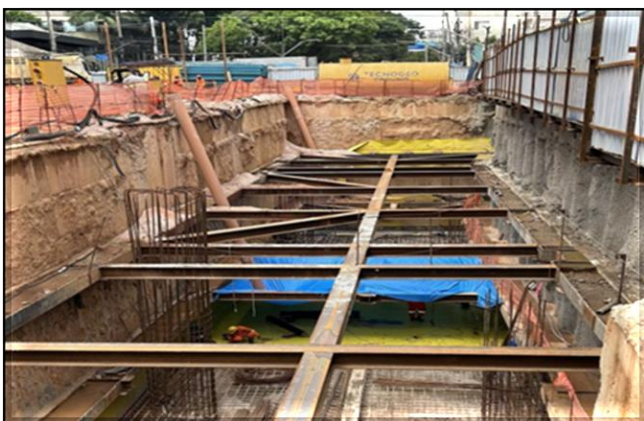
Área de integração (lado oeste): armação, forma e concretagem do bloco de fundação.
