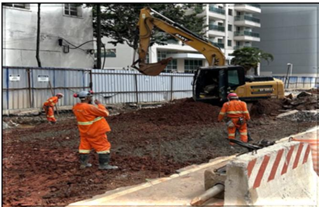
Canteiro de Obras.
