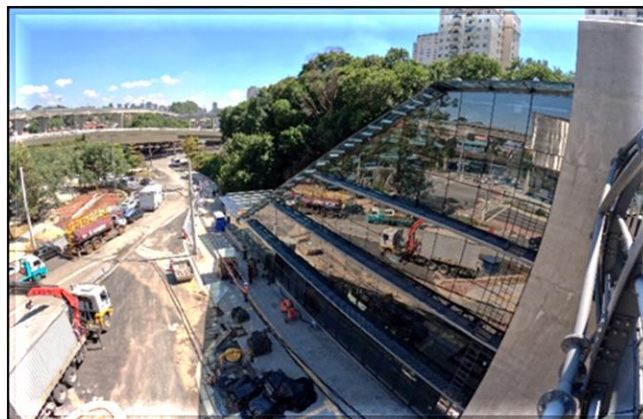
Obra Civil – Paisagismo no Acesso 2 em execução.
