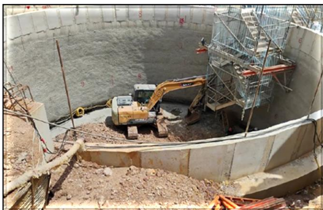
Escavação do poço do acesso secundário.
