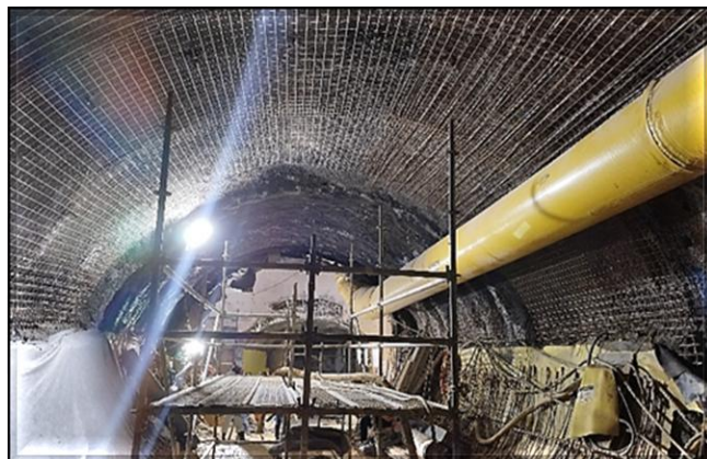
Túnel norte: complemento de reforço superior do túnel em execução, na região do trecho de patamar de descanso.
