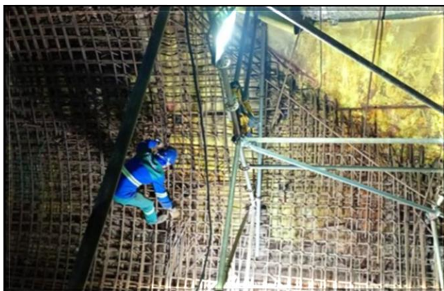
Revestimento secundário do túnel.
