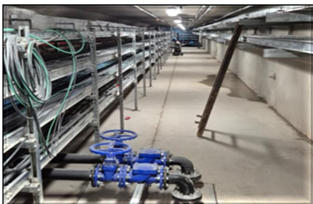
Novo Edifício Técnico Operacional (ETO)/ Porão de cabos: instalações hidráulicas e lançamento de cabos.
