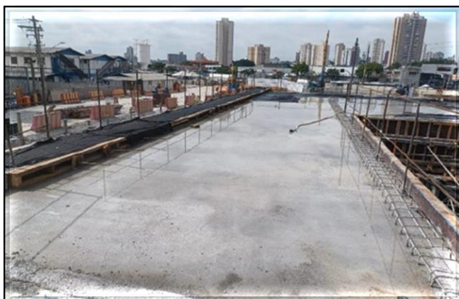
Estruturas de concreto do corpo da estação.
