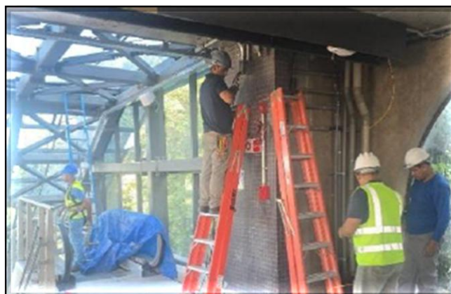
Sistemas – instalação da infraestrutura no Acesso 2.
