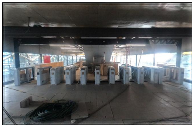
Sistemas – Instalação dos bloqueios e validadores
