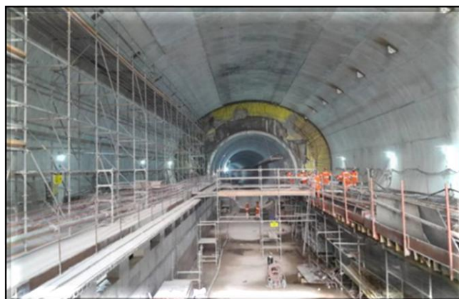
Estruturas de concreto do corpo da estação.
