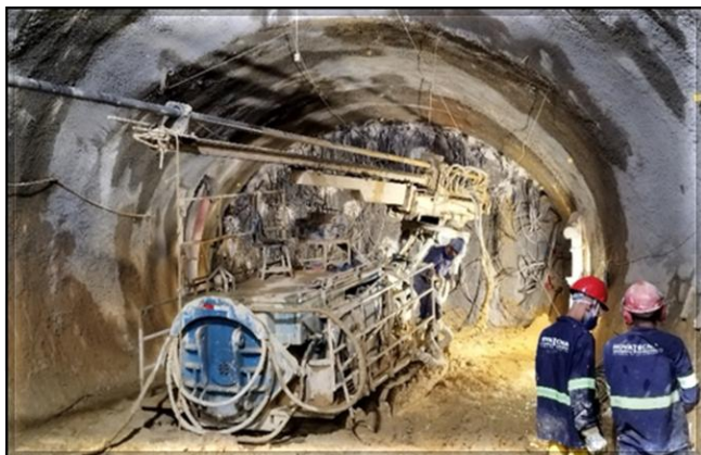
Túnel norte: tratamento do maciço da cambota 72.
