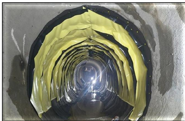
Impermeabilização do túnel de estacionamento.
