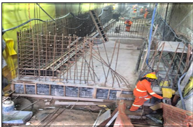
Mezanino sentido Jabaquara (lado sul): Armação, forma e concretagem da primeira etapa da laje de fundo.
