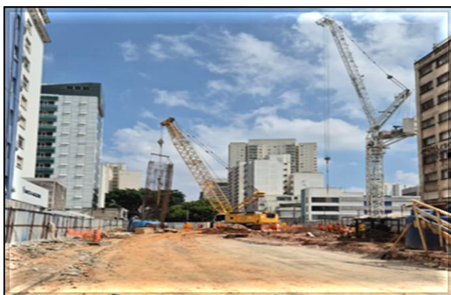
Canteiro de Obras.
