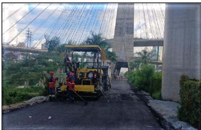
Obra Civil – execução da ciclovia no trecho entre as estações Morumbi e Chucuri Zaidan.
