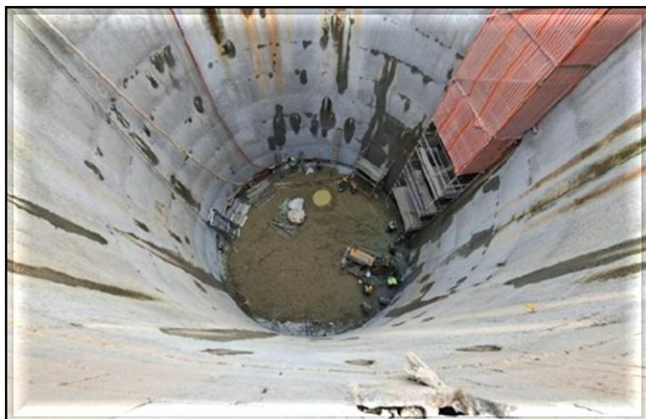
Escavação do poço.
