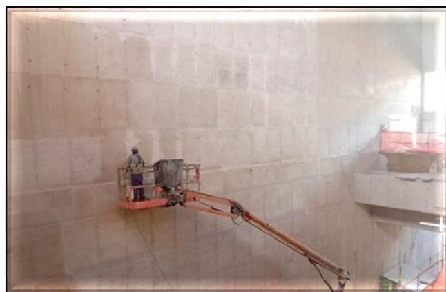
Tratamento de concreto no corpo da estação da CPTM.
