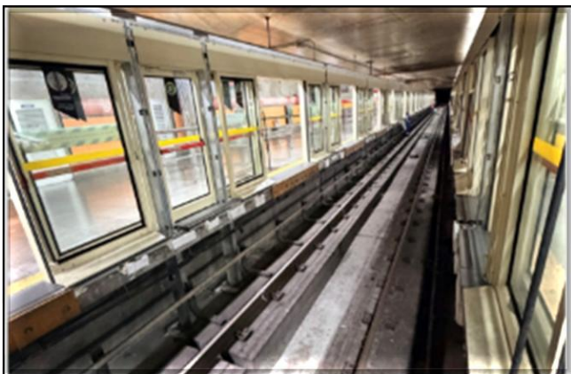
Fachadas das portas de plataforma em instalação.
