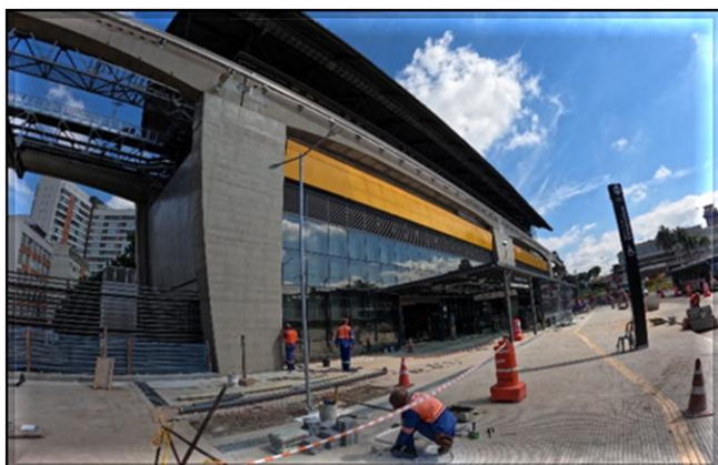
Obra Civil – execução da urbanização do Acesso 1.
