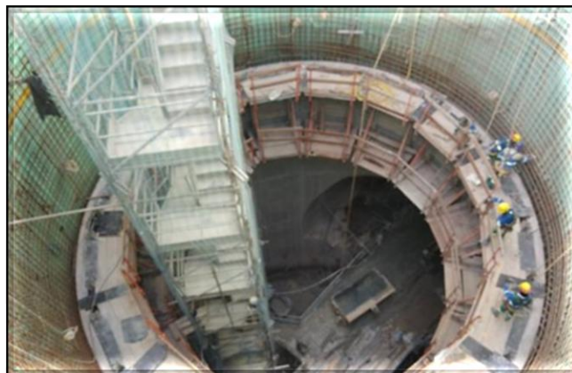
Revestimento secundário do Poço.
