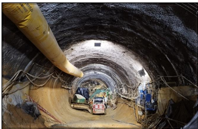
Túnel norte: retomada da escavação a partir da cambota 73.
