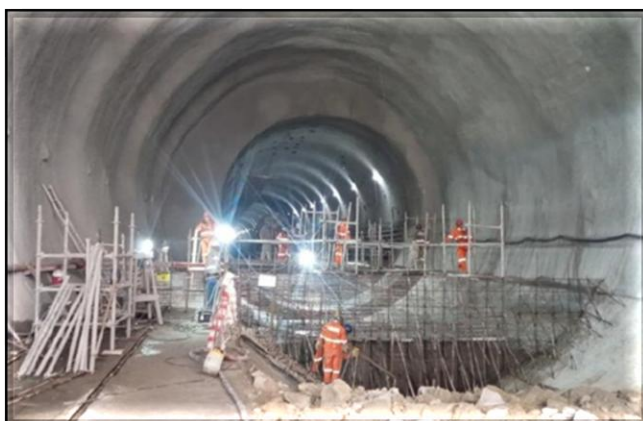
Enchimento do túnel para via permanente.
