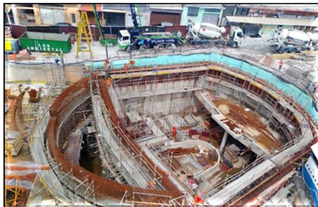
Estruturas de concreto do corpo da estação.
