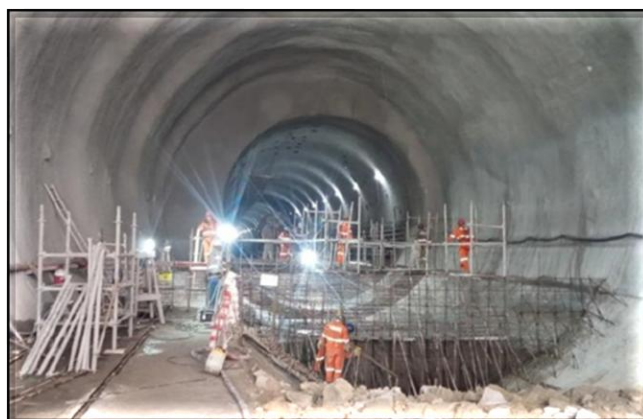
Enchimento da via.
