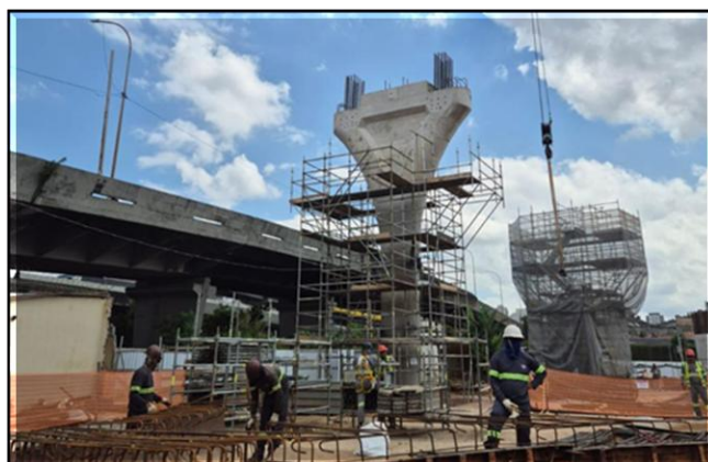
Obra Civil – execução dos pilares e capitéis junto à Avenida Luiz Ignácio de Anhaia Mello.
