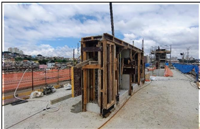
Obra Civil – execução das estruturas de concreto dos módulos da plataforma.
