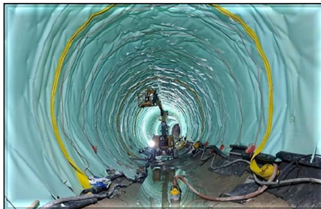
Impermeabilização do túnel.
