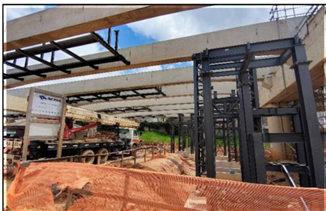
Obra Civil – instalação das passarelas da via de estacionamento.
