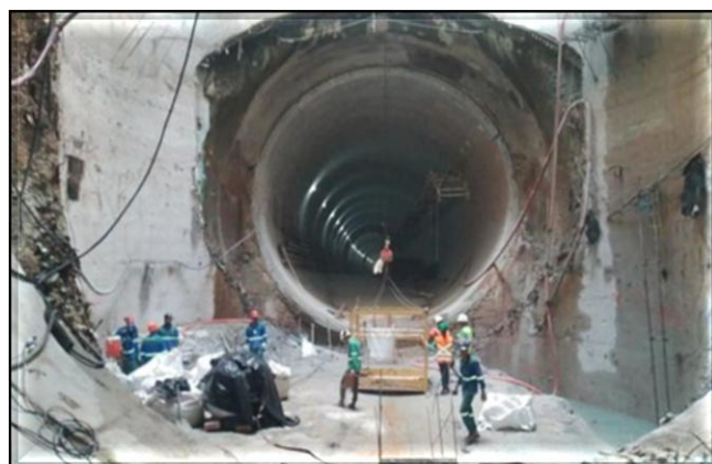
Revestimento secundário do túnel.
