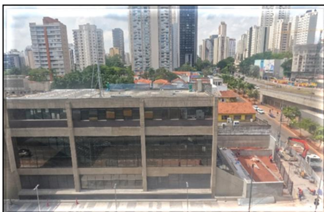
Obra Civil - urbanização do Acesso 1 em execução.
