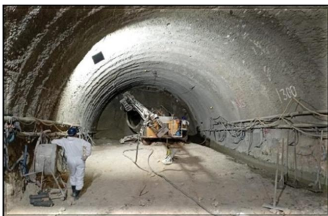
Escavação do túnel de estacionamento.
