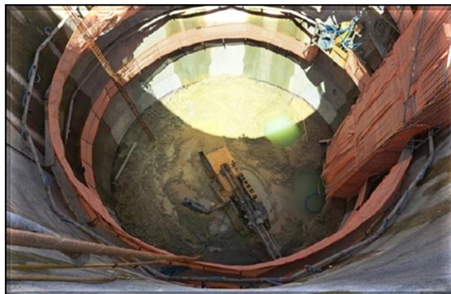
Escavação do poço.
