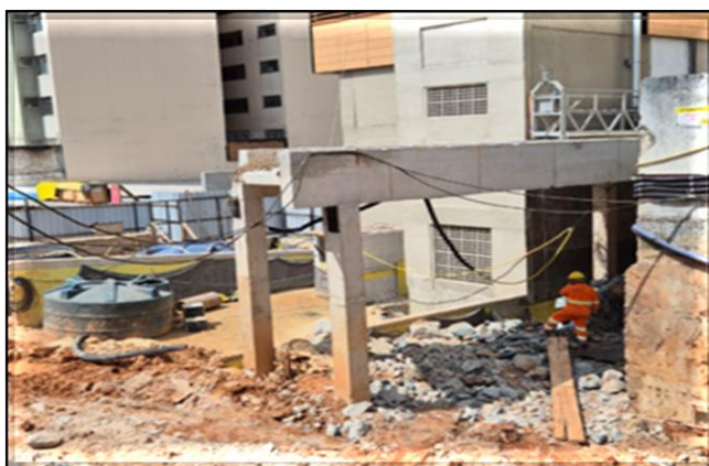
Passarela do ETO para o Acesso Leste.
