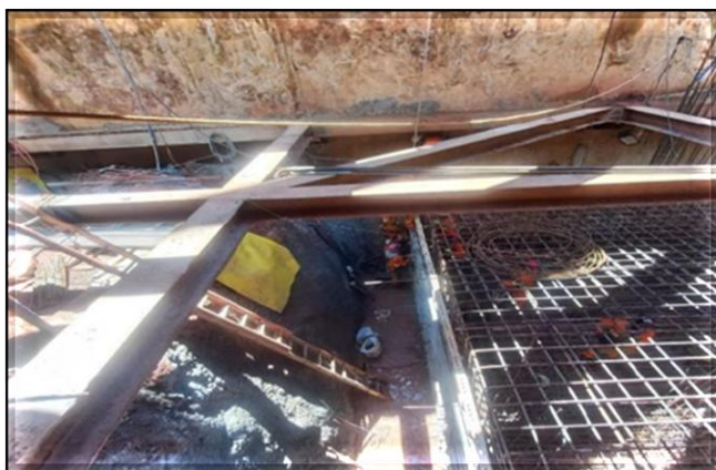
Área de integração (lado oeste): armação, forma e concretagem do bloco de fundação.
