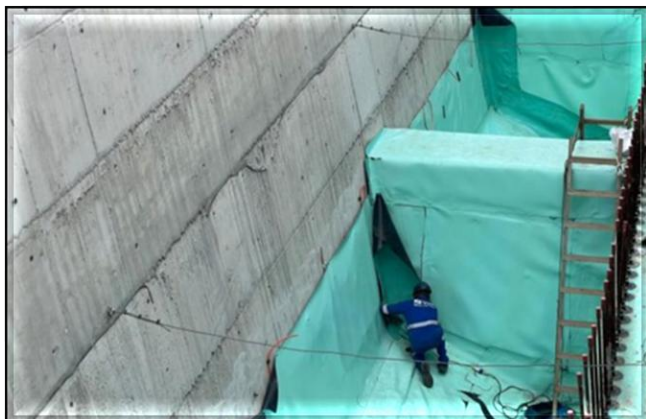
Impermeabilização do acesso.
