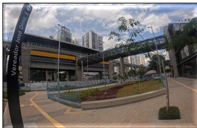
Obra Civil – urbanização, paisagismo e comunicação visual.
