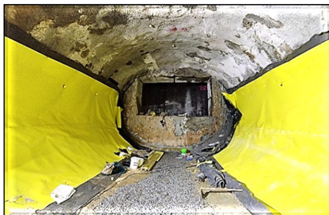
Túnel sul: impermeabilização do invert em execução.
