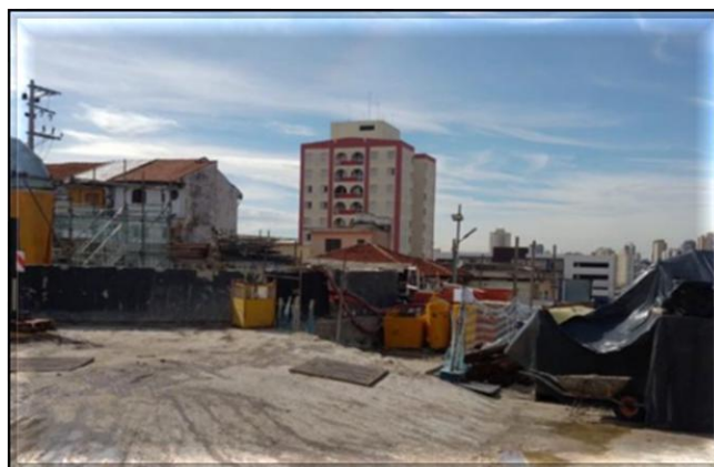
Manutenção do canteiro.
