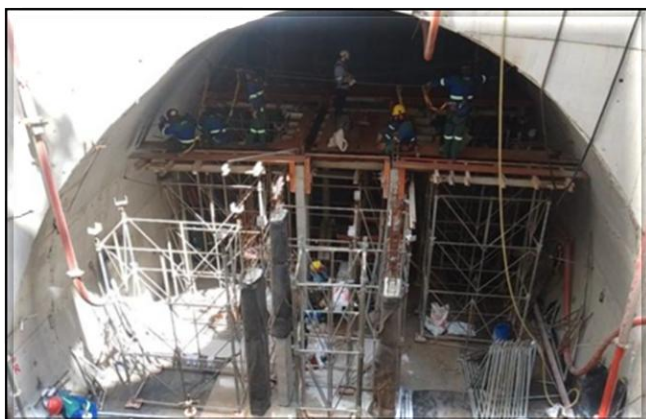
Estruturas de concreto do poço.
