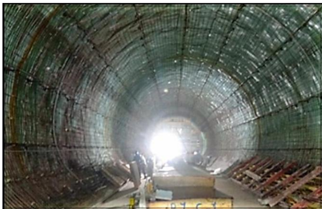
Revestimento secundário do túnel.
