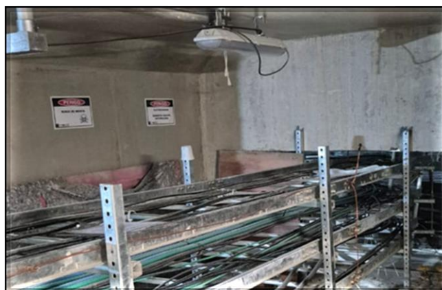
Novo Edifício Técnico Operacional (ETO)/ Porão de cabos: montagem do bandejamento e lançamento dos cabos de 22kV.
