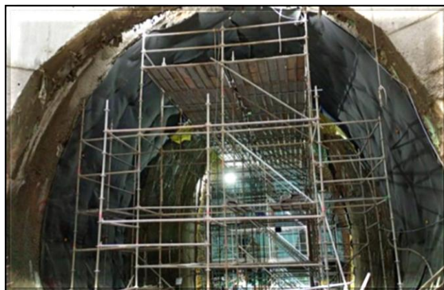
Revestimento secundário do túnel.
