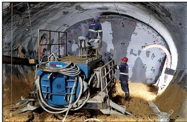
Túnel norte: tratamento do maciço da cambota 72.
