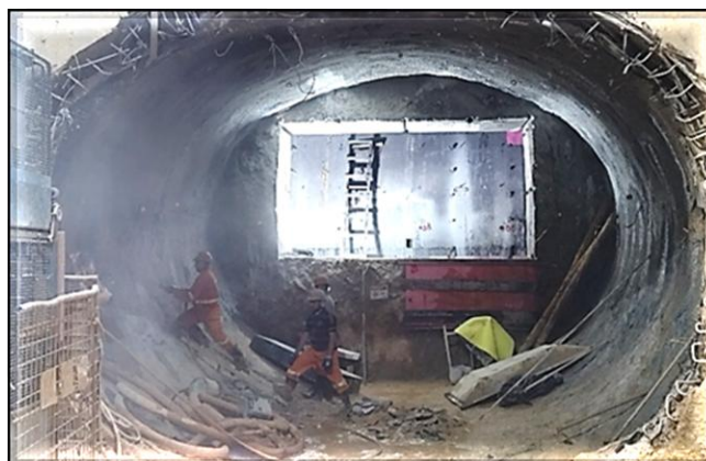
Túnel sul: regularização das paredes do revestimento primário para início da impermeabilização.
