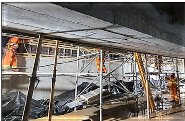
Plataforma Oeste (Jabaquara)/ Lado Norte: remoção do escoramento da laje.
