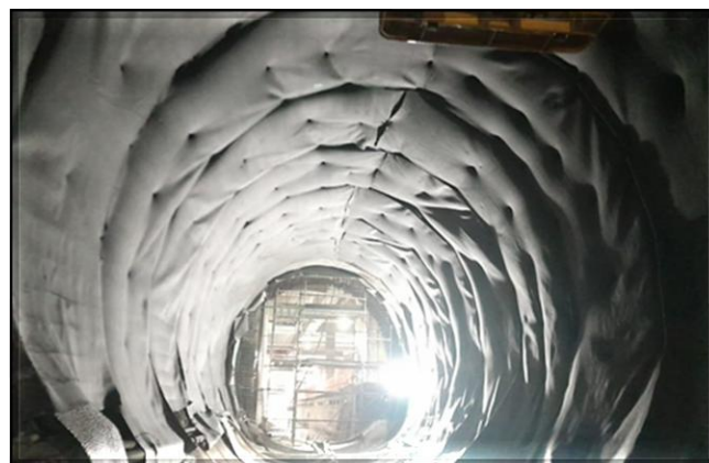
Impermeabilização e revestimento secundário.
