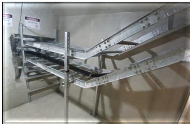
Novo Edifício Técnico Operacional (ETO)/ Porão de cabos: montagem do bandeamento e lançamento dos cabos de 22kV.
