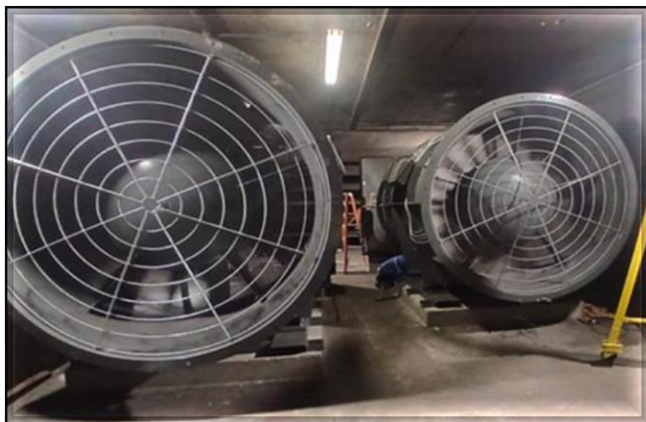
Ventilação Principal: montagem dos ventiladores na VSE 4.1.
