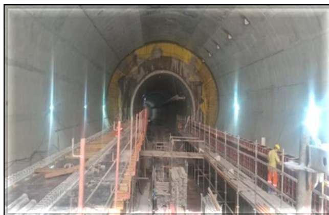
Estruturas de concreto do corpo da estação.
