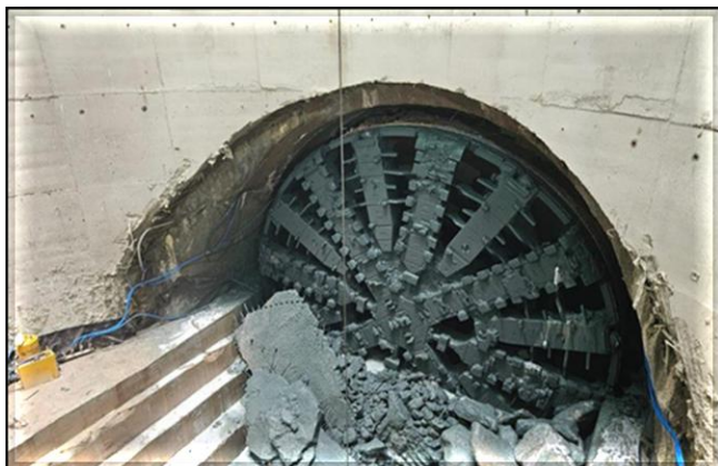
Vista da roda de corte na chegada da tuneladora na VSE Soares Neiva.
