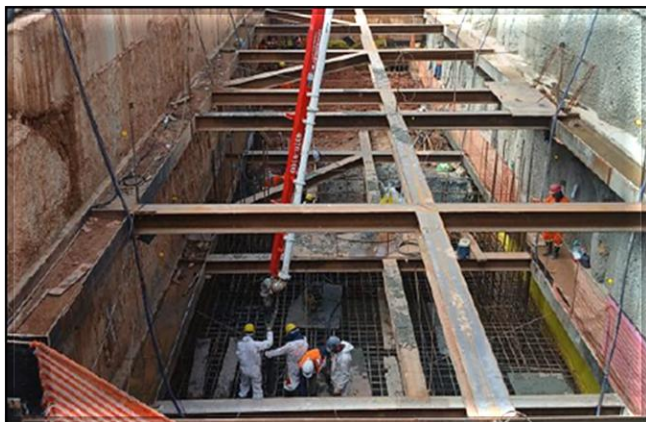
Saguão de Integração Oeste: escavação e concretagem dos blocos de fundação.
