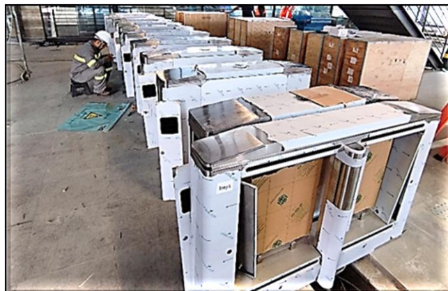
Sistemas – instalação dos bloqueios no mezanino.
