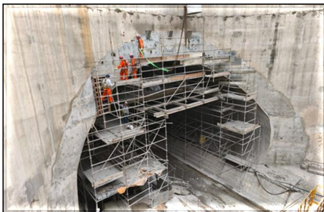
Revestimento secundário do túnel.
