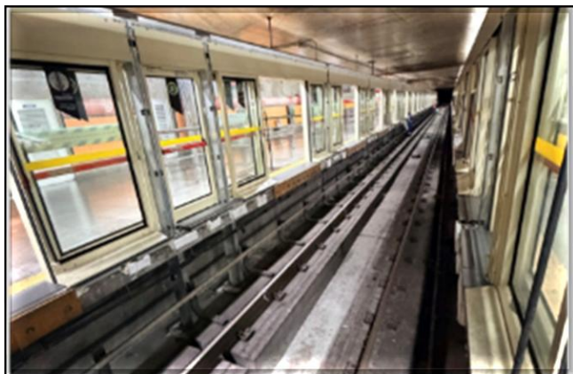
Fachadas das portas de plataforma em instalação.
