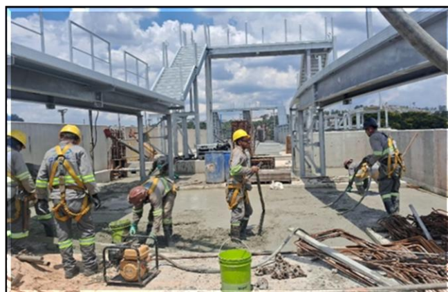
Obra Civil – instalação das passarelas e regularização da laje do deck-switch.
