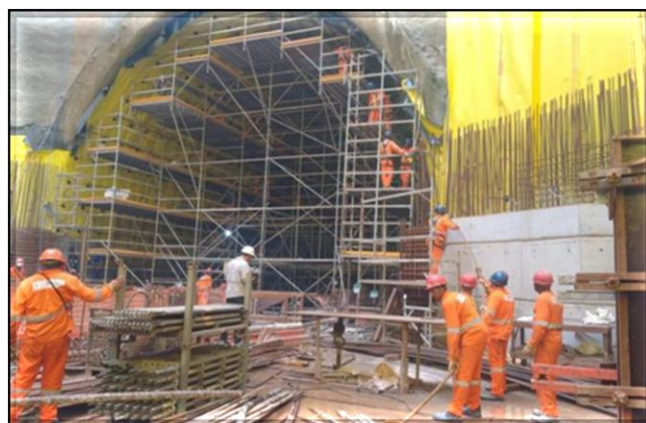
Laje de fundo e estruturas de concreto do poço do corpo da estação.
