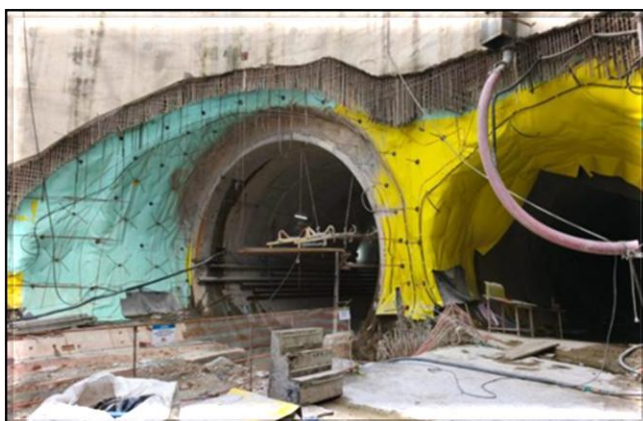
Revestimento secundário do túnel.
