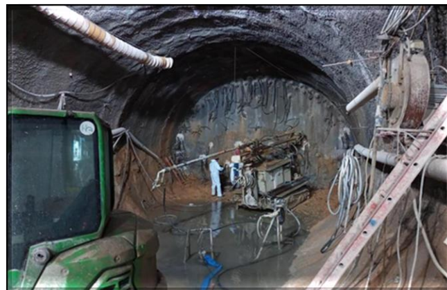
Túnel norte: tratamento do maciço da cambota 54, concluída em 12/12/2025
