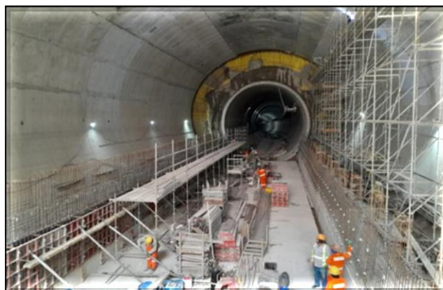
Estruturas de concreto da plataforma do corpo da estação.
