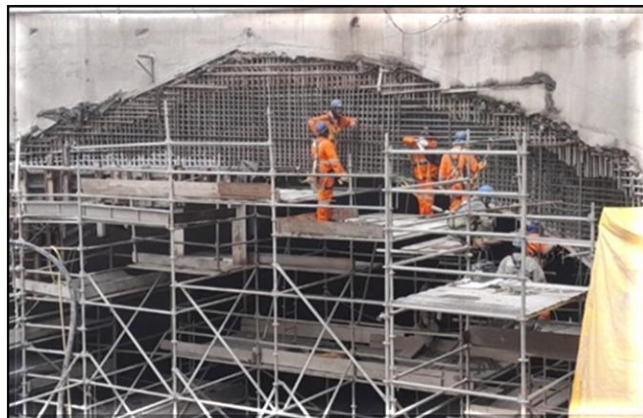
Revestimento secundário do túnel de transição.
