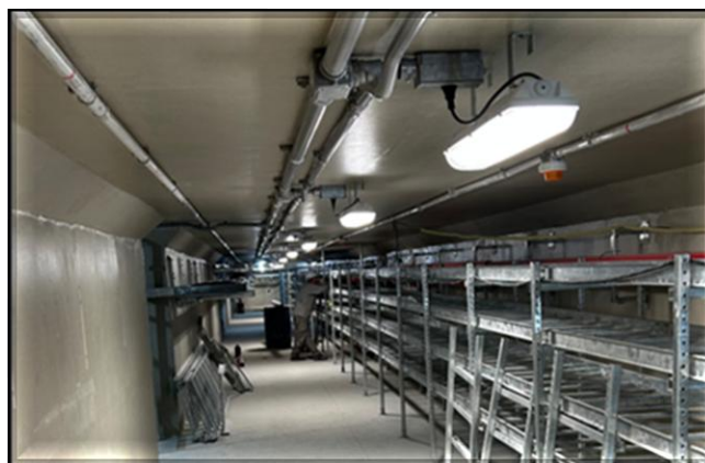
Novo Edifício Técnico Operacional (ETO): Porão de cabos (bandejamento para conexão com o sistema antigo de 22kV).
