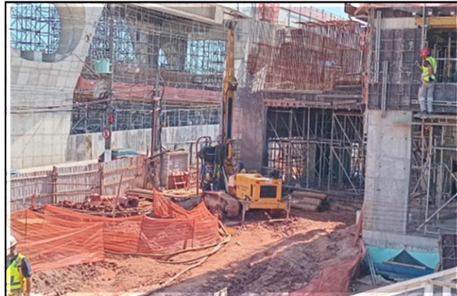
Obra Civil – execução da estrutura de concreto do mezanino do corpo da estação, do acesso e Edifício Técnico.
