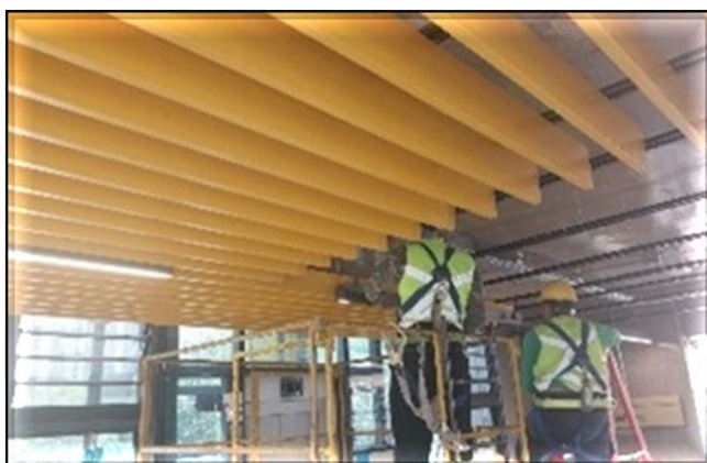
Sistemas – instalação do forro do mezanino.
