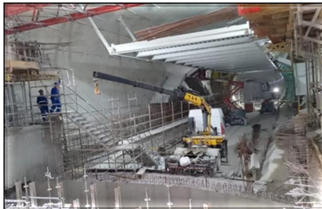
Montagem do mezanino metálico.
