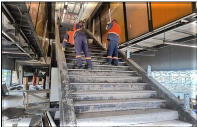
Obra Civil – instalação do guarda corpo da escada fixa de acesso à plataforma.
