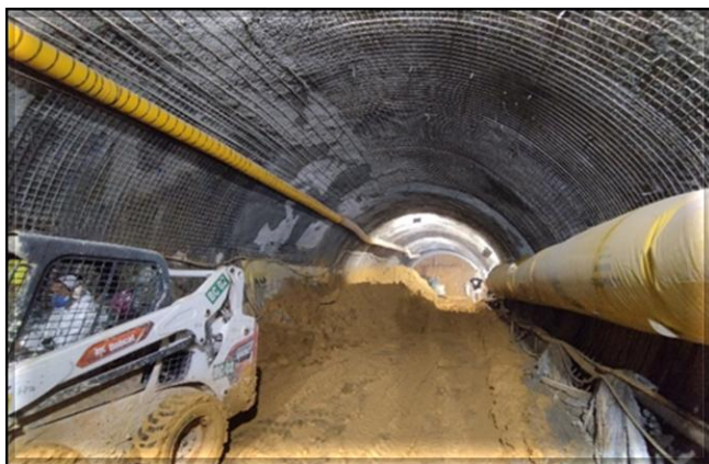
Túnel norte: complemento de reforço superior do túnel em execução, na região do trecho de patamar de descanso.
