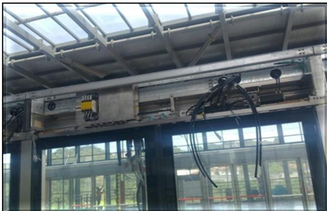
Sistemas – lançamento de cabos e instalação dos equipamentos das Portas de Plataforma.
