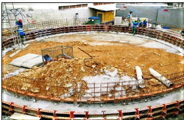
Viga de borda do poço do acesso secundário.
