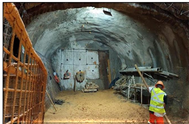
Túnel sul: execução da abertura da parede do túnel de conexão existente.
