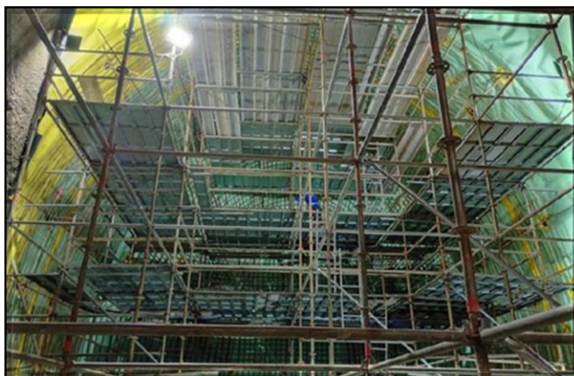
Revestimento secundário do túnel.
