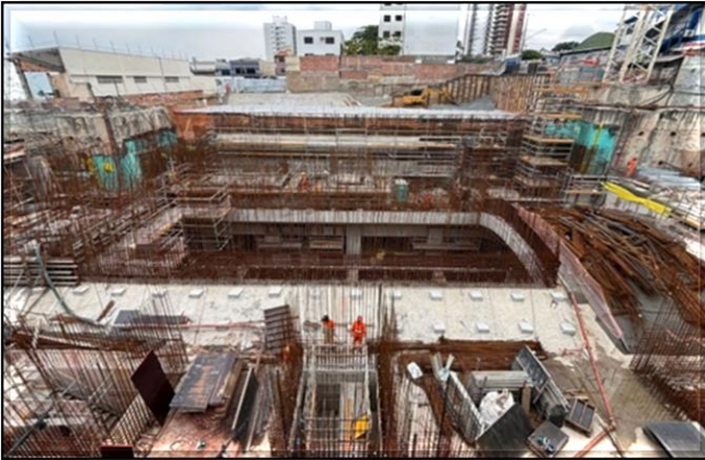
Estruturas de concreto da laje de cobertura.
