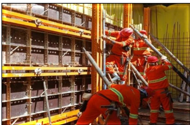
Plataforma lado norte: Armação, forma e concretagem das paredes e vigas.
