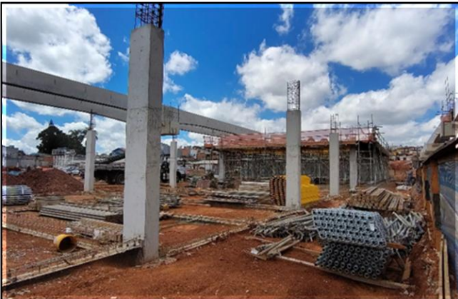
Obra Civil – execução da estrutura de concreto do Bloco B.
