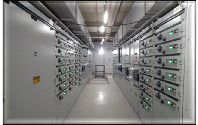
Sistemas – testes e energização dos quadros de distribuição de baixa tensão.
