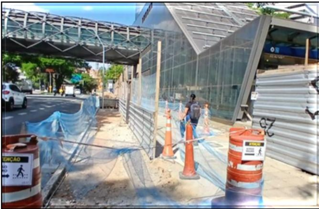
Obra Civil – atividades para execução da urbanização do acesso.
