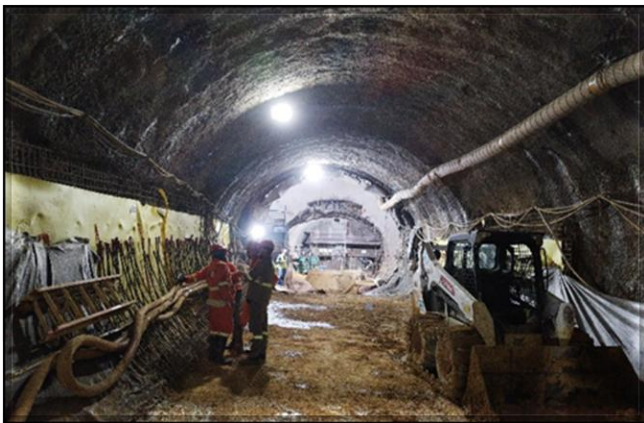
Túnel norte: 18m de revestimento secundário executados (vista sentido Túnel sul)
