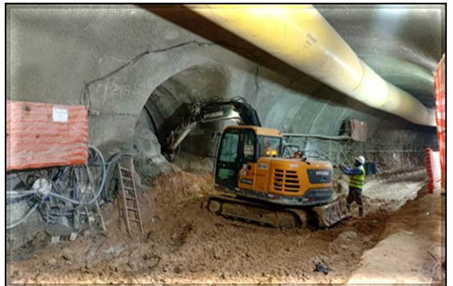
Escavação do túnel de interligação.
