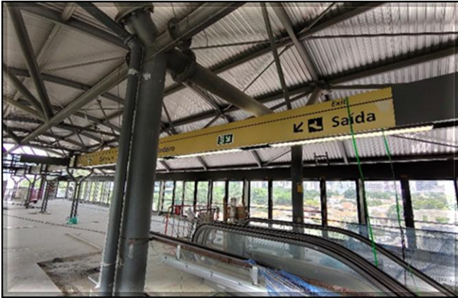
Obra Civil – instalação da comunicação visual na plataforma.
