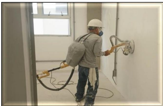
Novo Edifício Técnico Operacional (ETO): Preparação e pintura interna.
