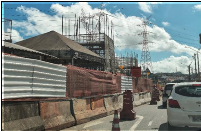
Obra Civil – execução dos pilares da via elevada no trecho entre as estações Jd. Colonial e Boa Esperança.
