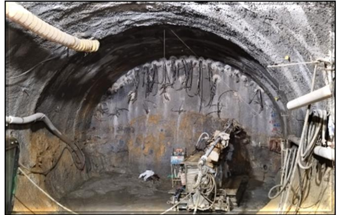
Túnel norte: tratamento da cambota 54 em execução.
