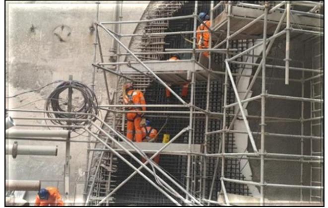
Revestimento secundário do túnel de transição.
