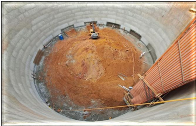
Escavação do poço do corpo da estação.
