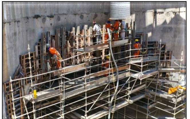
Revestimento secundário do túnel.
