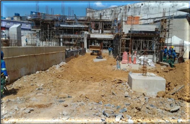
Fundação e estruturas de concreto das salas técnicas.
