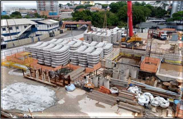
Vista do canteiro na estação Penha.
