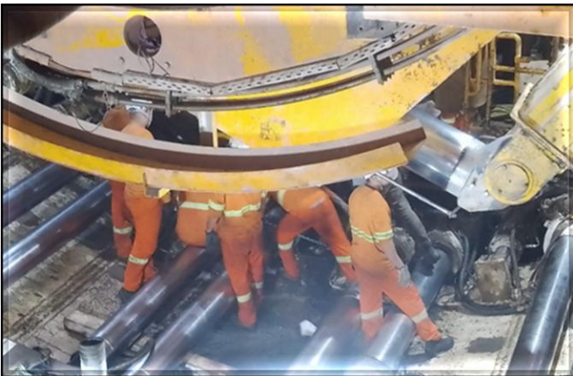
Montagem da Tunneladora na estação Penha.
