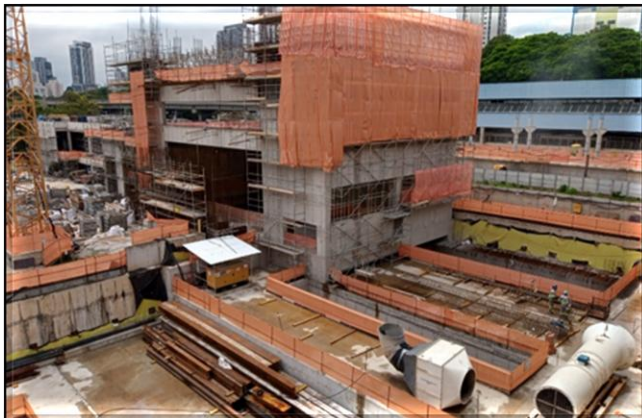
Estruturas de concreto do corpo da estação da CPTM.
