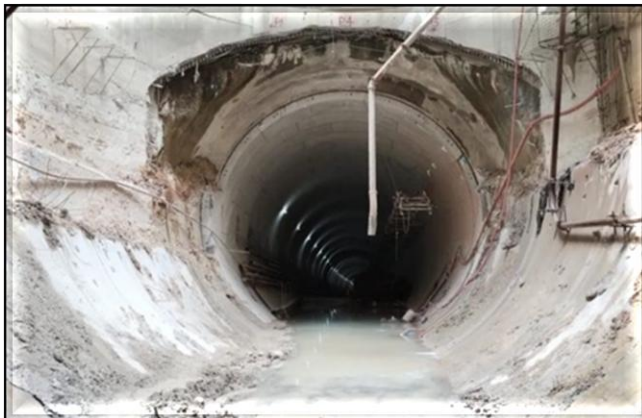
Remoção da demolição do túnel falso.
