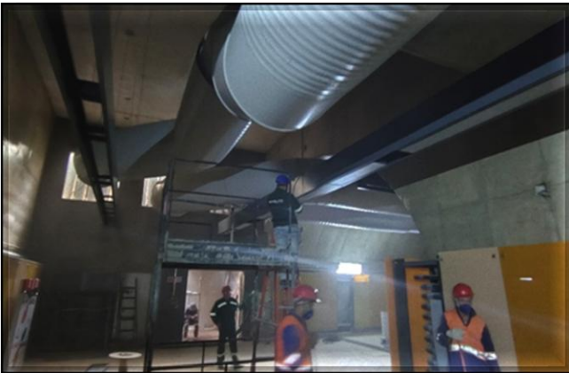
Sistemas – instalação das luminárias no túnel de interligação com o Aeroporto.
