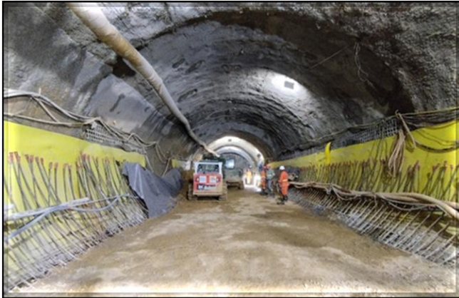
Túnel norte: 18m de revestimento secundário executados.
