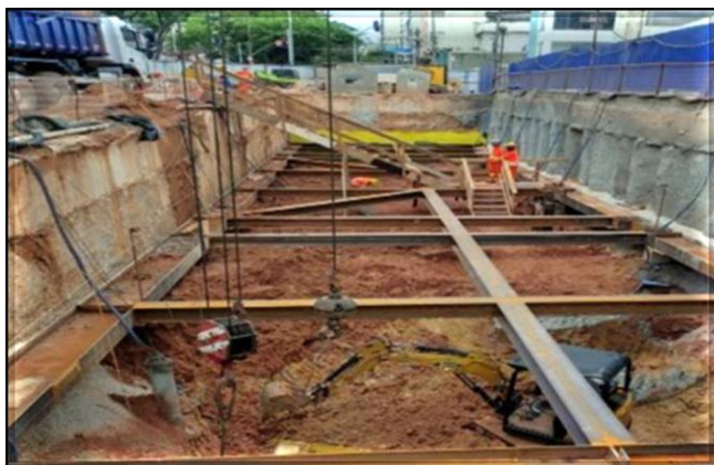
Área de integração, lado oeste: Segunda etapa da escavação.
