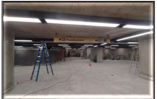
Obra Civil – instalação da comunicação visual na região de interligação com a Linha 5 - Lilás
