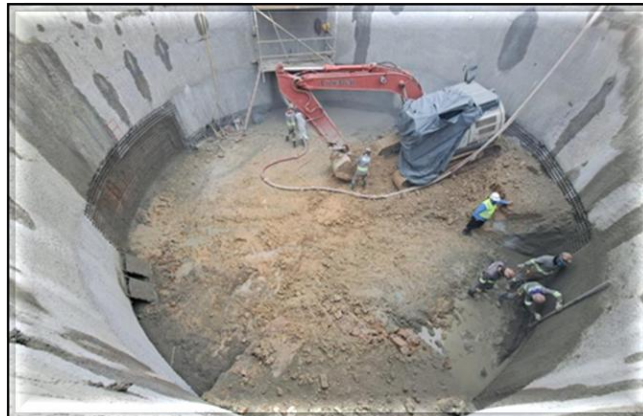
Escavação do poço.
