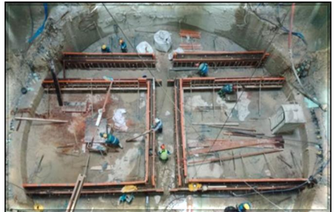
Estruturas de concreto do poço.
