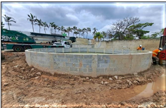
Guarda corpo para escavação do poço.
