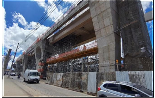
Obra Civil – execução da estrutura de concreto do mezanino do corpo da estação.
