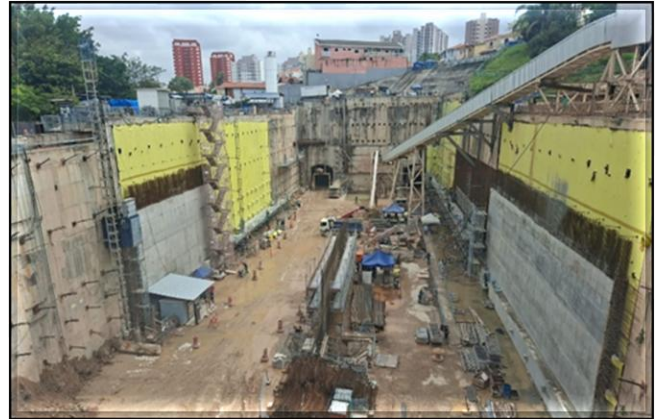
Estruturas de concreto da vala.
