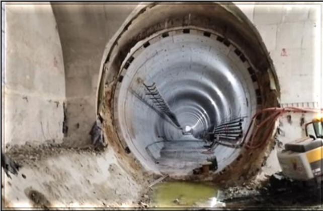
Demolição do túnel falso.
