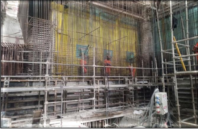
Revestimento secundário do corpo da estação.
