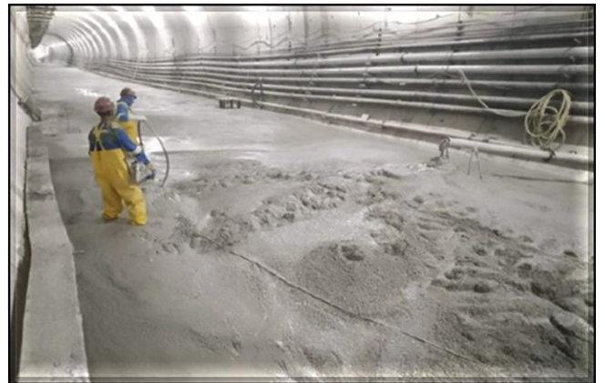
Enchimento do túnel para execução da via permanente.
