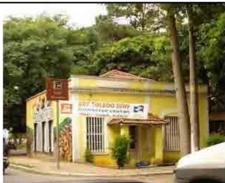
Figura 4.3.7-1: Antiga casa do chefe da estação ferroviária, restaurada e conhecida como "Casa Amarela", localizada na Praça IV Centenário, em Guarulhos.
