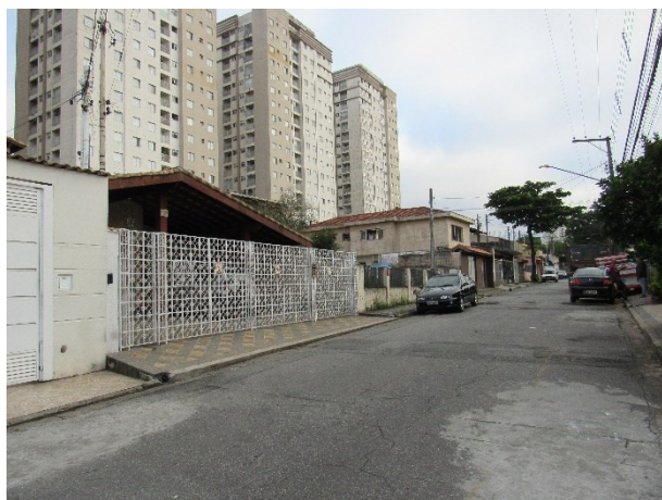
Foto 9.2.5.2-3 – Ambiente urbano no local de implantação do VSE São Pedro, na Rua São Pedro.
