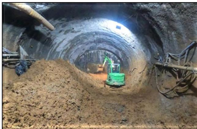
Túnel norte: Escavação da 27ª cambota concluída.
