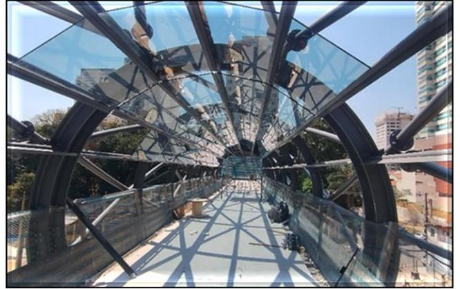
Obra Civil – instalação dos vidros da passarela do Acesso 2.
