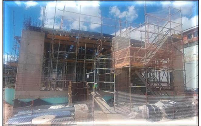
Obra Civil – executados os pilares e em andamento a laje das Salas Técnicas de nível 1 do Edifício Técnico.
