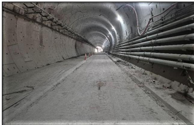
Enchimento de concreto para execução da via permanente.
