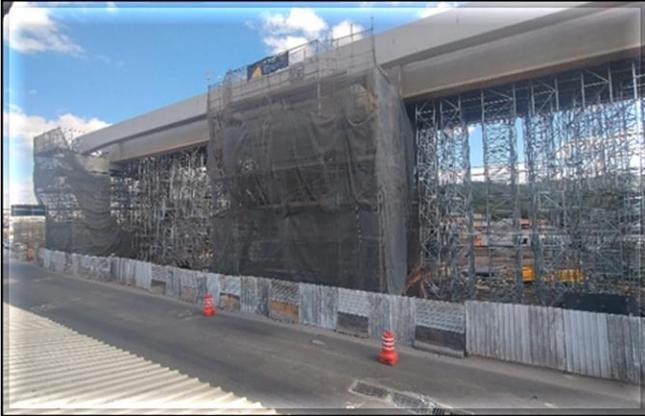
Obra Civil – execução da laje da plataforma, lançadas 6 de 10 vigas-guia da estação.
