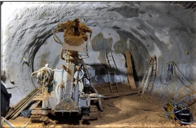
Túnel sul: Escavação da 12ª cambota concluída.
