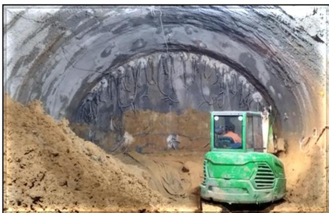
Túnel norte: Escavação da 27ª cambota concluída.
