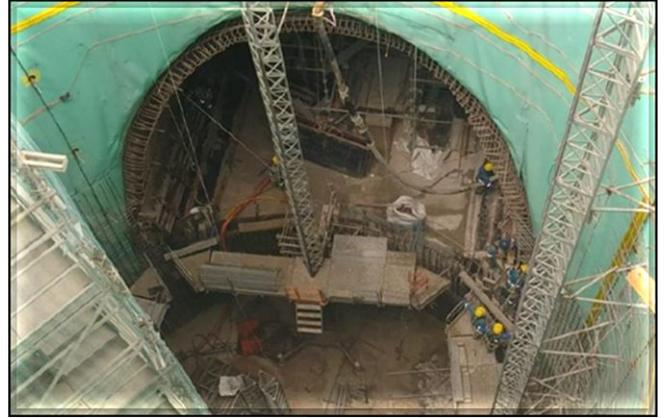
Revestimento secundário do Poço e do Túnel de ligação.
