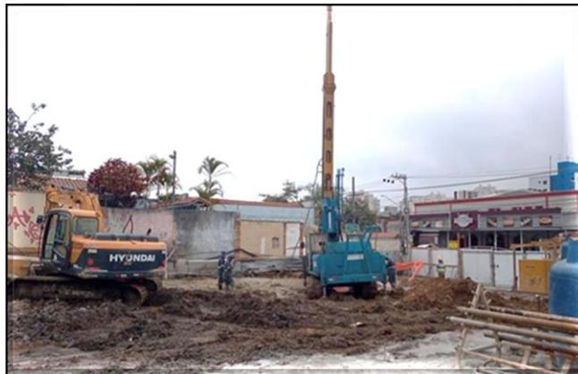
Jet grouting para escavação do Poço.
