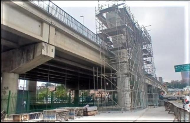
Obra Civil – execução do apoio para posterior lançamento das vigas-guia no sentido Trecho 3, após o Pátio Água Espraiada sentido Jabaquara.
