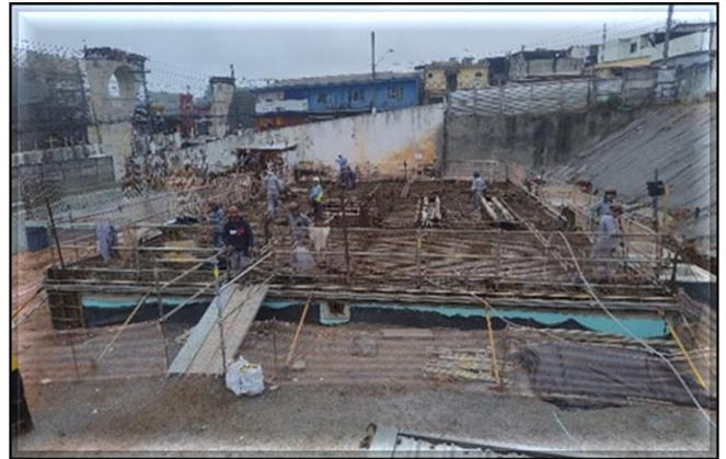
Obra Civil – armação e concretagem das lajes, paredes e pilares do Edifício Técnico Operacional.
