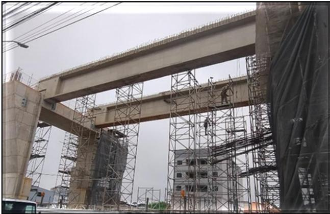
Obra Civil – lançadas vigas pré-moldadas do corpo da estação.
