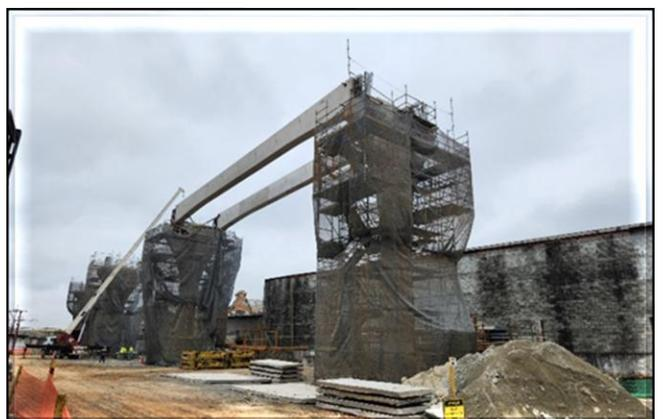
Obra Civil –lançada as duas primeiras vigas-guias do trecho.
