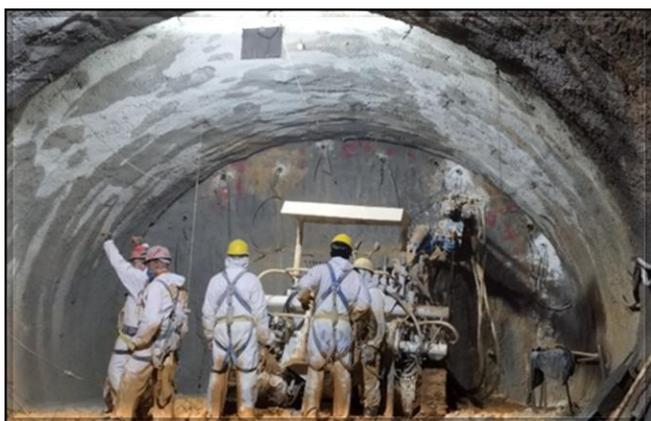
Túnel Norte: tratamento do maciço do túnel em execução, na região da 18ª cambota.
