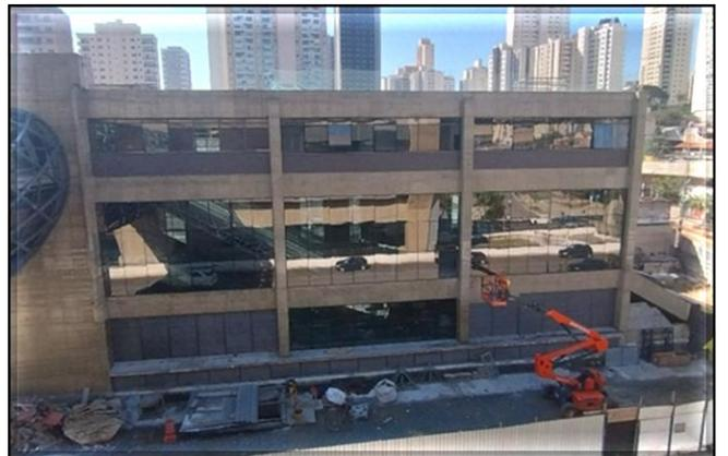
Obra Civil – instalação dos vidros do Acesso 1.
