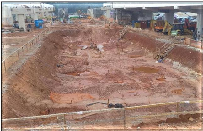
Obra Civil – execução das fundações dos blocos do Pátio.
