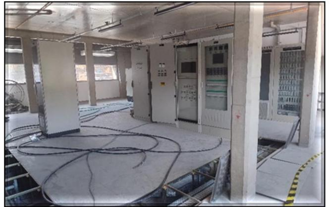
Sistemas – luminárias em instalação e lançamentos de cabos para Portas de Plataformas na Sala de Equipamentos Eletrônicos.
