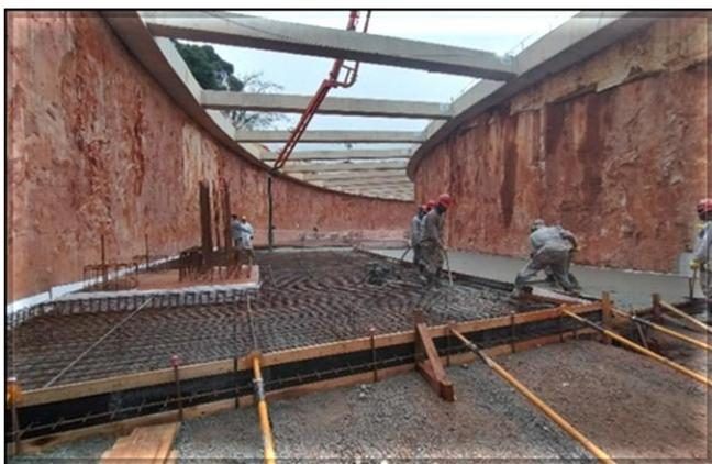
Obra Civil – armação e concretagem da laje da via na região da vala.
