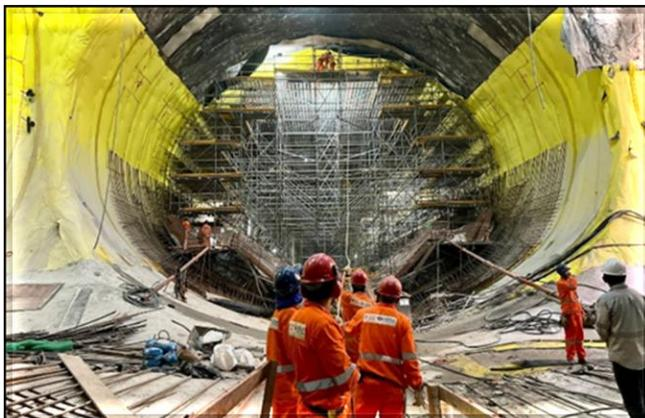
Impermeabilização, laje de fundo e revestimento secundário do túnel do corpo da estação.
