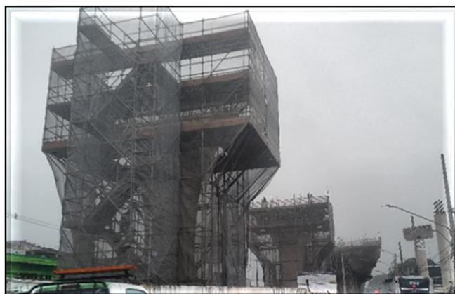
Obra Civil – execução dos capitéis da via e do track-switch de acesso ao Pátio.
