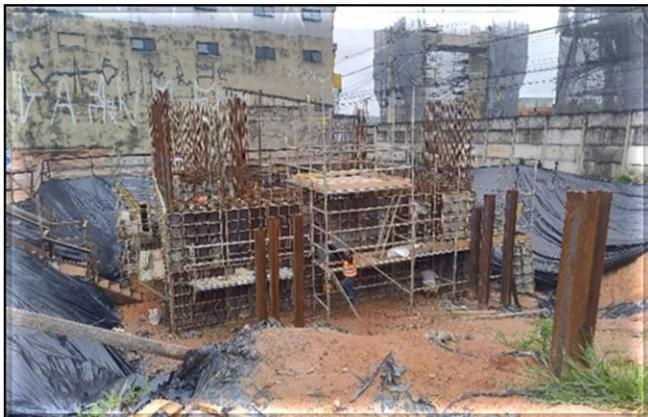
Obra Civil – armação e concretagem das paredes e pilares do Acesso Norte.
