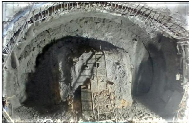
Túnel Norte: Escavação da 4ª cambota.
