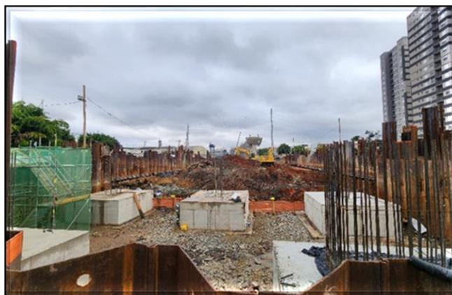
Obra Civil – execução dos blocos de fundação e escavação da vala do corpo da estação.
