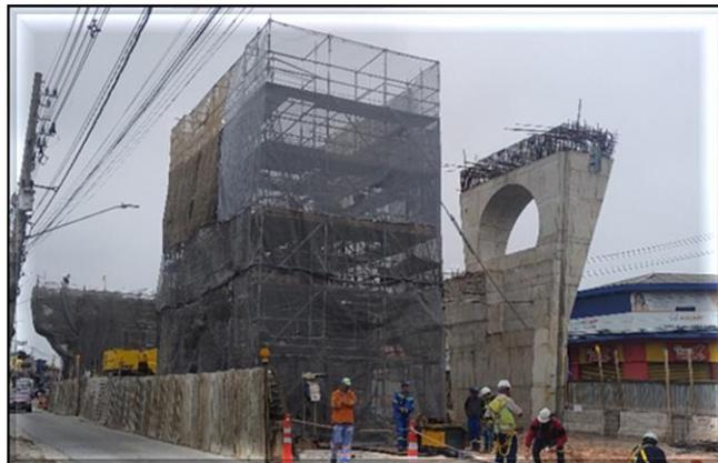
Obra Civil – execução dos pilares do corpo da estação.
