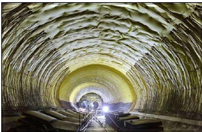
Laje de fundo, impermeabilização e revestimento secundário do túnel de via.
