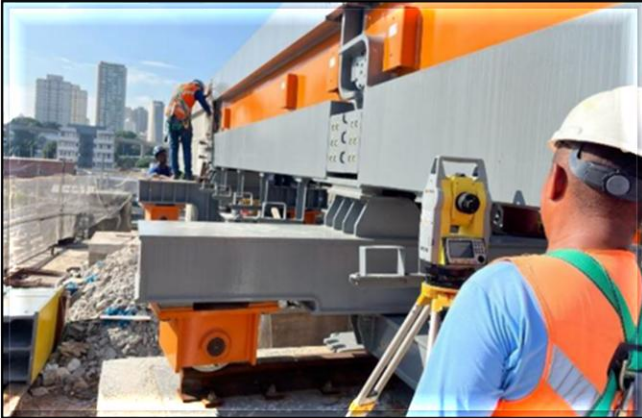
Sistemas – montagem mecânica do Track Switch X26.
