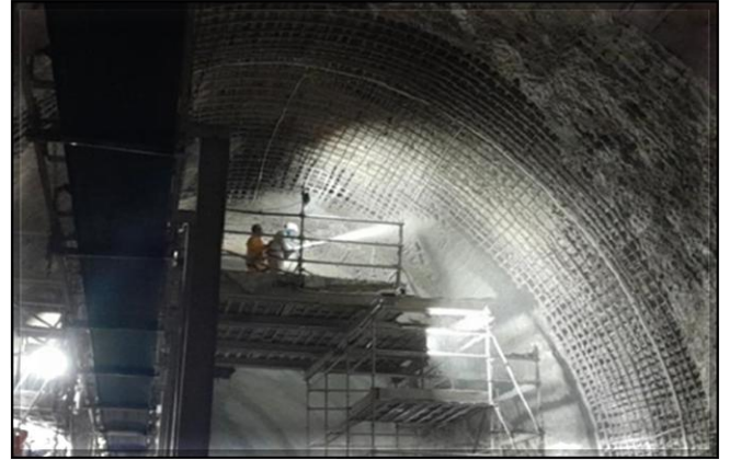
Revestimento secundário do túnel.
