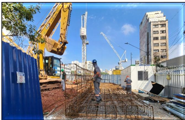
Rua Vergueiro (sentido centro): Em andamento a armação das lamelas e mobilização dos equipamentos para execução da parede diafragma
