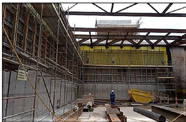
Revestimento secundário da interligação Linha 2/CPTM.
