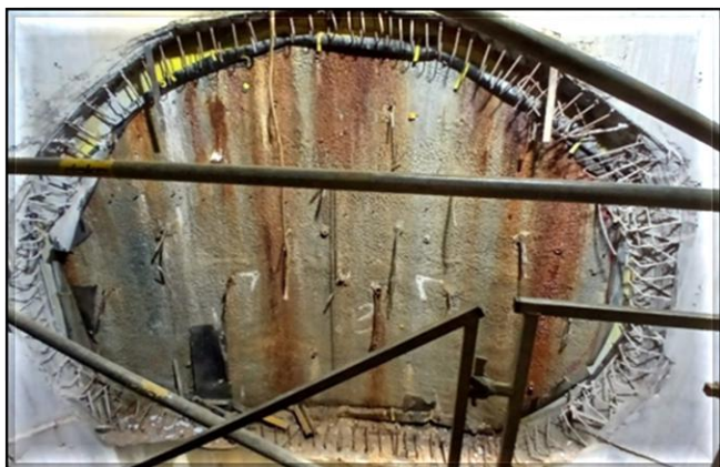
Poço principal: revestimento secundário parcial concluído e vista do emboque do Túnel Sul (sentido Estação Consolação).
