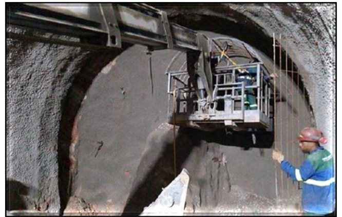
Escavação do túnel singular de estacionamento.
