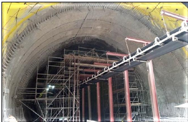
Impermeabilização do Túnel.
