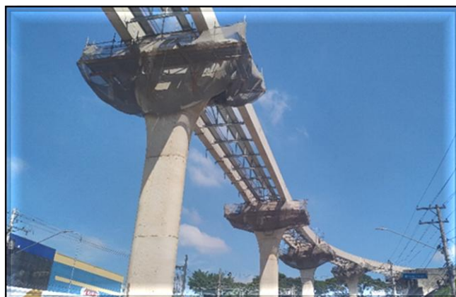
Obra Civil – execução da passarela de emergência da via elevada.
