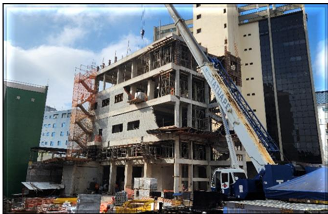
Novo Edifício Técnico Operacional (ETO): execução de alvenarias e acabamentos
