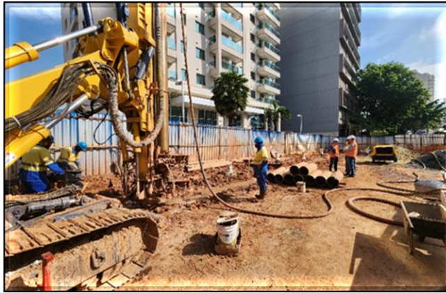
Avenida Liberdade (sentido bairro): execução dos poços de rebaixamento do lençol freático (PBS).
