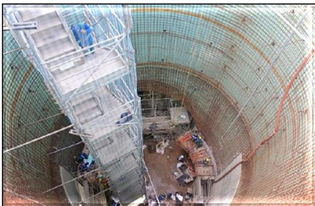
Revestimento secundário do poço.
