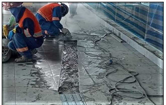
Obra Civil – instalação do piso tátil.
