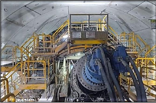
Vista do backup da tuneladora.
