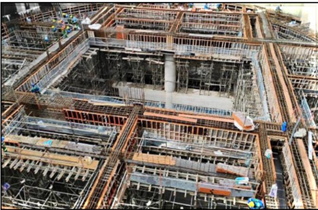
Estruturas de concreto do corpo da estação.
