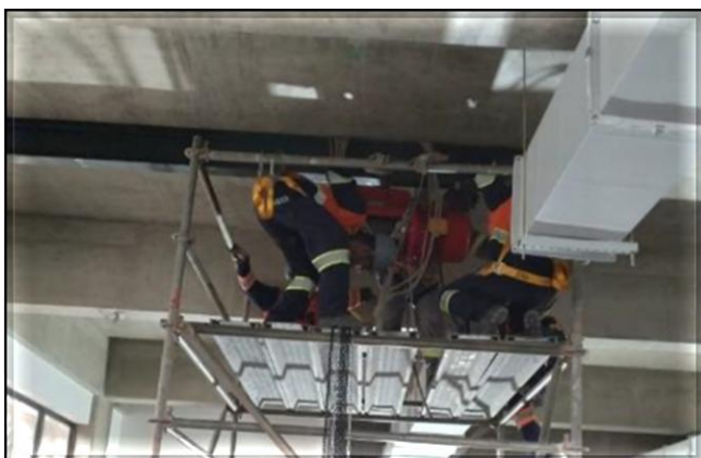
Sistemas – instalação dos Dutos de Ventilação.
