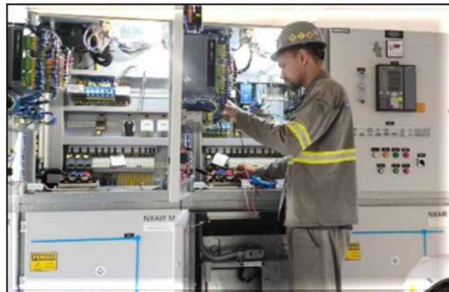
Sistemas – testes dos cubículos de Média Tensão.
