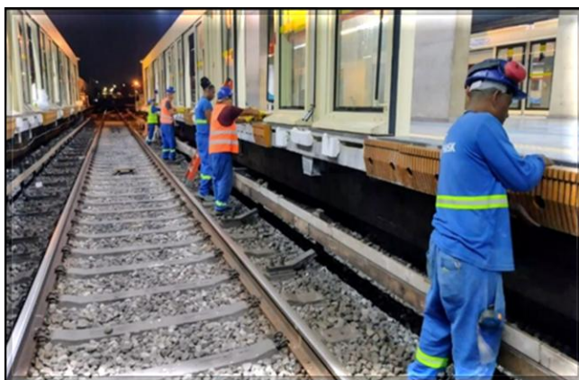
Fachadas e módulos das PSD's em instalação
