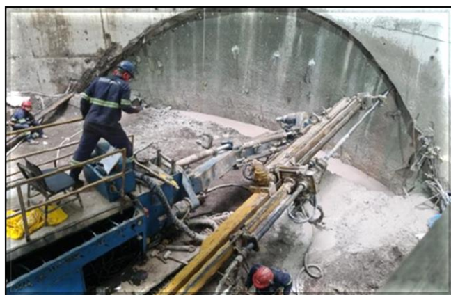
Tratamento para emboque dos túneis direcionais.
