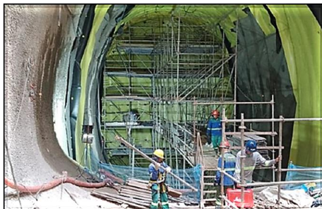
Impermeabilização e revestimento secundário do túnel de ligação.
