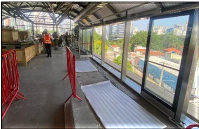
Sistemas — instalação mecânica das Portas de Plataforma.
