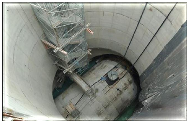
Vista superior do poço.
