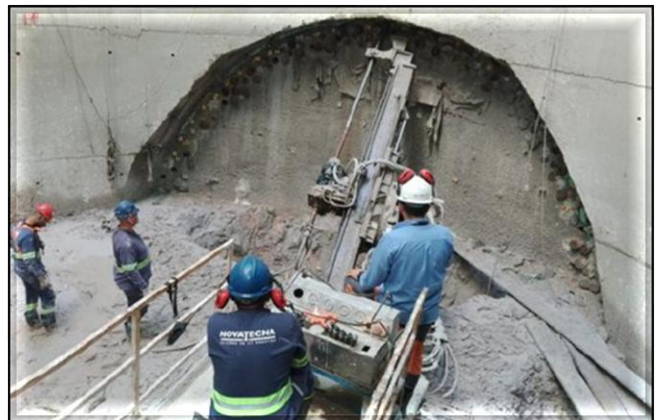
Tratamento para emboque do túnel de ligação.
