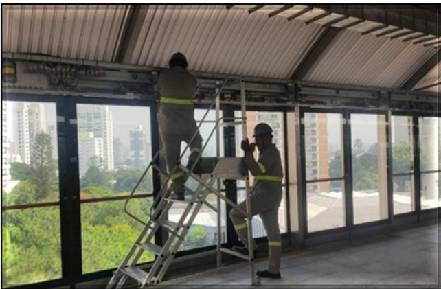
Sistemas – instalação das Portas de Plataformas (header boxes em montagem).
