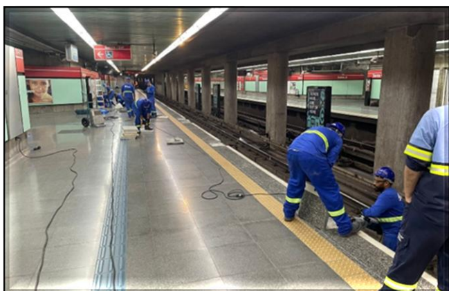
Adequação das estruturas das plataformas para receber a estrutura metálica das PSD's
