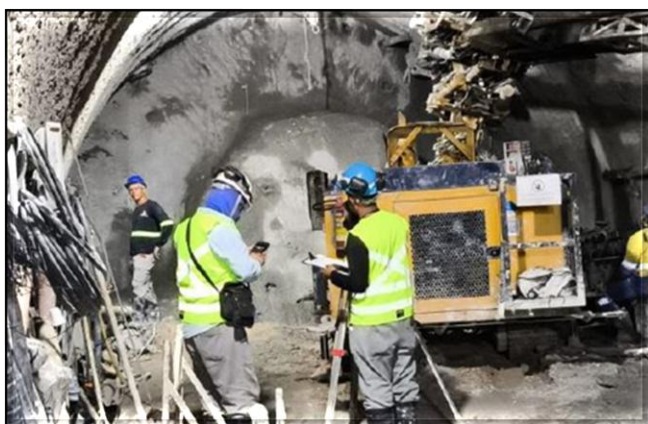
Escavação do túnel.
