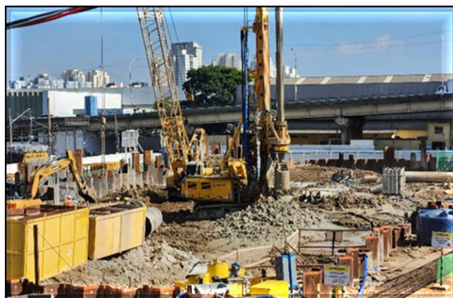
Obra Civil – execução das estacas de fundação do corpo da estação e escavação da vala.
