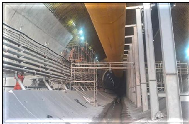
Revestimento secundário do túnel do corpo da estação
