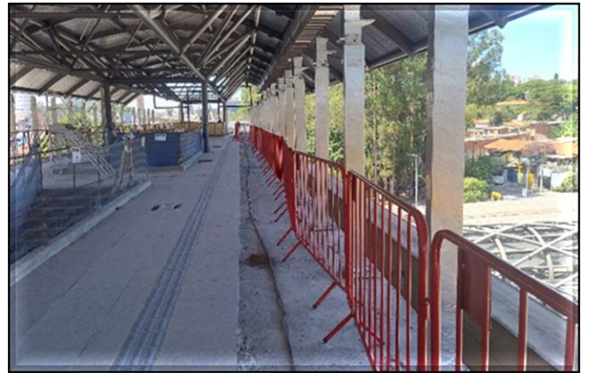
Sistemas – instalação das Portas de Plataformas.
