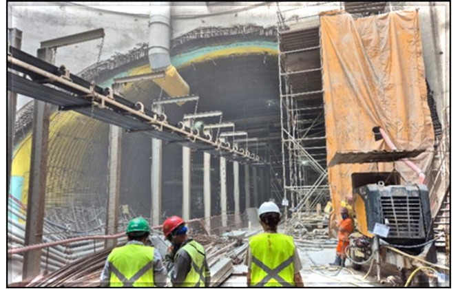
Revestimento secundário do túnel.
