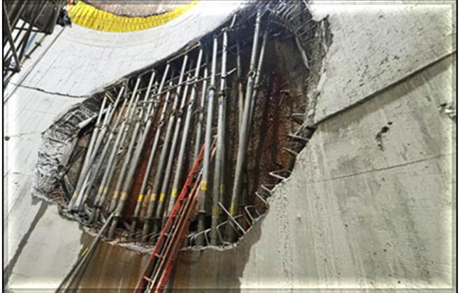
Poço principal: revestimento secundário parcial concluído e vista do emboque do túnel norte (sentido Estação Paulista).
