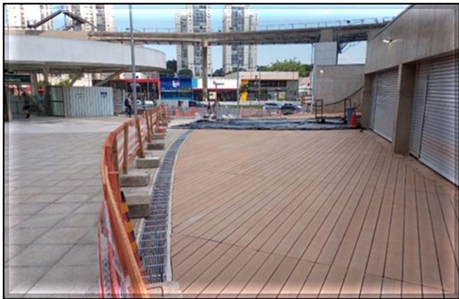
Área externa da estação Vila Prudente da Linha 2-Verde: Recomposição do viário e paisagismo.
