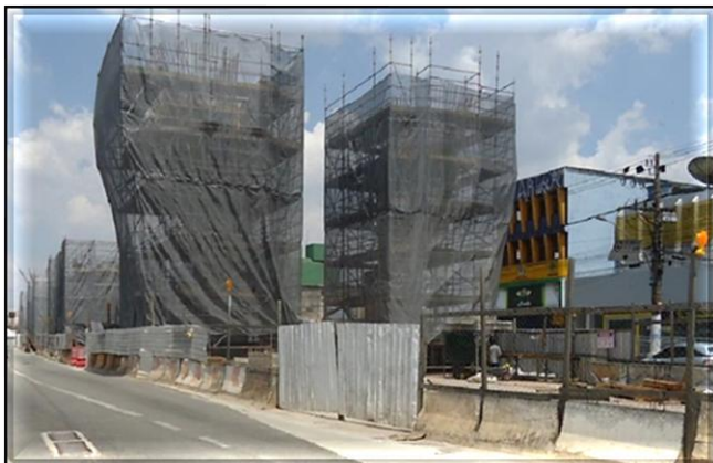
Obra Civil – armação e concretagem dos pilares do corpo da estação.
