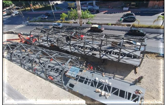
Obra Civil – montagem da passarela do Acesso 2.
