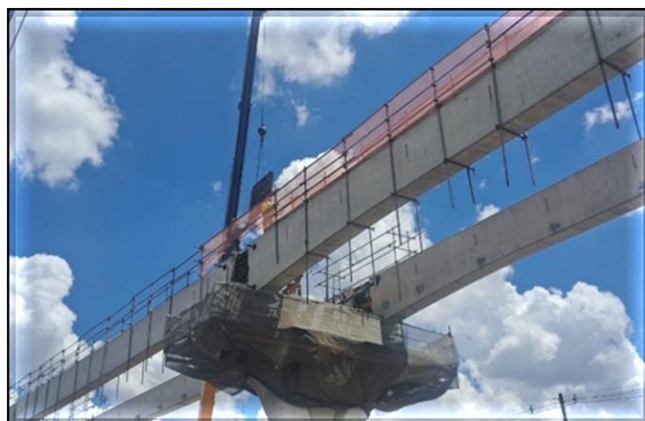
Obra Civil – execução da monolitização das vigas-guia da via elevada.
