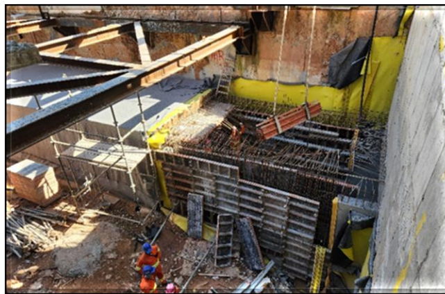
Galeria de Cabos: Em andamento a montagem de formas e armação das paredes laterais e laje de cobertura.
