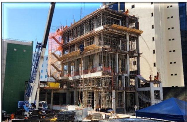
Novo Edifício Técnico Operacional (ETO): Montagem de armação e formas da laje de cobertura do ETO.
