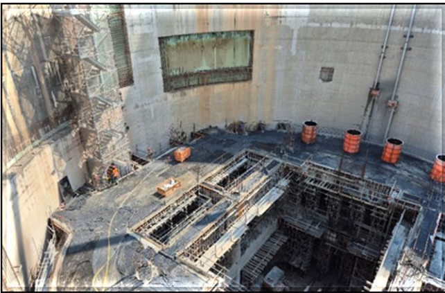
Estruturas de concreto do corpo da estação.
