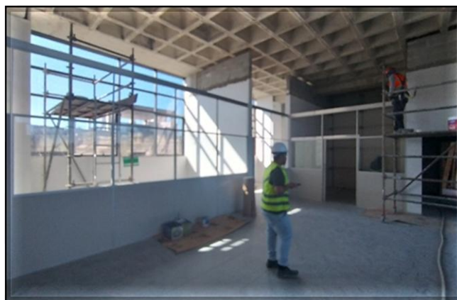
Obra Civil — execução do acabamento do Bloco B - CCO.
