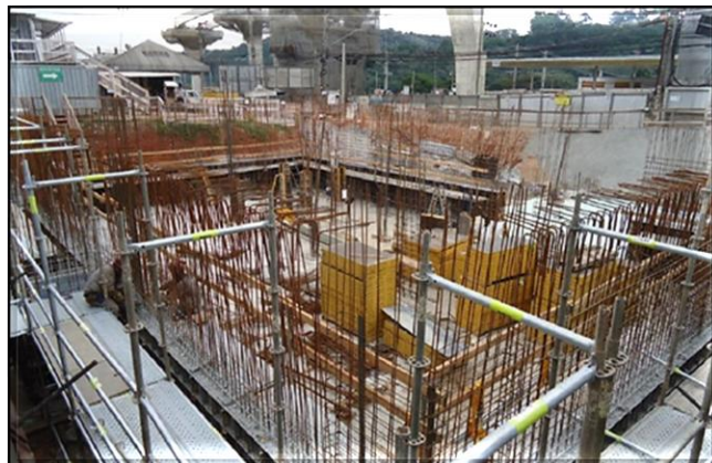
Obra Civil – armação e concretagem das estruturas do Edifício Técnico
