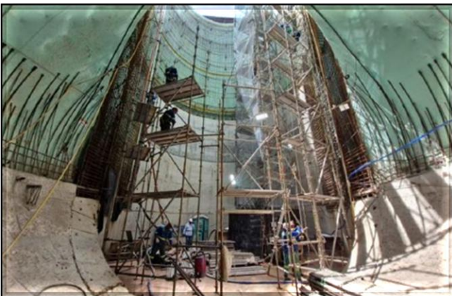
Revestimento secundário do poço.
