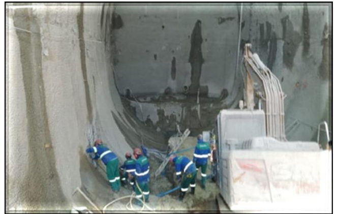
Escavação do túnel de ligação.
