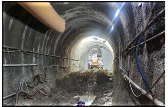
Escavação do túnel singelo de estacionamento.
