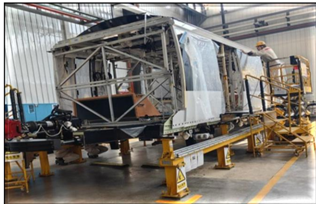
Montagem do décimo trem (S37) na fábrica na China.
