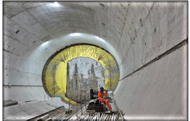
Revestimento secundário do túnel do corpo da estação.
