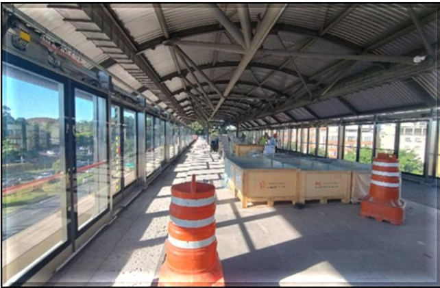
Sistemas – instalação das Portas de Plataformas.
