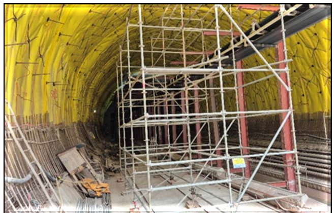
Impermeabilização do Túnel.
