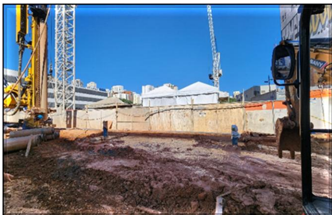
Rua Vergueiro (sentido bairro): Em execução os poços de rebaixamento do lençol freático (PBS).
