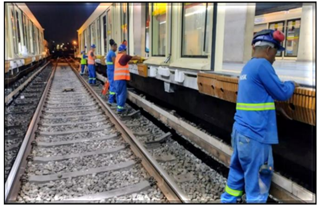
Fachadas e módulos das PSD's em instalação
