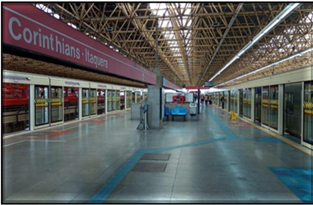
Fachadas das portas de plataforma | Instaladas 4/4 fachadas (em testes)
