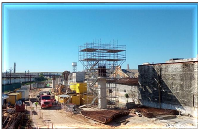
Obra Civil – armação, forma e concretagem dos pilares e capitéis da via elevada.
