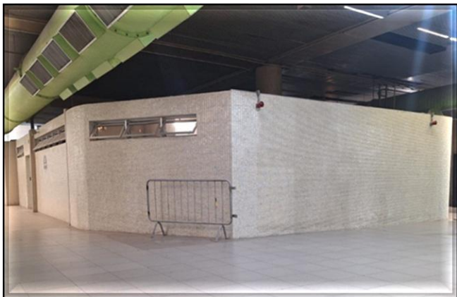
Linha 2-Verde - Novas Salas Operacionais: Concluídas as adequações em 11/02/2025.
