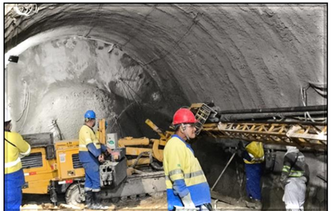
Escavação do túnel.
