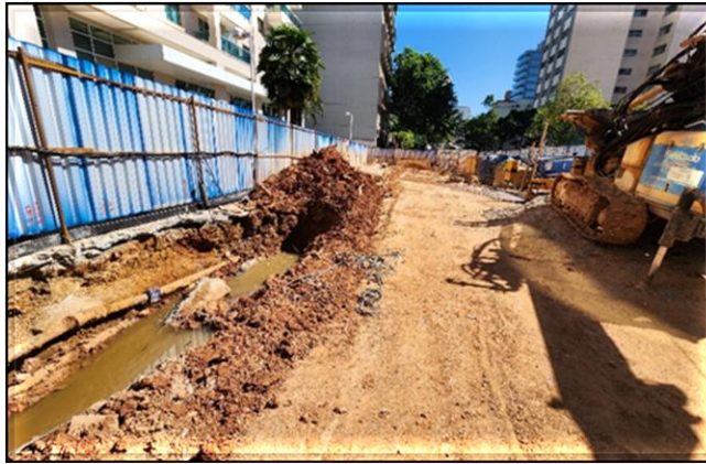
Avenida Liberdade (sentido bairro): execução das estacas raízes e remanejamento de interferências.
