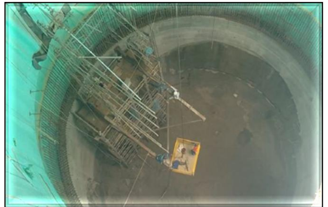
Montagem da escada de acesso.
