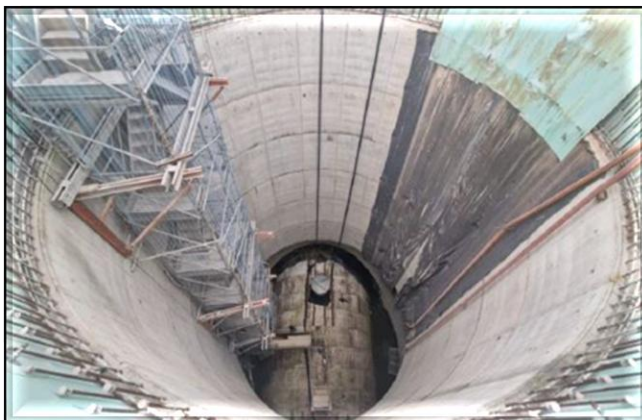
Vista superior do poço.
