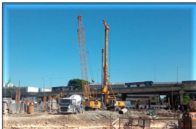
Obra Civil – execução das estacas de fundação do corpo da estação.
