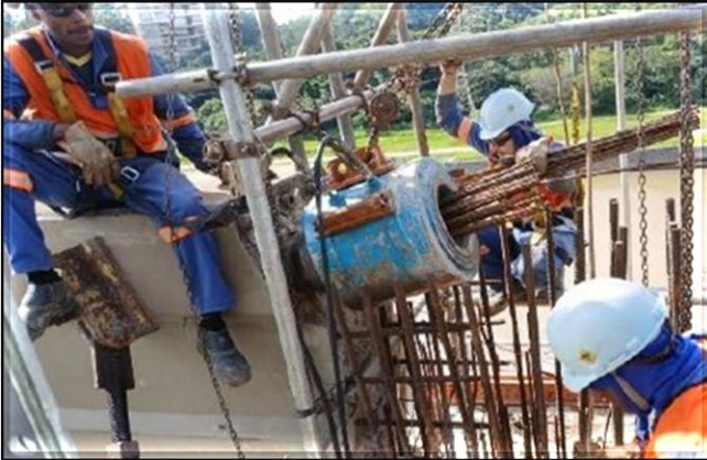
Civil – protensão do apoio da via do Lote 07.
