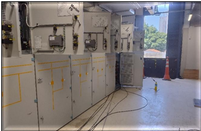
Sistemas – instalação dos sistemas nas Salas Técnicas.
