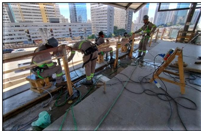
Obra Civil — execução das furações para instalação das Portas de Plataforma
