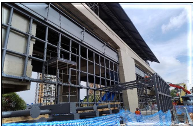
Obra Civil – instalação da estrutura metálica do corpo da estação e Acesso.
