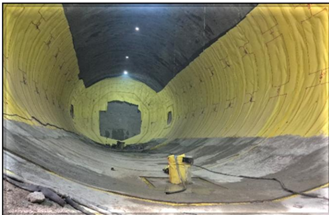
Proteção mecânica para execução do berço de arraste no túnel do corpo da estação.
