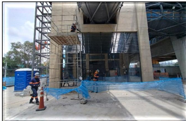
Obra Civil – instalação dos vidros do Acesso.
