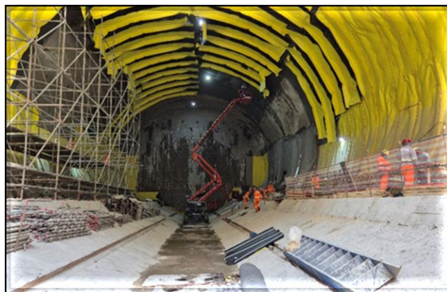
Impermeabilização do túnel do corpo da estação.
