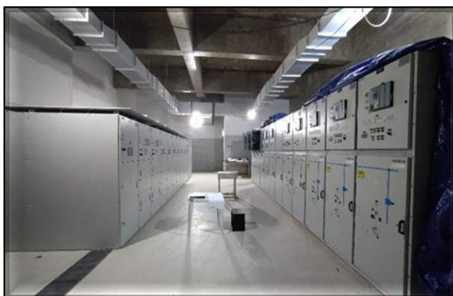
Sistemas – instalação dos cubículos de média tensão e de tração nas salas técnicas.
