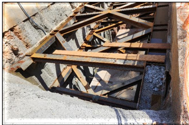
Galeria de Cabos: parcialmente concretada.
