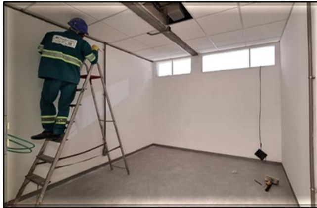
Linha 2-Verde - Novas Salas Operacionais: em andamento atividades de pintura, forros e arremates.
