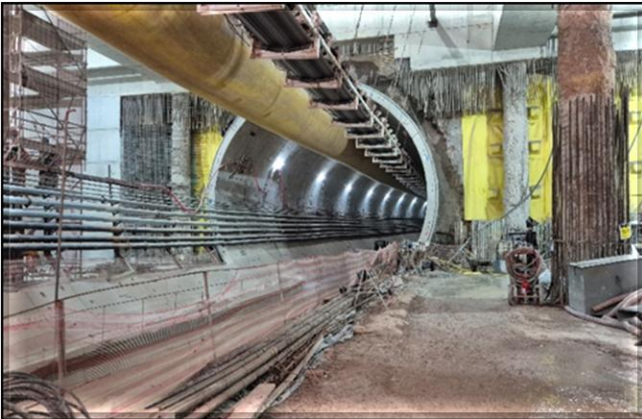
Vista da esteira transportadora de solo na estação Anália Franco.
