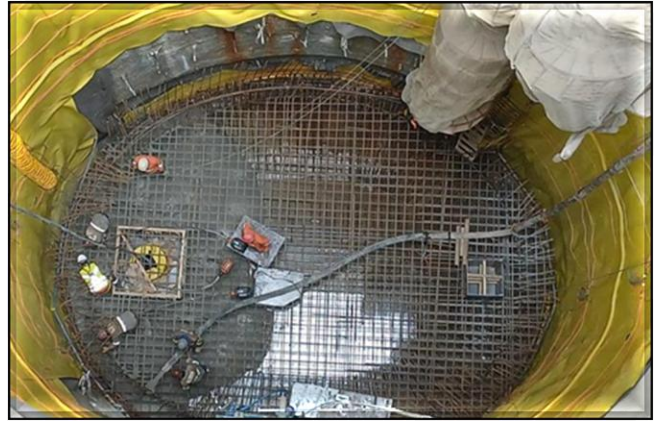
Poço principal: laje de fundo em concretagem em 14/11/2024.
