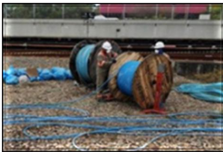
Lançamento de cabos do CBTC
