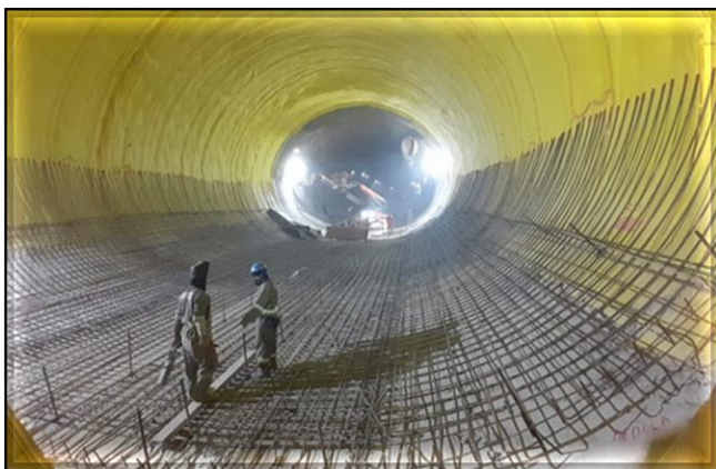
Armação do invert e impermeabilização do túnel de via.
