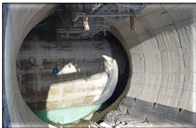
Vista do Poço.
