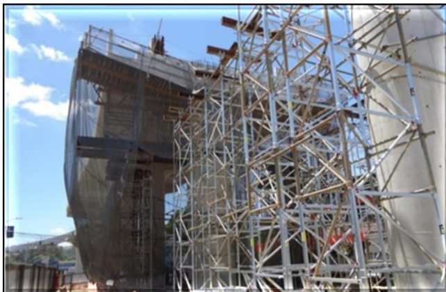
Obra Civil – montagem de cimbramento para execução de deck switch .
