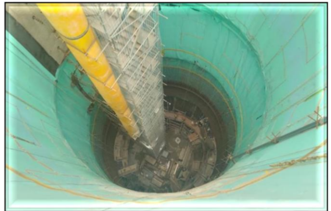
Revestimento secundário do Poço.
