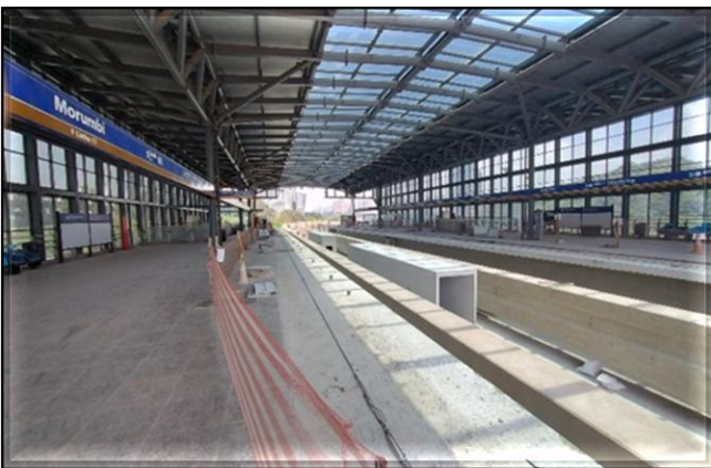
Sistemas – montagem mecânica das portas de plataforma (furações).
