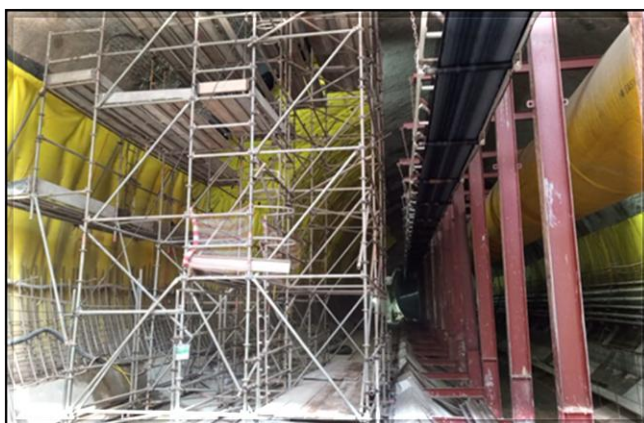
Impermeabilização do túnel de transição.
