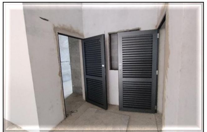
Obra Civil – em andamento a instalação das portas do Bloco B.
