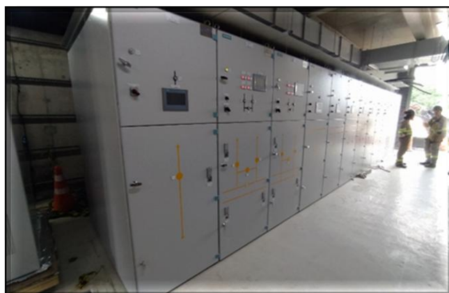
Sistemas – cubículos de tração em fase de testes.
