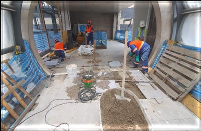
Obra Civil – execução do piso de granitos dos Acessos.
