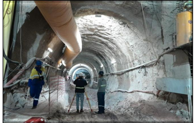
Escavação do túnel singelo.
