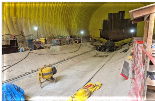
Impermeabilização do túnel do corpo da estação..
