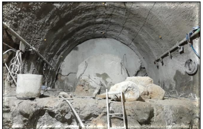
Escavação do túnel.
