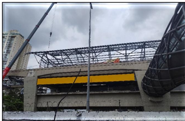
Obra Civil – em andamento a instalação da estrutura metálica da cobertura da plataforma.
