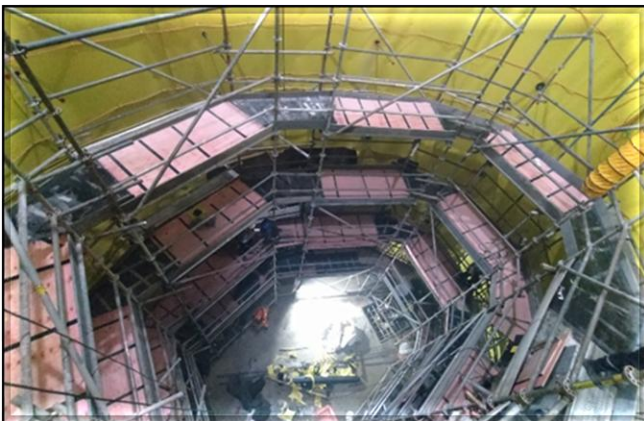
Poço principal: ajustes na manta de impermeabilização em execução.
