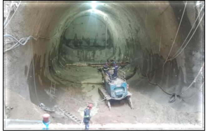
Escavação do túnel de ligação.
