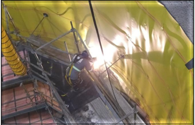
Poço principal: execução dos trumpets (suportes) para fixação da armação vertical do revestimento secundário.
