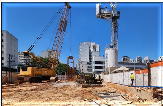
Rua Vergueiro (sentido bairro): execução das lamelas da parede diafragma.
