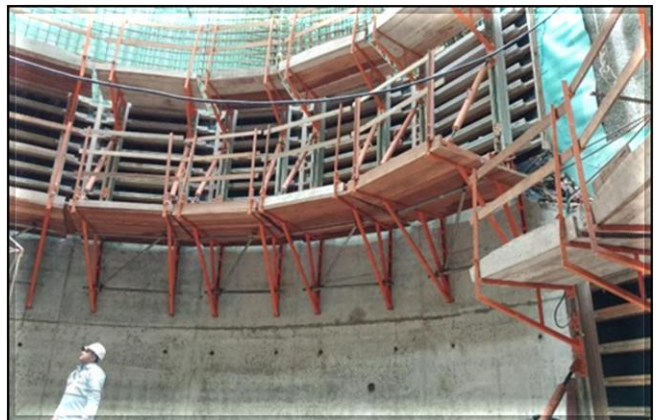
Revestimento secundário do Poço.
