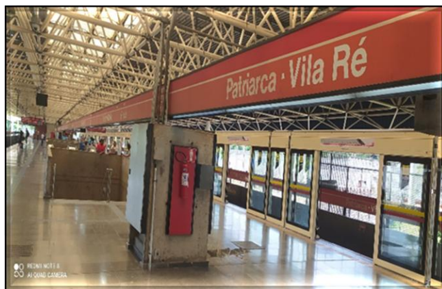
Fachadas das portas de plataforma | Em operação
