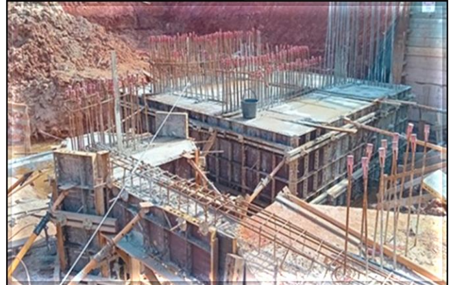
Obra Civil – armação e concretagem dos blocos do edifício técnico.
