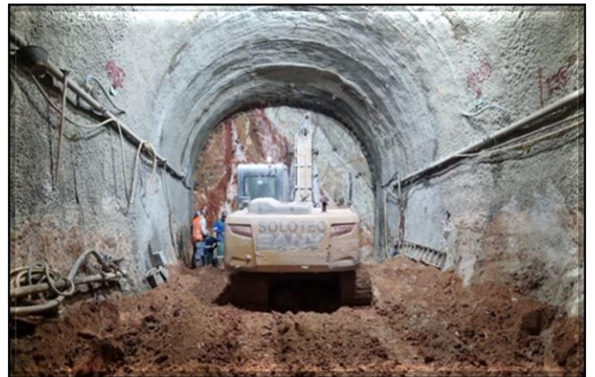
Escavação do túnel singelo.
