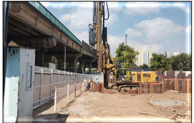
Obra Civil – cravação das estacas prancha do corpo da estação.
