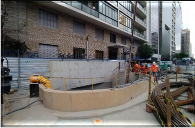
Vista do canteiro na região do poço principal
