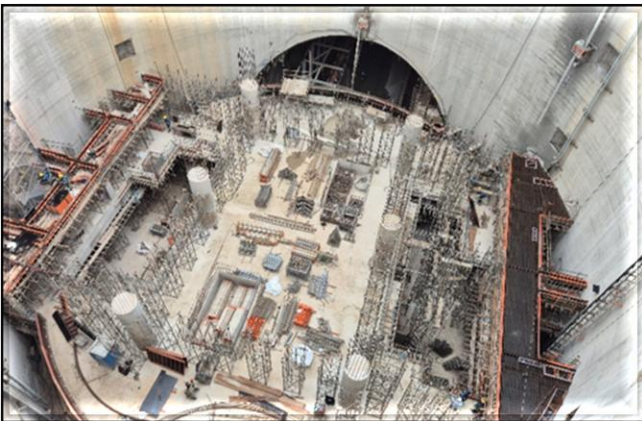
Estruturas de concreto do corpo da estação.
