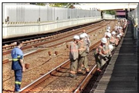
Lançamento de cabos do CBTC
