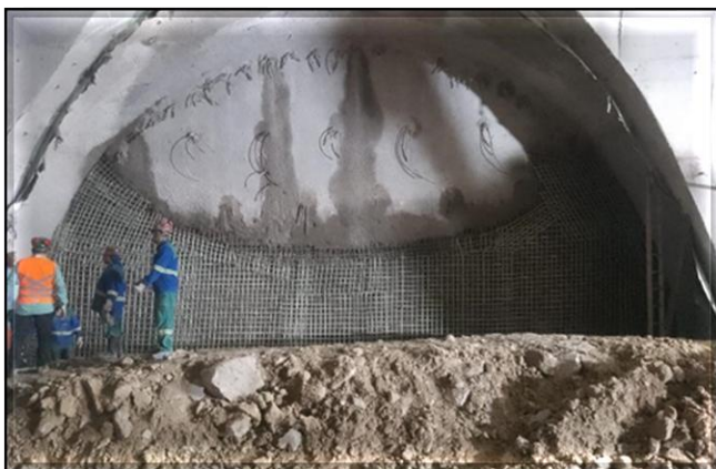
Escavação dos túneis direcionais para a tuneladora.
