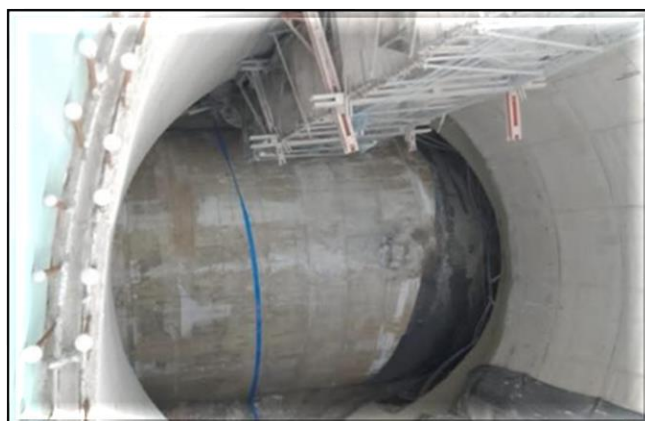
Passagem da tuneladora.
