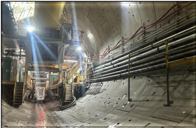
Vista das utilidades da tuneladora.
