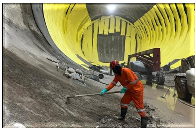
Impermeabilização dos túneis do corpo da estação.
