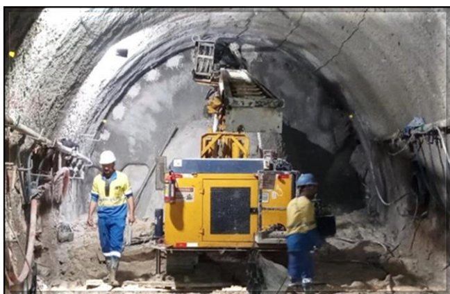
Escavação do túnel.
