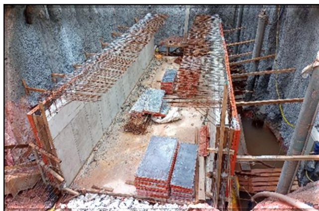
Galeria de Cabos: concretada laje de fundo e paredes da galeria.
