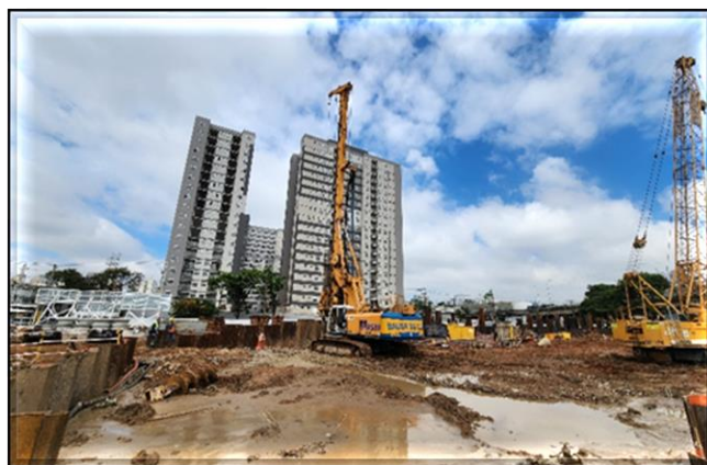
Obra Civil – execução das fundações do corpo da estação.
