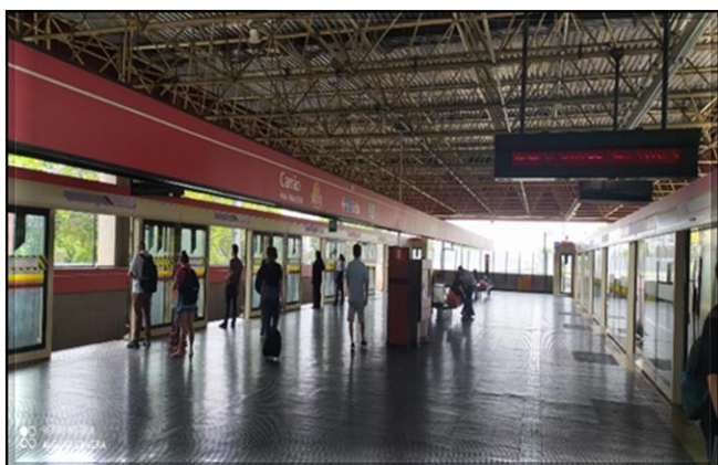
Fachadas das portas de plataforma | Em operação
