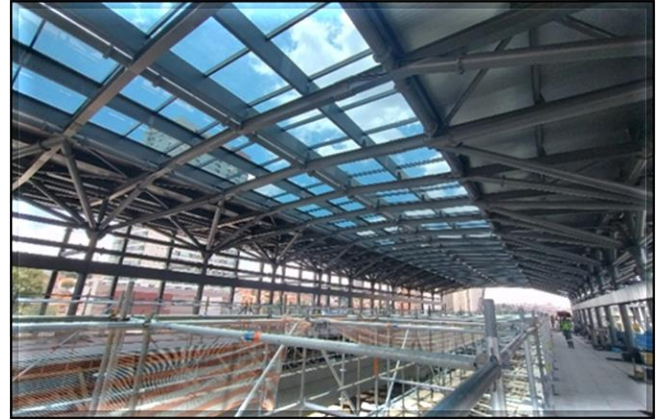
Obra Civil – concluída a instalação dos vidros da cobertura.
