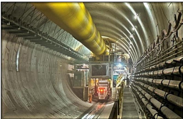
Vista do backup da tuneladora.
