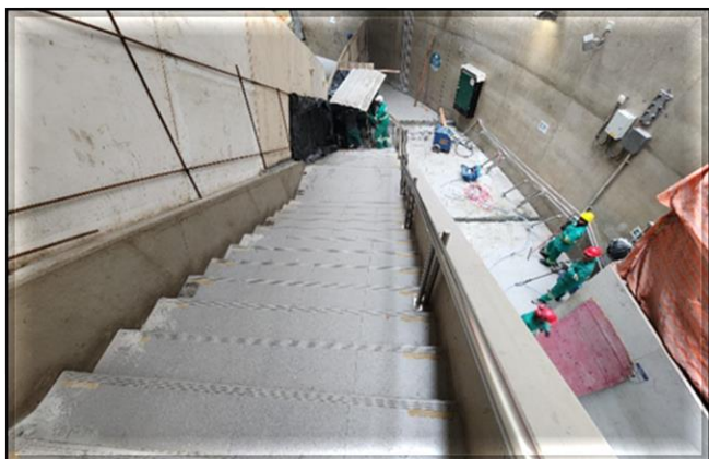
Linha 2-Verde - Plataforma 2 – lado leste – preparação do local para implantação da nova escada rolante.
