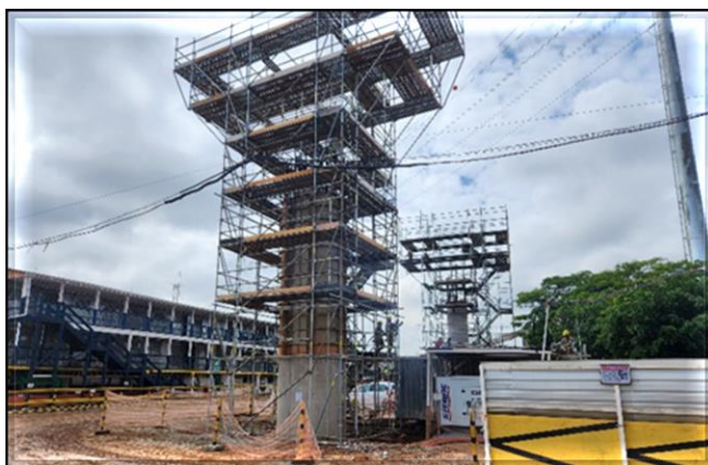
Obra Civil – armação e concretagem dos pilares da via elevada.
