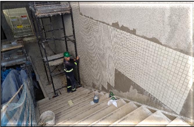
Obra Civil – assentamento de pastilhas no Acesso 1.
