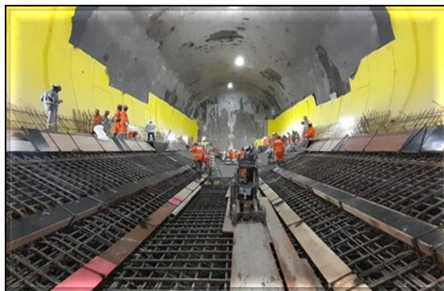
Laje de fundo e impermeabilização do túnel do corpo da estação.
