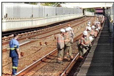
Lançamento de cabos do CBTC
