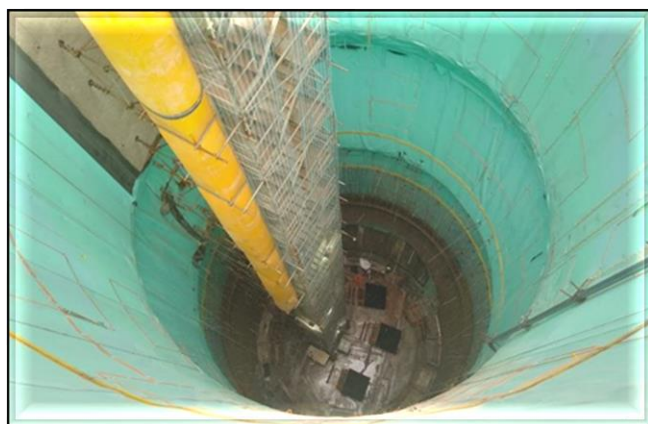
Revestimento secundário do Poço.
