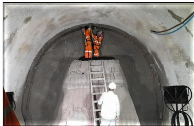
Escavação do túnel singelo.
