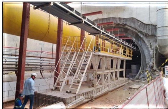
Vista correia transportadora de solo da tuneladora.
