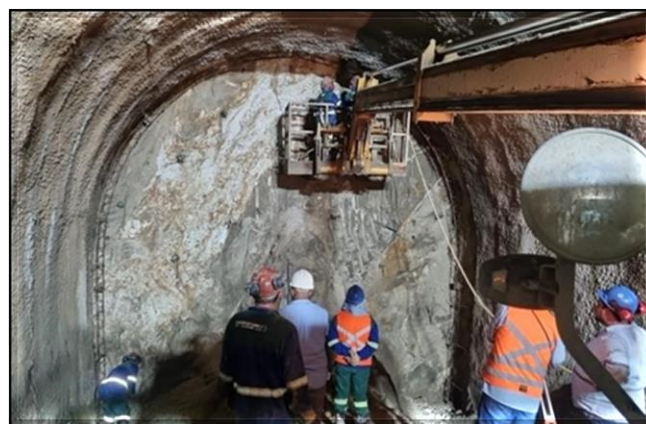
Escavação do túnel singelo.
