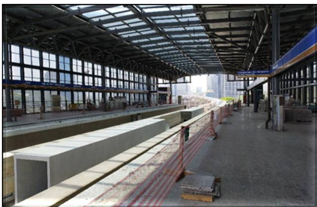
Sistemas – montagem mecânica das portas de plataforma (furações).
