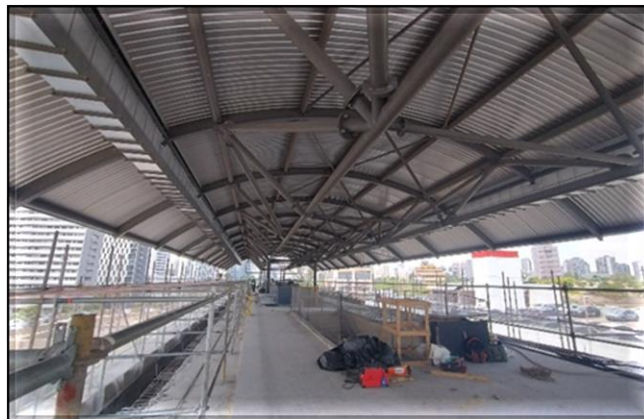
Obra Civil – concluída a instalação da cobertura da plataforma.
