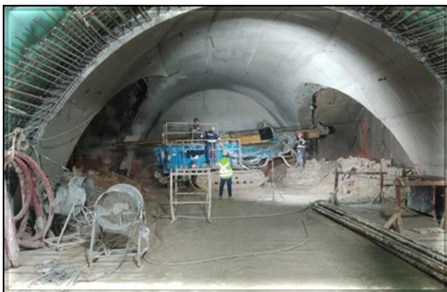
Escavação dos túneis direcionais para a tuneladora.
