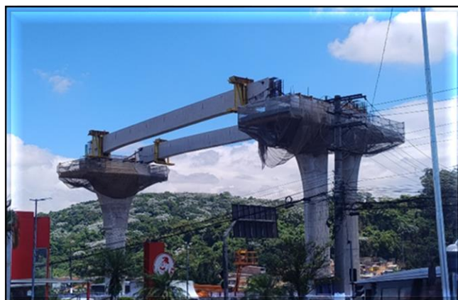
Obra Civil – vigas-guia lançadas no trecho entre a estação Boa Esperança e a estação Jacu Pêssego.
