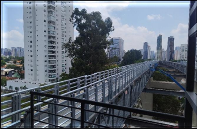
Vias do Monotrilho/Civil – instalação dos guarda-corpos na passarela de emergência entre as estações Campo Belo e Vila Cordeiro.
