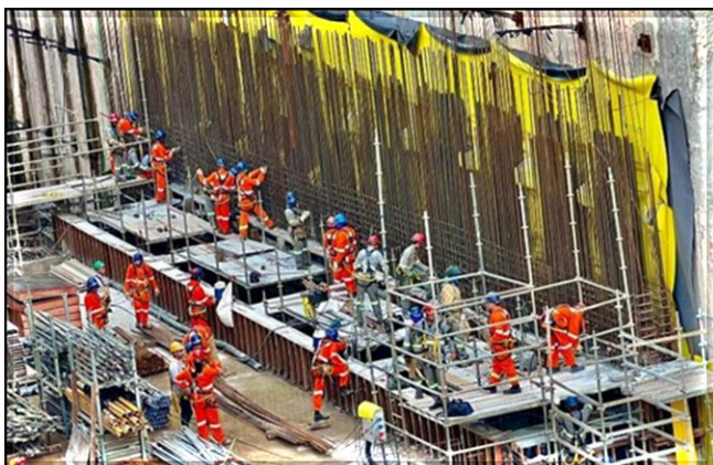
Revestimento secundário e estruturas de concreto do corpo da estação.
