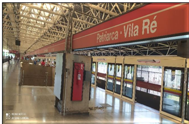
Fachadas das portas de plataforma | Em operação
