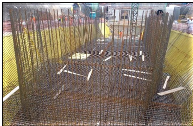
Laje de fundo e impermeabilização do túnel do corpo da estação.
