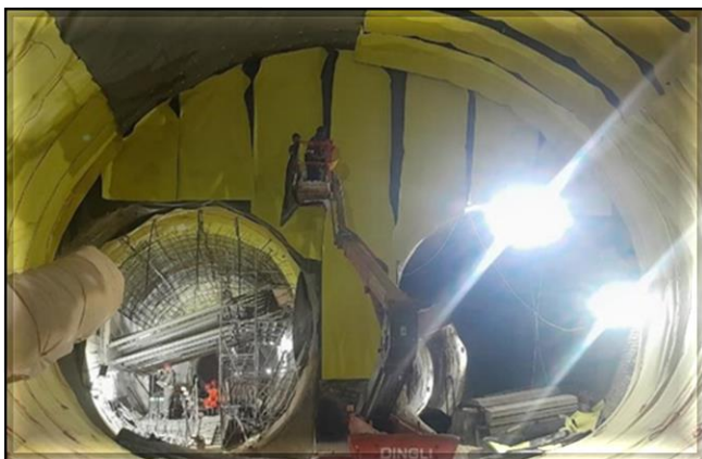
Impermeabilização do túnel de via.
