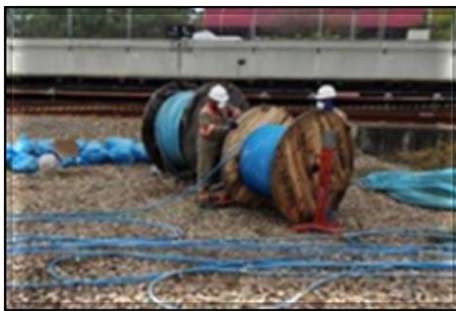
Lançamento de cabos do CBTC
