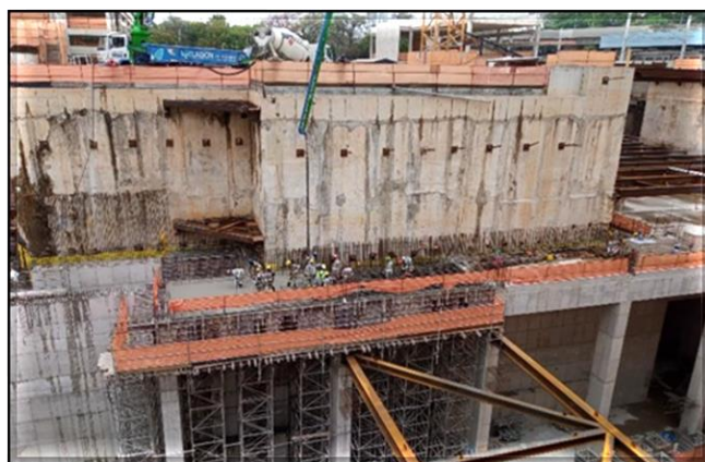
Estruturas de concreto do corpo da estação do Metrô.
