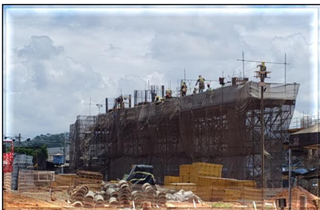
Obra Civil – execução das vigas travessas das vias de estacionamento.
