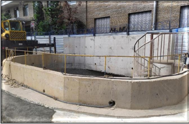
Vista do poço principal.
