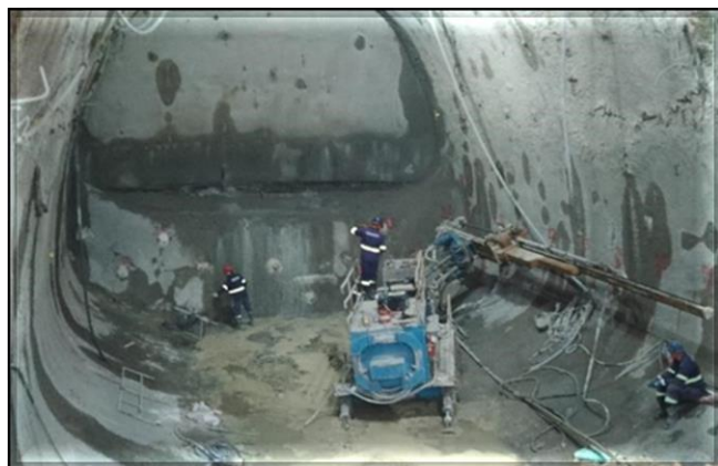
Escavação do túnel de ligação.
