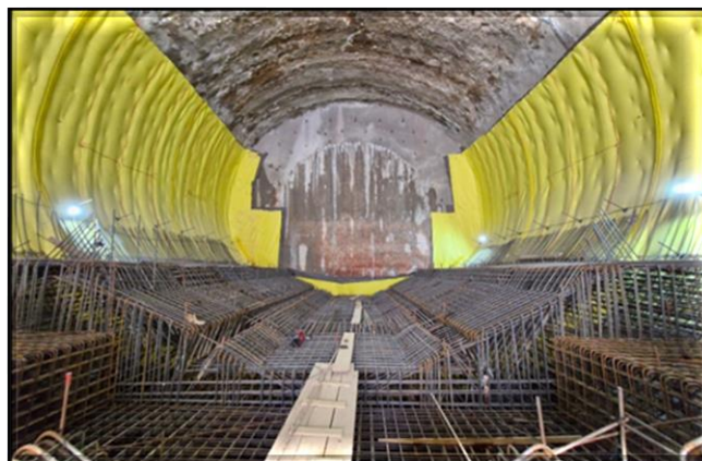
Laje de fundo do túnel do corpo da estação
