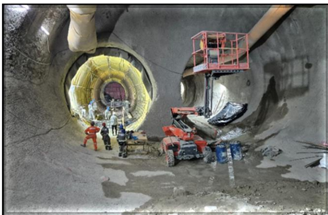
Escavação e impermeabilização do túnel de via.
