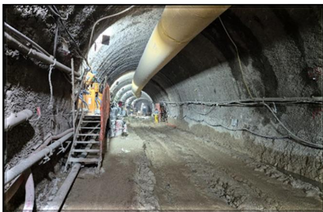
Escavação do túnel.
