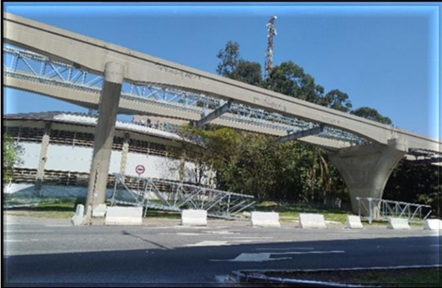
Vias do Monotrilho/Civil – instalação da passarela de emergência no trecho Chucri Zaidan - Morumbi.
