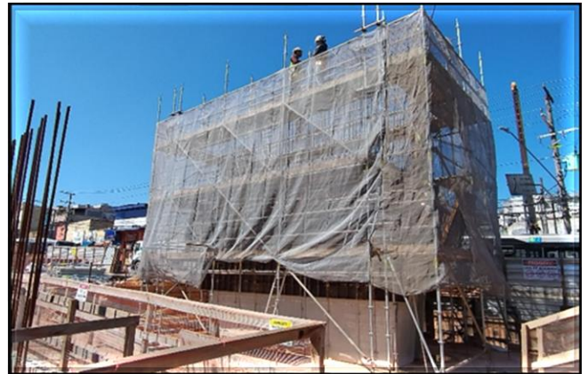
Obra Civil – execução os pilares do corpo da estação.
