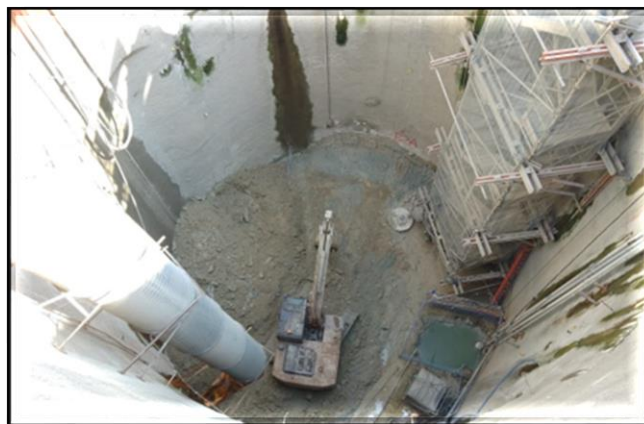
Remoção do aterro.
