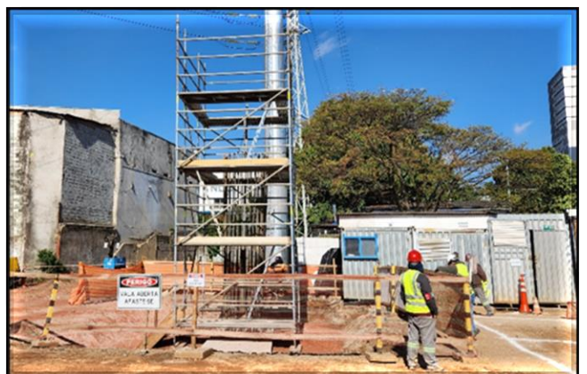
Obra Civil – montagem de andaime para execução do pilar da via elevada.
