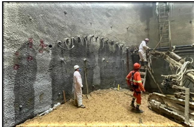
Tratamento do emboque do túnel sul: enfilagens concluídas.
