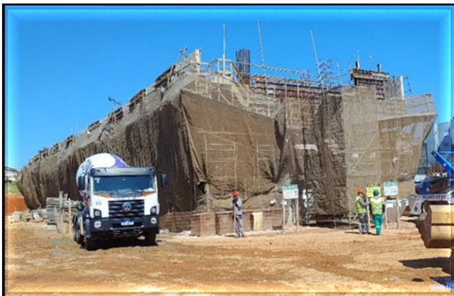
Obra Civil – concretagem da laje do track switch.
