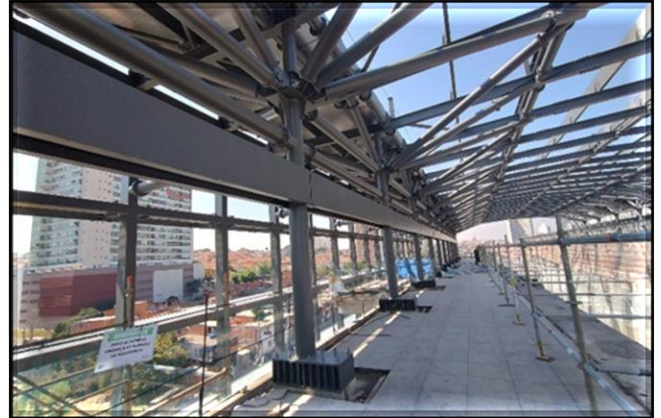
Obra Civil – em andamento a instalação das telhas da cobertura
