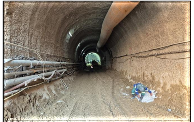
Escavação do túnel singelo.
