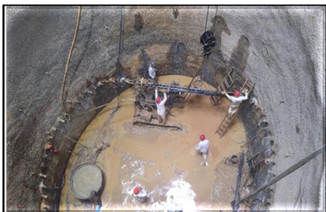
Tratamento do emboque do túnel norte: enfilagens em execução.
