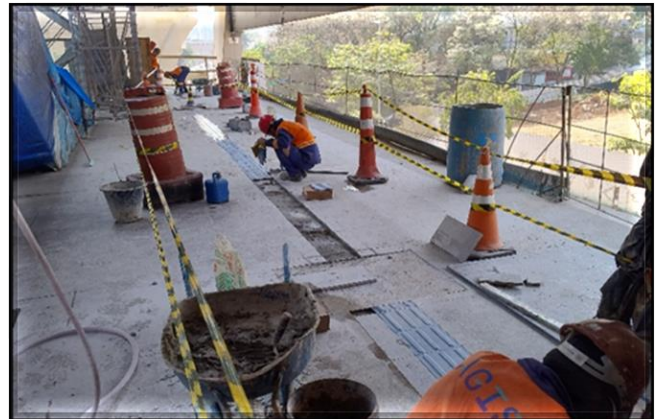
Obra Civil – em andamento a instalação do piso tátil no mezanino.
