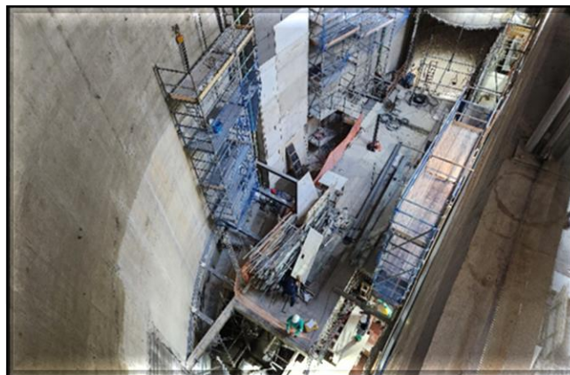
Linha 2-Verde - Plataforma 2 – lado oeste – preparação do local para implantação das novas escadas.
