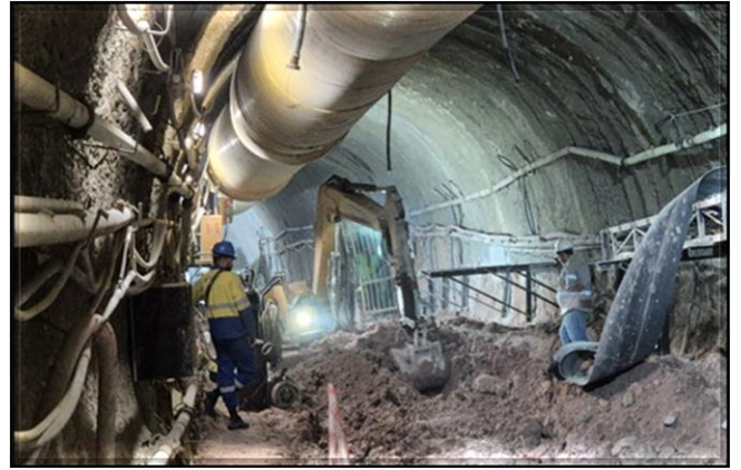
Escavação do túnel singelo.
