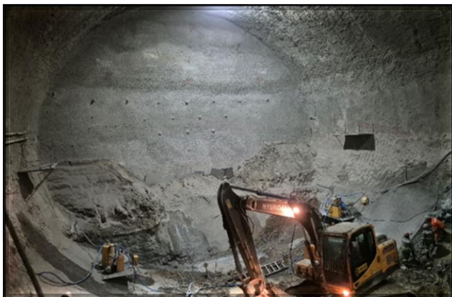
Escavação dos túneis do corpo da estação.
