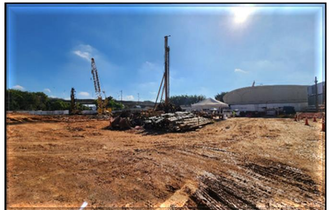
Obra Civil – execução das fundações do corpo da estação.
