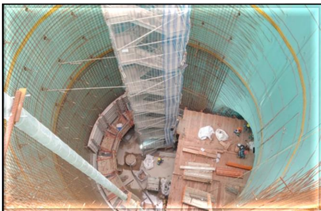
Revestimento secundário do túnel de ligação.
