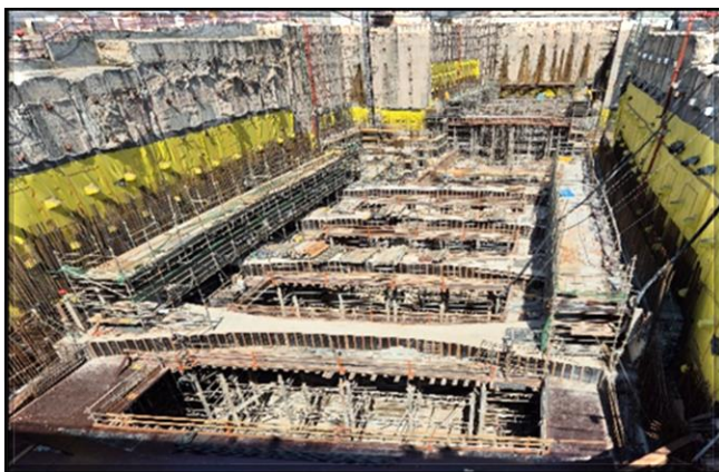
Revestimento secundário e estruturas de concreto do corpo da estação.
