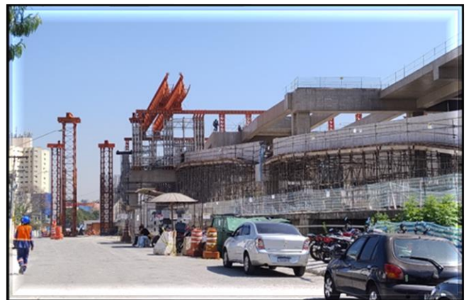
Obra Civil – execução das vias e montagem da treliça lançadeira de vigas-guia.
