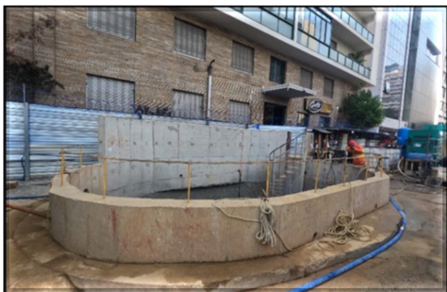
Canteiro de Obras: vista do poço principal.
