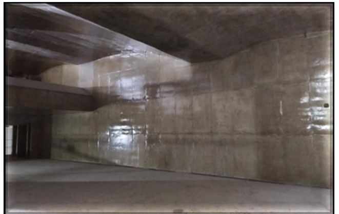
Obra Civil – em andamento o tratamento do concreto do túnel de interligação.
