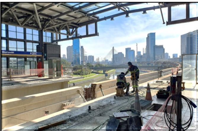
Sistemas – montagem mecânica das portas de plataforma em execução.
