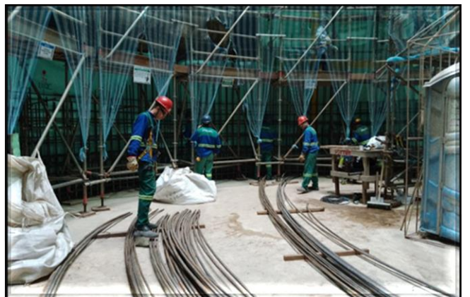
Revestimento secundário do Poço.
