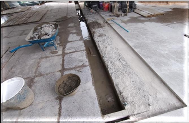
Obra Civil – em andamento a instalação das telhas da cobertura da plataforma.
