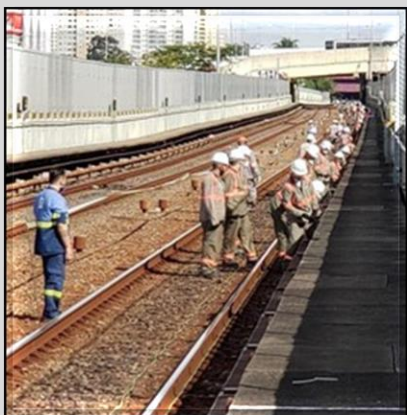
Lançamento de cabos do CBTC
