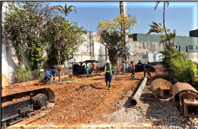
Estacas do muro de contenção para as salas técnicas.
