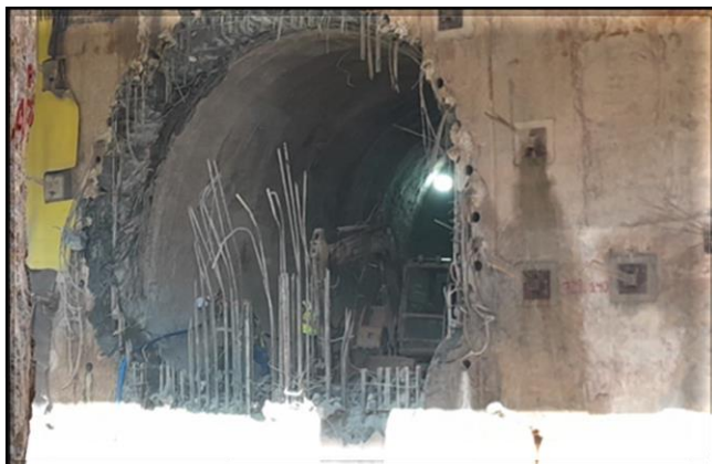
Vista do túnel singelo de terceira via.
