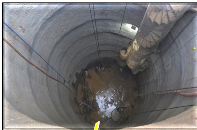
Local do poço de escavação do túnel: escavação e revestimento primário, 25,20m de 31,50m escavados
