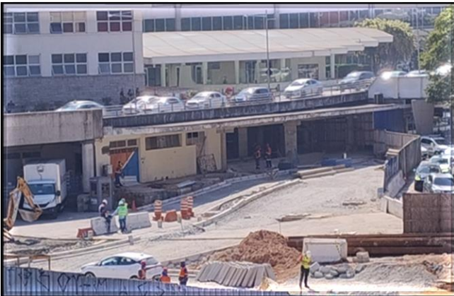
Obra Civil – execução das atividades de pavimentação no acesso junto ao aeroporto
