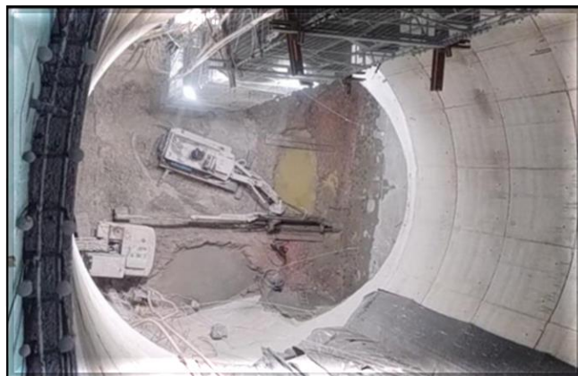
Tratamento para a Tuneladora.
