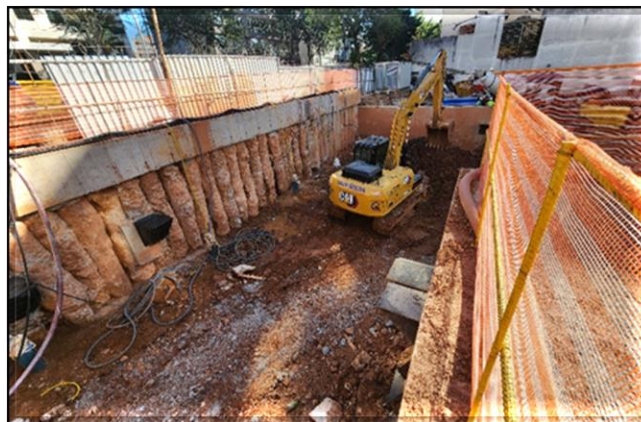
Galeria de Cabos: escavação e montagem do estorcamento da vala.
