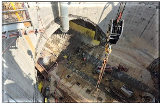
Laje de fundo do túnel de transição.
