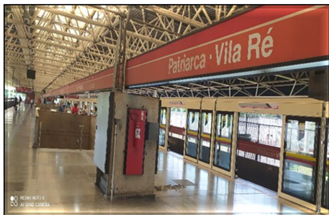
Fachadas das portas de plataforma | Instaladas 2/2 fachadas (em testes)
