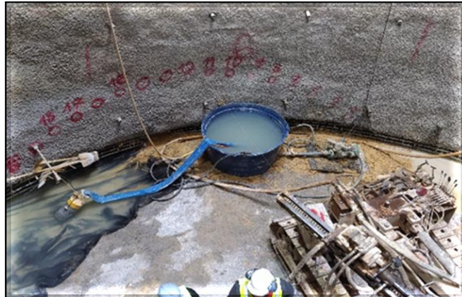
Tratamento do emboque do túnel sul: marcação da preparação das enfilagens no poço principal.
