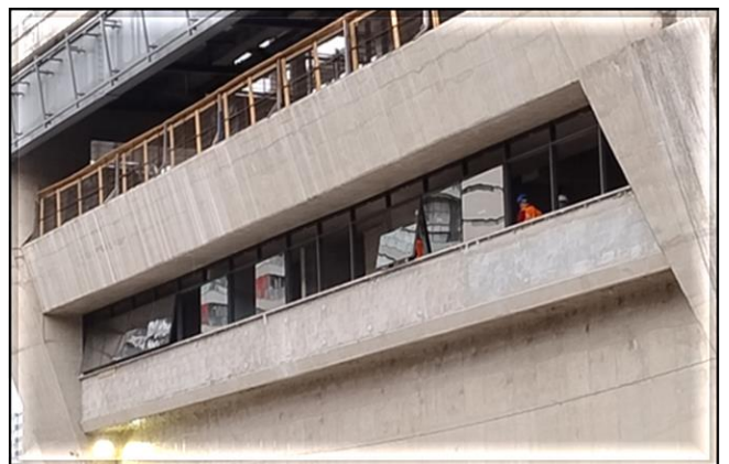
Obra Civil – em andamento a instalação dos vidros da Sala de Equipamentos Eletrônicos (SEE).
