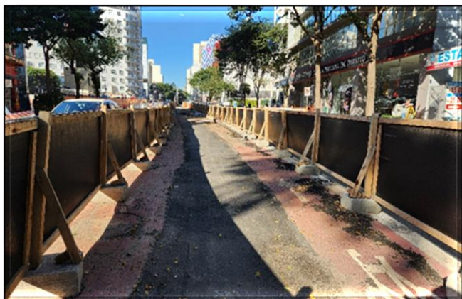
Remanejamento de interferências na Avenida da Liberdade/ Rua Vergueiro para implantação do desvio de tráfego.
