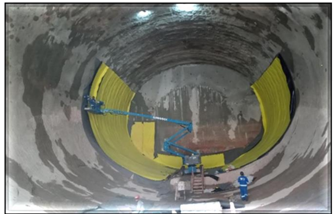
Impermeabilização do túnel do corpo da estação.
