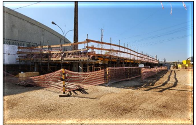
Obra Civil – montagem do canteiro de obras.
