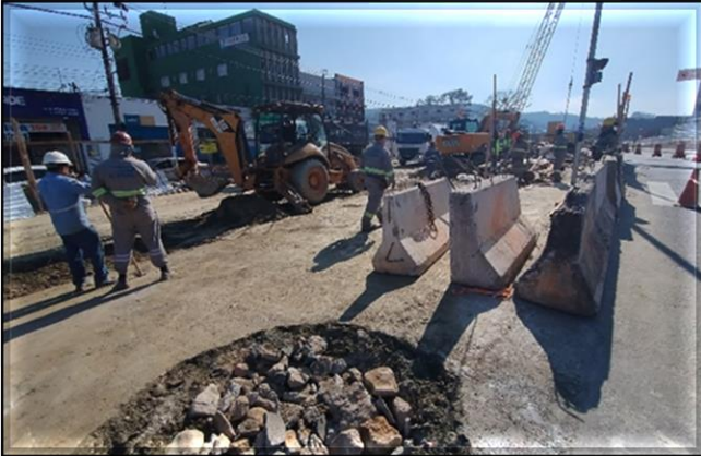
Obra Civil – estações do Corpo da Estação concluídos.
