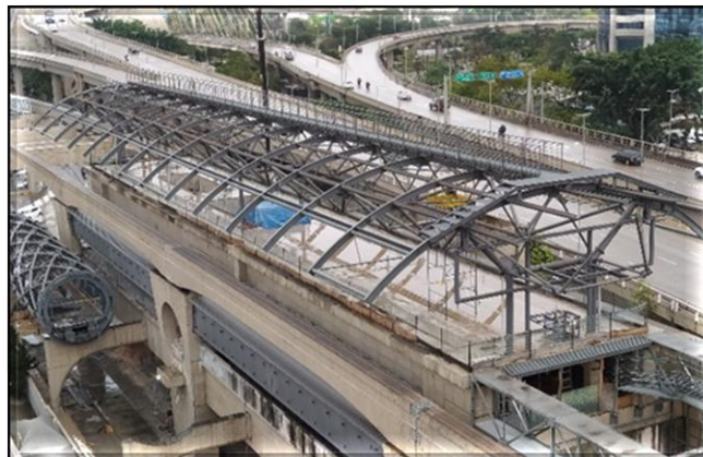
Obra Civil – montagem da estrutura da cobertura da plataforma.
