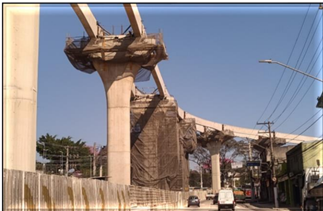
Obra Civil – lançamento das vigas-guia da via elevada.
