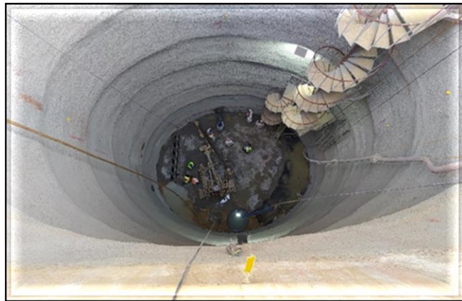
Local do poço de escavação do túnel: escavação e revestimento primário, 23,10m de 31,50m escavados.
