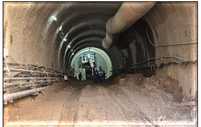
Escavação do túnel singelo.
