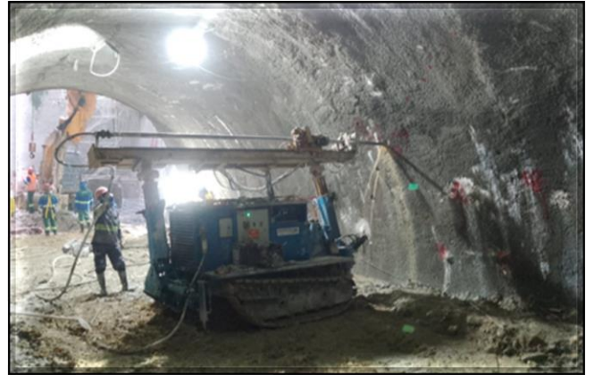
Tratamento para Tuneladora.
