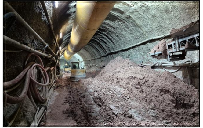
Escavação do túnel singelo.
