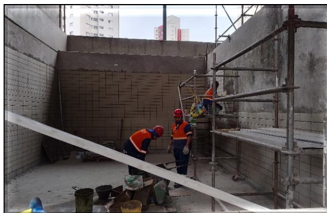
Obra Civil – execução do acabamento dos blocos.
