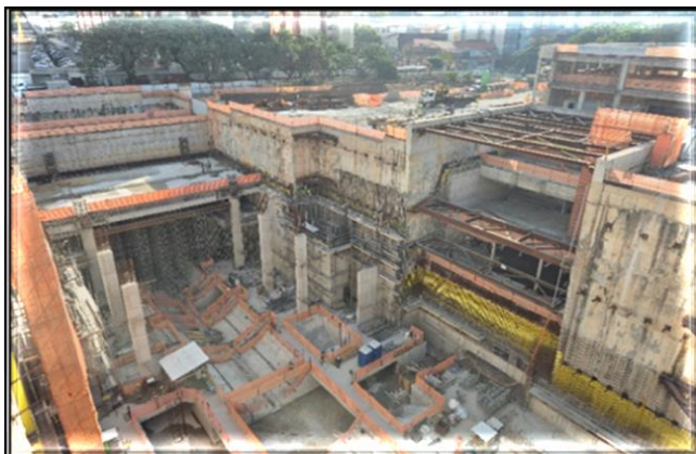
Estruturas de concreto do corpo da estação do Metrô.
