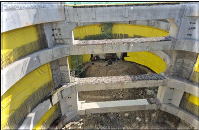
Escavação e estruturas de concreto dos poços do corpo da estação.
