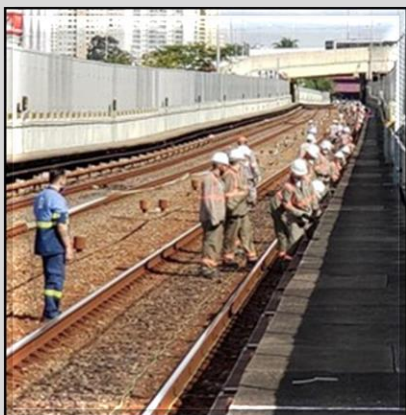
Lançamento de cabos do CBTC
