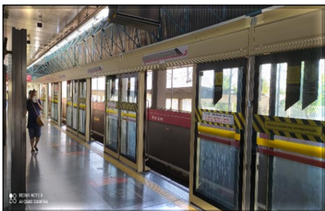
Fachada das portas de plataforma | Instaladas 2/2 fachadas (em testes)
