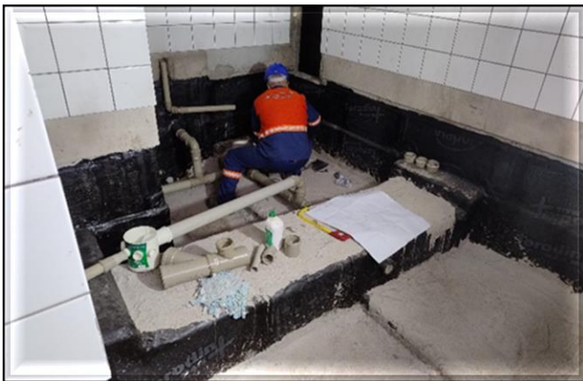
Obra Civil – execução da instalação hidráulica.
