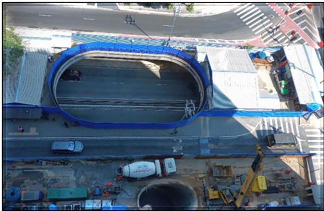
Canteiro de Obras: vista superior da área administrativa e do poço principal.
