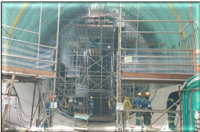
Revestimento secundário do túnel de ligação.
