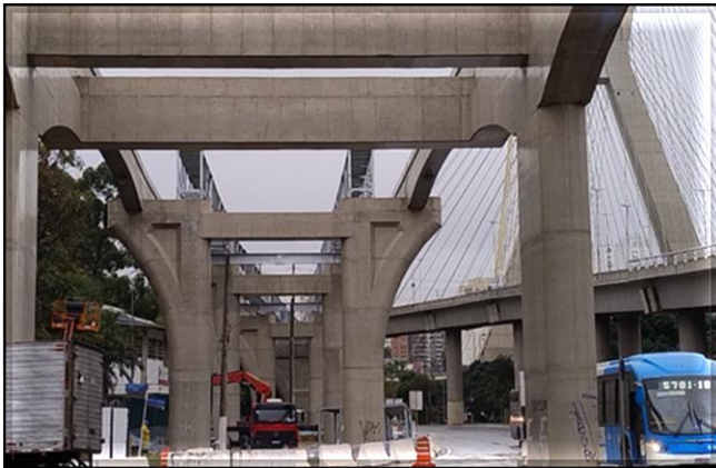
Vias do Monotrilho/Civil – instalação da passarela de emergência no trecho Chucr Zaidan - Morumbi.
