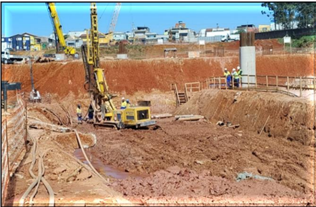
Obra Civil – execução das estacas dos blocos do Pátio.
