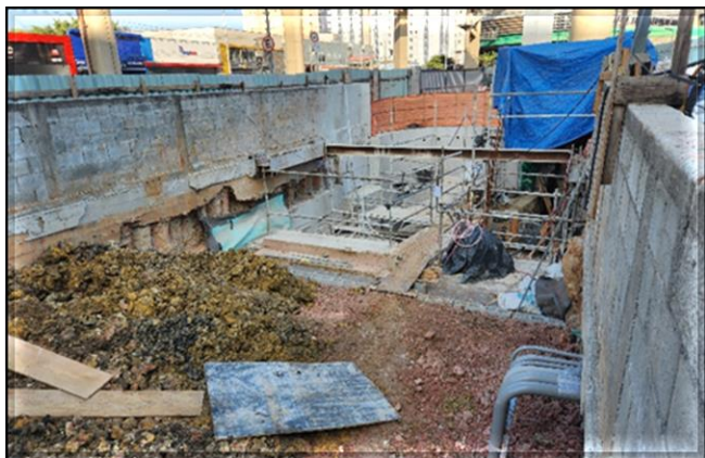
Exaustão 1 - Novo canal de ventilação da Plataforma 2 da estação Vila Prudente da Linha 2-Verde – início do reaterro.
