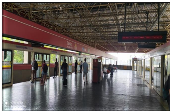
Fachadas das portas de plataforma | Instaladas 2/2 fachadas (em testes)
