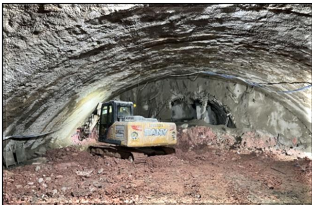
Escavação dos túneis do corpo da estação.
