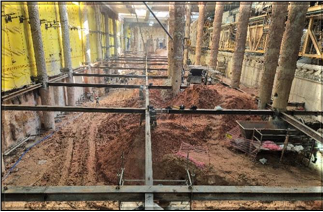
Escavação e estruturas de concreto do corpo da estação.
