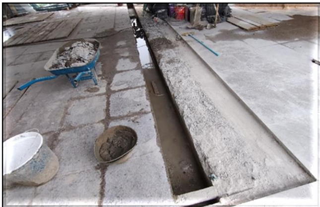
Obra Civil – em andamento a regularização da calha da linha de bloqueios.
