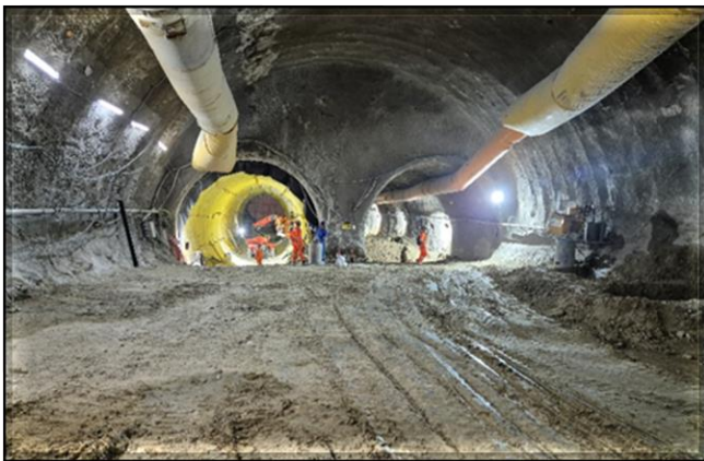
Escavação e impermeabilização do túnel de via.
