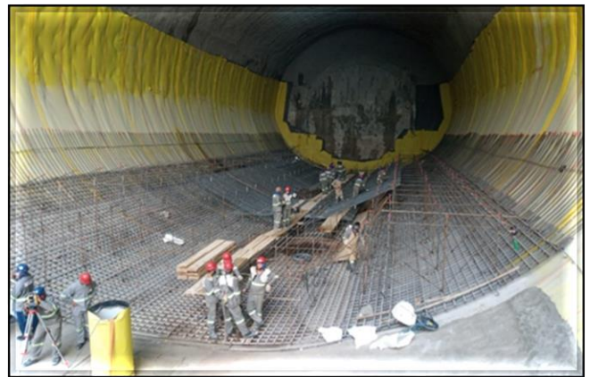
Laje de fundo do túnel do corpo da estação.
