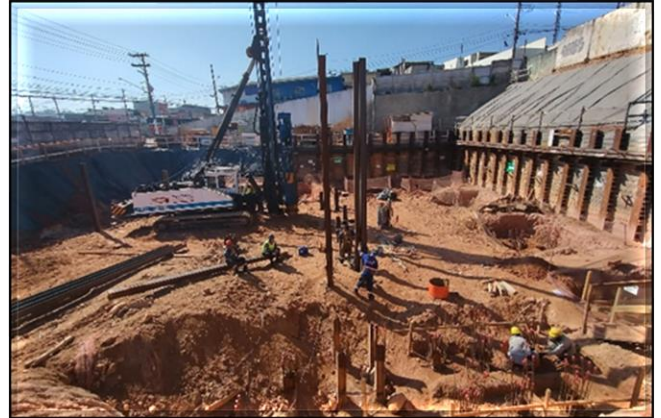
Obra Civil – em execução a cravação dos perfis metálicos da fundação do Edifício Técnico Operacional e Acesso Sul.
