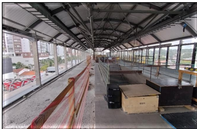
Sistemas – em andamento a instalação das Portas de Plataforma.
