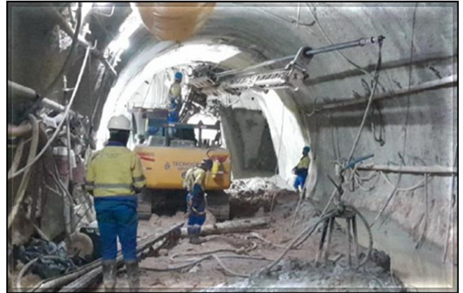
Escavação do túnel singelo.
