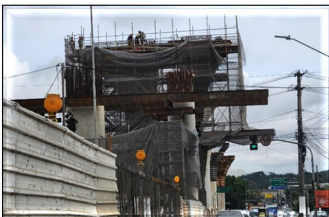
Obra Civil – execução dos capitéis da via elevada.
