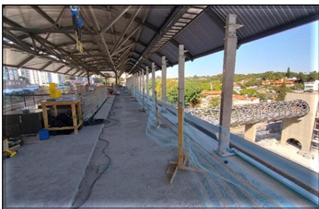
Sistemas – em andamento a instalação das estruturas das Portas de Plataforma.
