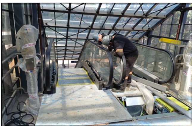
Sistemas – passagem do cabeamento e montagem de eletrodutos nas escadas rolantes.
