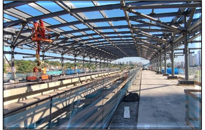
Obra Civil – em andamento a instalação da estrutura metálica da cobertura da plataforma.
