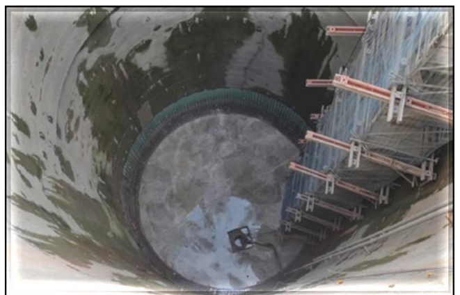
Vista geral do Poço.
