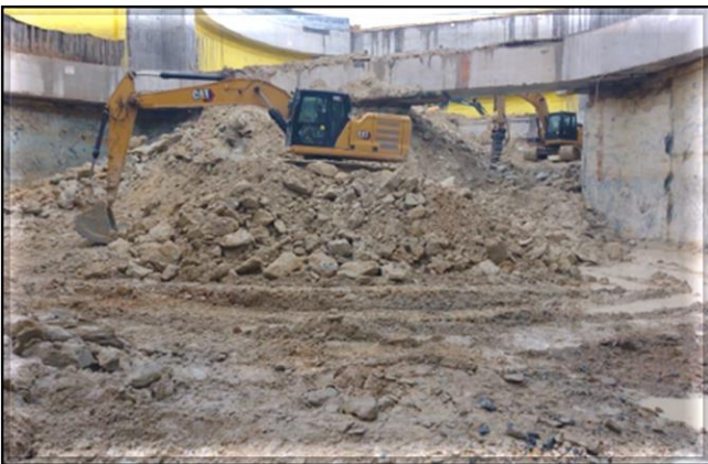
Escavação e estruturas de concreto dos poços do corpo da estação.
