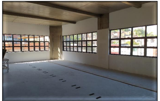
Obra Civil – em andamento a instalação dos caixilhos no Edifício Técnico Operacional (ETO).
