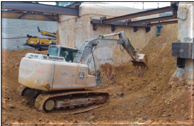
Estroncas para escavação da vala do corpo da estação.
