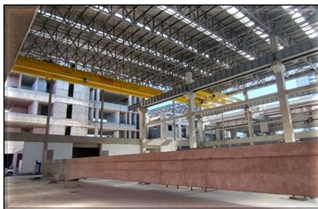
Sistemas – instalação das pontes rolantes do Bloco A.
