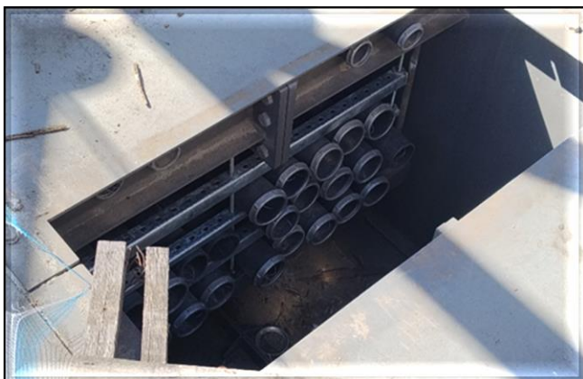
Sistemas – em andamento a instalação dos bancos de dutos das passarelas.
