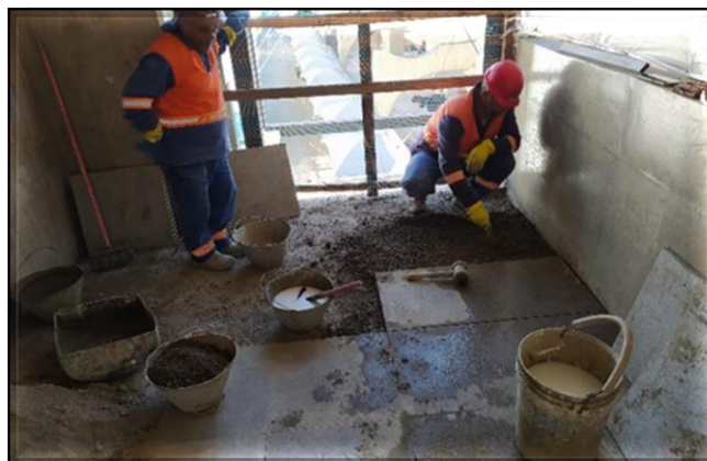
Obra Civil – em andamento o acabamento do Acesso C.
