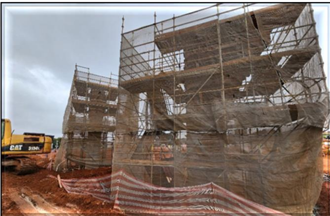
Obra Civil – execução dos pilares da via de estacionamento do Pátio.
