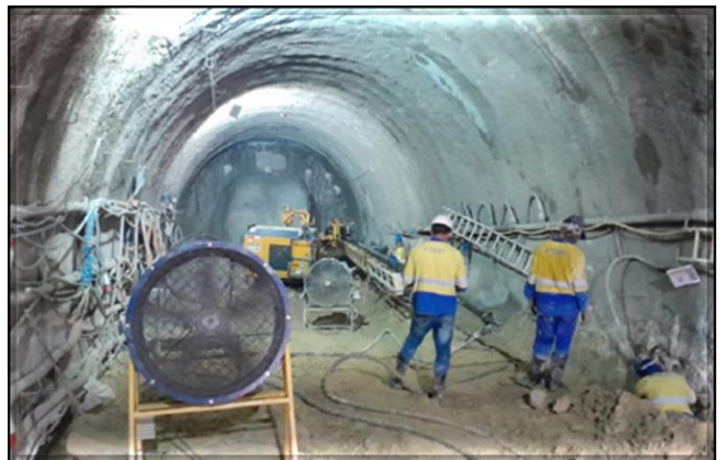
Escavação do túnel.
