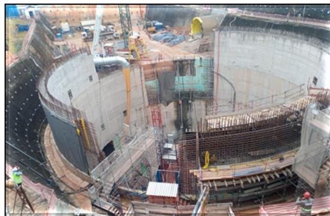
Estruturas de concreto do corpo da estação.
