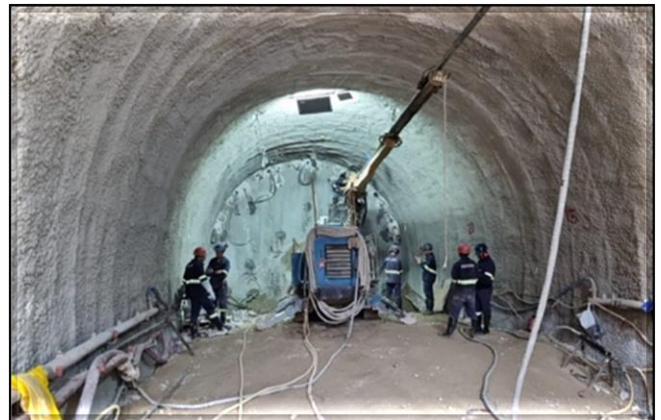
Escavação do túnel singelo.
