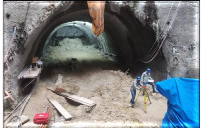
Vista geral do Poço.
