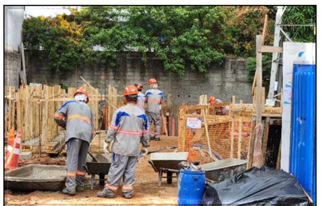
Obra Civil – execução dos blocos de fundação para o alteamento da linha de transmissão da Avenida Presidente Wilson.
