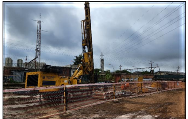
Obra Civil – execução de estacas raízes do canteiro de obras.
