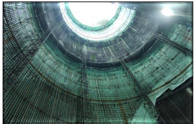
Revestimento secundário do Poço.
