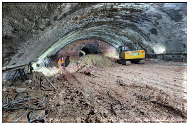
Escavação dos túneis do corpo da estação.
