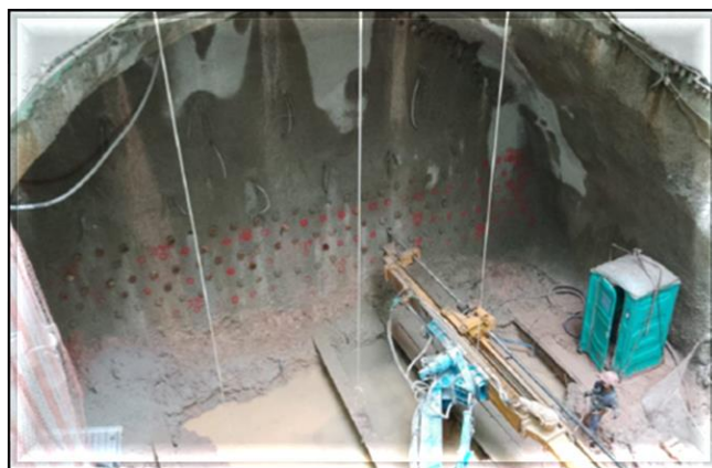
Tratamento para emboque e desemboque da tuneladora.
