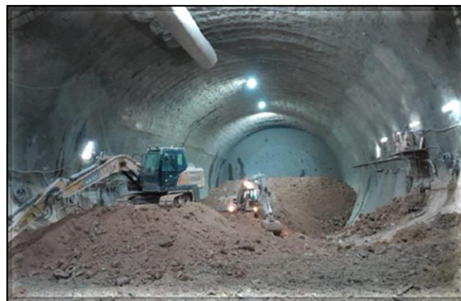
Escavação dos túneis de corpo da estação.
