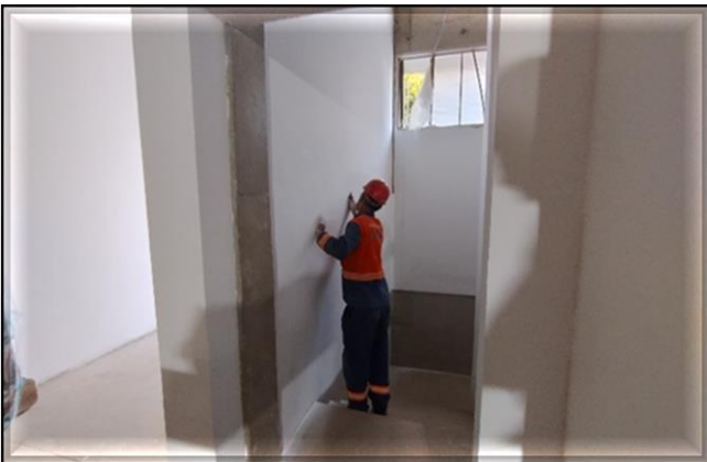
Civil – em andamento o acabamento das Salas Técnicas.
