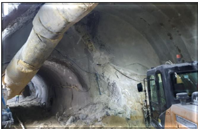
Escavação do túnel de via.
