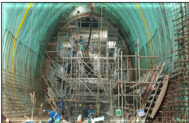
Revestimento secundário do túnel de ligação.
