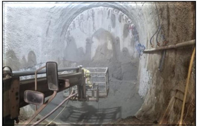
Escavação do túnel singelo.
