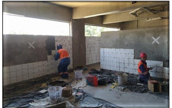
Obra Civil – em andamento o acabamento do Edifício Técnico Operacional
