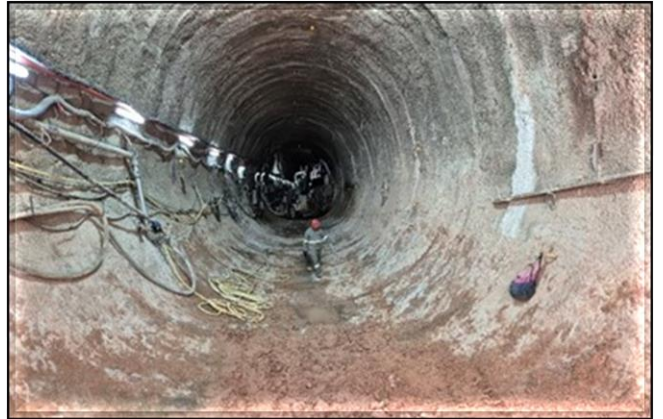
Escavação do túnel singelo.
