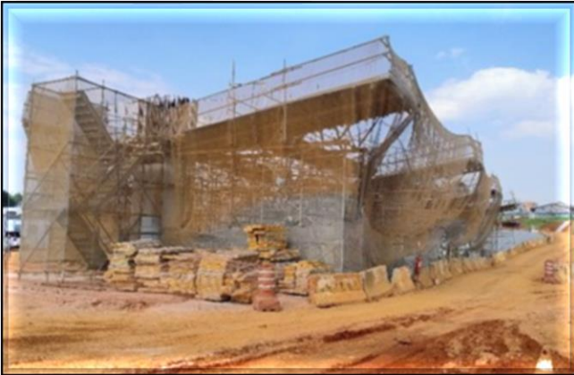
Obra Civil – montagem do cimbramento para execução dos track switches do Pátio.
