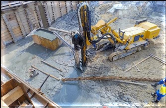
Obra Civil – Em execução as estacas raízes do Acesso Sul e Edifício Técnico
