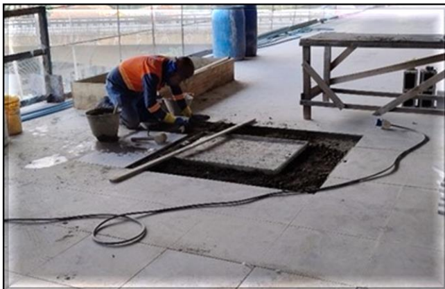
Obra Civil – em andamento requadro das caixas de passagem.
