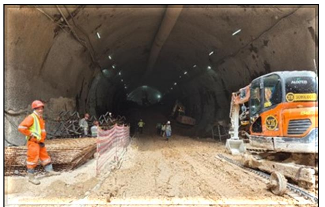
Escavação do túnel de transição.
