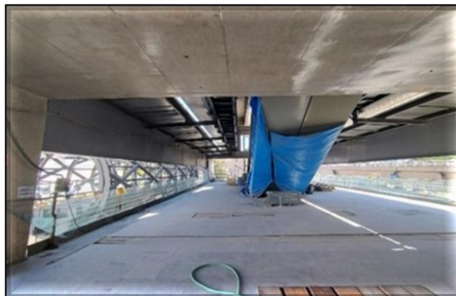
Obra Civil – em andamento a instalação das telhas planas do mezanino.
