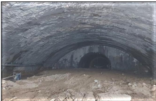
Escavação dos túneis do corpo da estação.
