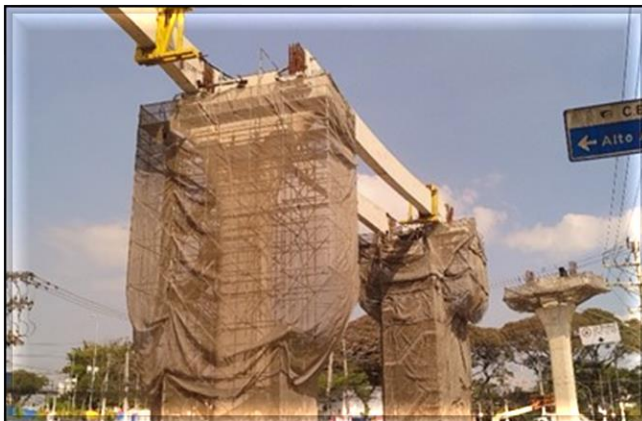
Obra Civil – Execução do lançamento das vigas-guia da via elevada.
