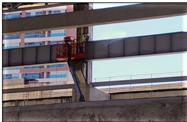
Sistemas – instalação dos trilhos das pontes rolantes do Bloco A.
