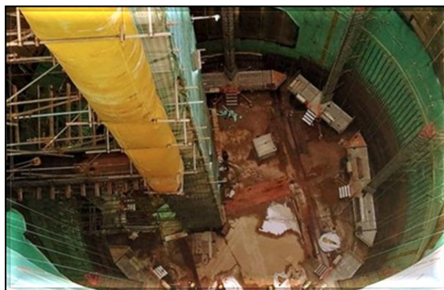
Vista geral do Poço.
