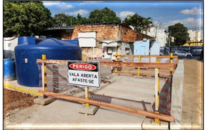
Obra Civil – execução do lava-rodas.
