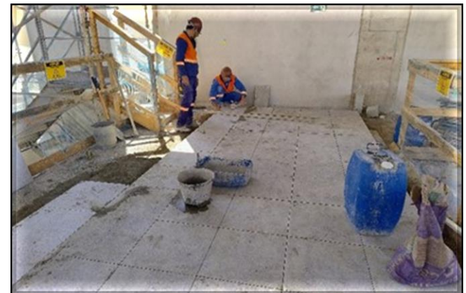
Obra Civil – em andamento acabamento do Acesso 01.
