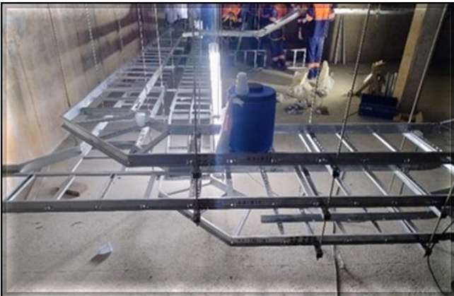
Sistemas – em andamento a instalação do bandejamento no Acesso 02.
