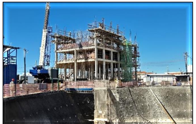
Estruturas de concreto das salas técnicas.
