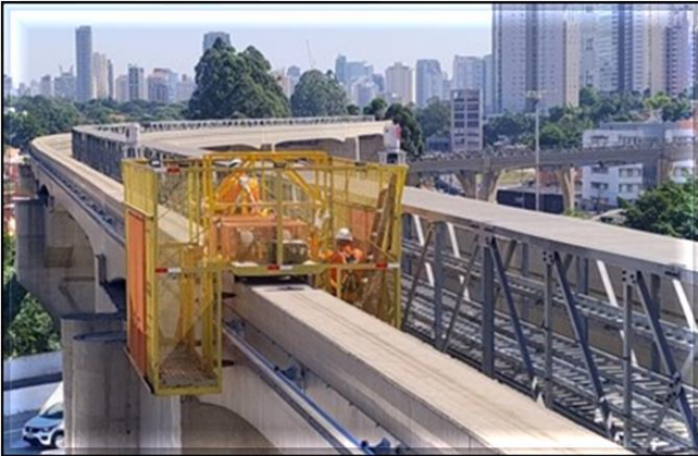
Vias do Monotrilho/Sistemas – instalação dos trilhos de captação de energia.
