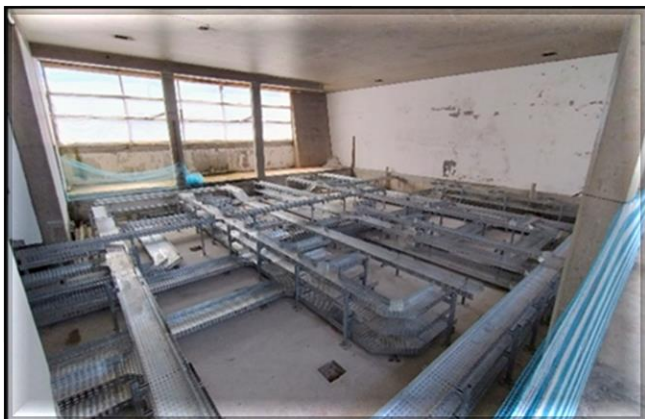
Sistemas – em andamento a instalação do bandeamento na Sala de Equipamentos Eletrônicos.
