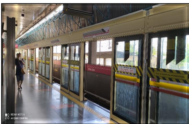
Fachada das portas de plataforma | Em instalação e testes
