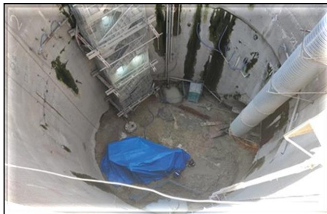
Vista geral do Poço.
