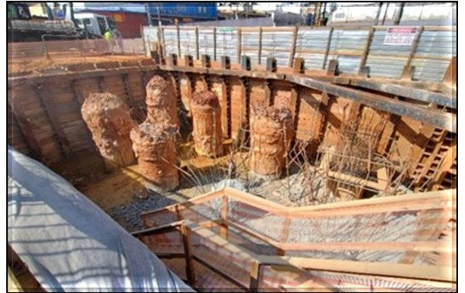
Obra Civil – Em execução o arrasamento dos estacões para execução dos blocos de fundação do Corpo da Estação.
