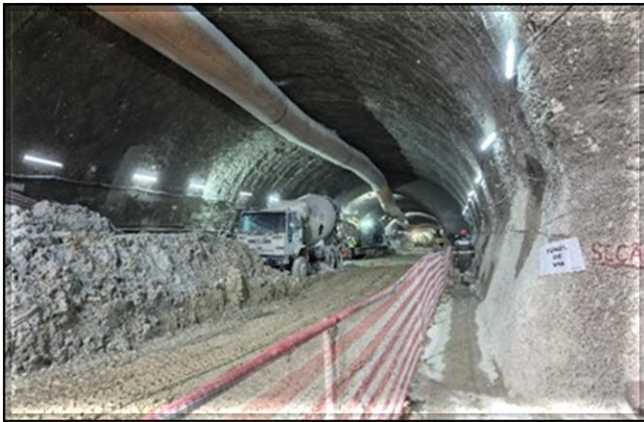
Escavação do túnel de via.
