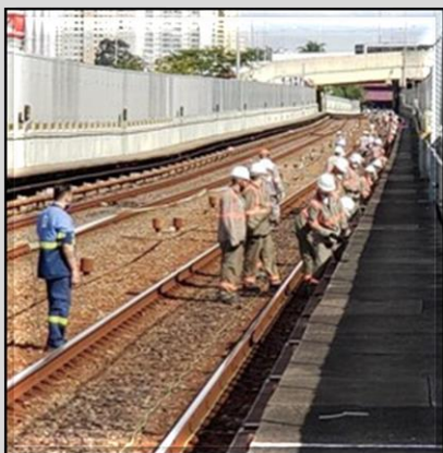
Lançamento de cabos do CBTC
