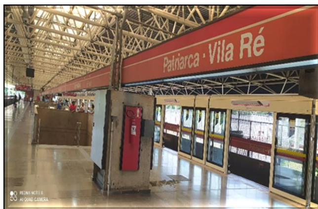
Fachada das portas de plataforma | Instalada a fachada na via 1
