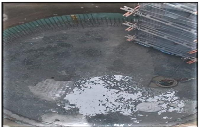
Vista geral do Poço.
