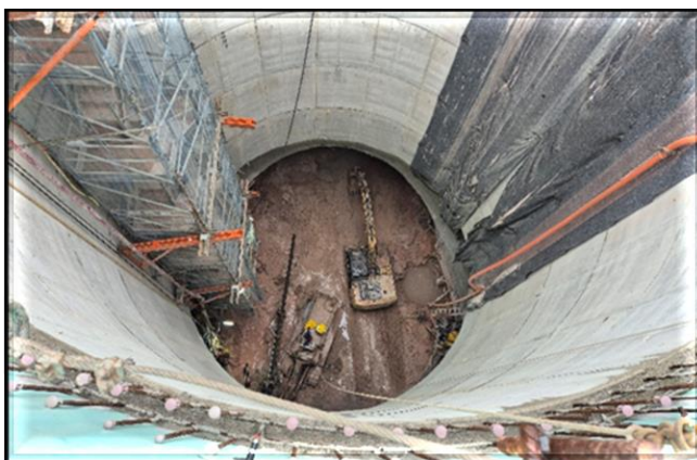
Escavação dos túneis direcionais para a tuneladora.
