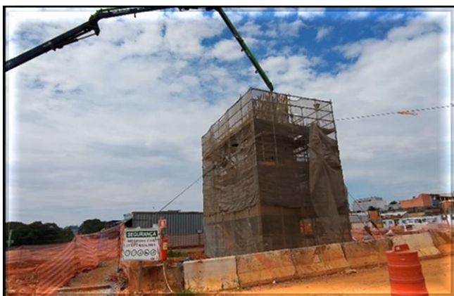
Em andamento a execução dos estações, blocos e pilares das vias do pátio.
