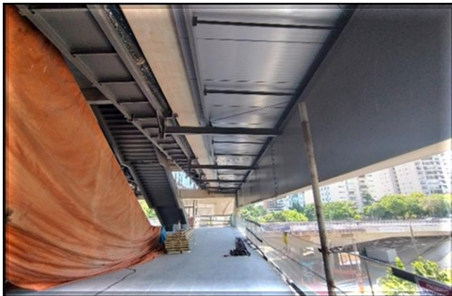
Obra Civil – instaladas as telhas planas do mezanino.
