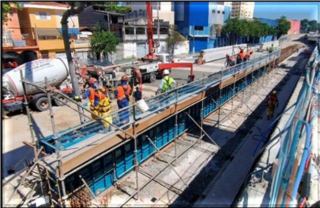
Vias do Monotrilho/ Obra Civil – em andamento a fabricação das vigas-guia do Lote 17.
