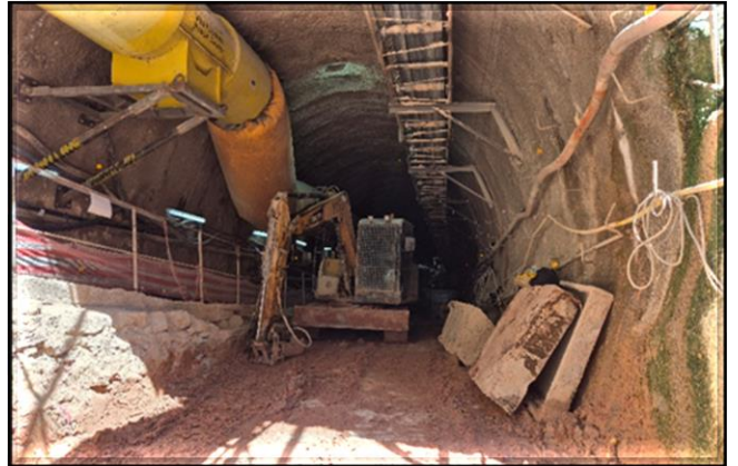
Escavação do túnel singelo.
