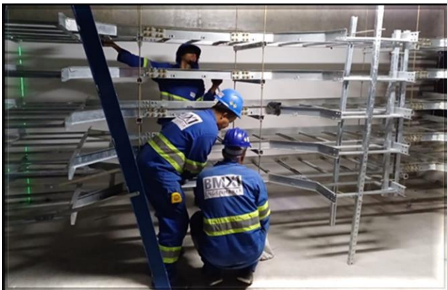
Sistemas – instalação do bandejamento no porão de cabos.
