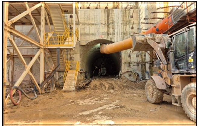
Escavação do túnel singelo.
