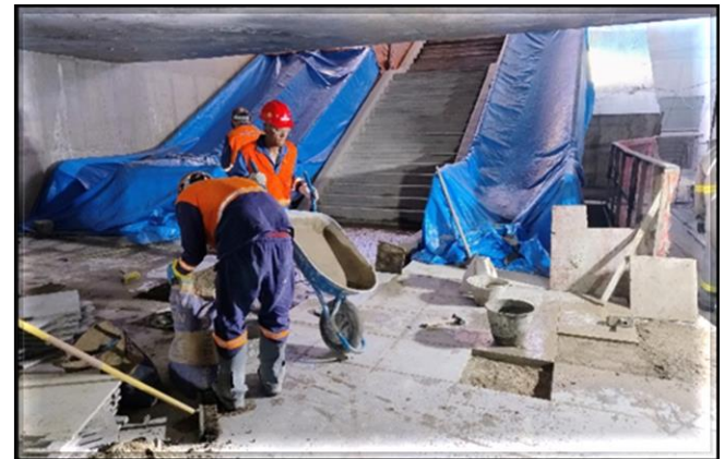
Obra Civil – em andamento a execução do piso de granito do Acesso 01/interligação.
