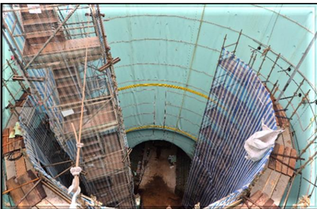
Revestimento secundário do poço e do túnel de ligação.
