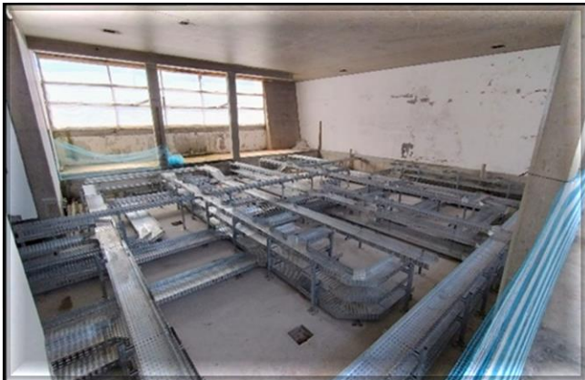
Sistemas – em andamento a instalação do bandejamento na Sala de Equipamentos Eletrônicos.
