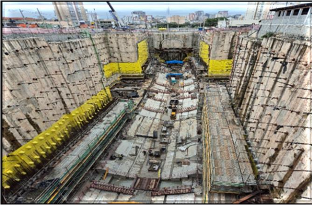
Revestimento secundário do corpo da estação.
