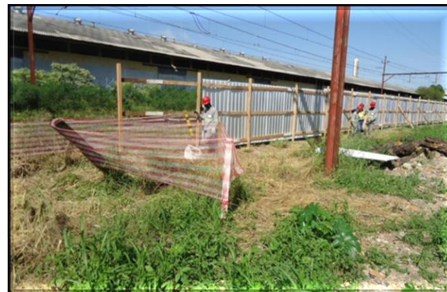
Implantação de tapumes junto à via férrea para segregação da área operacional da CPTM.
