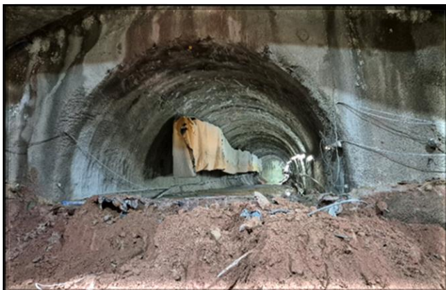
Escavação dos túneis do corpo da estação.
