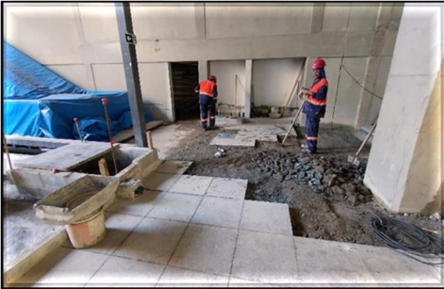
Obra Civil – em andamento execução do piso de granito no Acesso 01.
