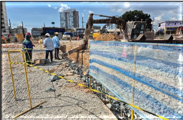
Viga de coroamento da vala do corpo da estação.
