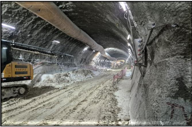
Escavação do túnel de via.
