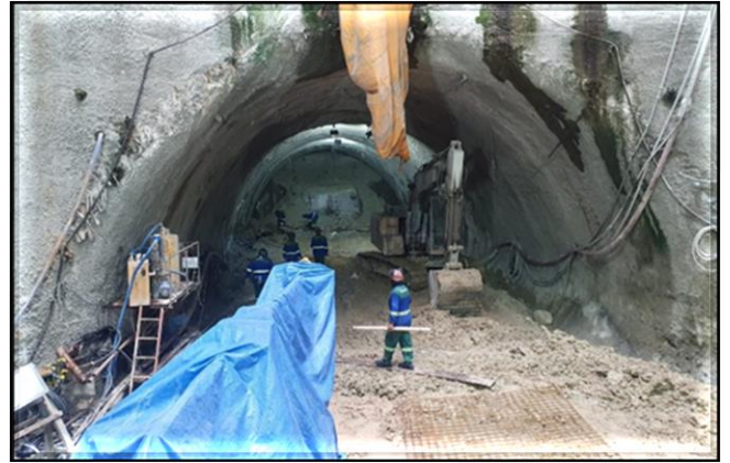
Escavação do túnel de ligação.
