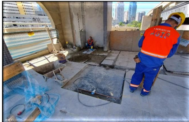
Obra Civil – em andamento a execução do piso de granito no Acesso B.
