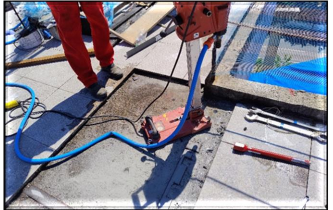
Obra Civil – em andamento a furação para instalação da estrutura metálica da cobertura da plataforma.
