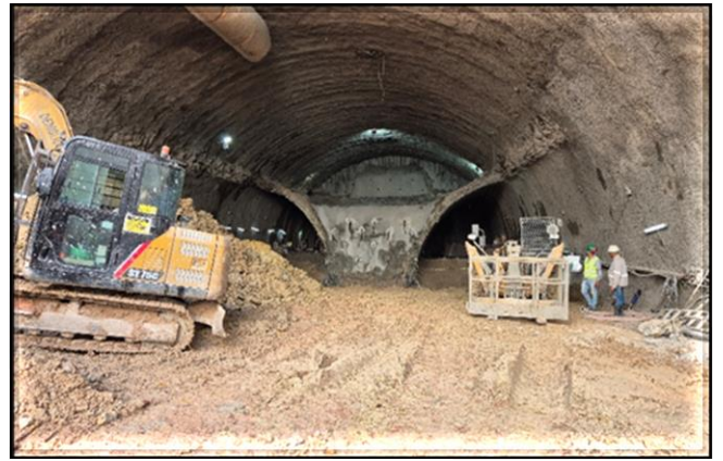
Escavação do túnel de via do corpo da estação
