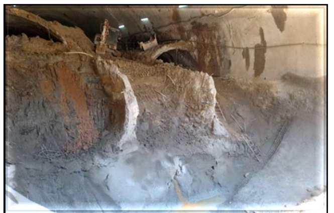
Escavação do túnel de transição.
