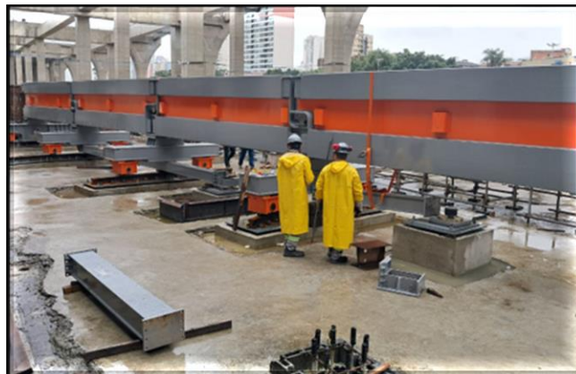
Sistemas – instalação do track-switch (AMV) 14.
