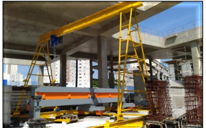
Obra Civil – em andamento a execução das vigas guia. Sistemas – instalação do bandejamento da galeria de cabos e execução das bases dos aparelhos de mudança de via (AMVs); ponte rolante para instalação do AMV 11 em montagem.
