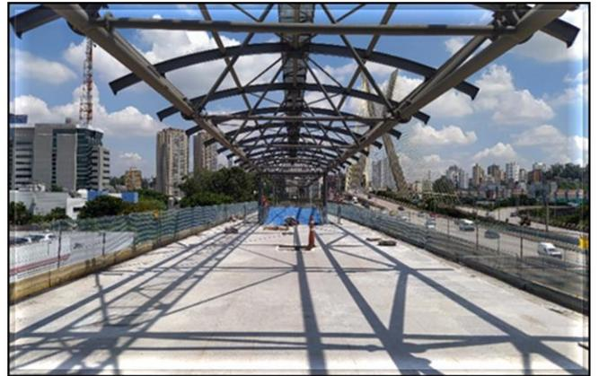
Obra Civil – em andamento a instalação do piso de granito na plataforma.
