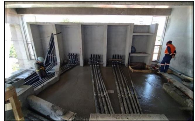
Obra Civil – Em andamento regularização do contrapiso do mezanino. Sistemas – em execução a instalação do bandejamento na Sala de Equipamentos Eletrônicos (SEE).
