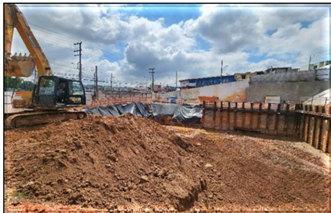
Em execução o arrasamento das estacas e reaterro da vala do Acesso B (sul) e Edifício Técnico
