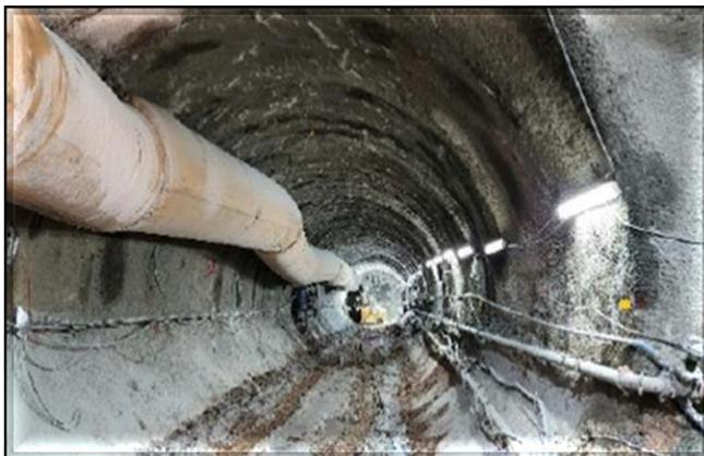
Escavação dos túneis do corpo da estação.
