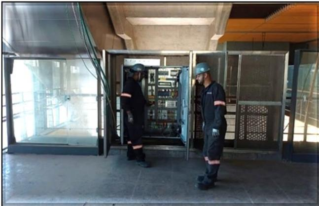
Sistemas – montagem dos elevadores; pré-testes das escadas rolantes em execução (painéis e escadas).
