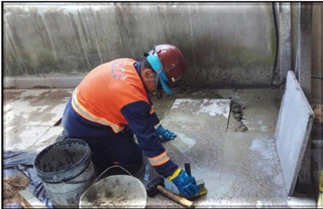
Obra Civil – em andamento a instalação do piso de granito no mezanino.
