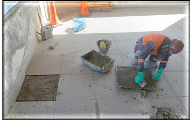
Obra Civil – em andamento a instalação do piso porcelanato nos escritórios do Edifício Técnico Operacional.
